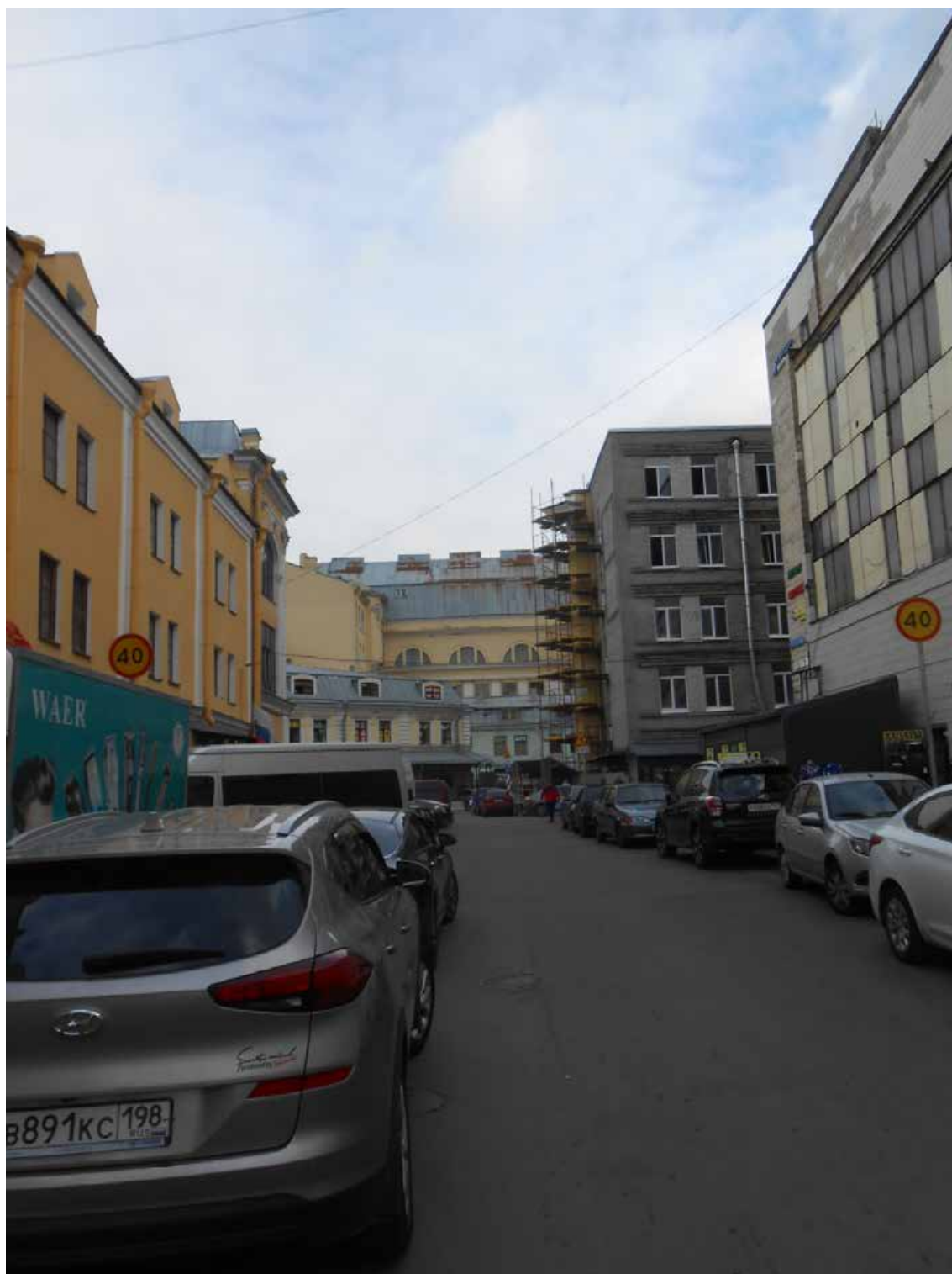
13. Вид на участок трассы вдоль Степановского проезда. Фото: 18.09.2023.
