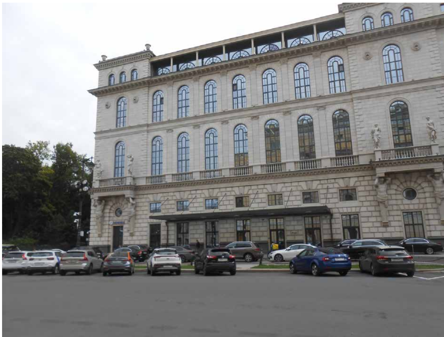
30. Вид на место прохождения трассы по пл. Островского у дома №2. Фото: 18.09.2023.
