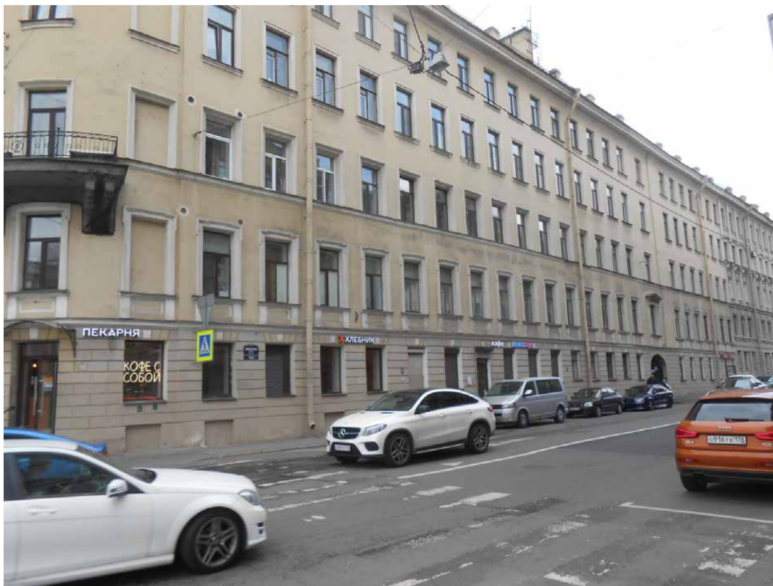
7. Вид на участок трассы вдоль Апраксина пер. Фото: 18.09.2023.
