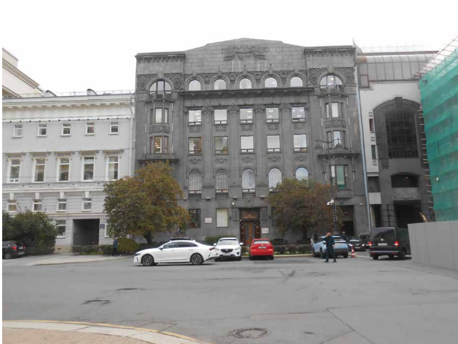
28. Вид на место прохождения трассы по пл. Островского. Фото: 18.09.2023.
