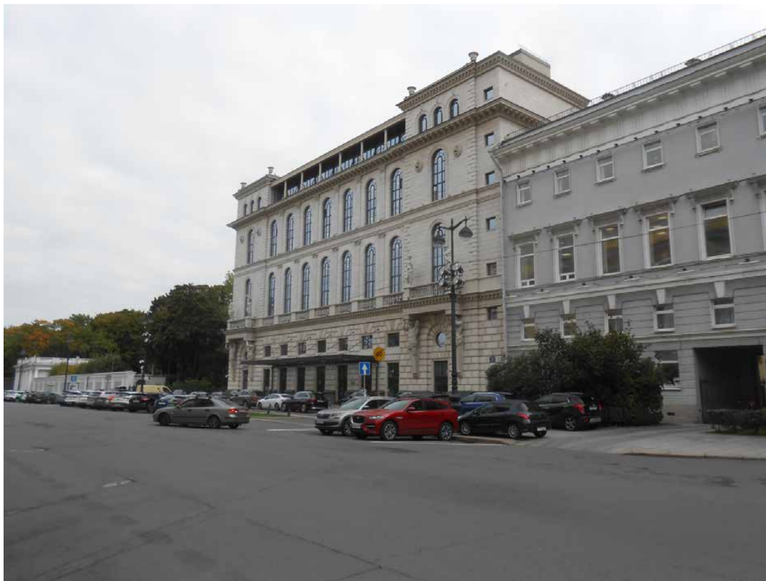
29. Вид на место прохождения трассы по пл. Островского. Фото: 18.09.2023.
