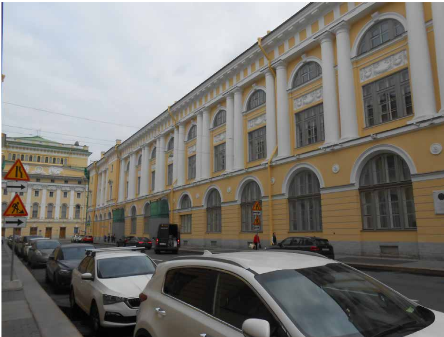
26. Объект культурного наследия федерального значения «Ансамбль улицы Зодчего Росси». Фрагмент. Вид на место прохождения трассы вдоль ул. Зодчего Росси. Фото: 18.09.2023.
