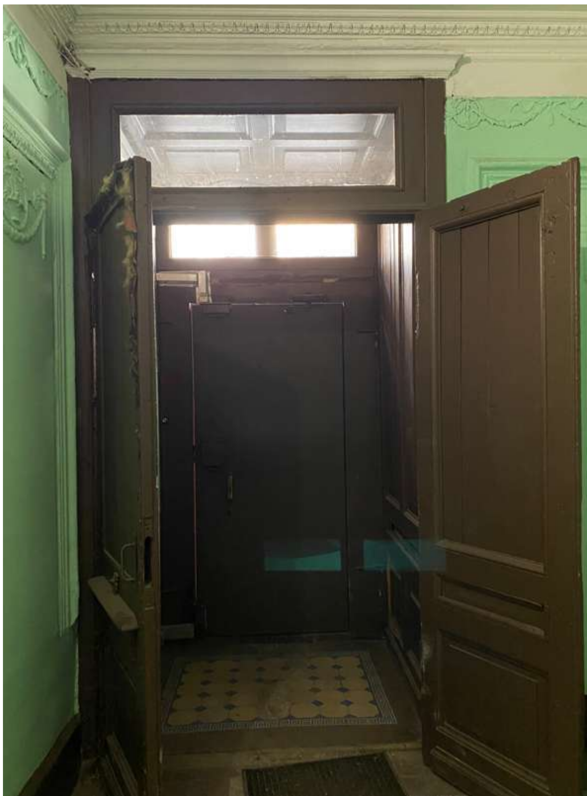
31. Тамбур лестницы Л-1
