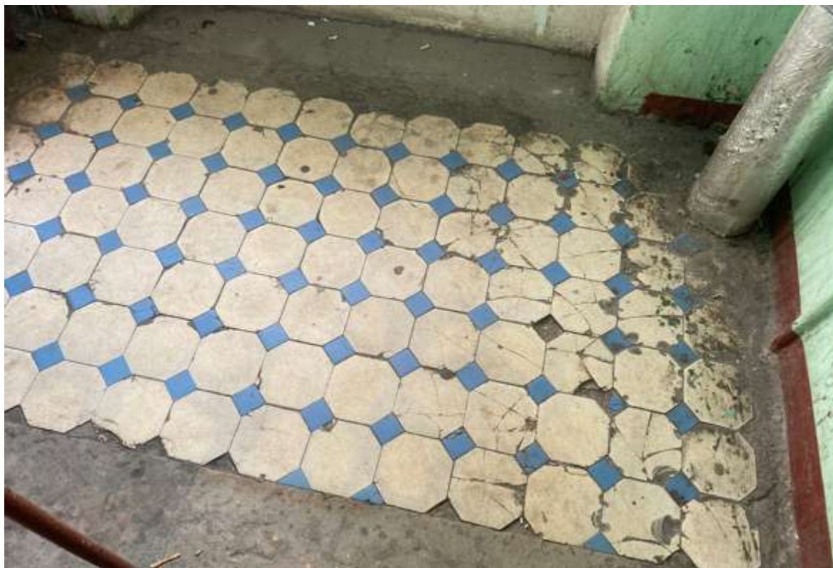
41. Покрытие площадки лестницы Л-2
