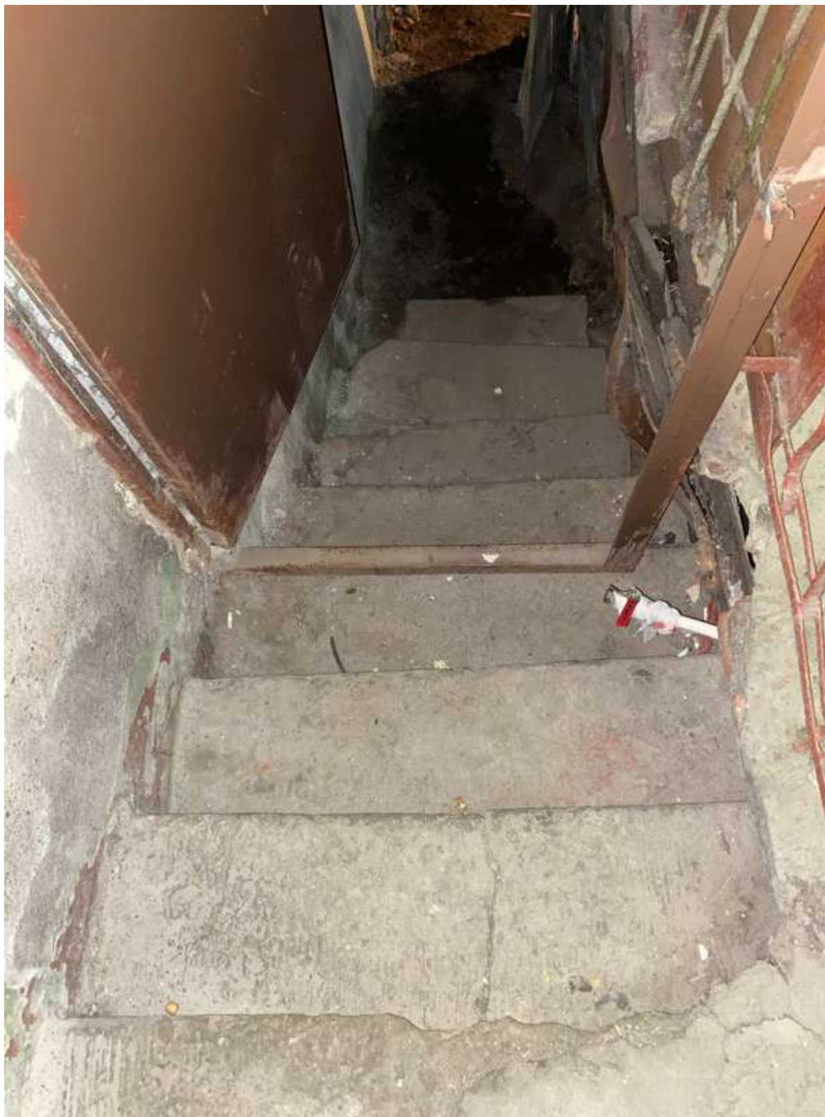
34. Лестница в подвал
