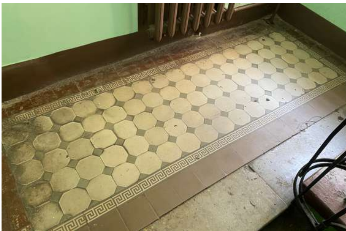
16. Покрытие пола лестничной площадки лестницы Л-1
