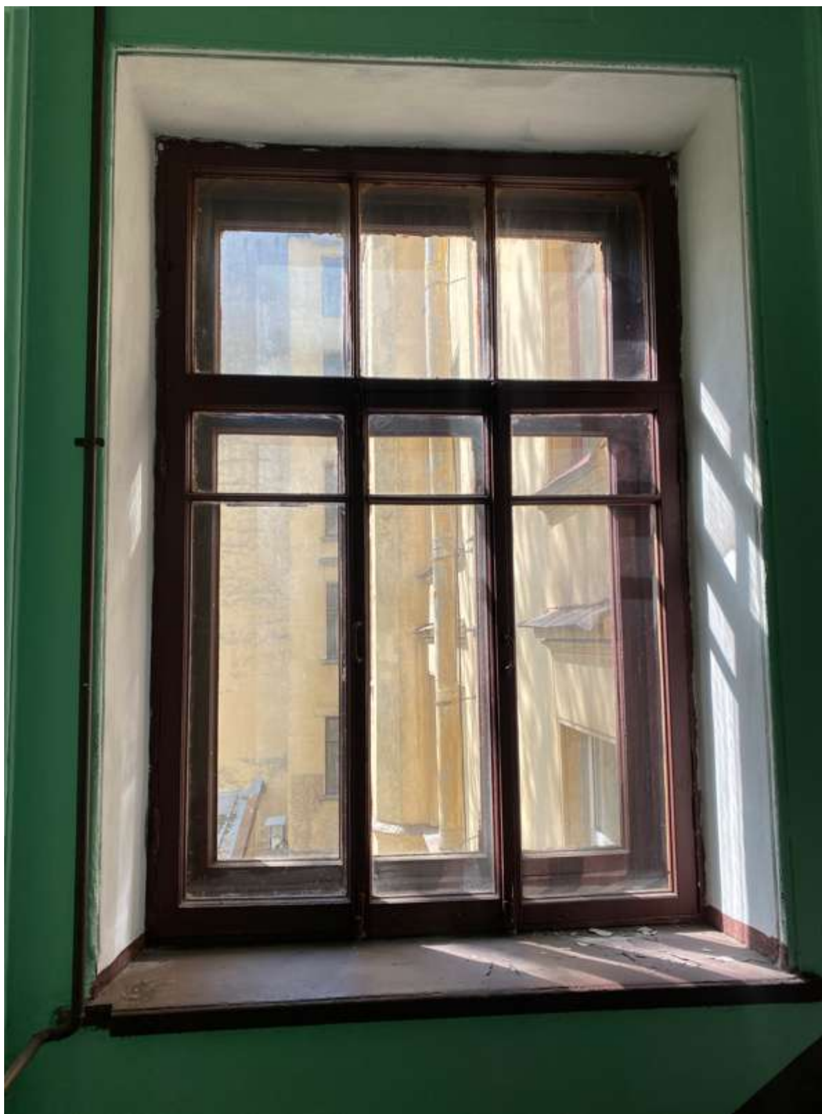
22. Оконное заполнение лестницы Л-1
