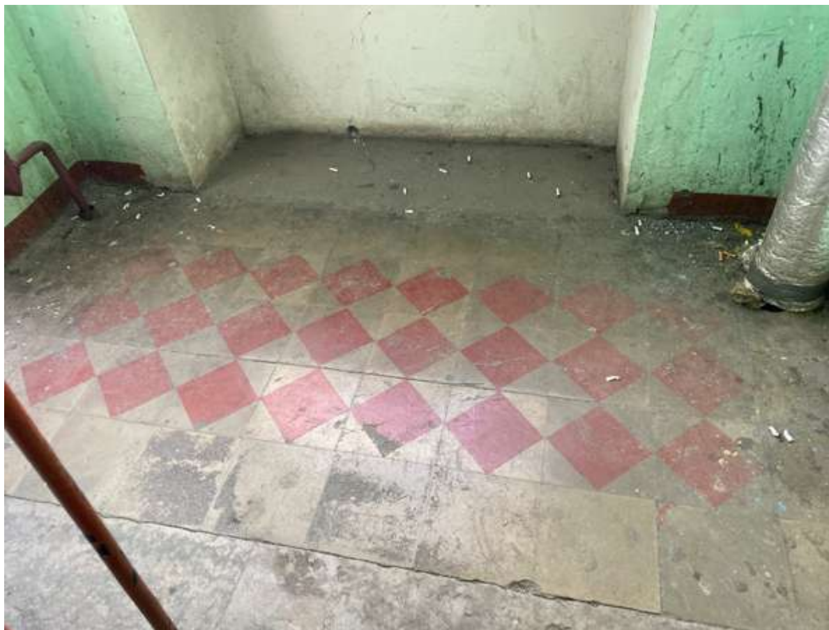
44. Покрытие площадки лестницы Л-2
