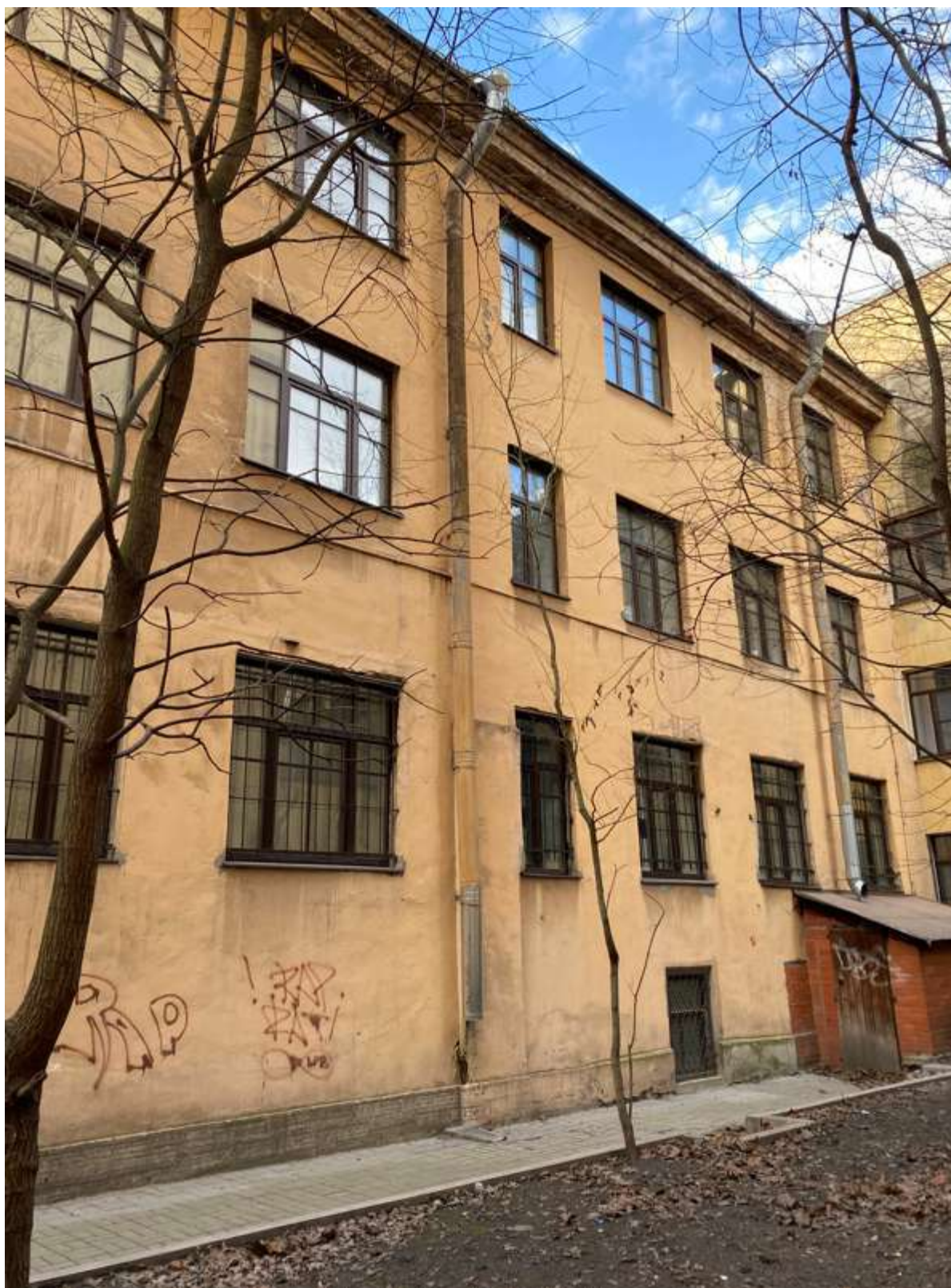
5. Вид на здание молельни с юга
