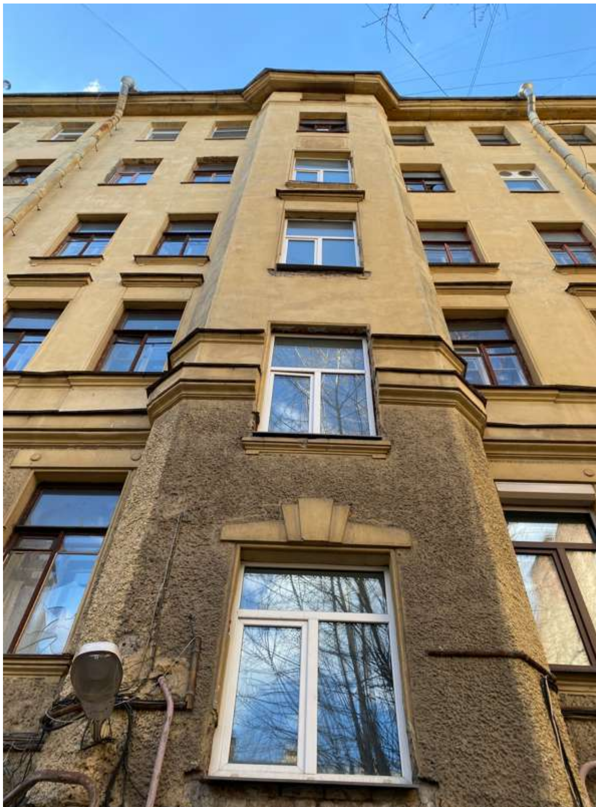
10. Фрагмент дворового фасада
