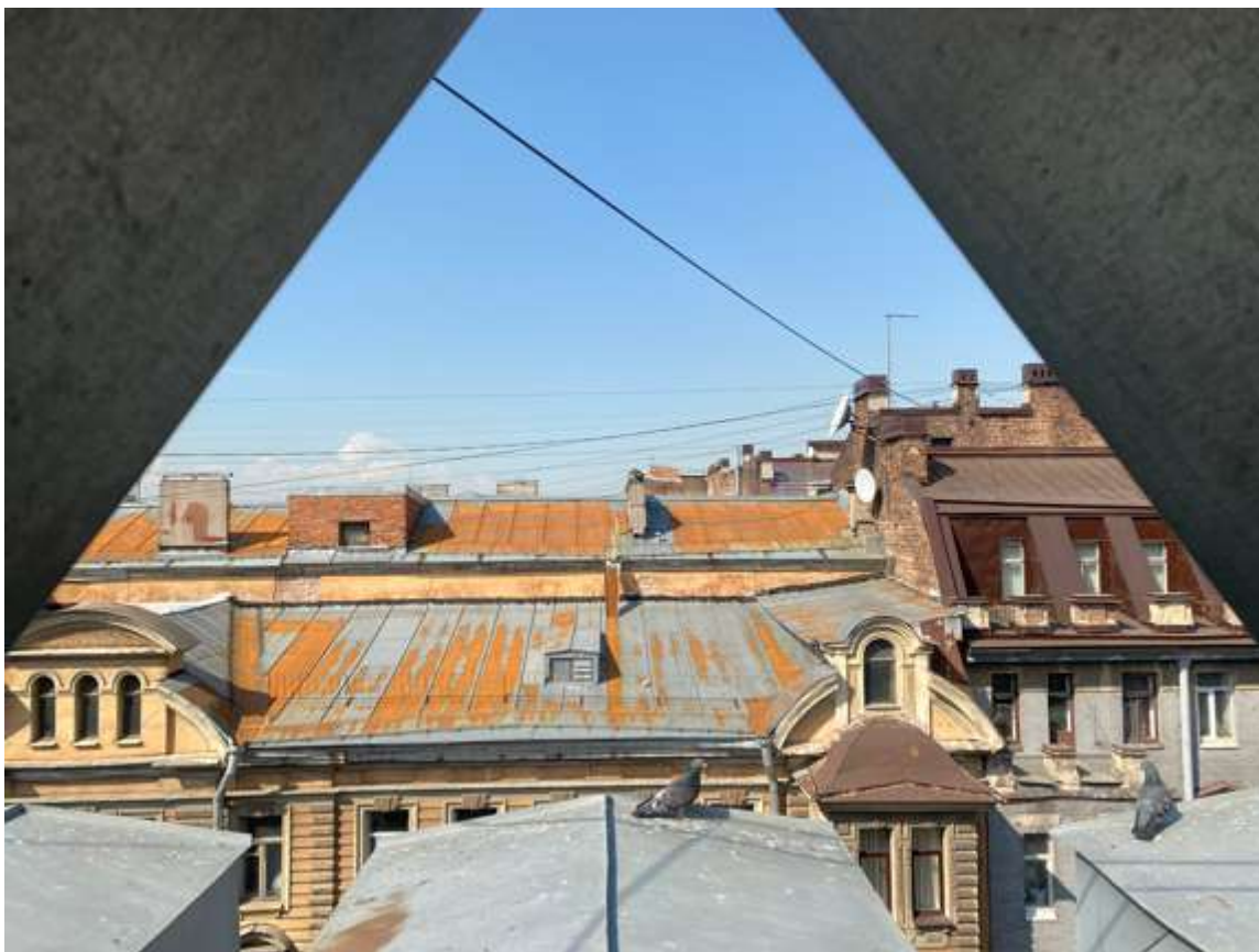
54. Вид на крышу
