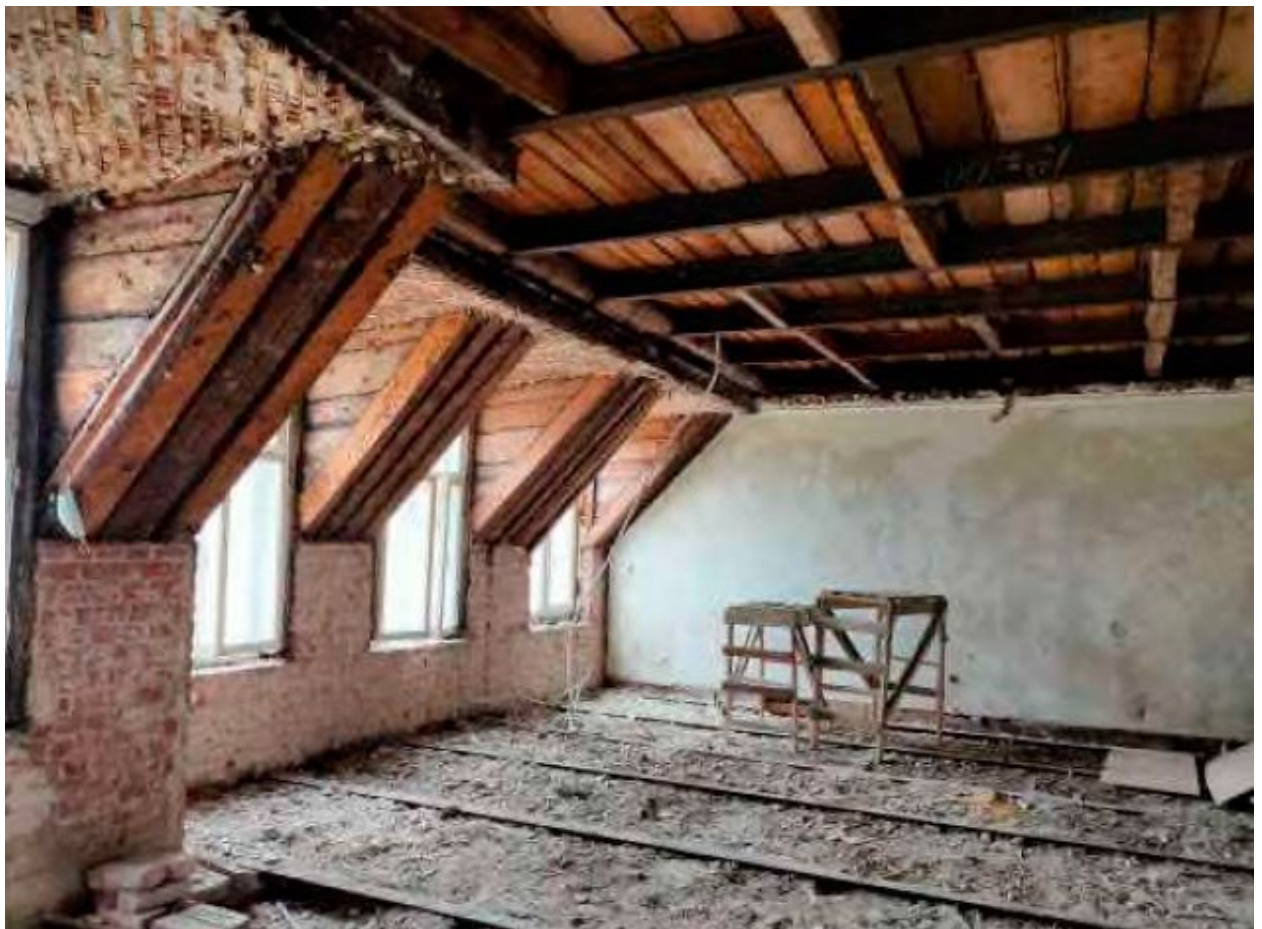
4. Помещение №14 квартиры №10 в уровне мансардного этажа выявленного объекта культурного наследия «Дом М.Д. Корнилова», расположенного по адресу: г. Санкт-Петербург, Малый проспект П.С., д. 26-28, литера А. 25.08.2023.
