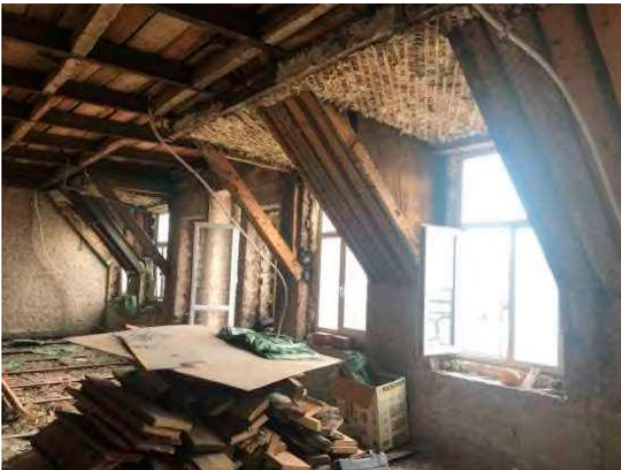
5. Помещения №№11-13 квартиры №10 в уровне мансардного этажа выявленного объекта культурного наследия «Дом М.Д. Корнилова», расположенного по адресу: г. Санкт-Петербург, Малый проспект П.С., д. 26-28, литера А. 25.08.2023.
