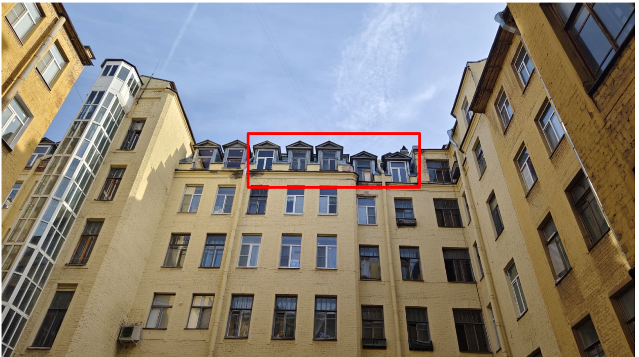
2. Оконные заполнения квартиры №10 в уровне мансардного этажа выявленного объекта культурного наследия «Дом М.Д. Корнилова», расположенного по адресу: г. Санкт-Петербург, Малый проспект П.С., д. 26-28, литера А. 25.08.2023.
