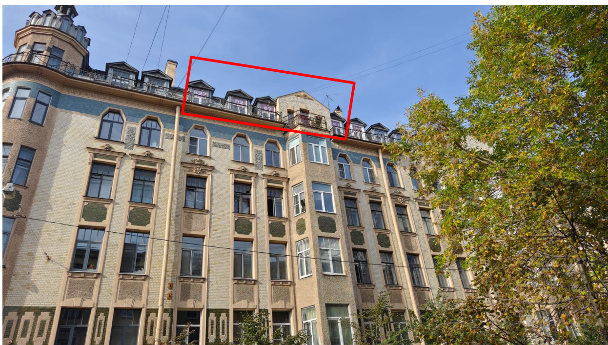
1. Оконные заполнения квартиры №10 в уровне мансардного этажа выявленного объекта культурного наследия «Дом М.Д. Корнилова», расположенного по адресу: г. Санкт-Петербург, Малый проспект П.С., д. 26-28, литера А. 25.08.2023.
