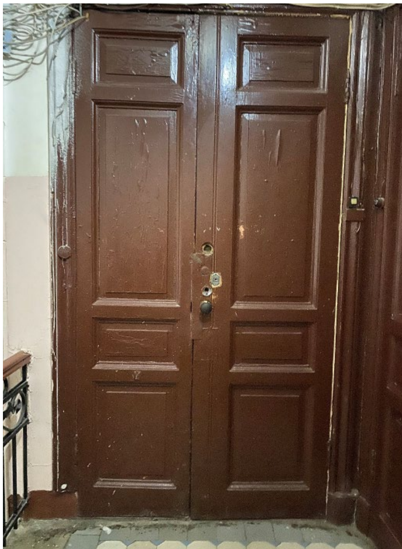
3. Входные дверные заполнения квартиры №10 в уровне мансардного этажа на «парадной» лестнице выявленного объекта культурного наследия «Дом М.Д. Корнилова», расположенного по адресу: г. Санкт-Петербург, Малый проспект П.С., д. 26-28, литера А. 25.08.2023.
