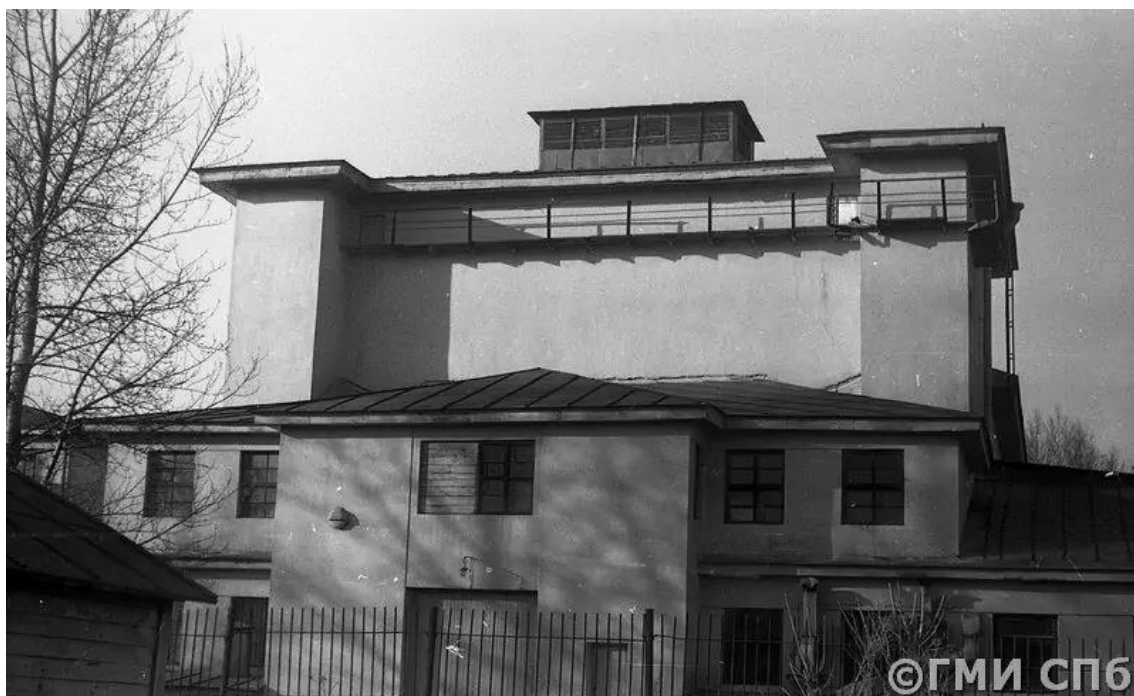
27. Дом культуры им. В.И. Ленина (Дворец культуры им. В.И. Ленина завода «Большевик») по адресу: г. Санкт-Петербург, пр. Обуховской Обороны, д. 223. Фрагмент южного фасада. Фотография. 1979 г. ГМИ СПб. www.pastvu.com .
