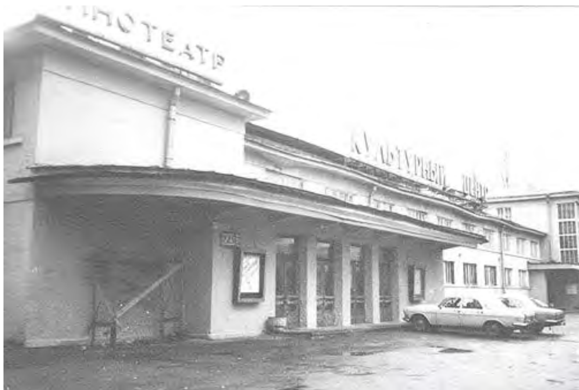
35. Дом культуры им. В.И. Ленина (Дворец культуры им. В.И. Ленина завода «Большевик») по адресу: г. Санкт-Петербург, пр. Обуховской Обороны, д. 223. Фотография. 1999 г. КГИОП.
