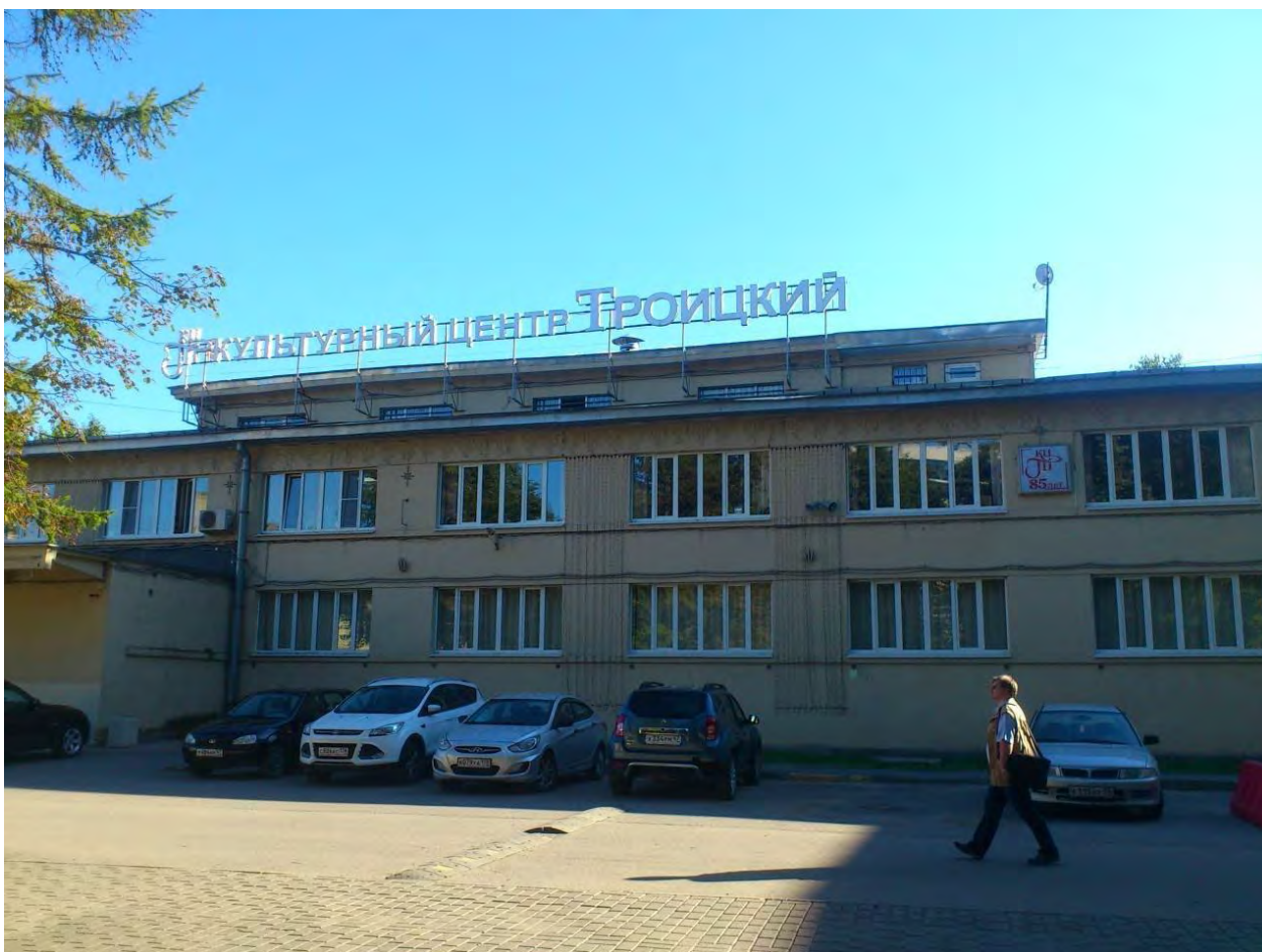
41. Выявленный объект культурного наследия «Дом культуры им. В.И. Ленина завода «Большевик»» по адресу: г. Санкт-Петербург, пр. Обуховской Обороны, д. 223. Культурный центр «Троицкий». Фотография. 2015 г. https://www.citywalls.ru/
