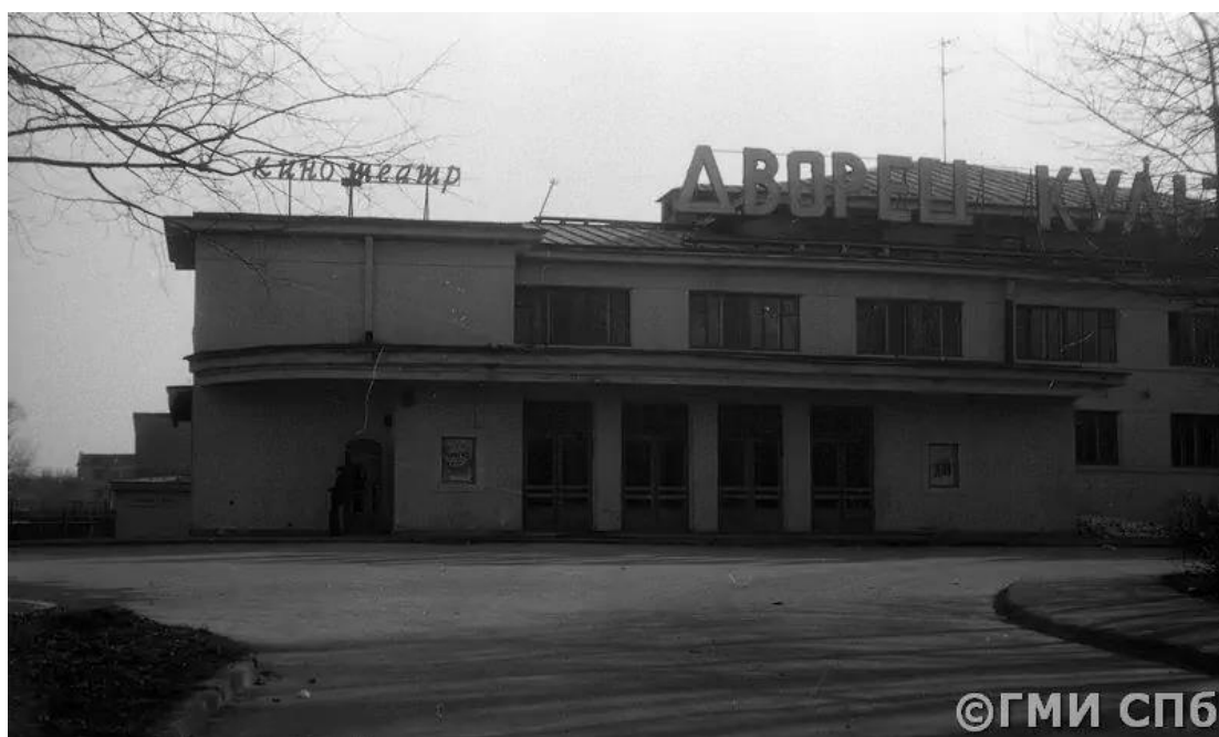
24. Дом культуры им. В.И. Ленина (Дворец культуры им. В.И. Ленина завода «Большевик») по адресу: г. Санкт-Петербург, пр. Обуховской Обороны, д. 223. Фрагмент северного фасада. Фотография. 1979 г. ГМИ СПб. www.pastvu.com .
