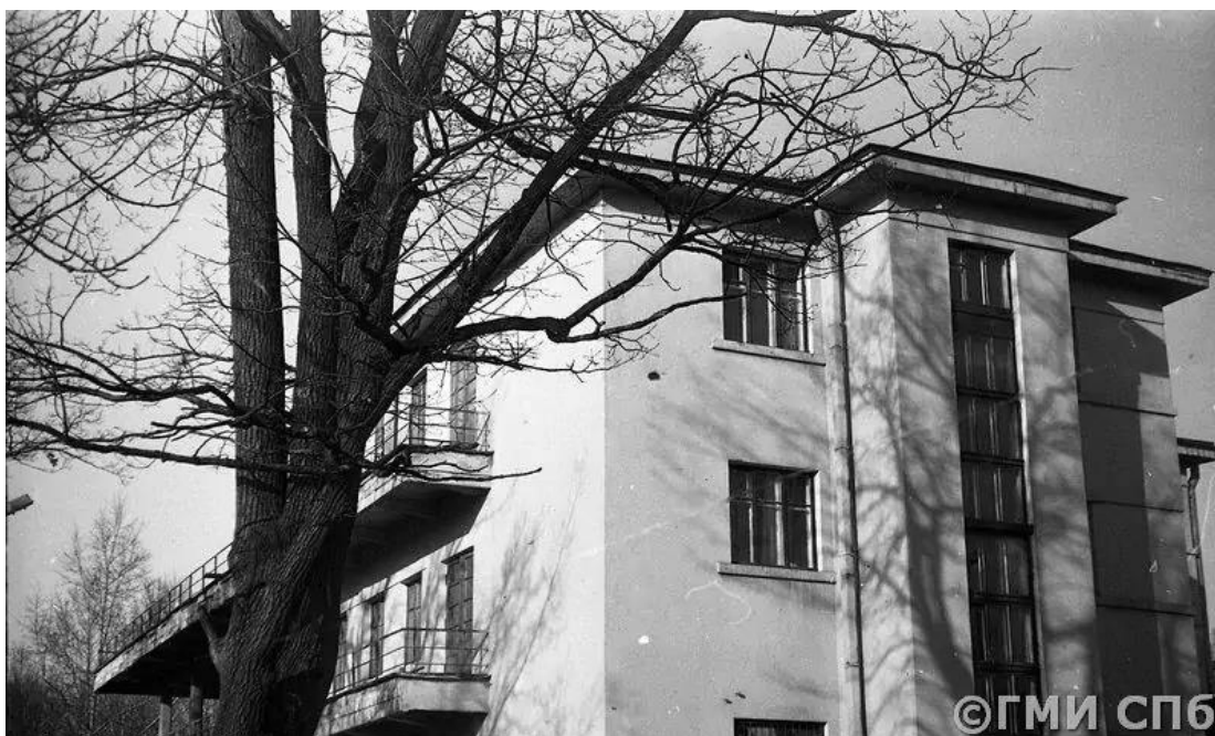
31. Дом культуры им. В.И. Ленина (Дворец культуры им. В.И. Ленина завода «Большевик») по адресу: г. Санкт-Петербург, пр. Обуховской Обороны, д. 223. Вид с юго-запада. Фотография. 1979 г. ГМИ СПб. www.pastvu.com .
