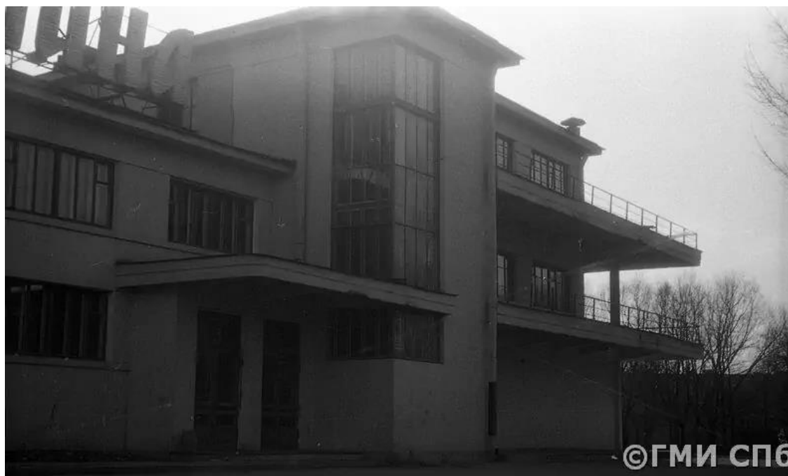
25. Дом культуры им. В.И. Ленина (Дворец культуры им. В.И. Ленина завода «Большевик») по адресу: г. Санкт-Петербург, пр. Обуховской Обороны, д. 223. Фрагмент северного фасада. Фотография. 1979 г. ГМИ СПб. www.pastvu.com .
