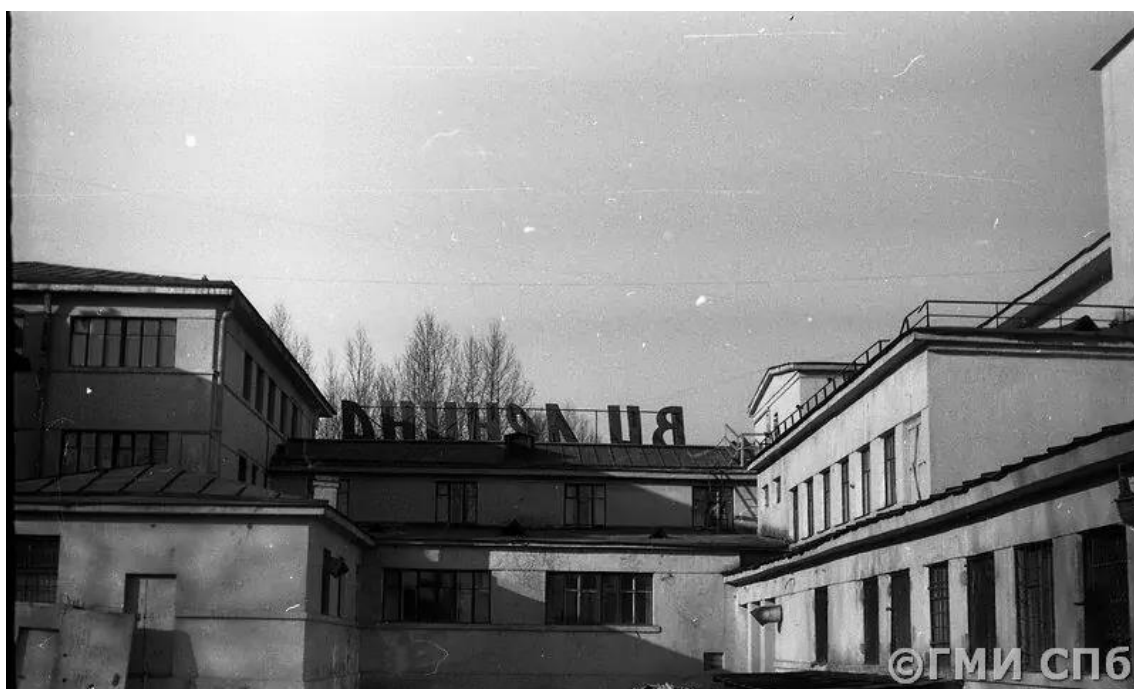
26. Дом культуры им. В.И. Ленина (Дворец культуры им. В.И. Ленина завода «Большевик») по адресу: г. Санкт-Петербург, пр. Обуховской Обороны, д. 223. Фрагмент южного фасада. Фотография. 1979 г. ГМИ СПб. www.pastvu.com .
