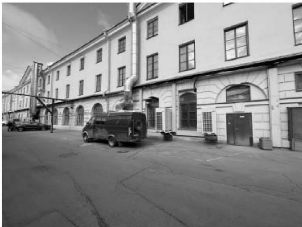
Фото 1. Фрагмент дворового фасада объекта культурного наследия федерального значения «Казармы (трехэскадронный корпус)», входящего в состав объекта культурного наследия федерального значения «Манеж и казармы Конногвардейского полка»
