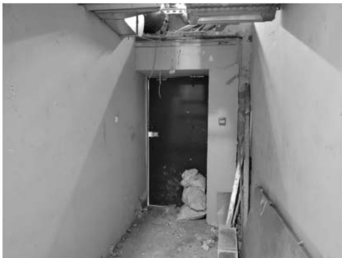
Фото 30. Интерьер пом. 6-Н и 7-Н объекта культурного наследия федерального значения «Казармы (трехэскадронный корпус)», входящего в состав объекта культурного наследия федерального значения «Манеж и казармы Конногвардейского полка»
