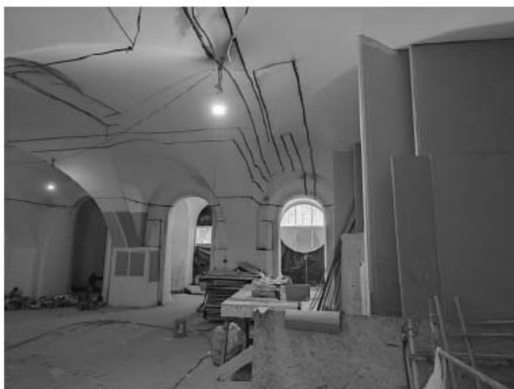
Фото 6. Интерьер пом. 6-Н и 7-Н объекта культурного наследия федерального значения «Казармы (трехэскадронный корпус)», входящего в состав объекта культурного наследия федерального значения «Манеж и казармы Конногвардейского полка»
