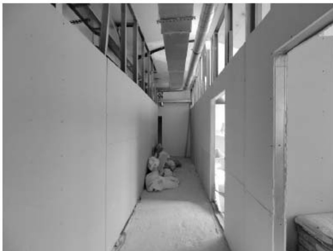
Фото 25. Интерьер пом. 6-Н и 7-Н объекта культурного наследия федерального значения «Казармы (трехэскадронный корпус)», входящего в состав объекта культурного наследия федерального значения «Манеж и казармы Конногвардейского полка»
