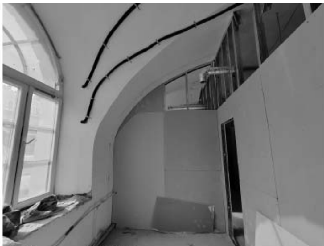
Фото 22. Интерьер пом. 6-Н и 7-Н объекта культурного наследия федерального значения «Казармы (трехэскадронный корпус)», входящего в состав объекта культурного наследия федерального значения «Манеж и казармы Конногвардейского полка»
