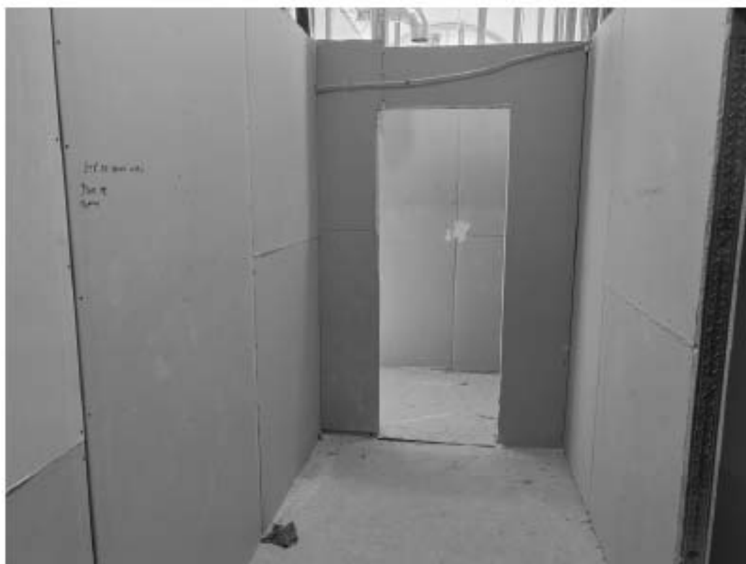
Фото 19. Интерьер пом. 6-Н и 7-Н объекта культурного наследия федерального значения «Казармы (трехэскадронный корпус)», входящего в состав объекта культурного наследия федерального значения «Манеж и казармы Конногвардейского полка»
