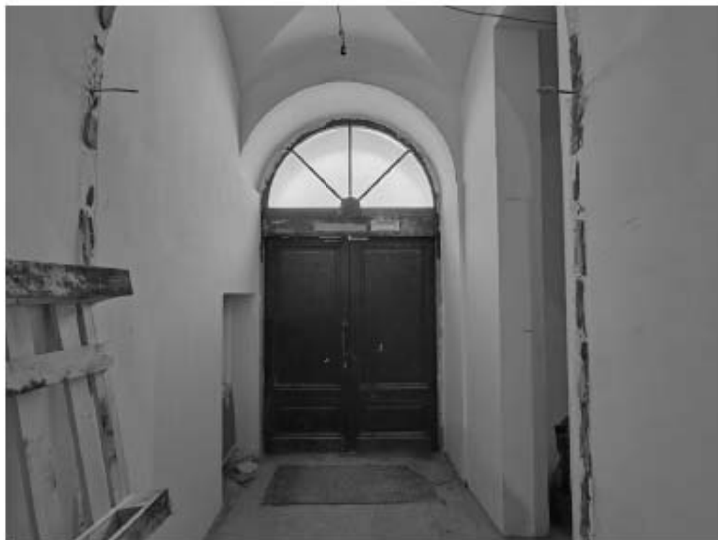
Фото 12. Интерьер пом. 6-Н и 7-Н объекта культурного наследия федерального значения «Казармы (трехэскадронный корпус)», входящего в состав объекта культурного наследия федерального значения «Манеж и казармы Конногвардейского полка»
