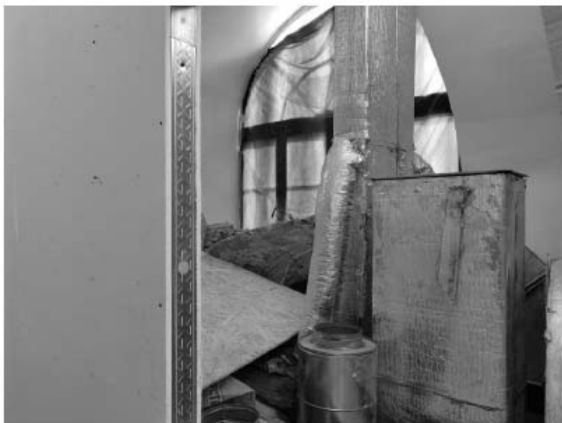
Фото 23. Интерьер пом. 6-Н и 7-Н объекта культурного наследия федерального значения «Казармы (трехэскадронный корпус)», входящего в состав объекта культурного наследия федерального значения «Манеж и казармы Конногвардейского полка»
