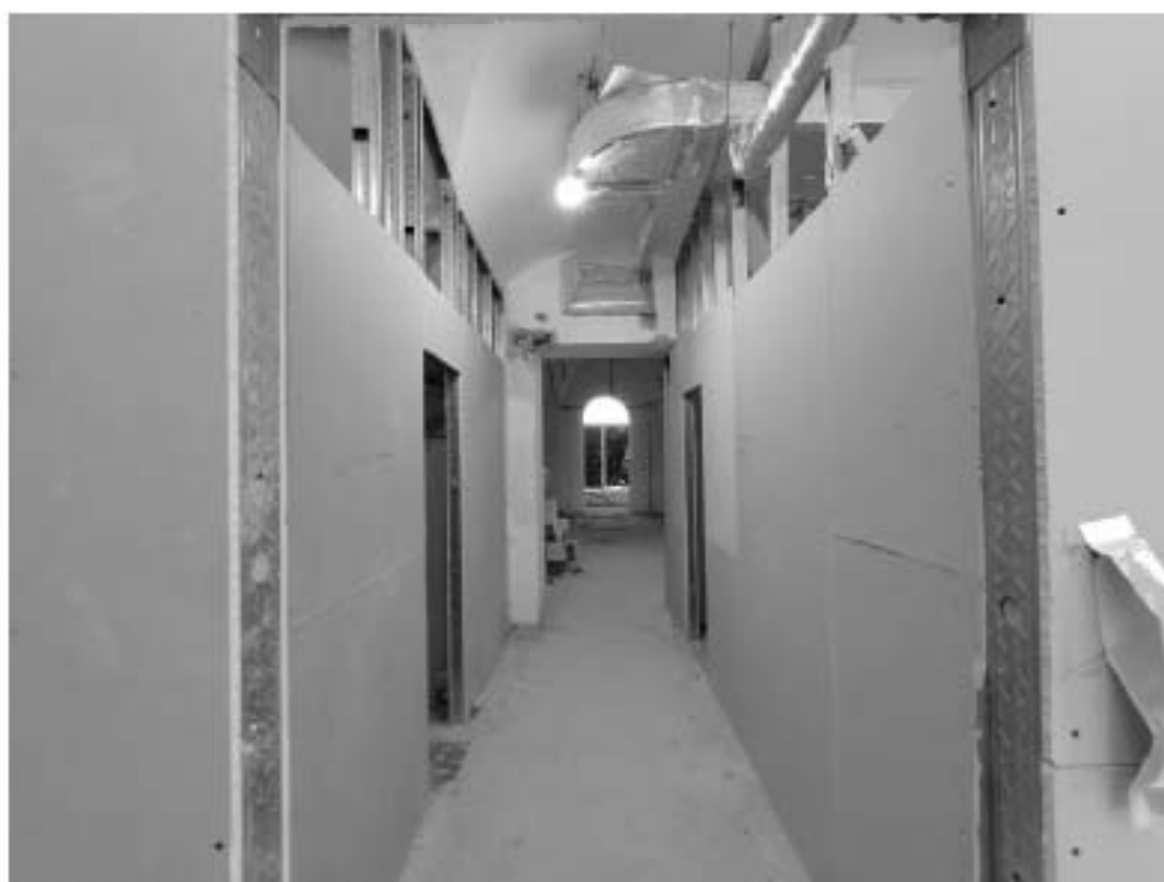
Фото 20. Интерьер пом. 6-Н и 7-Н объекта культурного наследия федерального значения «Казармы (трехэскадронный корпус)», входящего в состав объекта культурного наследия федерального значения «Манеж и казармы Конногвардейского полка»
