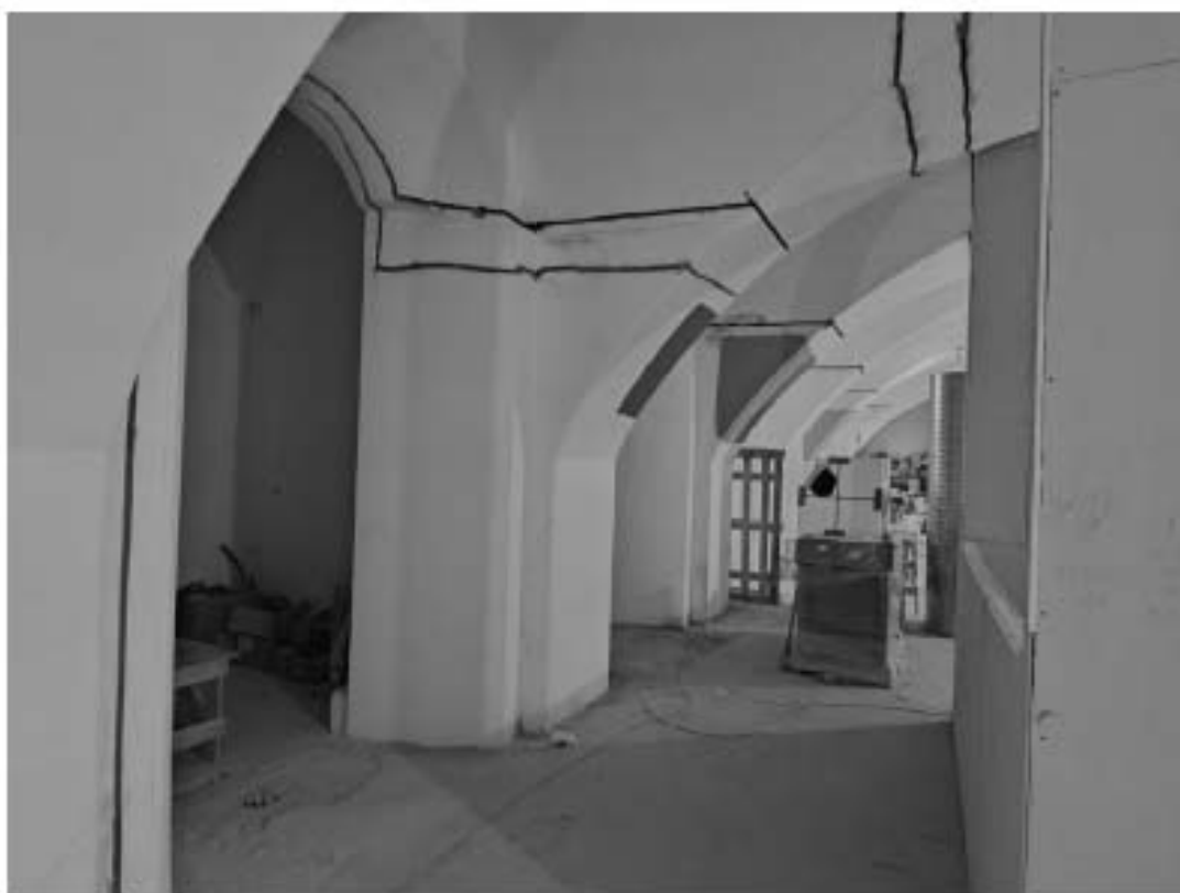
Фото 15. Интерьер пом. 6-Н и 7-Н объекта культурного наследия федерального значения «Казармы (трехэскадронный корпус)», входящего в состав объекта культурного наследия федерального значения «Манеж и казармы Конногвардейского полка»
