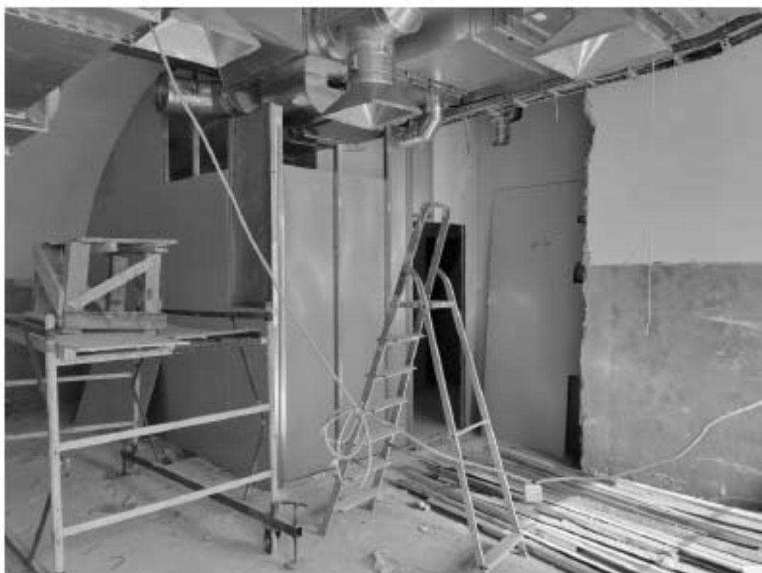
Фото 37. Интерьер пом. 6-Н и 7-Н объекта культурного наследия федерального значения «Казармы (трехэскадронный корпус)», входящего в состав объекта культурного наследия федерального значения «Манеж и казармы Конногвардейского полка»
