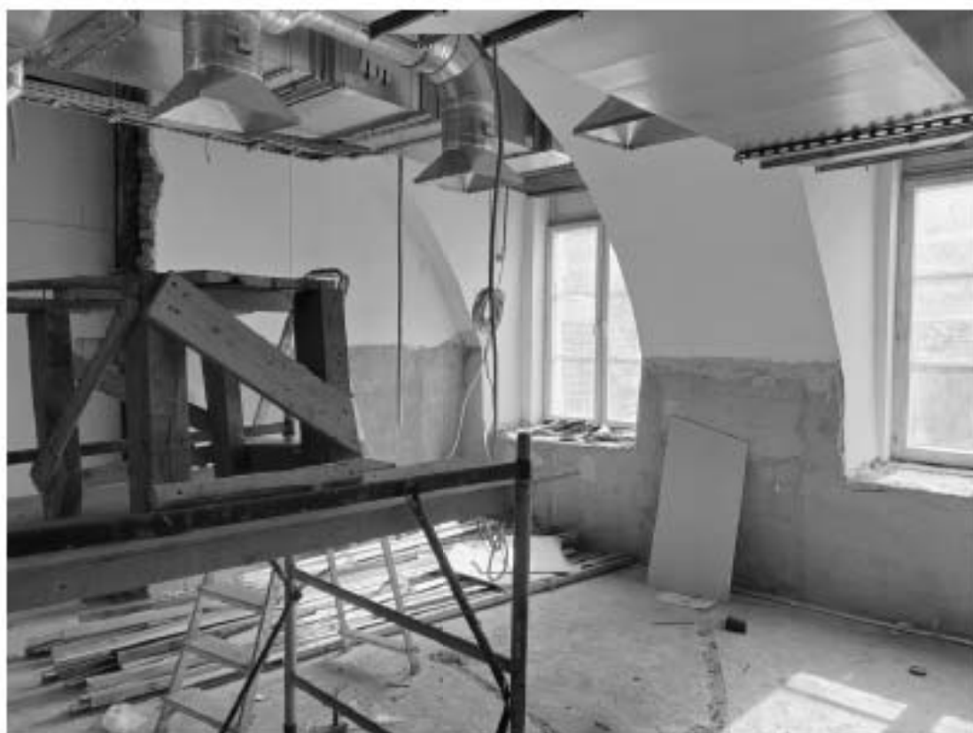
Фото 38. Интерьер пом. 6-Н и 7-Н объекта культурного наследия федерального значения «Казармы (трехэскадронный корпус)», входящего в состав объекта культурного наследия федерального значения «Манеж и казармы Конногвардейского полка»
