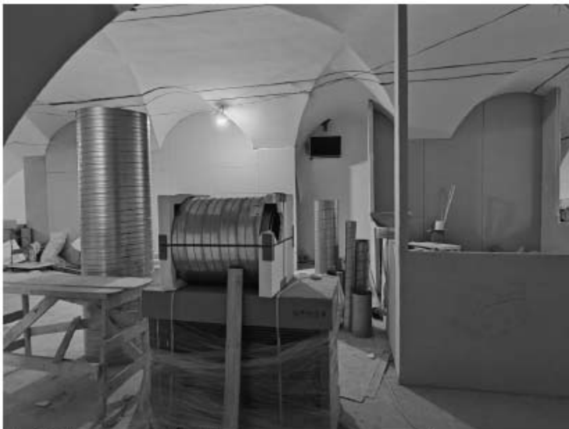
Фото 13. Интерьер пом. 6-Н и 7-Н объекта культурного наследия федерального значения «Казармы (трехэскадронный корпус)», входящего в состав объекта культурного наследия федерального значения «Манеж и казармы Конногвардейского полка»
