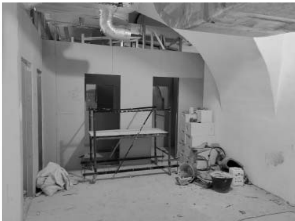
Фото 29. Интерьер пом. 6-Н и 7-Н объекта культурного наследия федерального значения «Казармы (трехэскадронный корпус)», входящего в состав объекта культурного наследия федерального значения «Манеж и казармы Конногвардейского полка»
