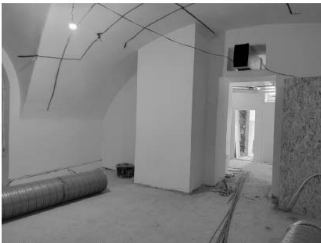
Фото 35. Интерьер пом. 6-Н и 7-Н объекта культурного наследия федерального значения «Казармы (трехэскадронный корпус)», входящего в состав объекта культурного наследия федерального значения «Манеж и казармы Конногвардейского полка»
