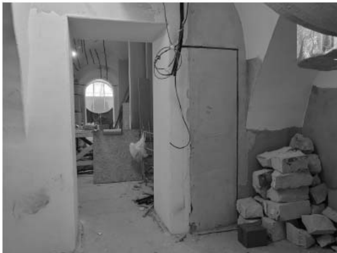
Фото 31. Интерьер пом. 6-Н и 7-Н объекта культурного наследия федерального значения «Казармы (трехэскадронный корпус)», входящего в состав объекта культурного наследия федерального значения «Манеж и казармы Конногвардейского полка»
