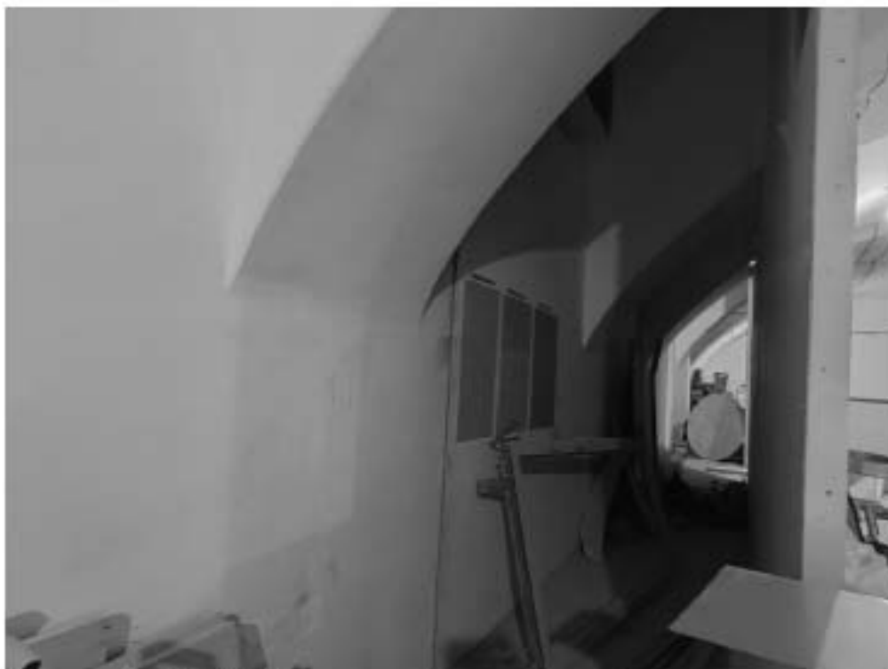
Фото 7. Интерьер пом. 6-Н и 7-Н объекта культурного наследия федерального значения «Казармы (трехэскадронный корпус)», входящего в состав объекта культурного наследия федерального значения «Манеж и казармы Конногвардейского полка»
