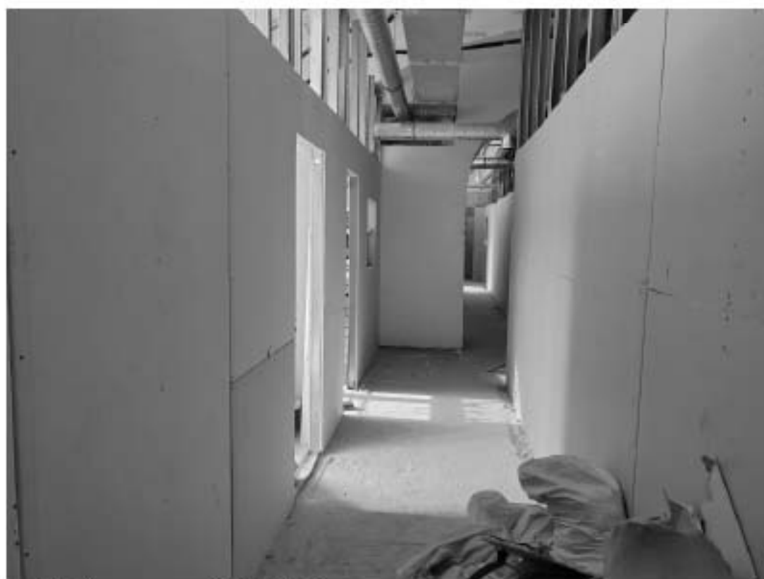
Фото 28. Интерьер пом. 6-Н и 7-Н объекта культурного наследия федерального значения «Казармы (трехэскадронный корпус)», входящего в состав объекта культурного наследия федерального значения «Манеж и казармы Конногвардейского полка»
