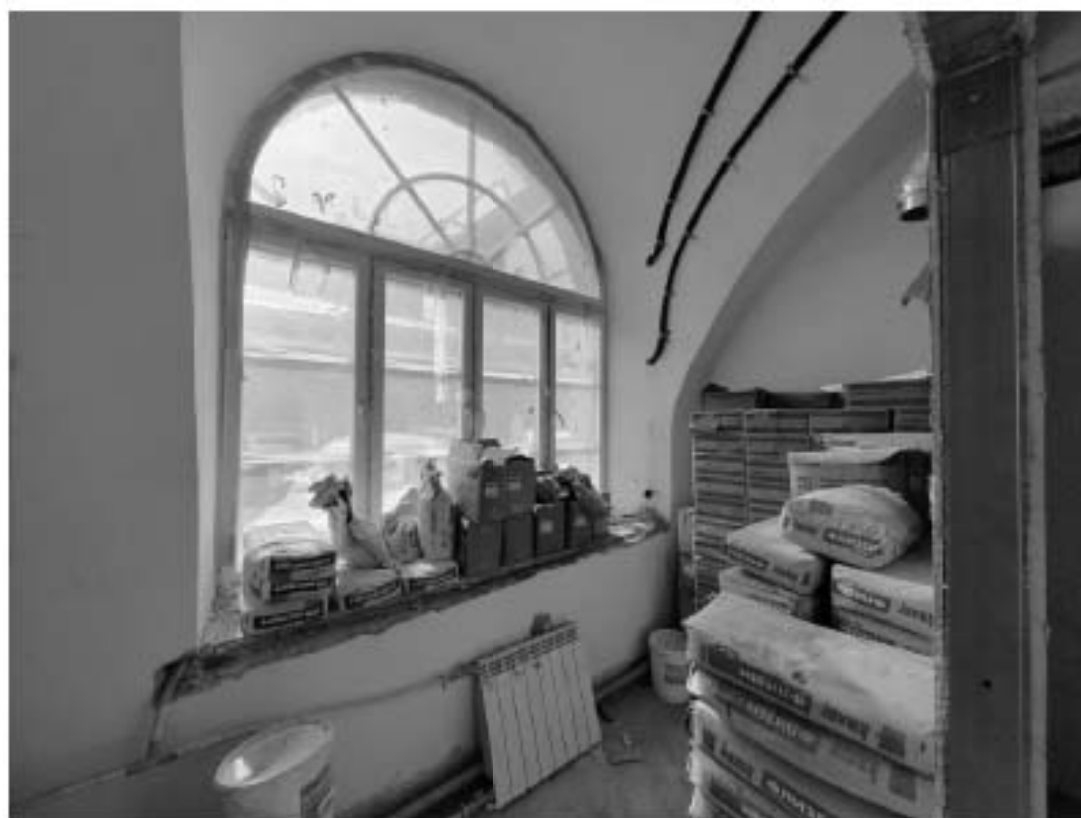
Фото 26. Интерьер пом. 6-Н и 7-Н объекта культурного наследия федерального значения «Казармы (трехэскадронный корпус)», входящего в состав объекта культурного наследия федерального значения «Манеж и казармы Конногвардейского полка»
