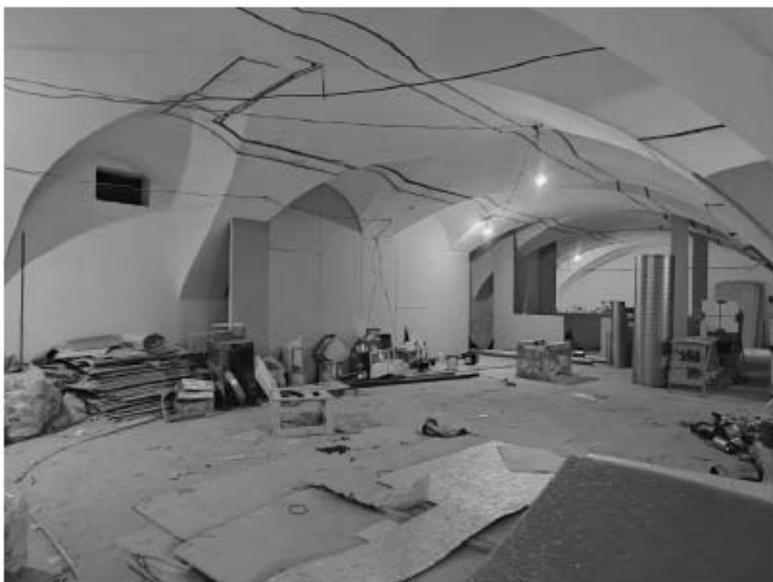
Фото 8. Интерьер пом. 6-Н и 7-Н объекта культурного наследия федерального значения «Казармы (трехэскадронный корпус)», входящего в состав объекта культурного наследия федерального значения «Манеж и казармы Конногвардейского полка»
