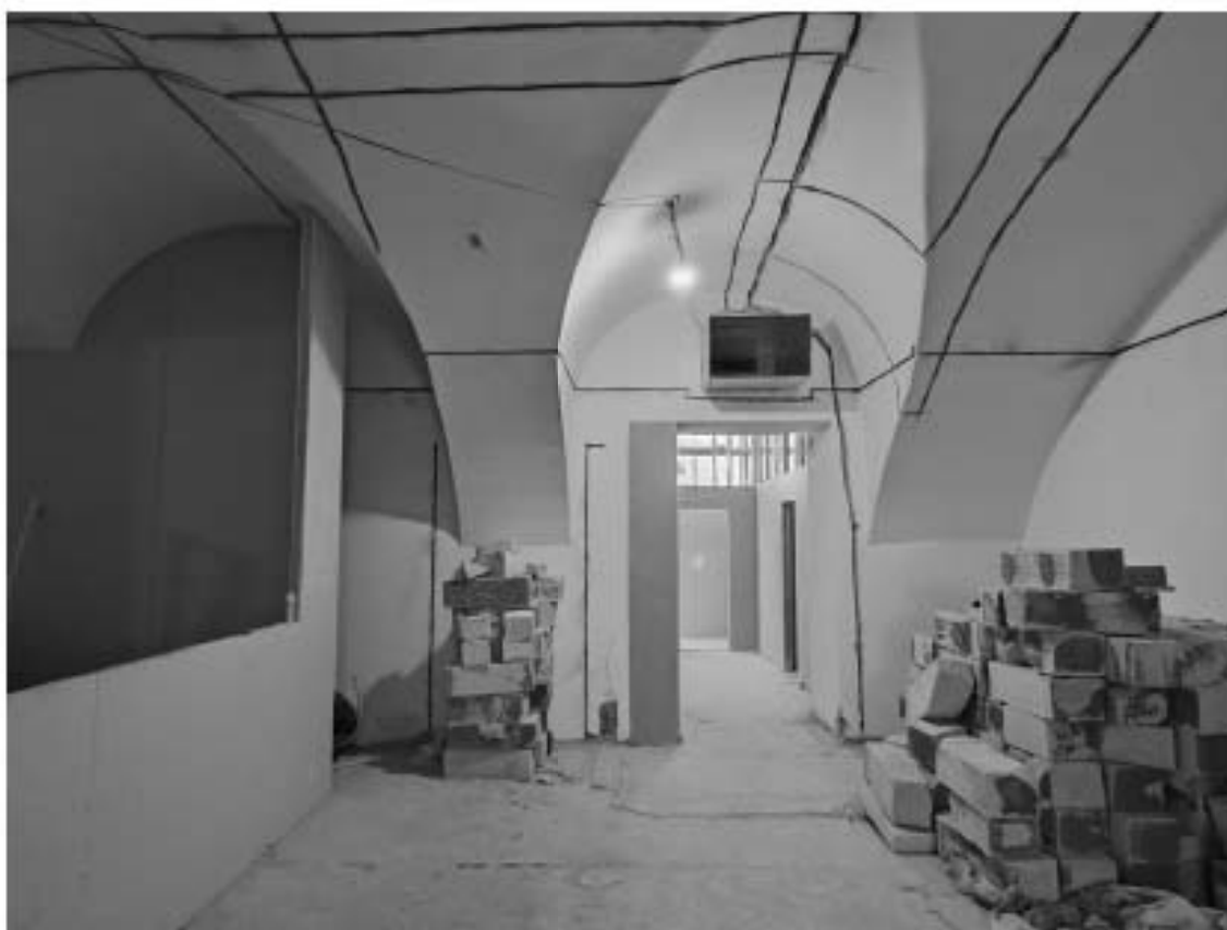
Фото 16. Интерьер пом. 6-Н и 7-Н объекта культурного наследия федерального значения «Казармы (трехэскадронный корпус)», входящего в состав объекта культурного наследия федерального значения «Манеж и казармы Конногвардейского полка»
