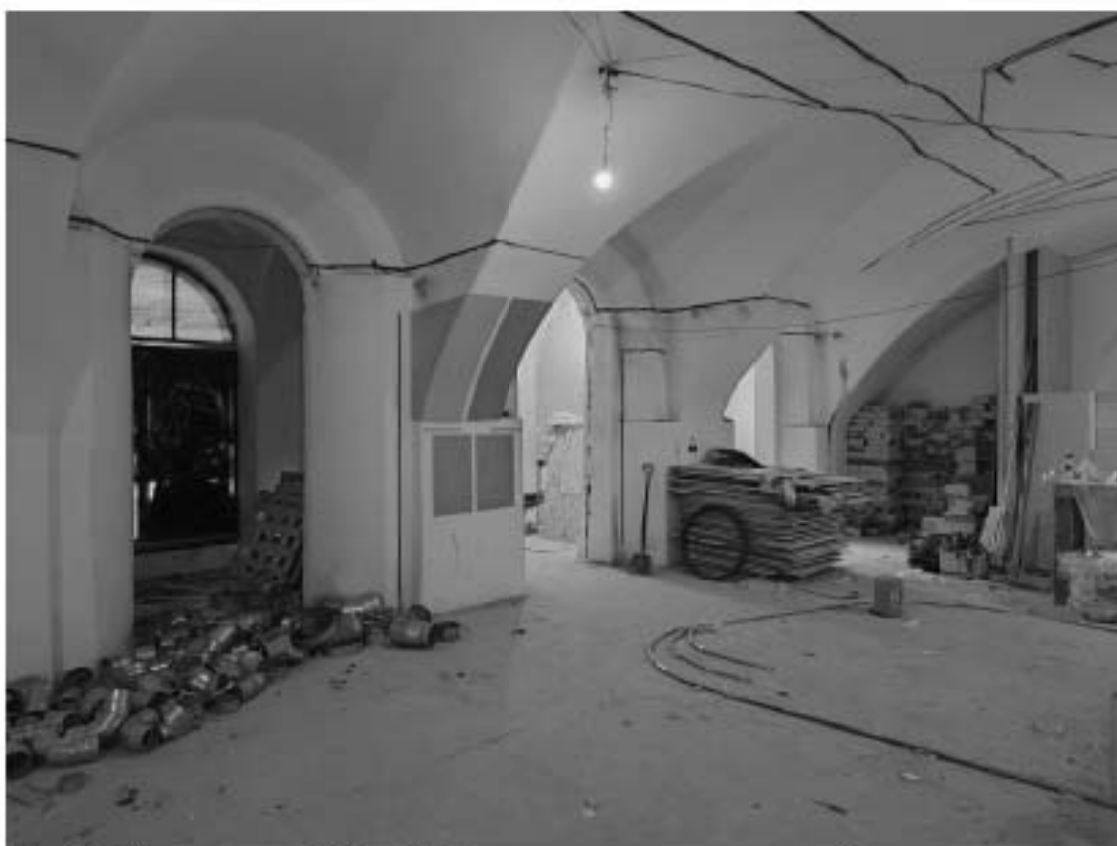
Фото 11. Интерьер пом. 6-Н и 7-Н объекта культурного наследия федерального значения «Казармы (трехэскадронный корпус)», входящего в состав объекта культурного наследия федерального значения «Манеж и казармы Конногвардейского полка»
