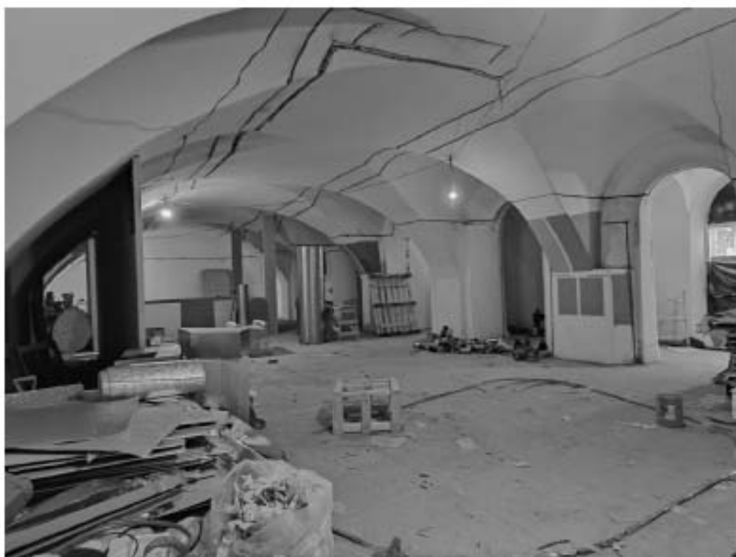
Фото 5. Интерьер пом. 6-Н и 7-Н объекта культурного наследия федерального значения «Казармы (трехэскадронный корпус)», входящего в состав объекта культурного наследия федерального значения «Манеж и казармы Конногвардейского полка»
