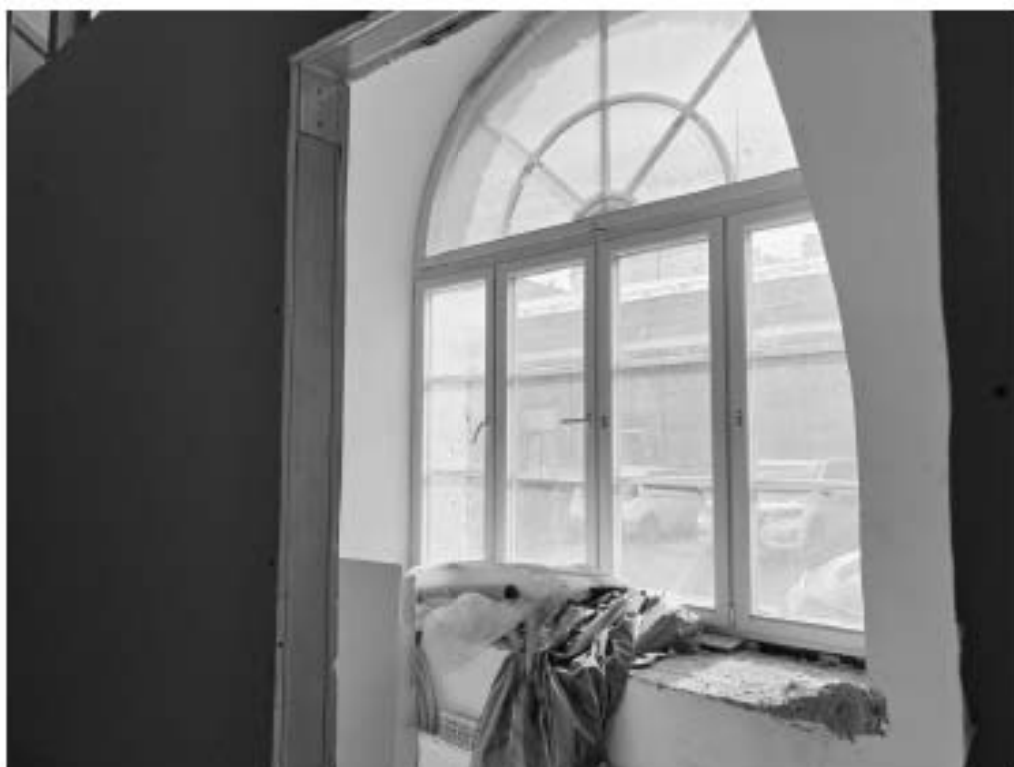
Фото 27. Интерьер пом. 6-Н и 7-Н объекта культурного наследия федерального значения «Казармы (трехэскадронный корпус)», входящего в состав объекта культурного наследия федерального значения «Манеж и казармы Конногвардейского полка»
