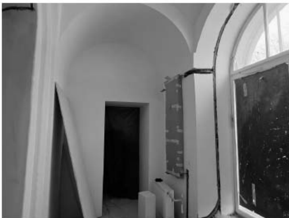
Фото 17. Интерьер пом. 6-Н и 7-Н объекта культурного наследия федерального значения «Казармы (трехэскадронный корпус)», входящего в состав объекта культурного наследия федерального значения «Манеж и казармы Конногвардейского полка»
