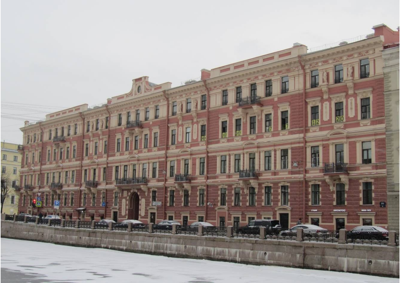
2. Доходные дома М.С. Воронина. Вид на лицевой фасад по набережной р. Мойки.
