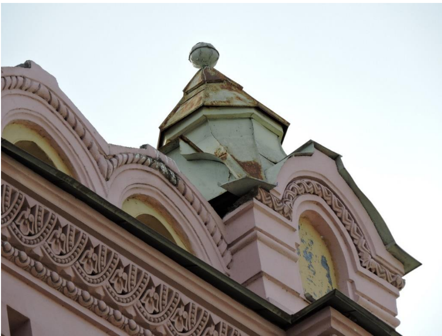
32. Объект культурного наследия регионального значения «Собственный дом архитектора Н.П. Басина», г. Санкт-Петербург, Крылова пер., 7/5, лит. А. Северный фасад. Фрагмент. Фото 28.08.2023г.
