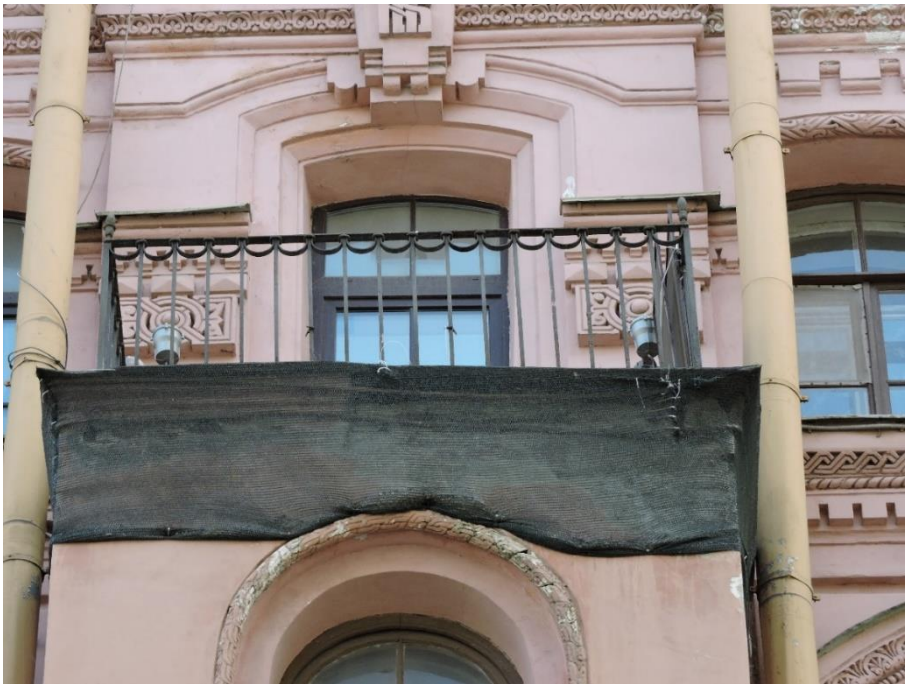
29. Объект культурного наследия регионального значения «Собственный дом архитектора Н.П. Басина», г. Санкт-Петербург, Крылова пер., 7/5, лит. А. Северный фасад. Фрагмент. Фото 28.08.2023г.
