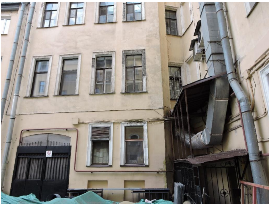
34. Объект культурного наследия регионального значения «Собственный дом архитектора Н.П. Басина», г. Санкт-Петербург, Крылова пер., 7/5, лит. А. Северный фасад. Фрагмент. Фото 28.08.2023г.
