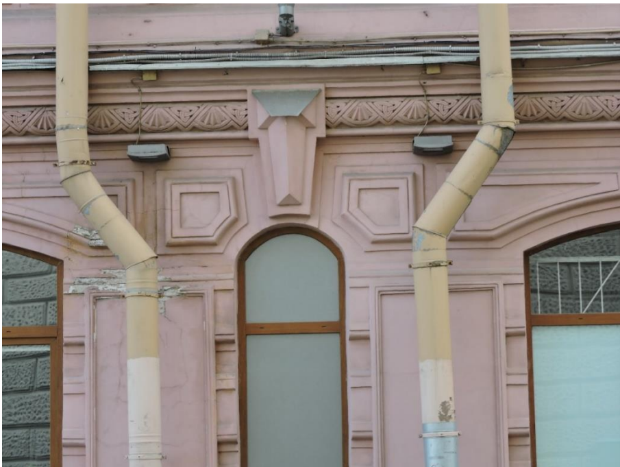
30. Объект культурного наследия регионального значения «Собственный дом архитектора Н.П. Басина», г. Санкт-Петербург, Крылова пер., 7/5, лит. А. Северный фасад. Фрагмент. Фото 28.08.2023г.
