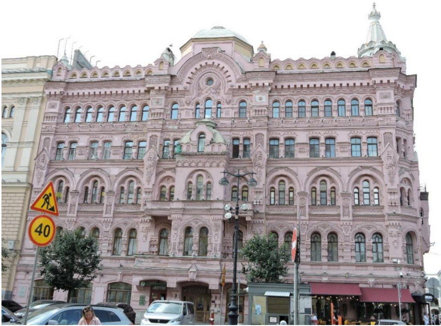
1. Объект культурного наследия регионального значения «Собственный дом архитектора Н.П. Басина», г. Санкт-Петербург, Крылова пер., 7/5, лит. А. Восточный фасад. Общий вид. Фото 28.08.2023г.
