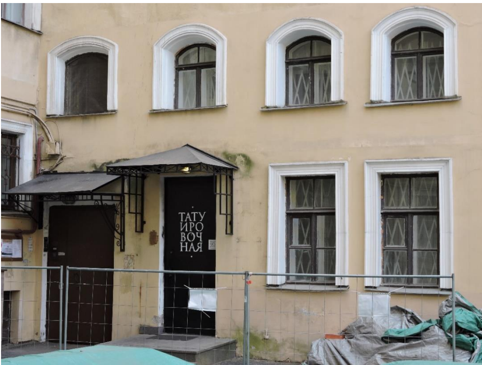
36. Объект культурного наследия регионального значения «Собственный дом архитектора Н.П. Басина», г. Санкт-Петербург, Крылова пер., 7/5, лит. А. Северный фасад. Фрагмент. Фото 28.08.2023г.
