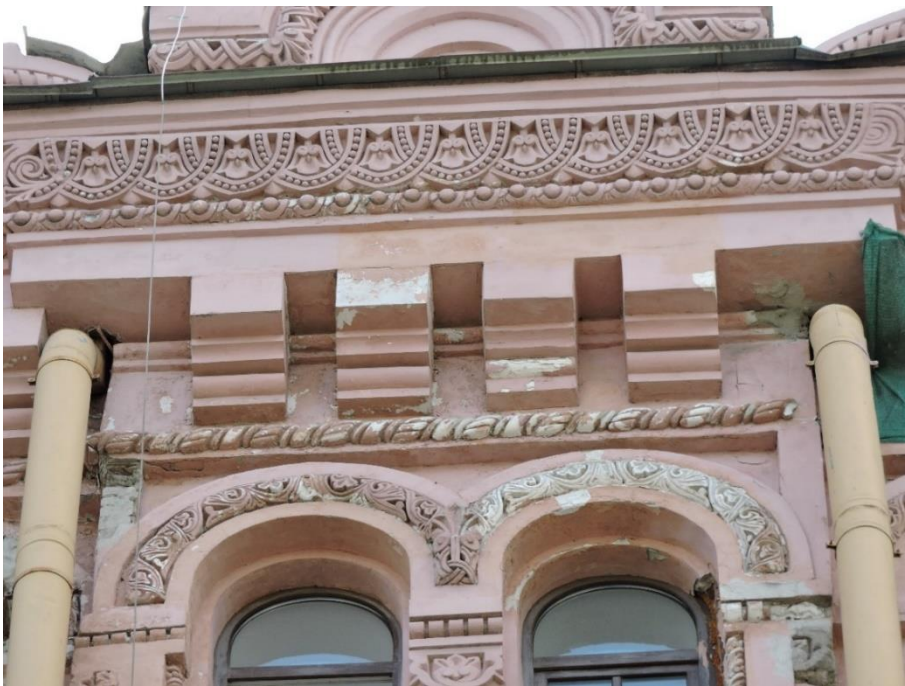
27. Объект культурного наследия регионального значения «Собственный дом архитектора Н.П. Басина», г. Санкт-Петербург, Крылова пер., 7/5, лит. А. Северный фасад. Фрагмент. Фото 28.08.2023г.
