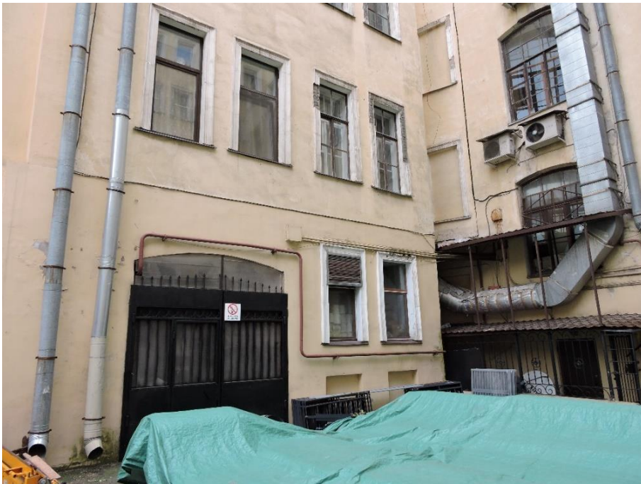
33. Объект культурного наследия регионального значения «Собственный дом архитектора Н.П. Басина», г. Санкт-Петербург, Крылова пер., 7/5, лит. А. Северный фасад. Фрагмент. Фото 28.08.2023г.
