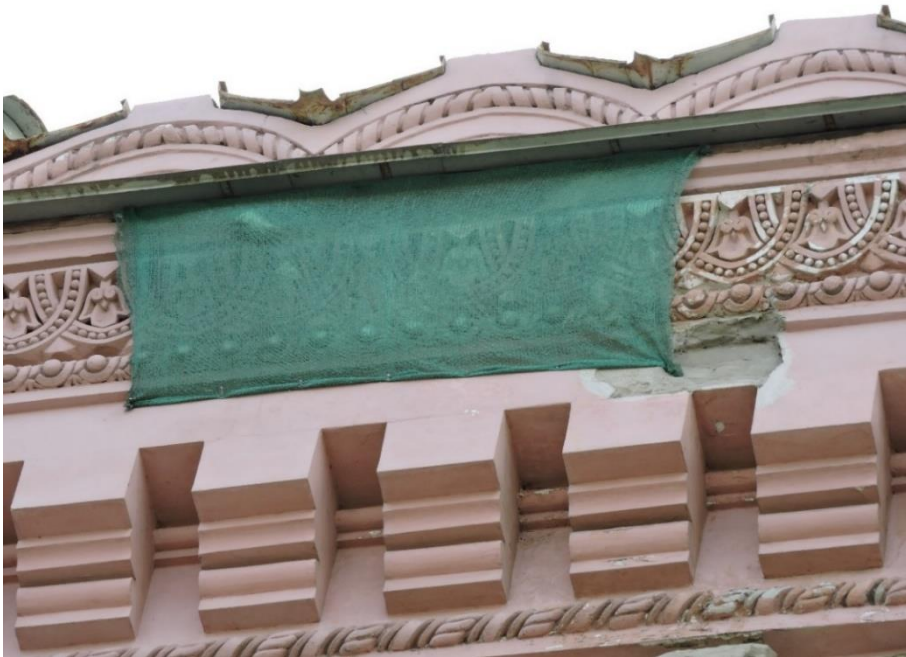
25. Объект культурного наследия регионального значения «Собственный дом архитектора Н.П. Басина», г. Санкт-Петербург, Крылова пер., 7/5, лит. А. Северный фасад. Фрагмент. Фото 28.08.2023г.
