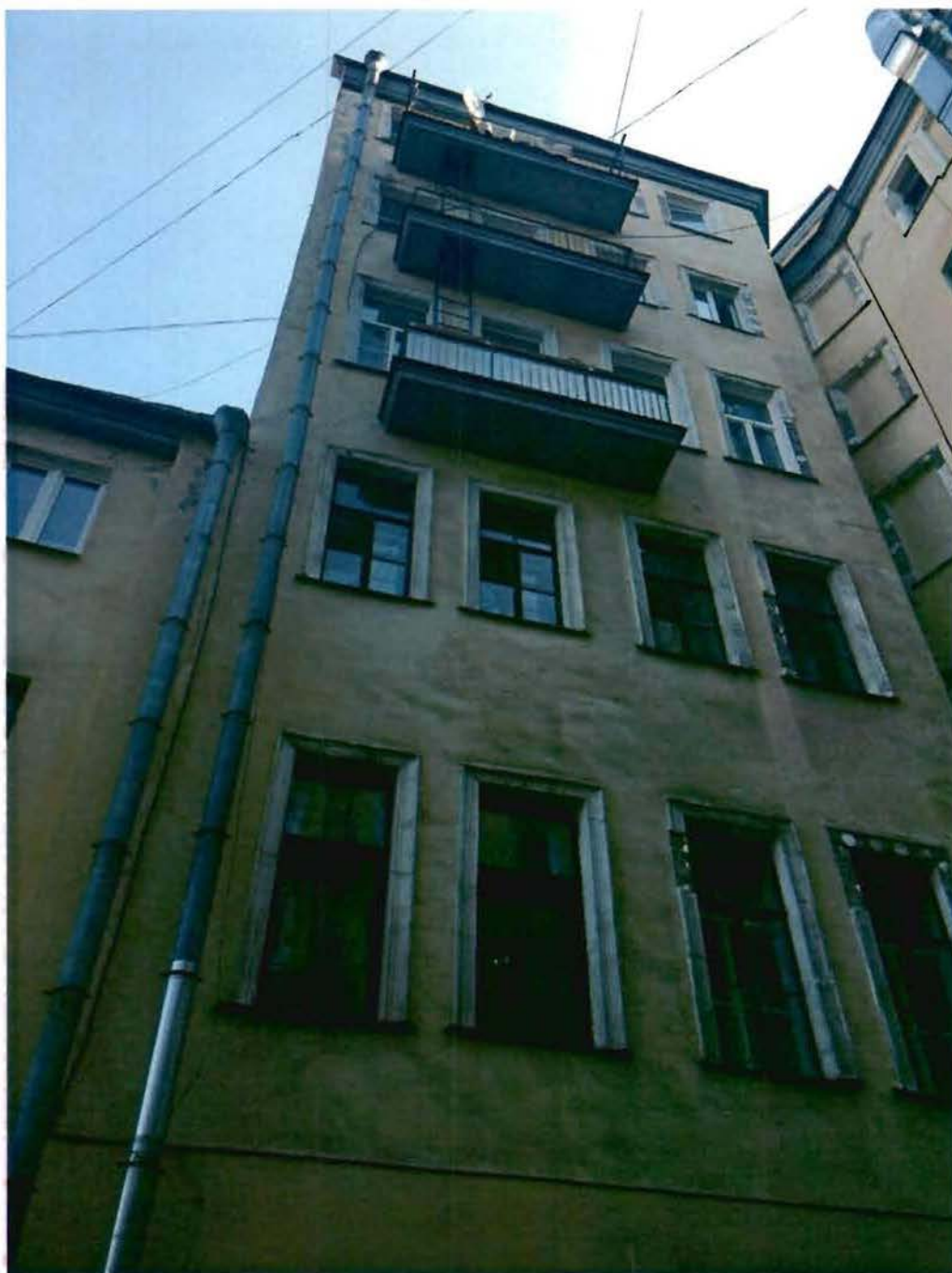
4. Дворовый фасад. Фрагмент.
