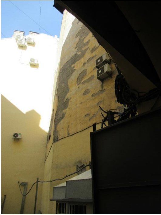
39. Объект культурного наследия регионального значения «Собственный дом архитектора Н.П. Басина», г. Санкт-Петербург, Крылова пер., 7/5, лит. А. Северный фасад. Фрагмент. Фото 28.08.2023г.
