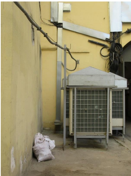
40. Объект культурного наследия регионального значения «Собственный дом архитектора Н.П. Басина», г. Санкт-Петербург, Крылова пер., 7/5, лит. А. Северный фасад. Фрагмент. Фото 28.08.2023г.
