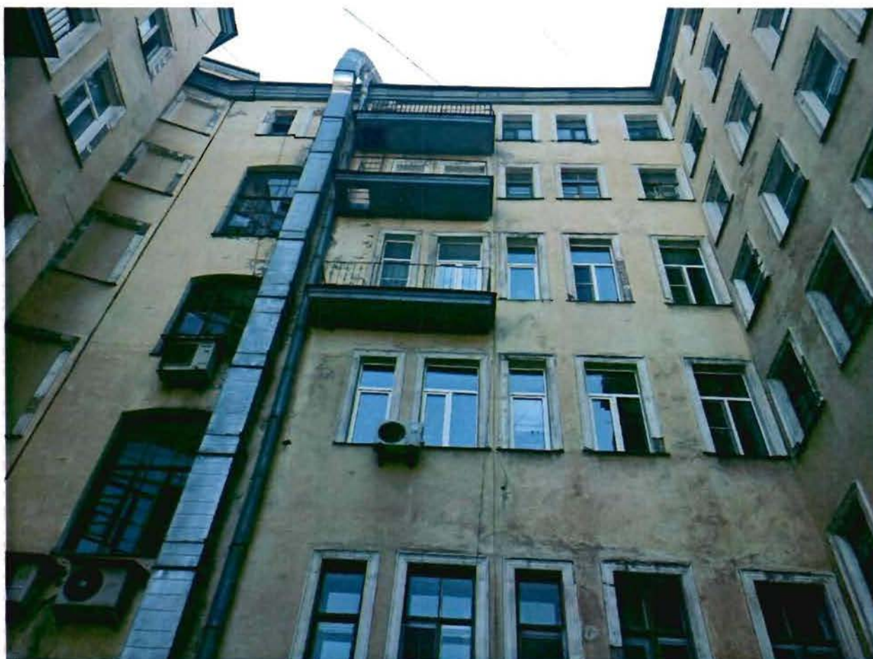
3. Дворовый фасад. Фрагмент.
