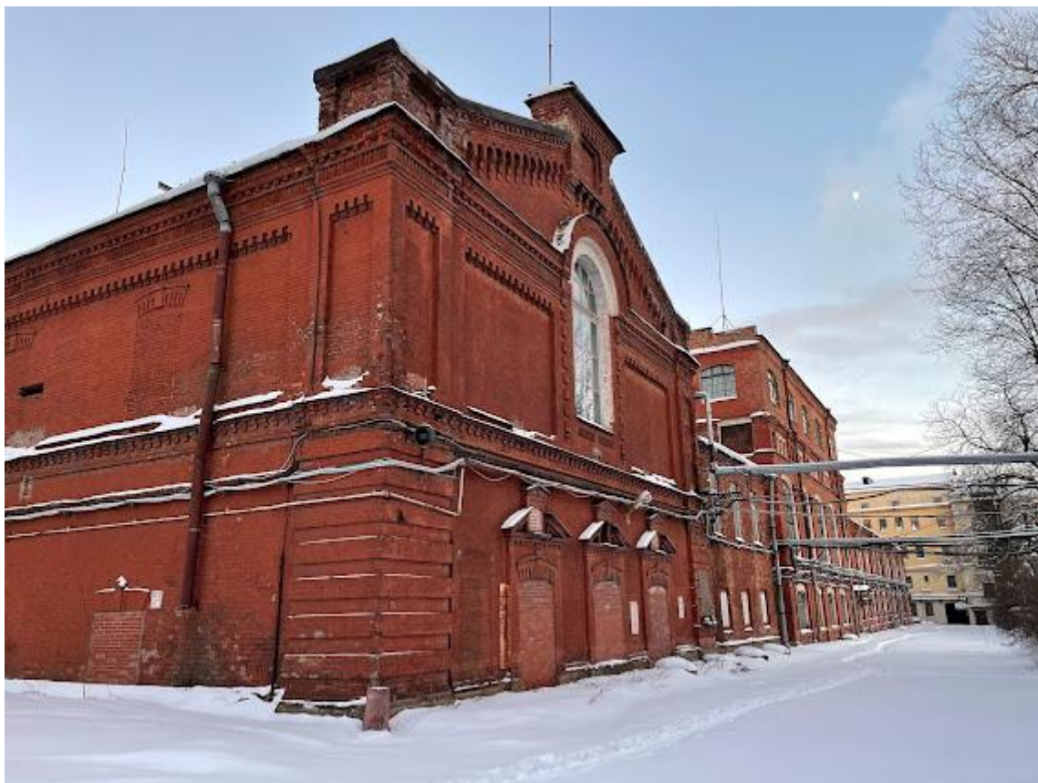
1. Вид с юго-запада
