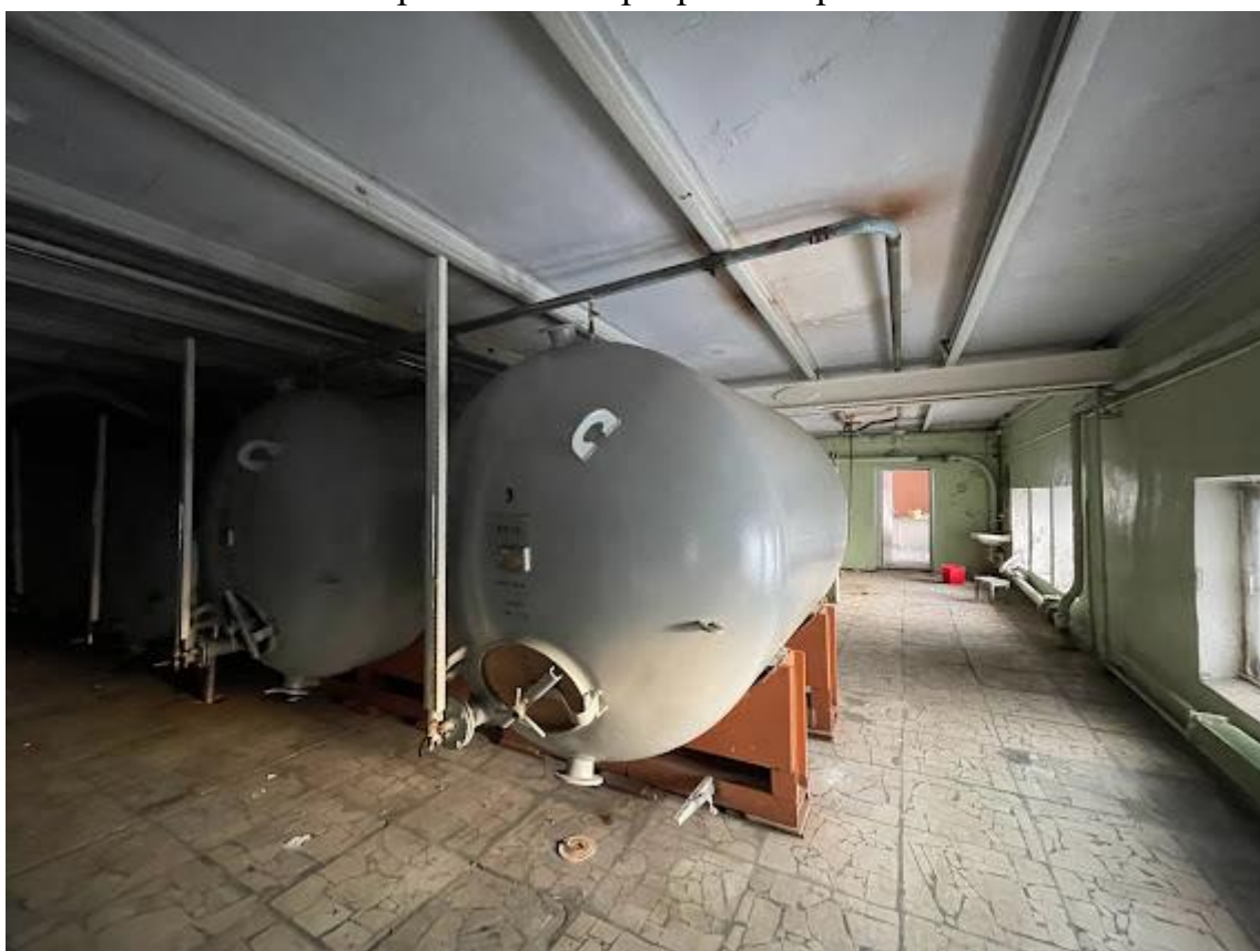
35. Фрагмент интерьера четвертого этажа
