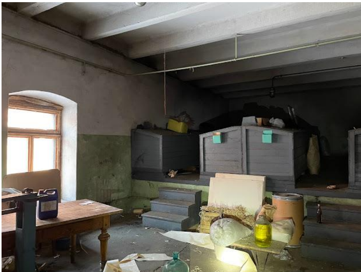
15. Фрагмент интерьера второго этажа
