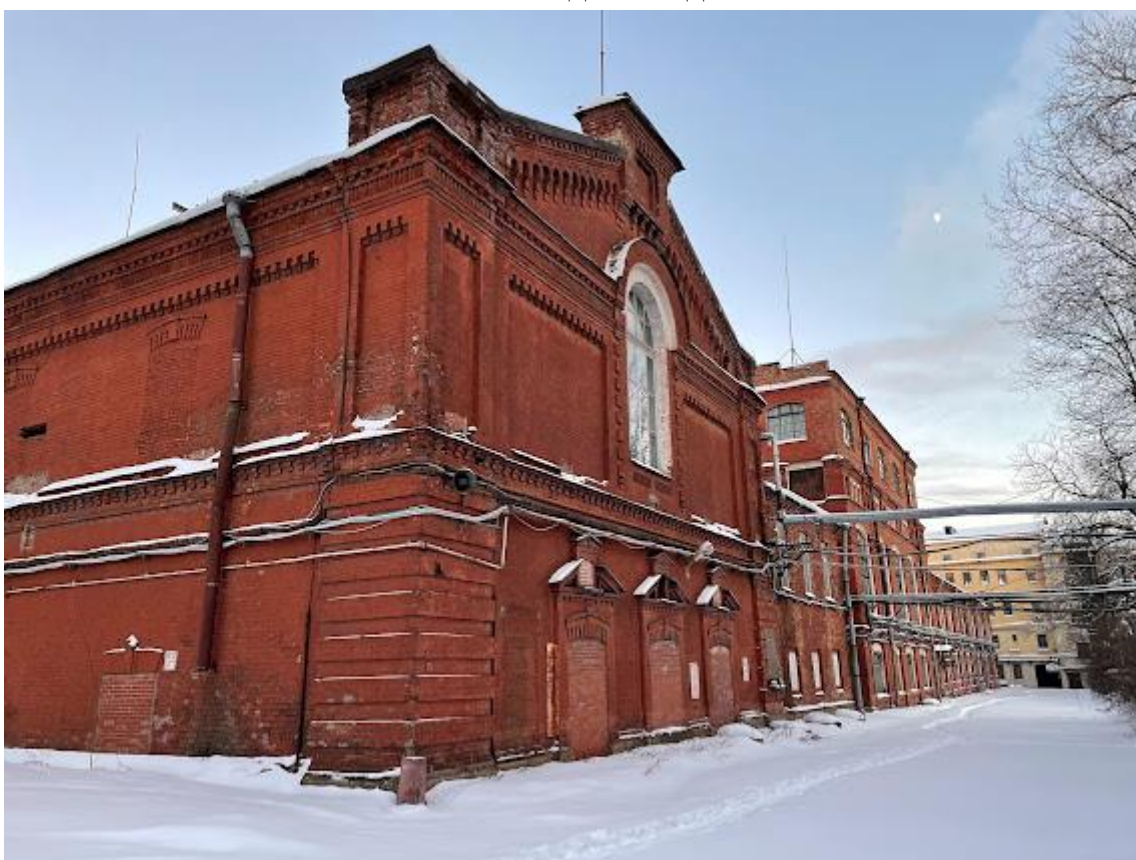
2. Вид с юго-запада
