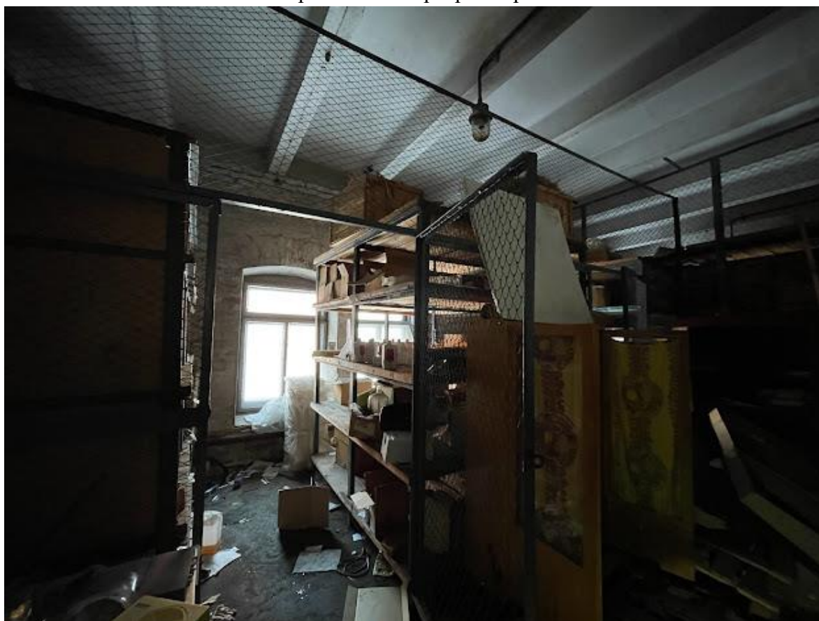
12. Фрагмент интерьера второго этажа
