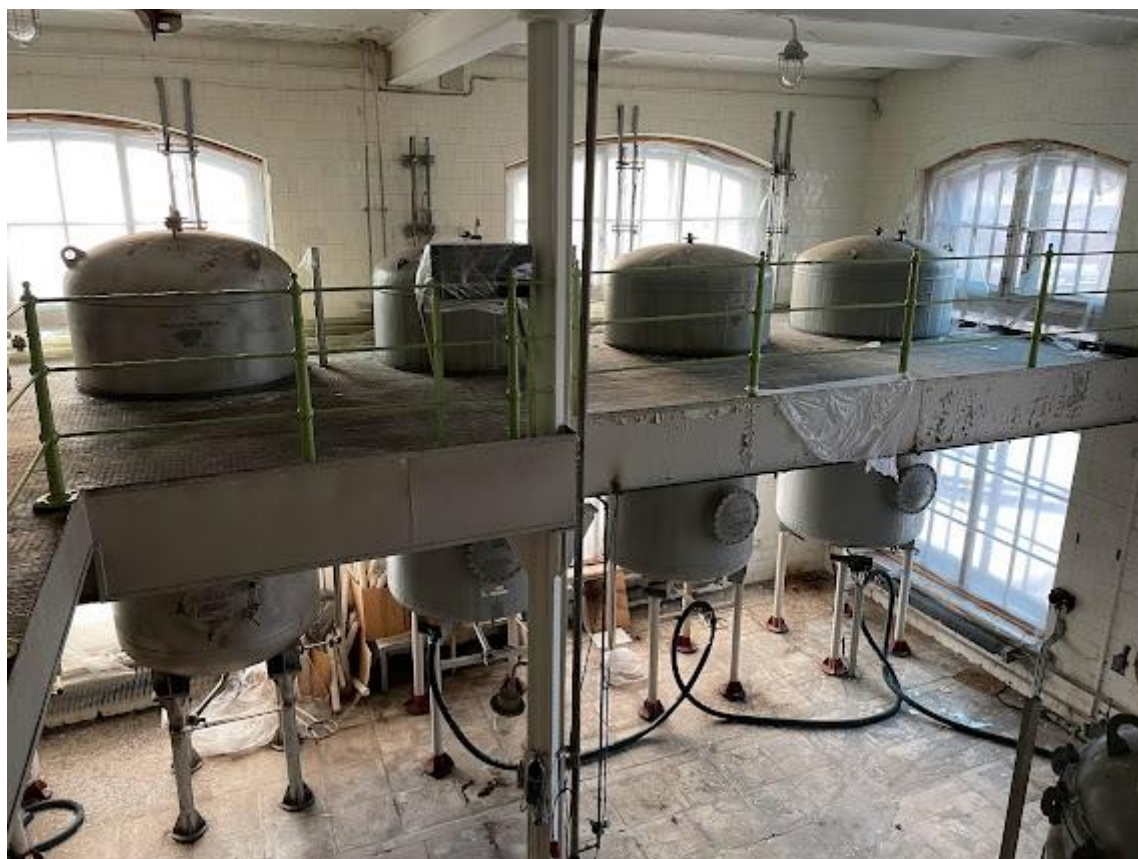
28. Фрагмент интерьера второго этажа
