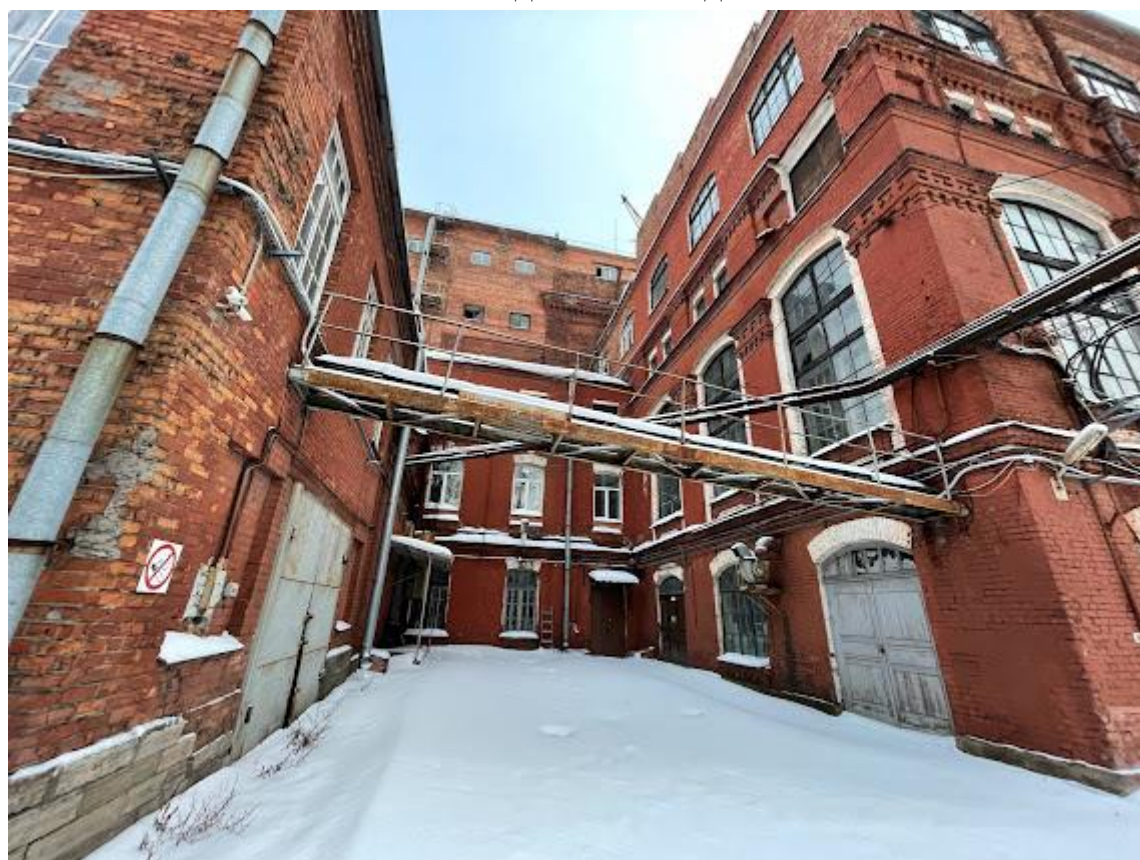
2. Фрагмент южного фасада
