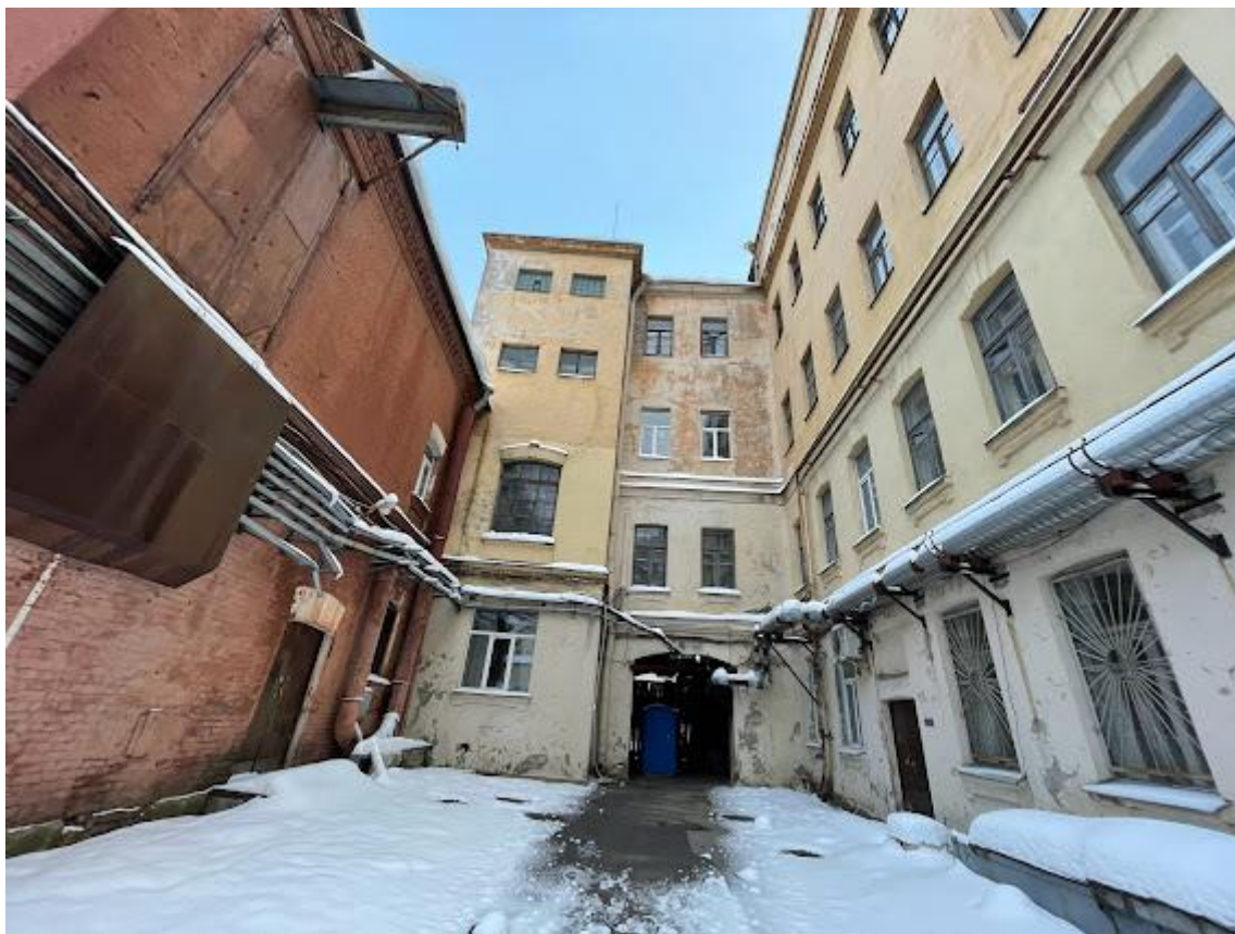
7. Вид на часть здания с воротным проездом
