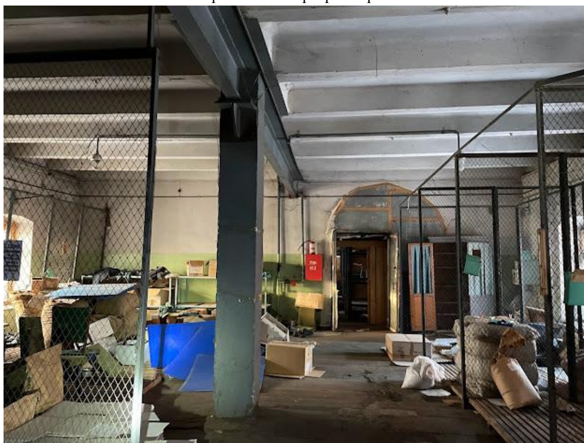
14. Фрагмент интерьера второго этажа
