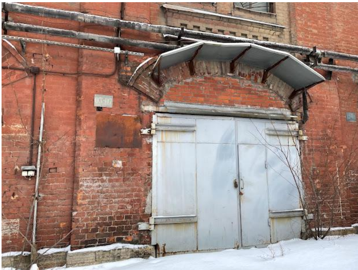
5. Ворота на южном фасаде
