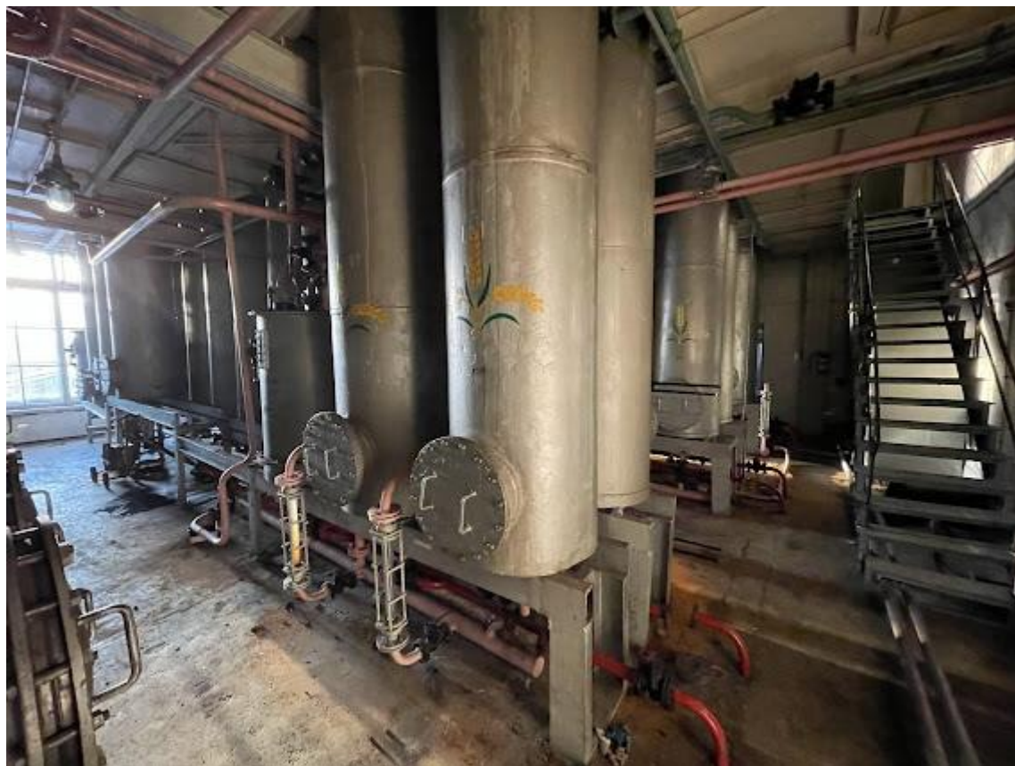
26. Фрагмент интерьера второго этажа
