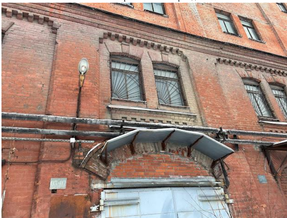
6. Оконные проемы в уровне второго этажа
