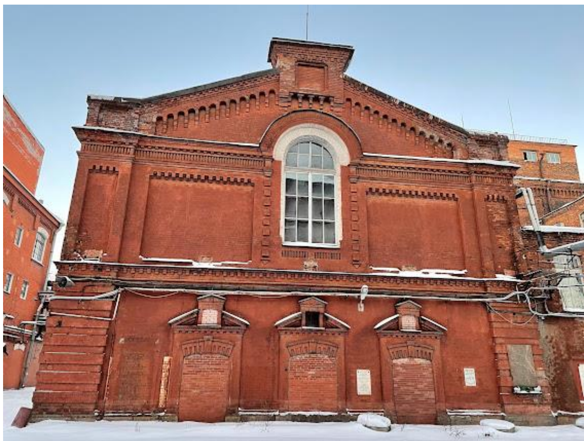
3. Фрагмент южного фасада
