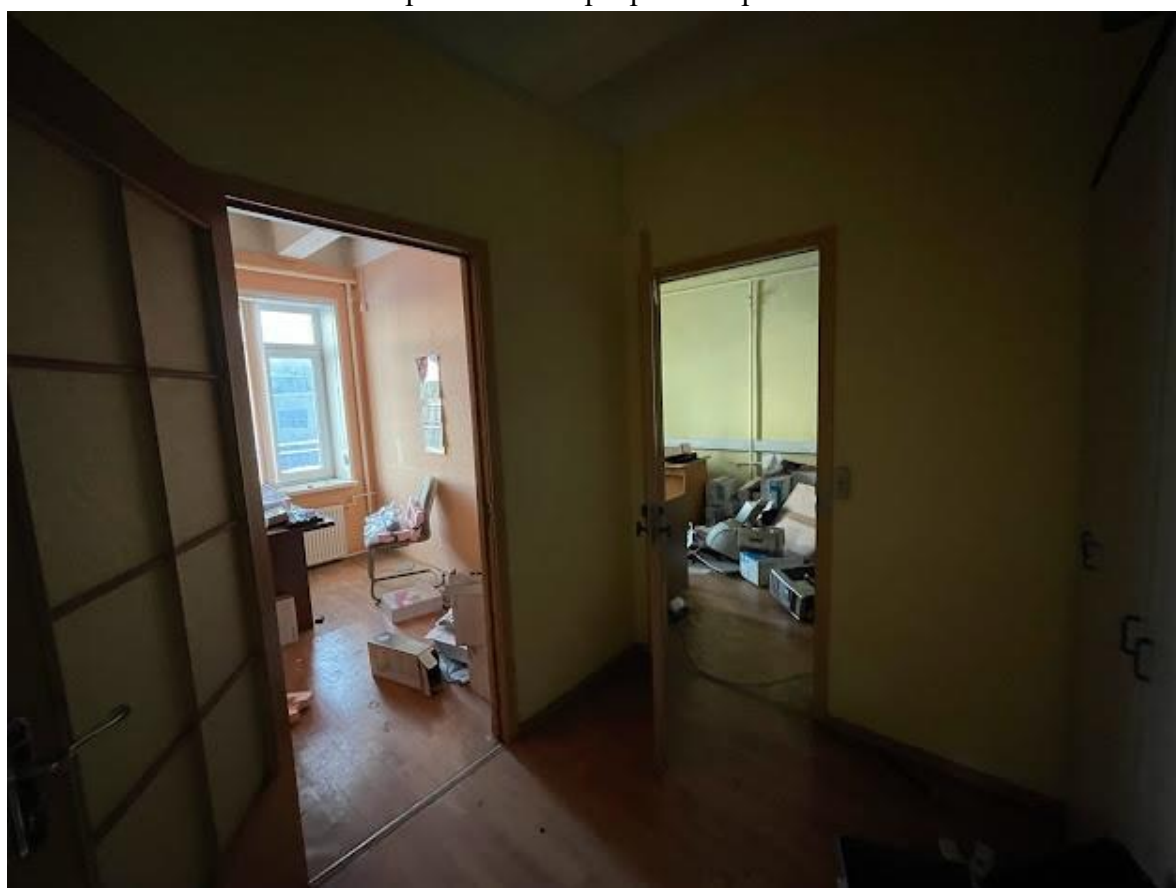
30. Фрагмент интерьера четвертого этажа
