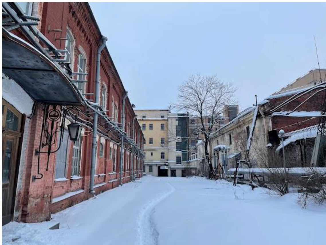
3. Фрагмент южного фасада. Вид в сторону Синопской набережной
