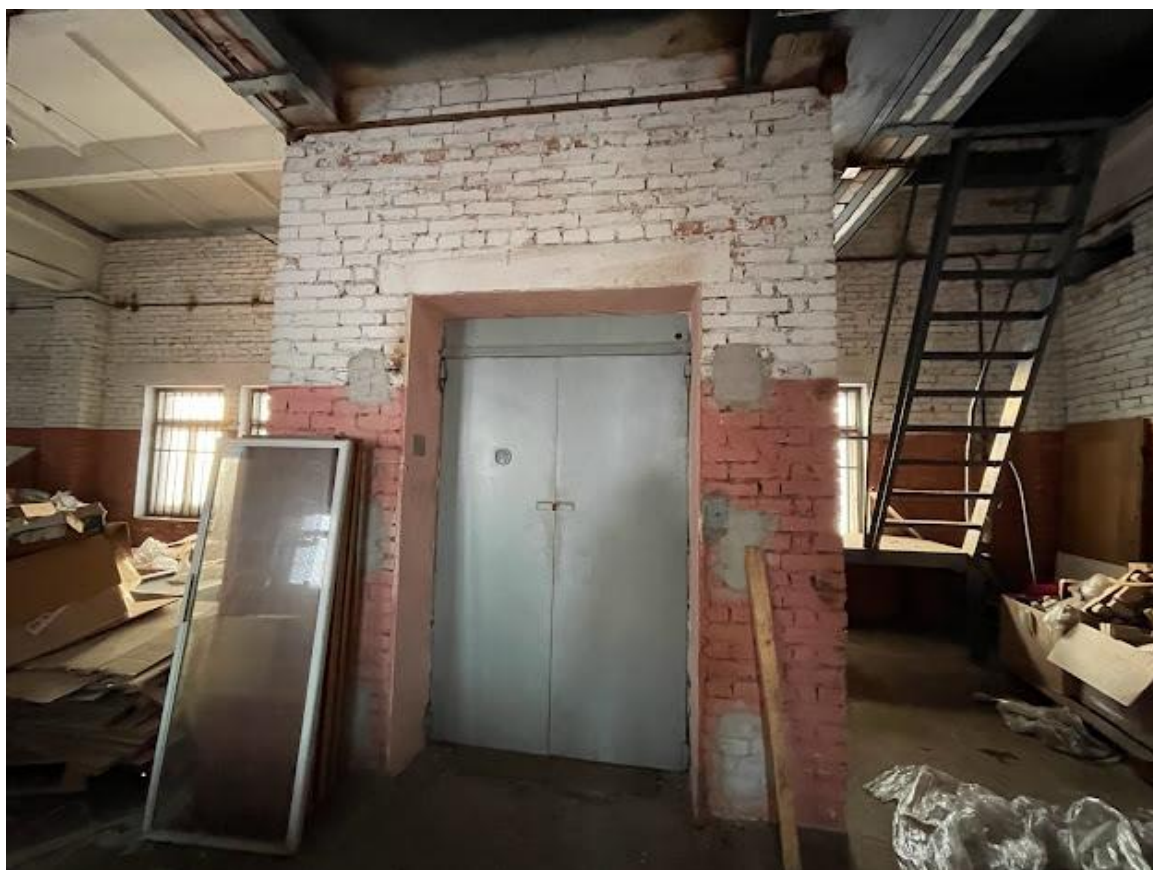
33. Фрагмент интерьера четвертого этажа
