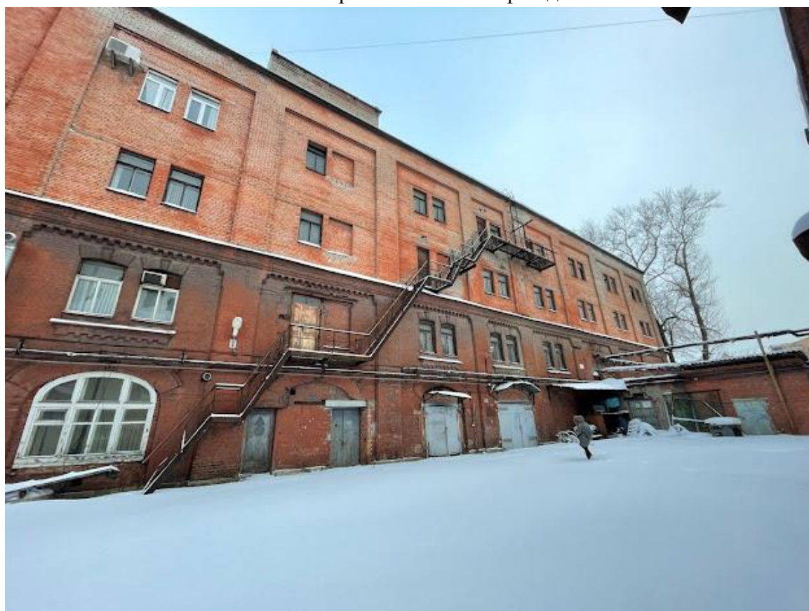
4. Фрагмент южного фасада
