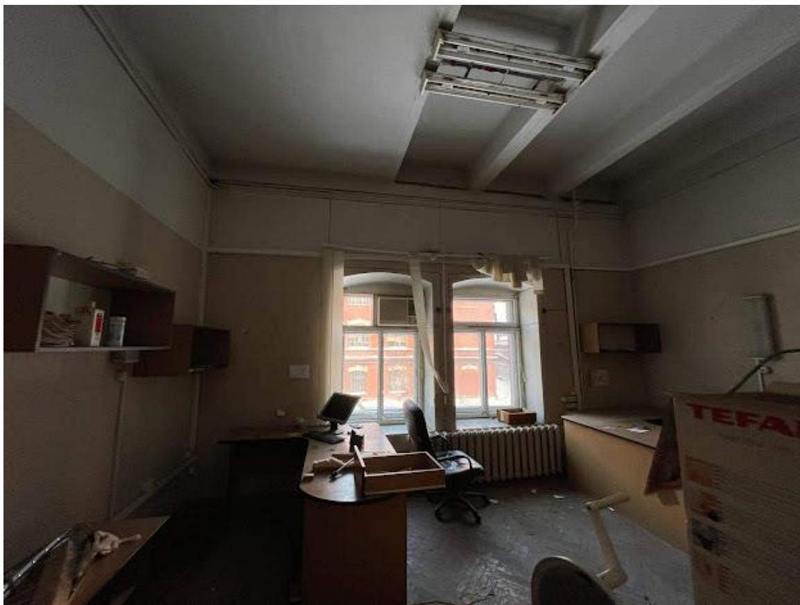
11. Фрагмент интерьера второго этажа
