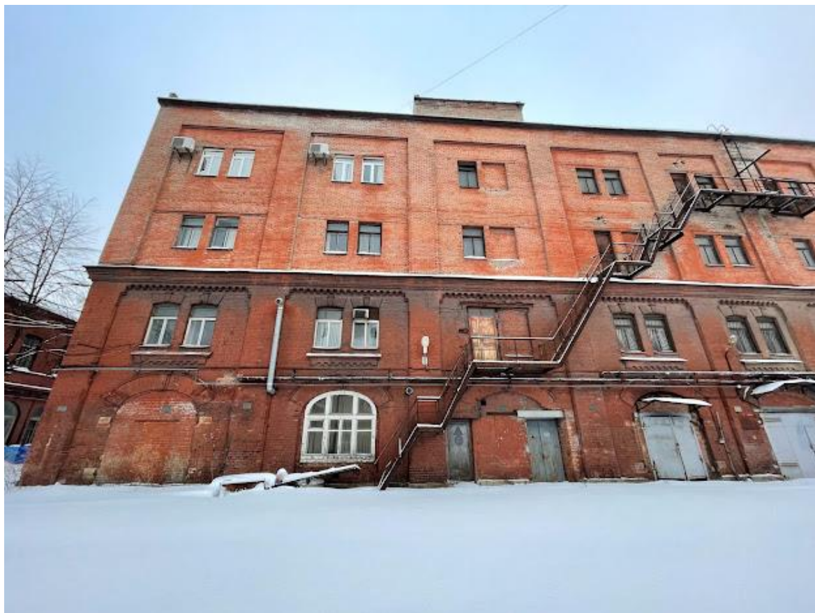
3. Фрагмент южного фасада
