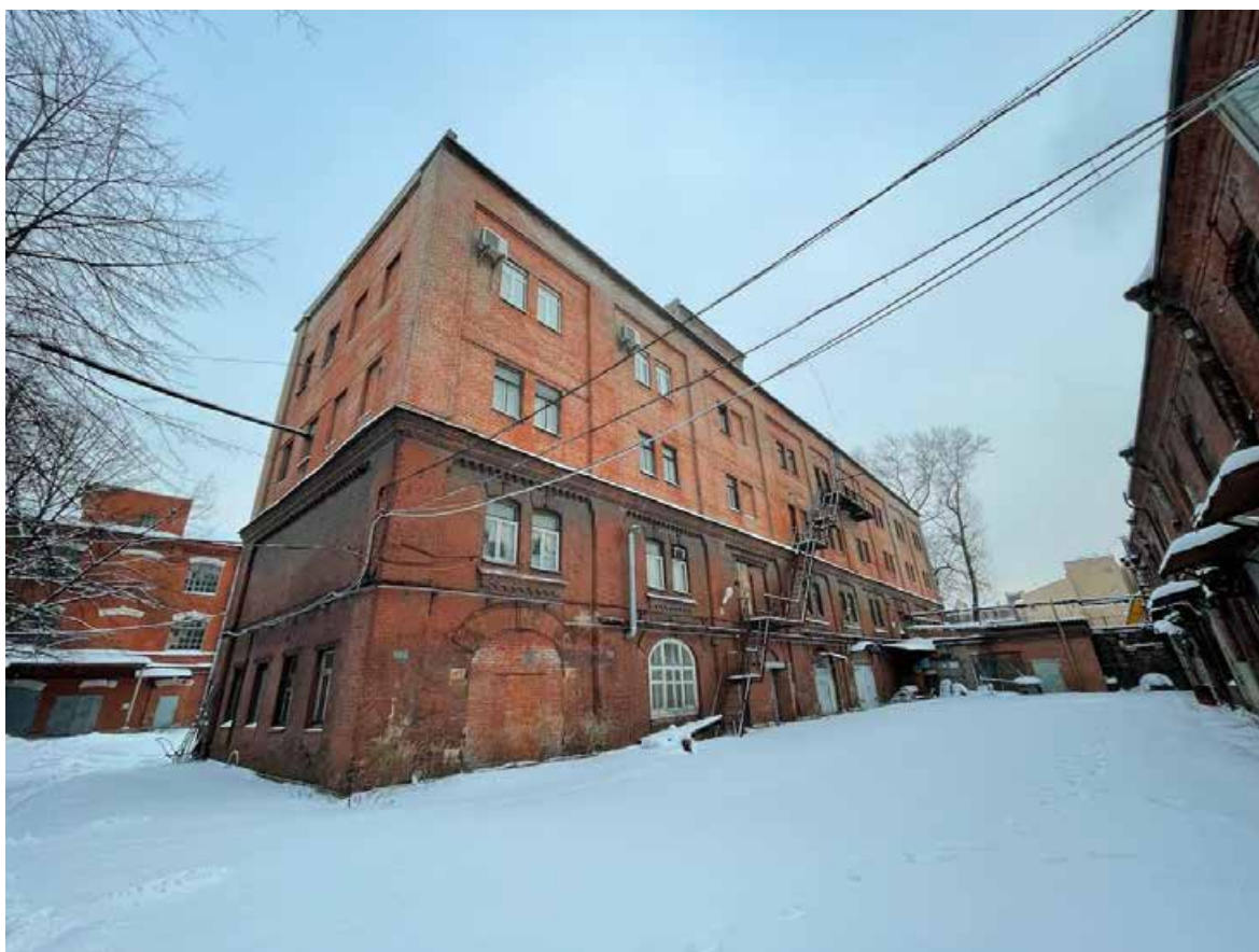
1. Общий вид с юго-запада
