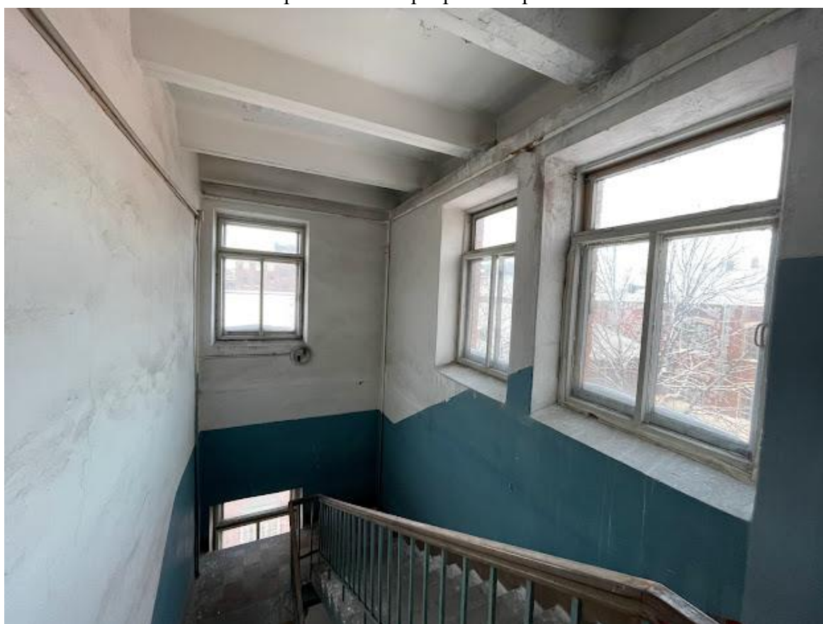
32. Лестница в уровне четвертого этажа
