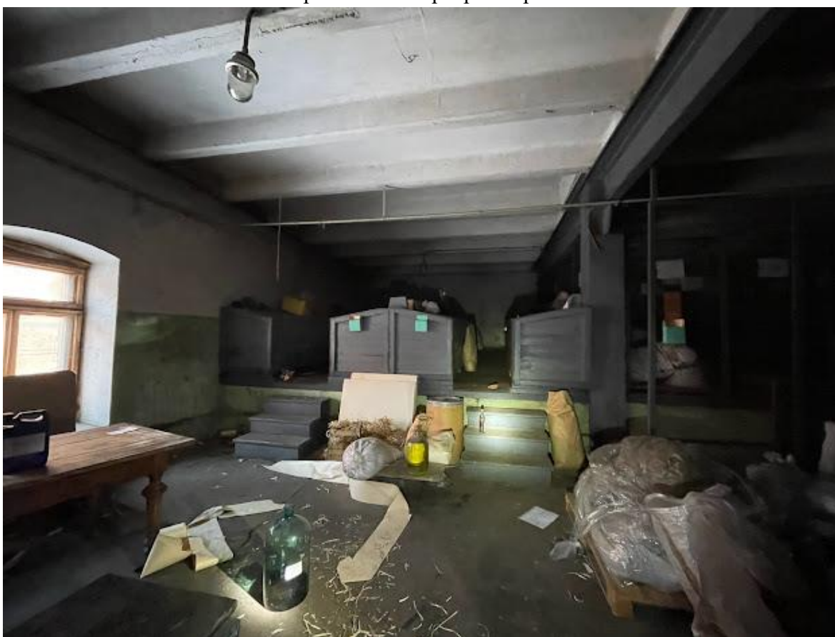
16. Фрагмент интерьера второго этажа
