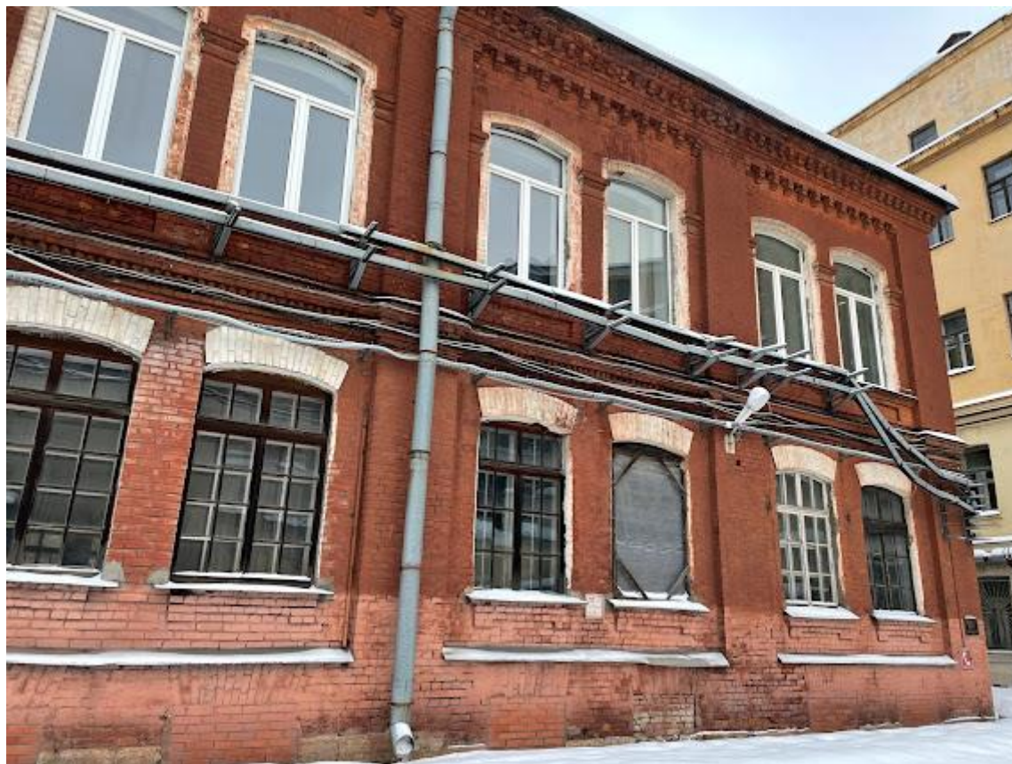
5. Фрагмент южного фасада
