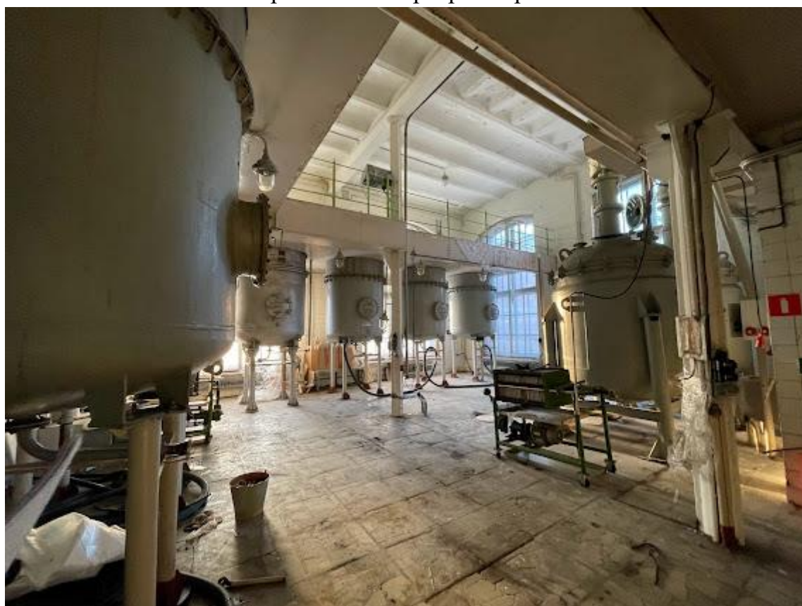
27. Фрагмент интерьера второго этажа
