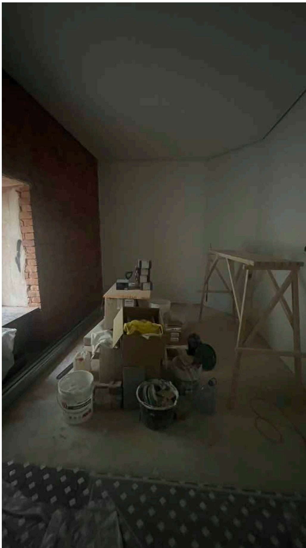
12. Фрагмент интерьера кухни (помещение 6/22.5);
