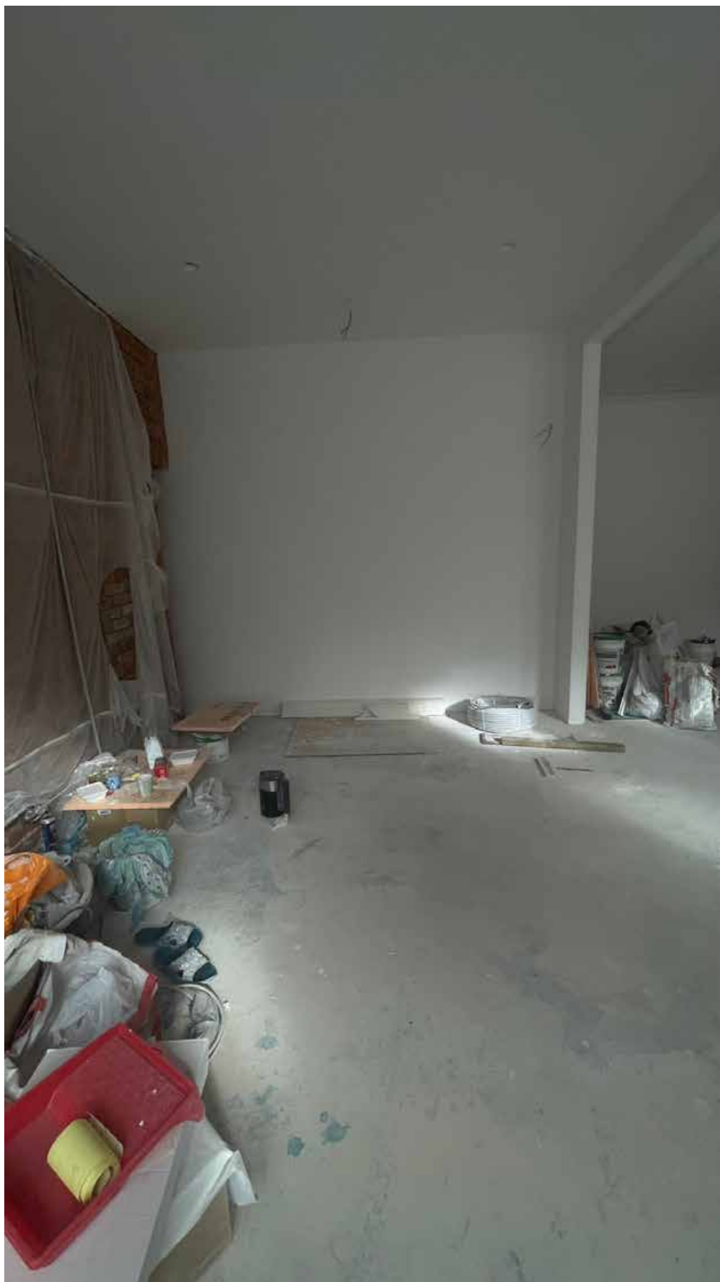
9. Фрагмент интерьера комнаты (помещение 4/22.2);
