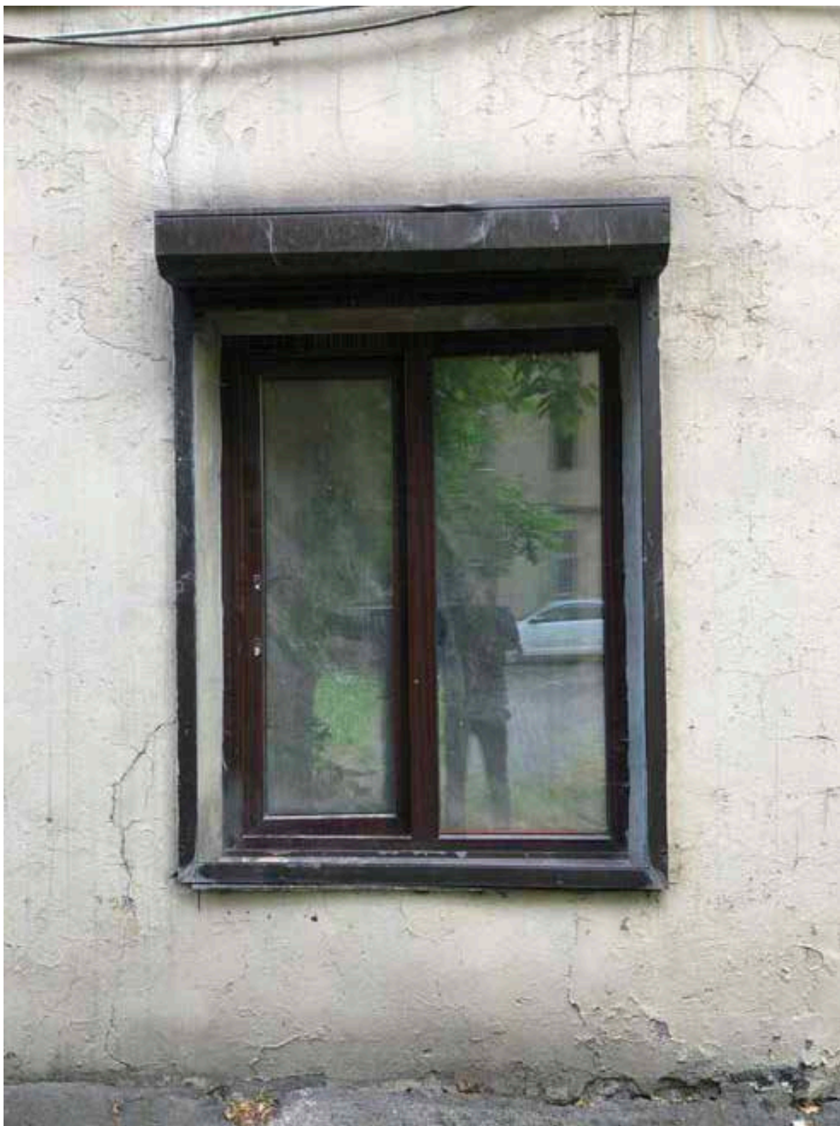
3. Вид на дворовой фасад здания и окна квартиры;
