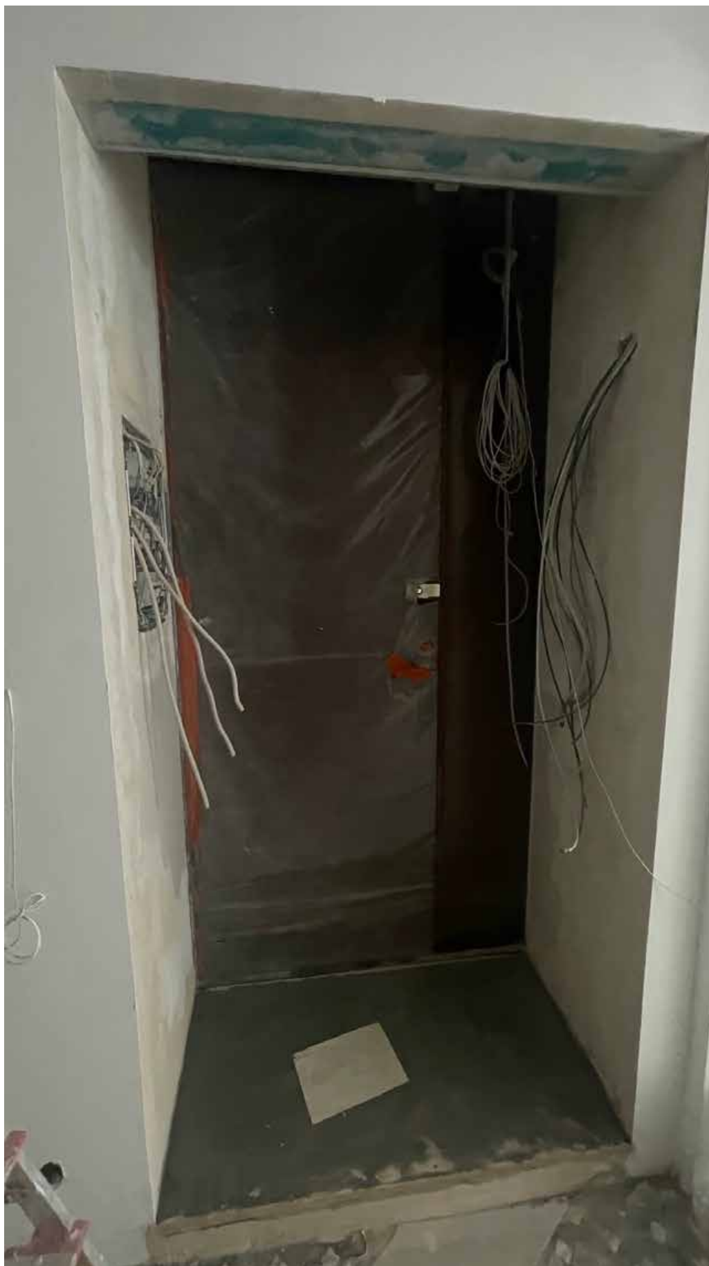
5. Вид на входную дверь в квартире;
