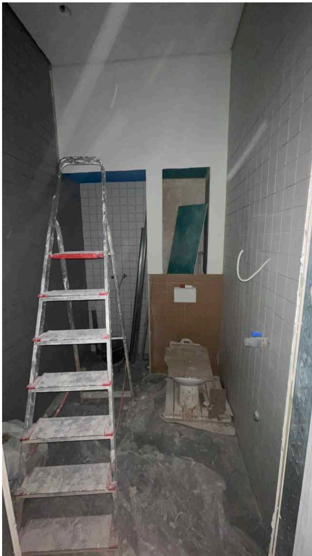
14.Фрагмент интерьера санузла;
