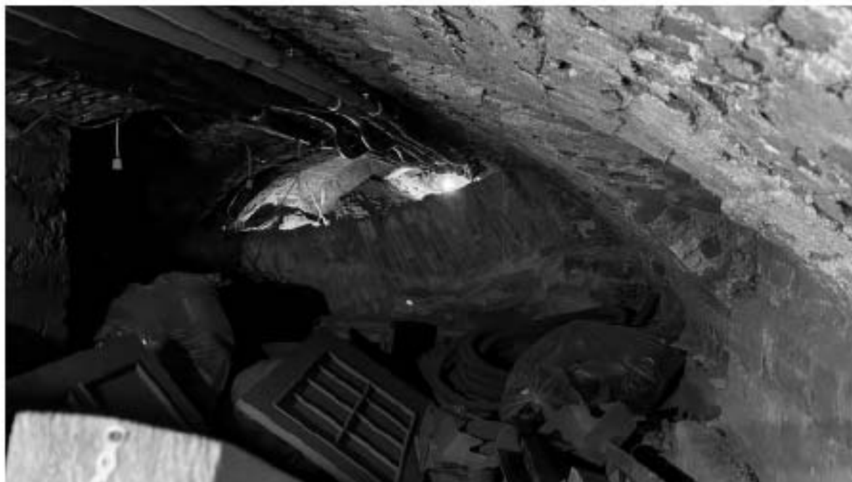
Фото 11. Подвал. Вид на разгрузочную арку в центральной части собора.
