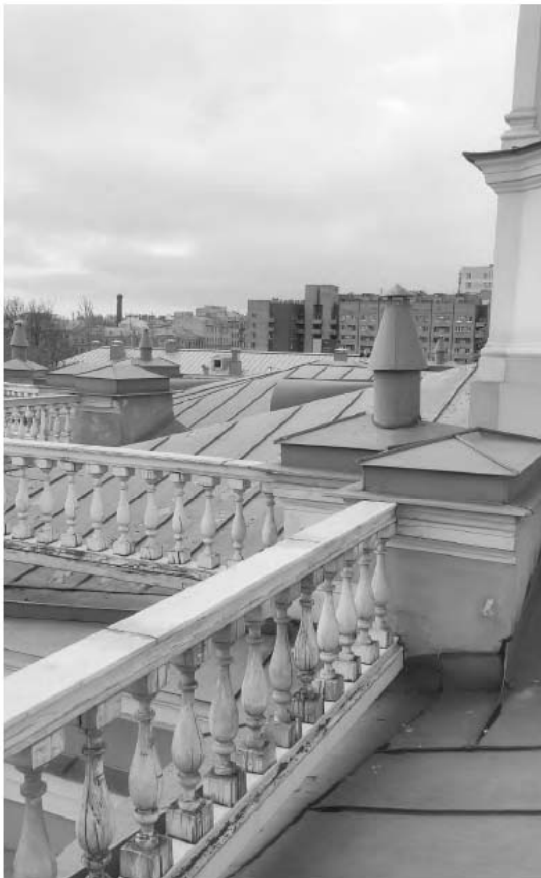
Фото 5. Вид с крыши собора.
