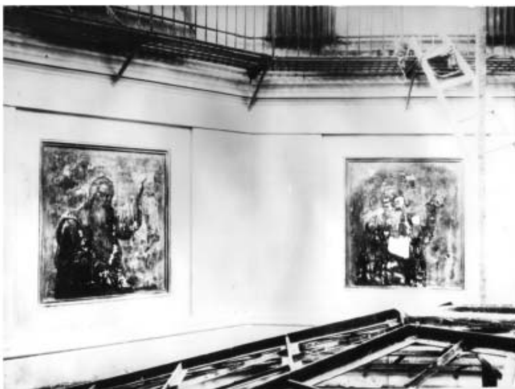
83. Пророки Исаия и Иезекииль. Роспись в барабане центрального купола, обнаруженная под набелом во время ремонта. 1950 г. (Материалы исторической справки, «Ленпроектреставрация», 1990 г.)
