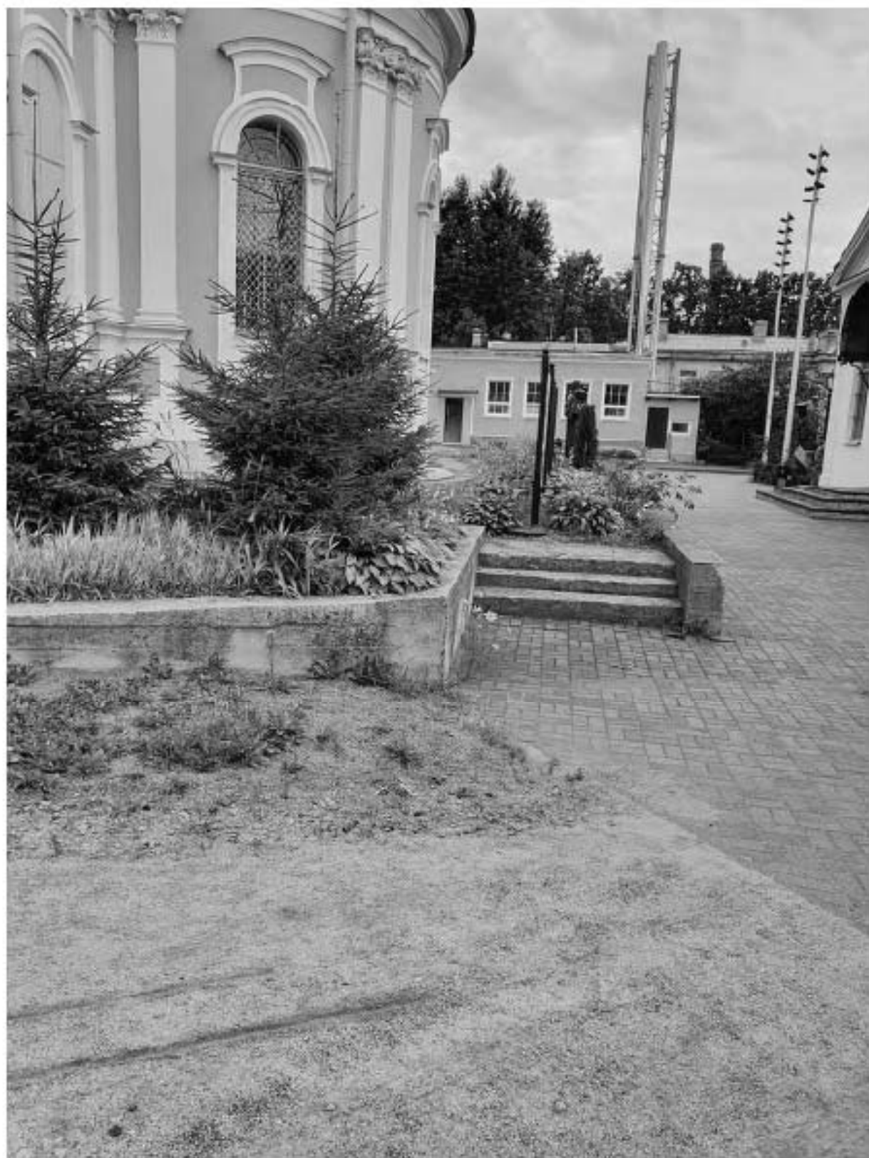
Фото 8. Фрагмент юго –восточного фасада.
