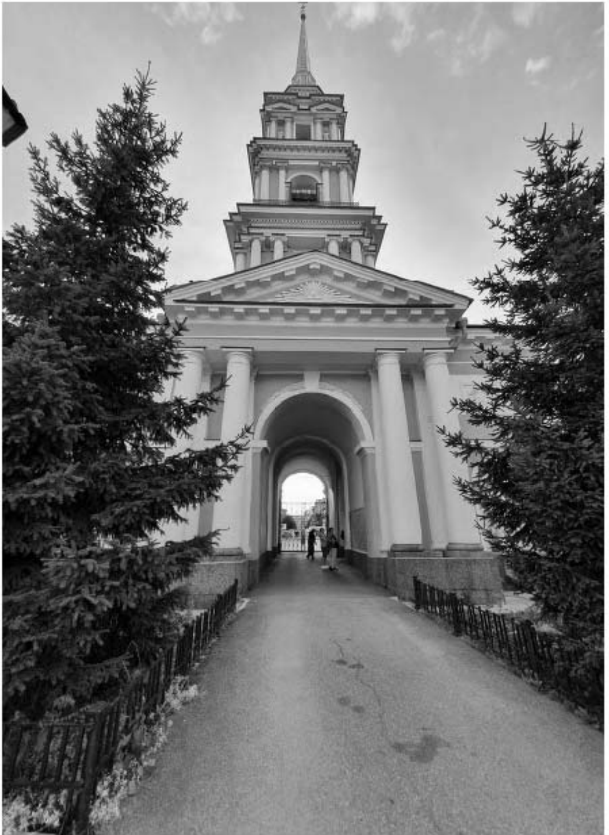
Фото 9. Вид на колокольню.
