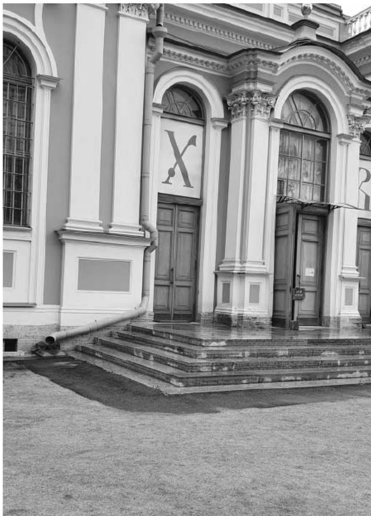
Фото 6. Фрагмент западного фасада.
