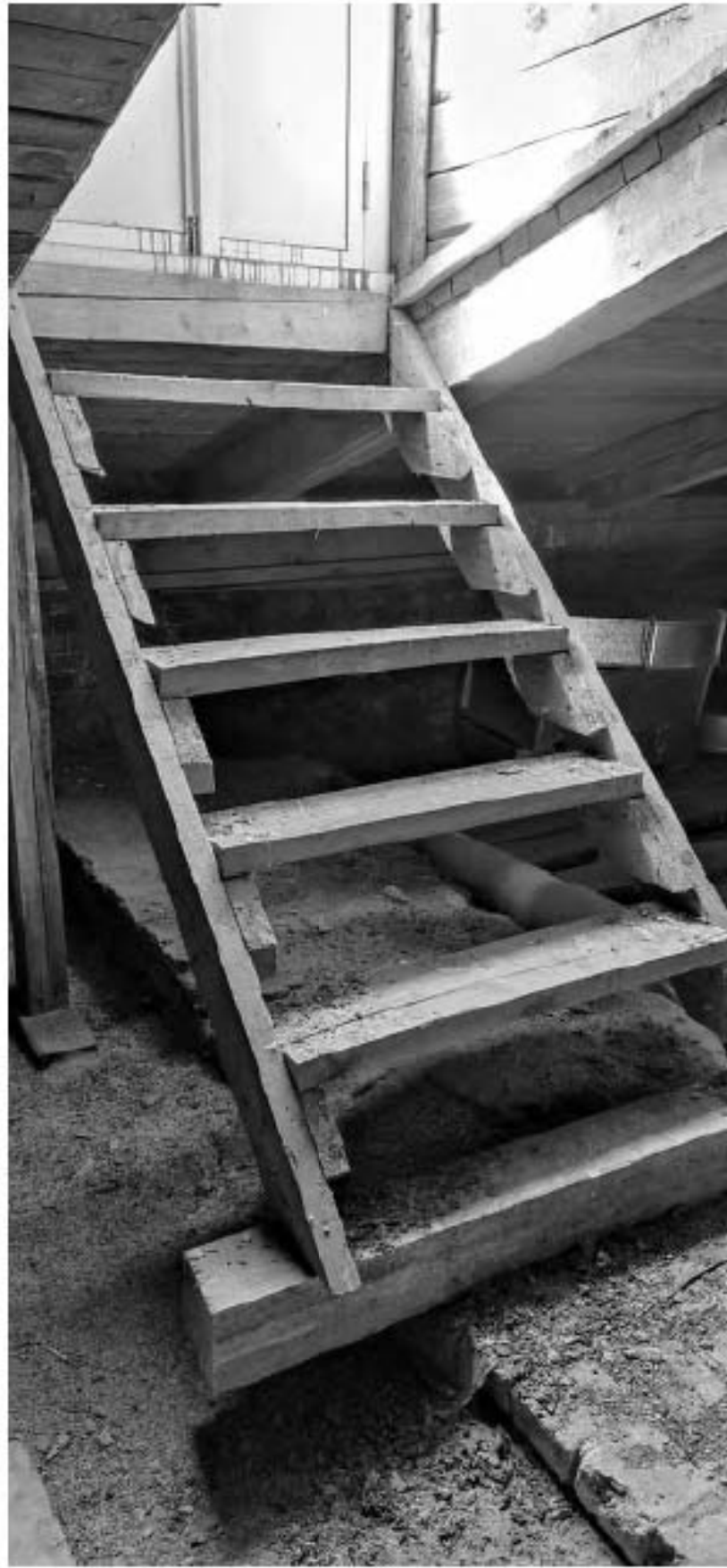
Фото 37. Выход на крышу.
