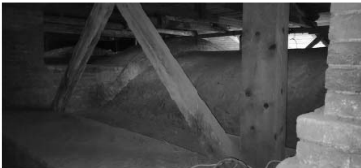
Фото 35. Подкровельное пространство. Вид на цилиндрический свод собора.
