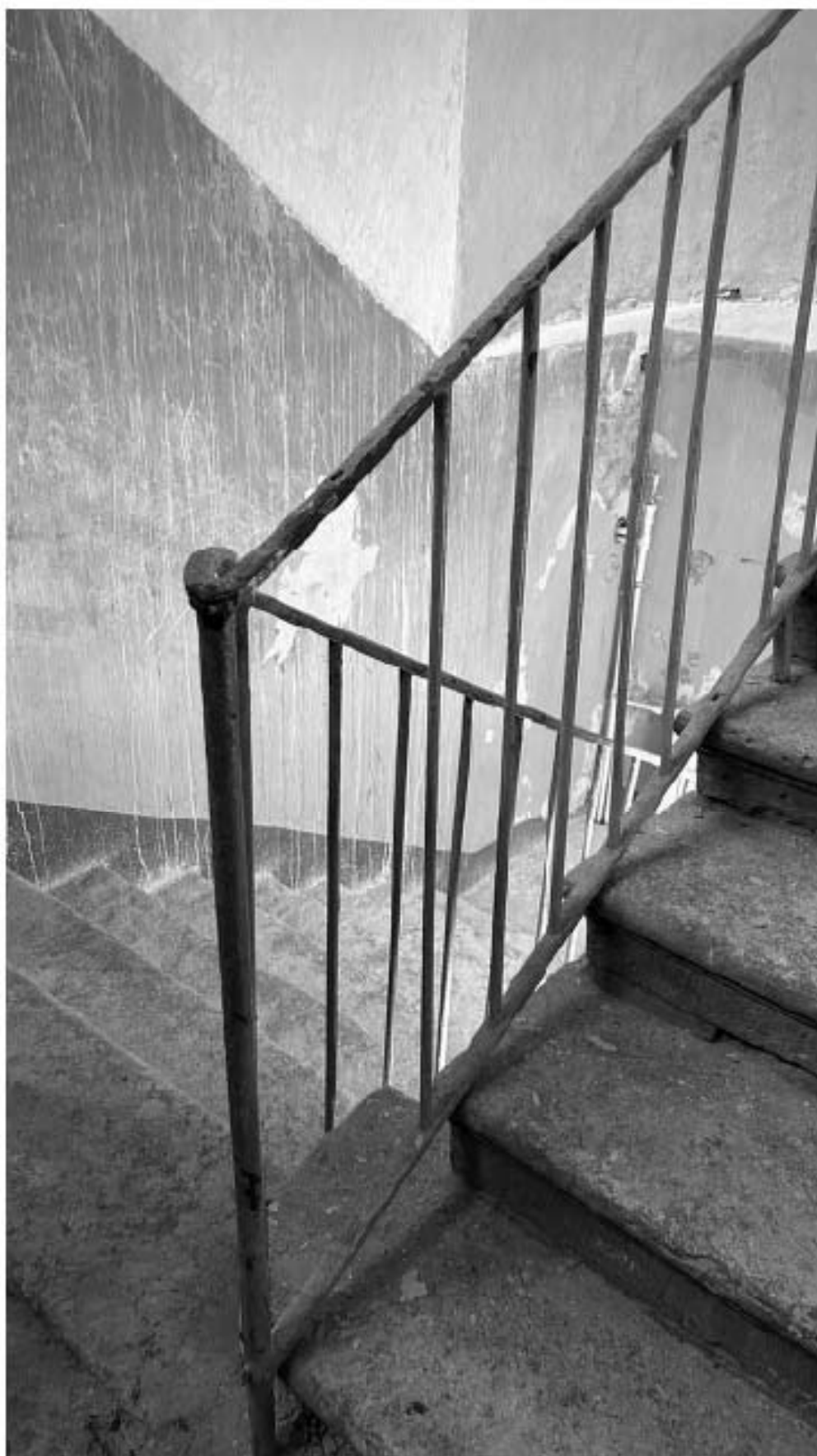
Фото 28. Лестница в западной части собора.
