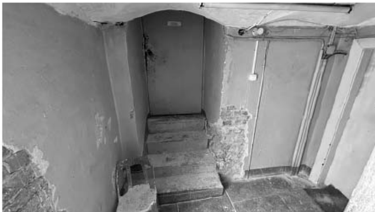
Фото 30. Вид на лестничную площадку.
