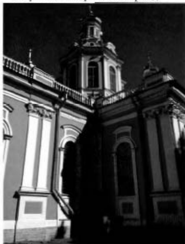
2. Фрагмент северной части фасада
