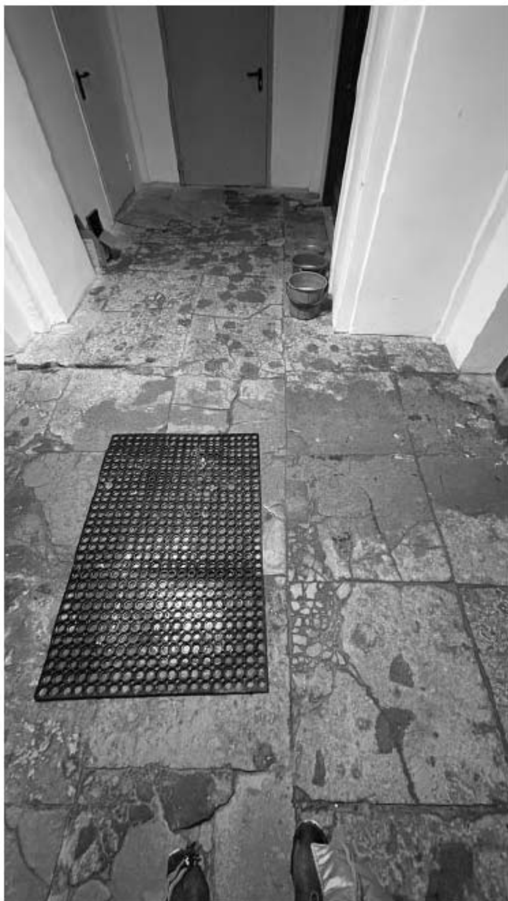
Фото 27. Напольное покрытие притвора собора.
