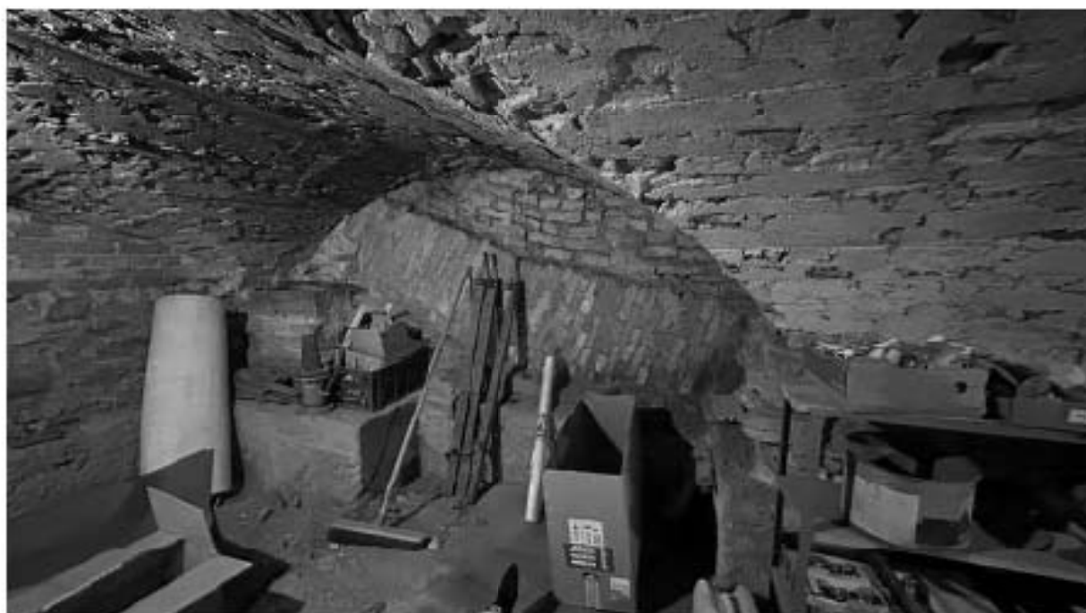
Фото 18. Подвал. Вид на разгрузочную арку в помещении мастерских.
