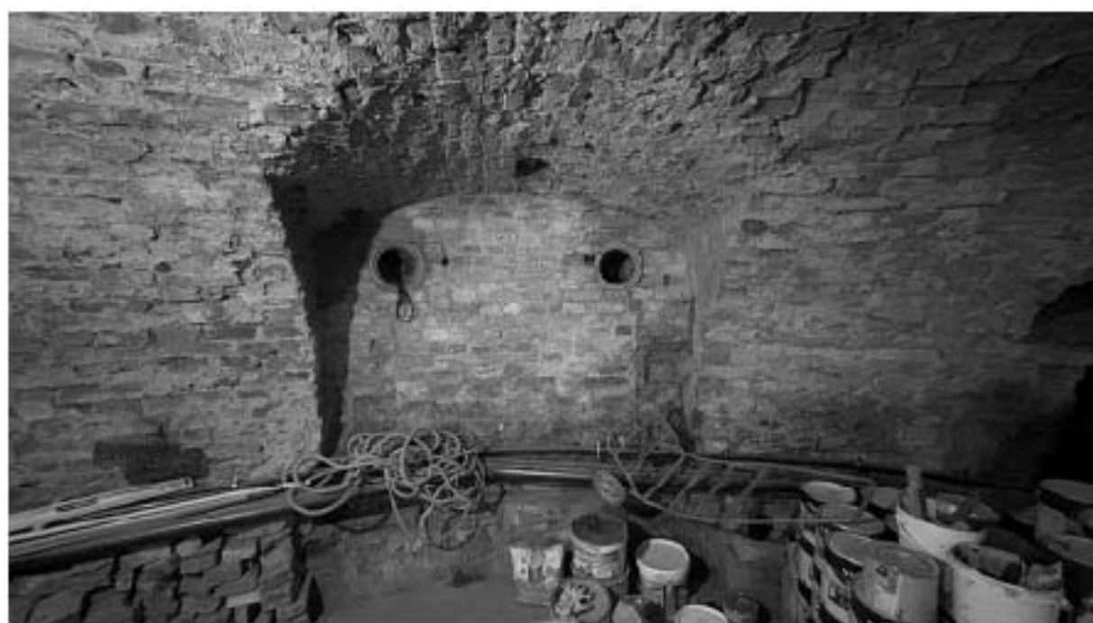
Фото 21. Подвал. Помещение под алтарной частью. Вид на керамические воздушные каналы.
