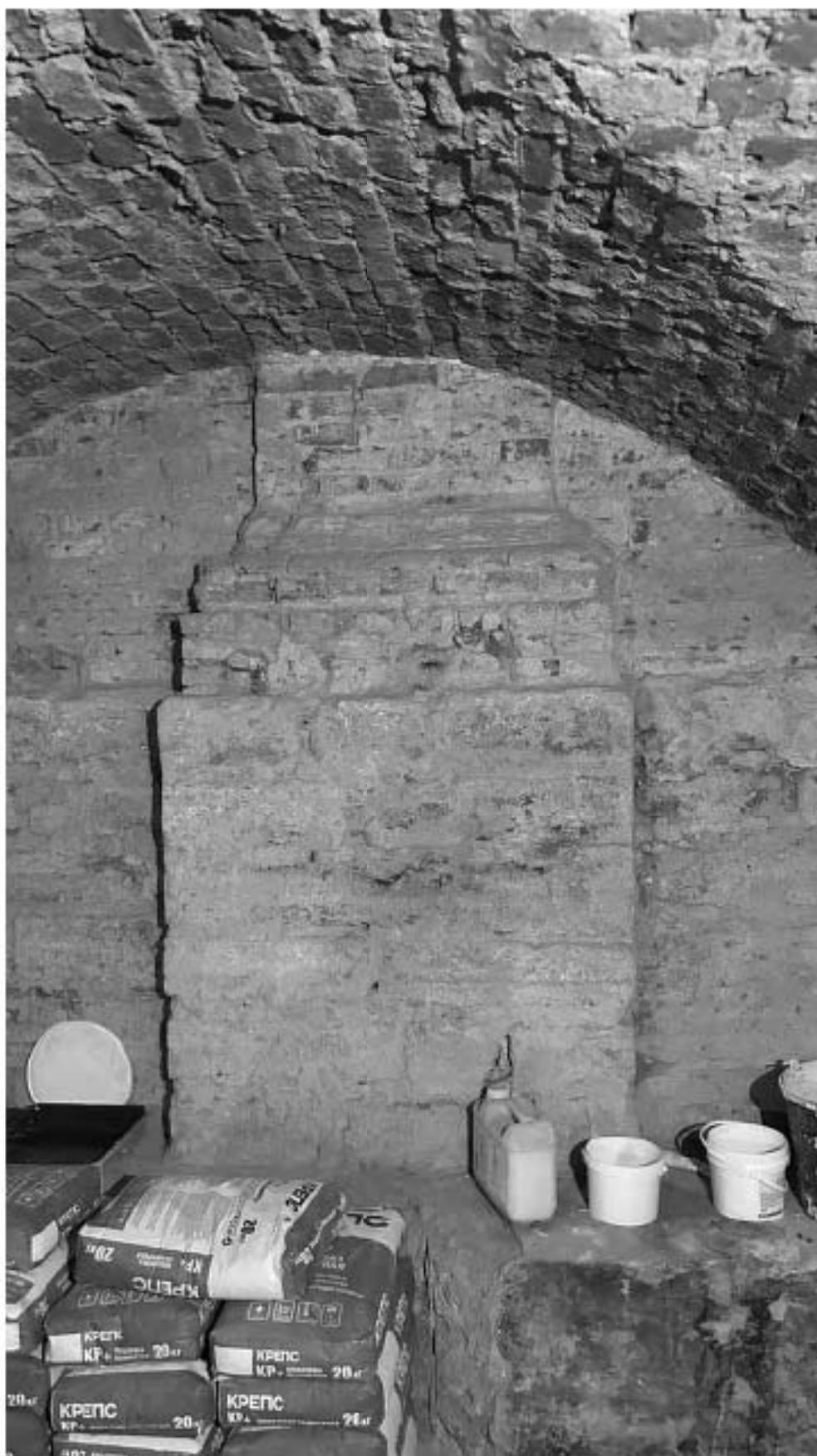
Фото 22. Подвал. Помещение под алтарной частью. Вид на пилястру XIIIв.
