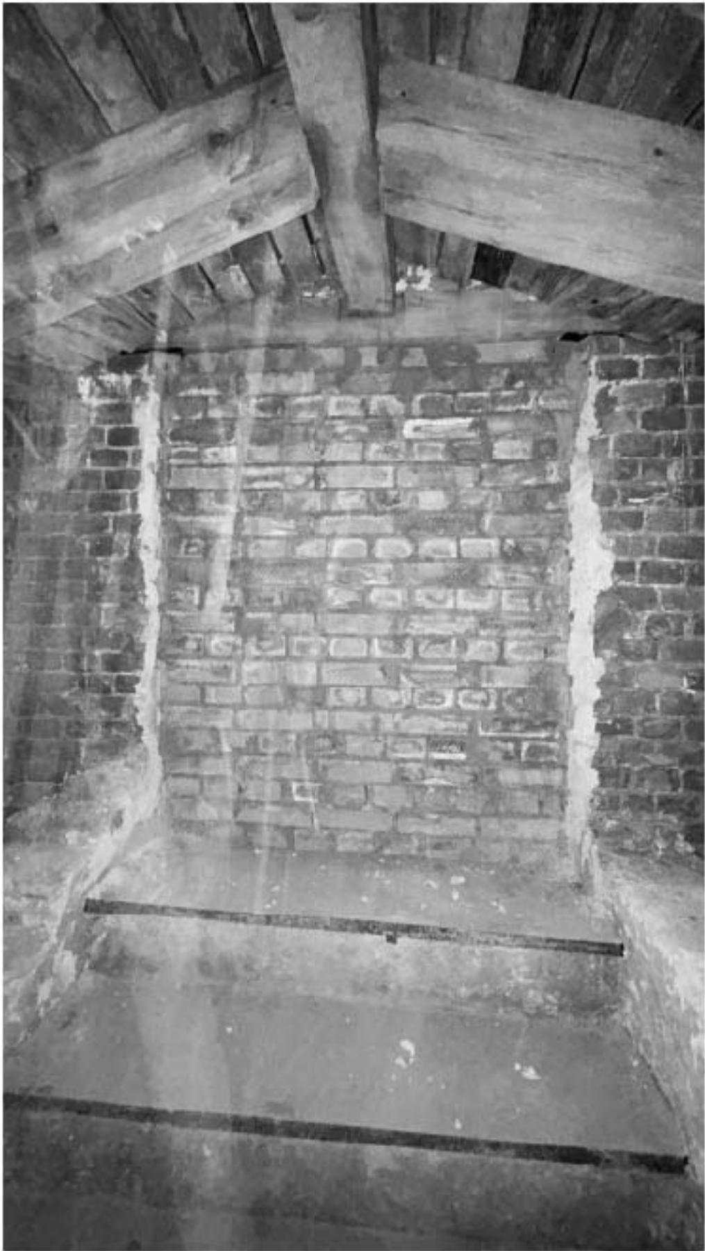
Фото 33. Подкровельное пространство. Фрагмент стропильной системы.
