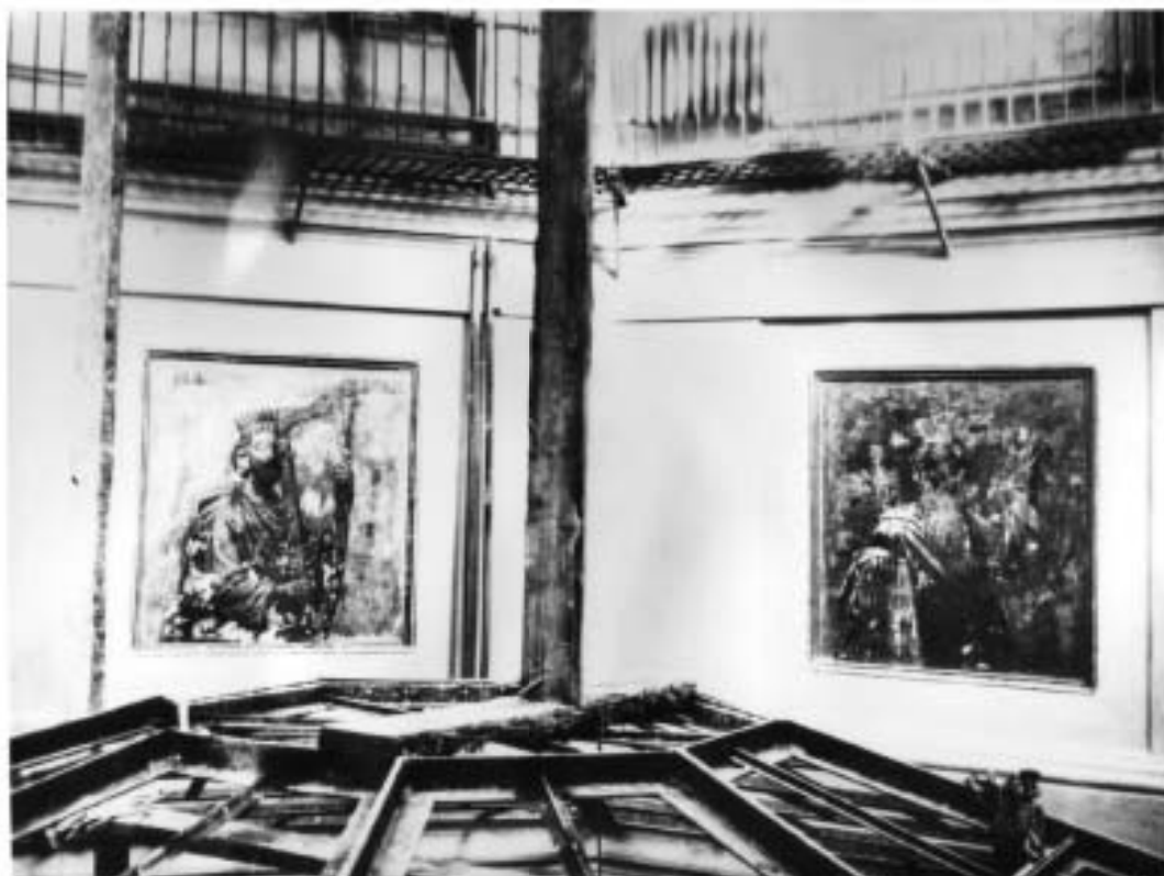
82. Пророки Давид и Моисей. Роспись в барабане центрального купола, обнаруженная под набелом во время ремонта. 1950 г. (Материалы исторической справки, «Ленпроектреставрация», 1990 г.)
