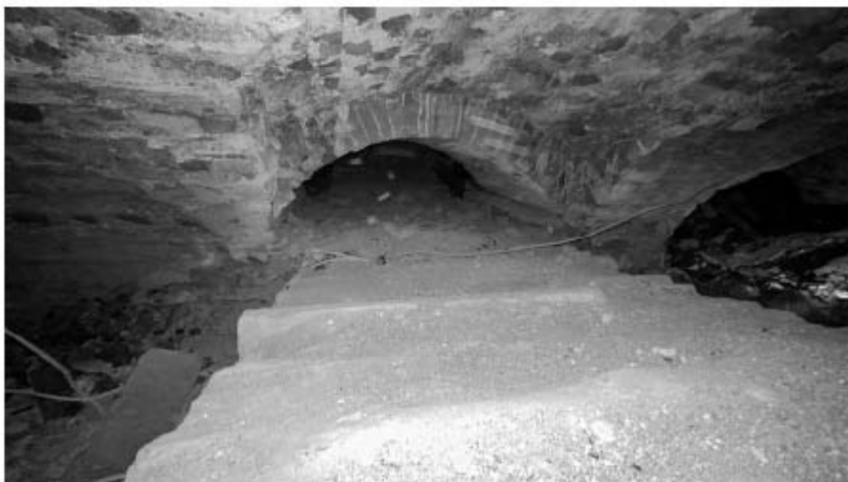
Фото 14. Подвал. Вид на разгрузочную арку в центральной части собора.
