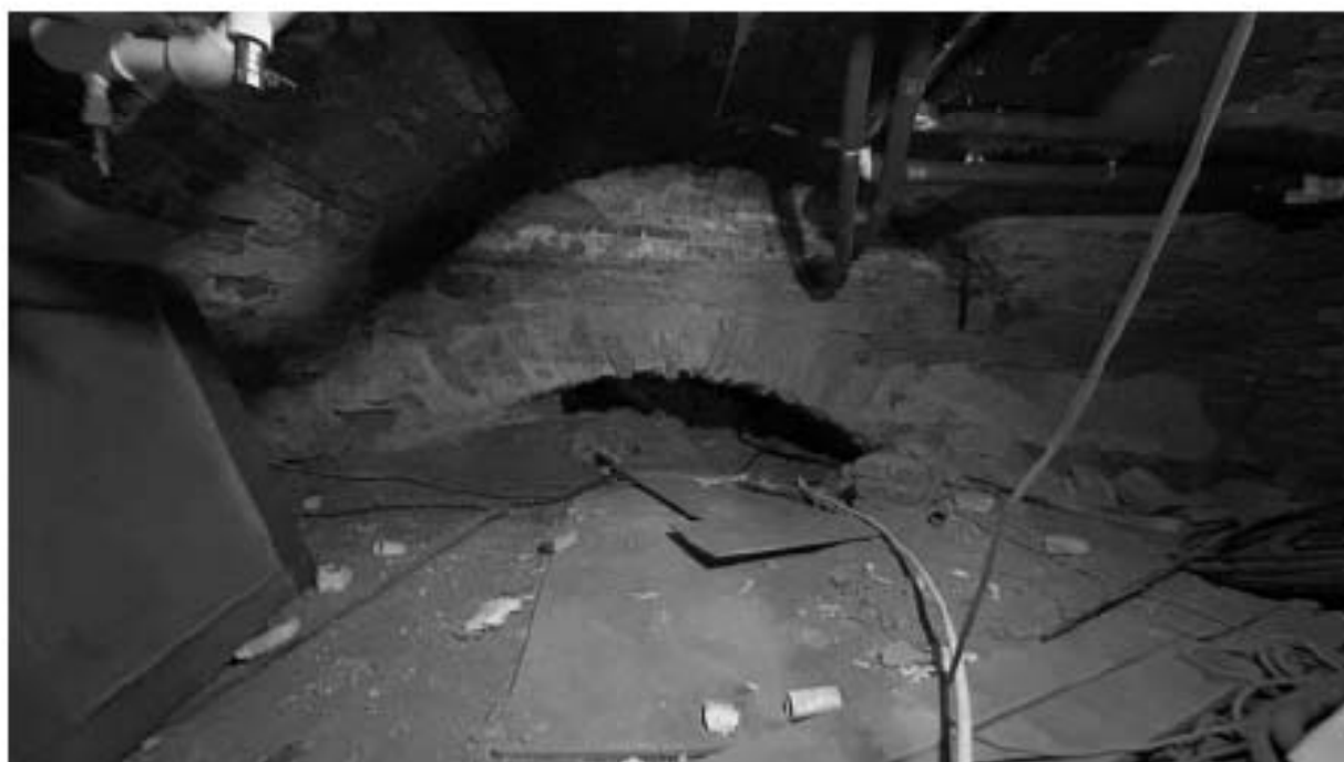
Фото 12. Подвал. Вид на цилиндрический свод центральной части собора.
