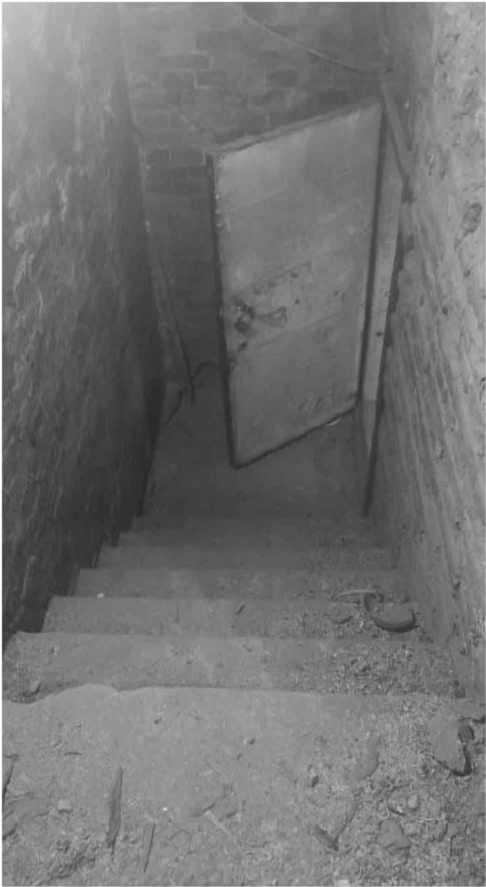
Фото 32. Лестница на чердак.
