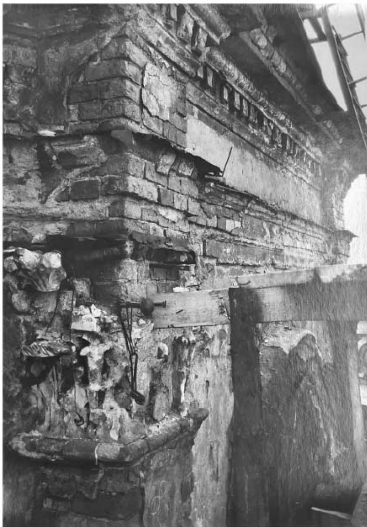
92. Предтеченская церковь. Деталь восьмигранник центральной главы Западная часть, до реставрации 1954 г. (ЦГАНДТ Р-488, Оп. 324, Д. 213, Л. 7. 1952-1967 г.)
