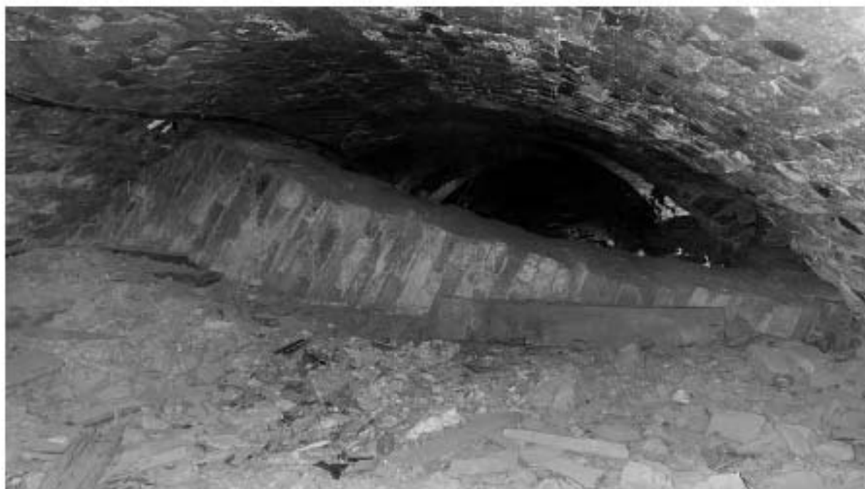
Фото 16. Подвал. Вид на разгрузочную арку в центральной части собора.
