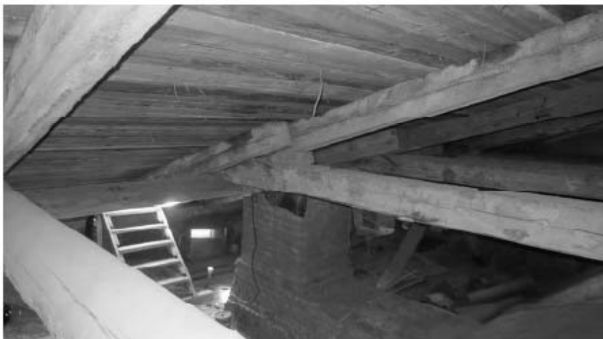
Фото 36. Подкровельное пространство. Фрагмент стропильной системы
