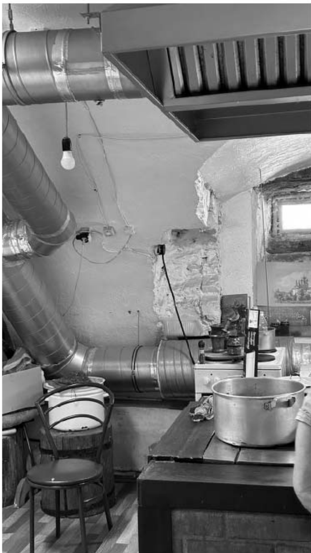
Фото 19. Подвальное помещение. Фрагмент кухни.
