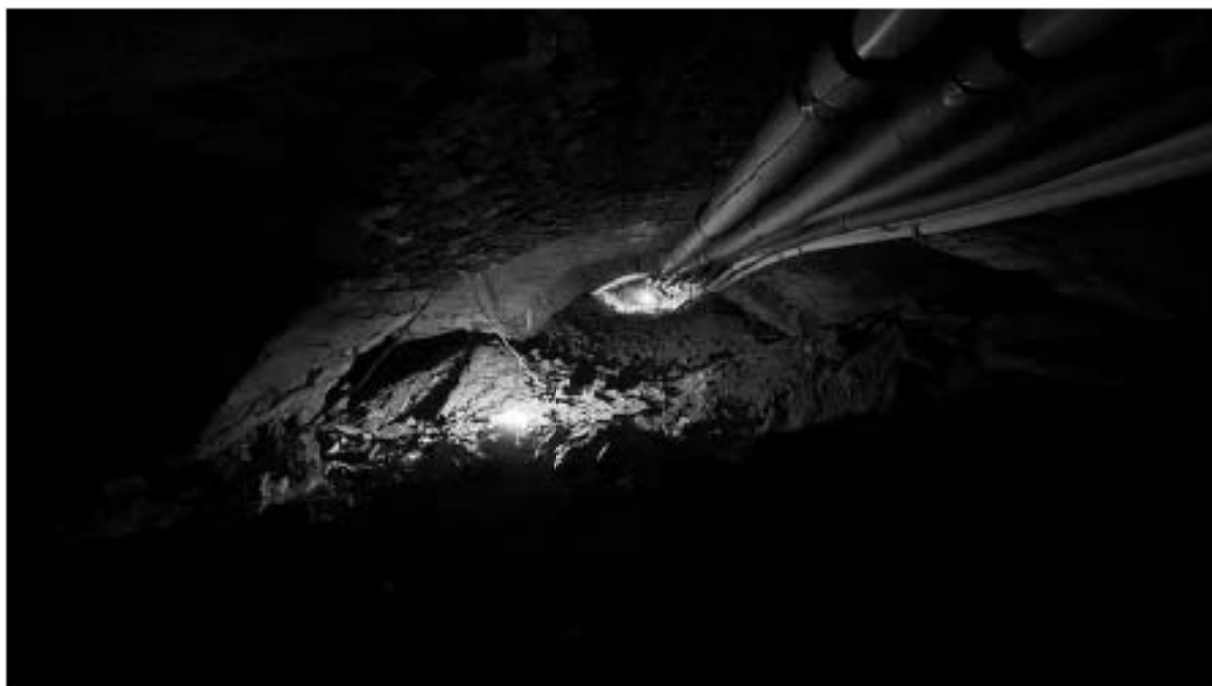
Фото13. Подвал. Вид на разгрузочную арку в центральной части собора.
