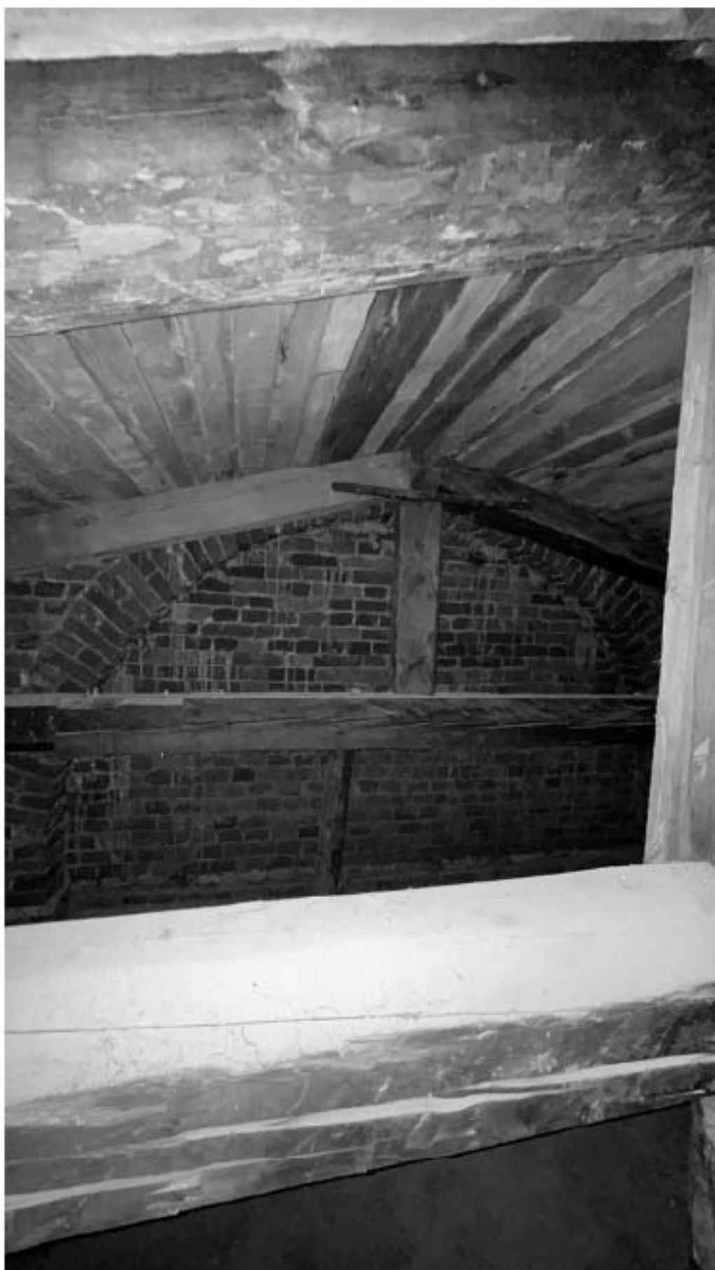
Фото 34. Подкровельное пространство. Фрагмент стропильной системы.
