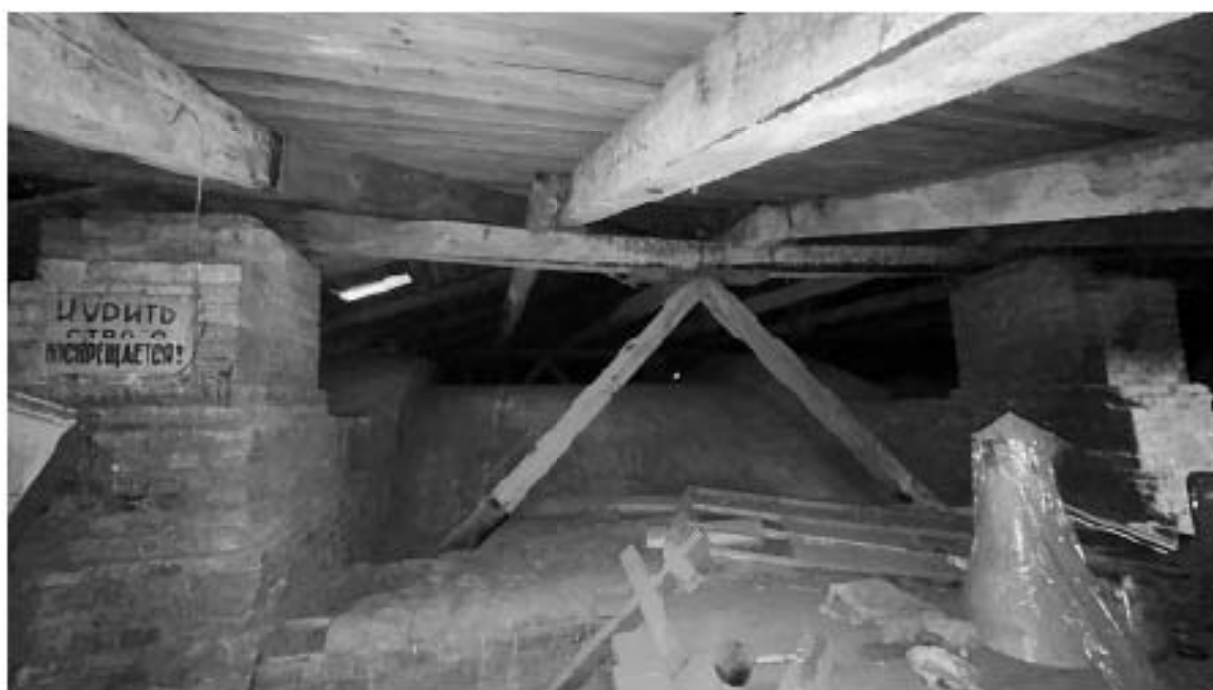
Фото 31. Подкровельное пространство. Фрагмент стропильной системы.
