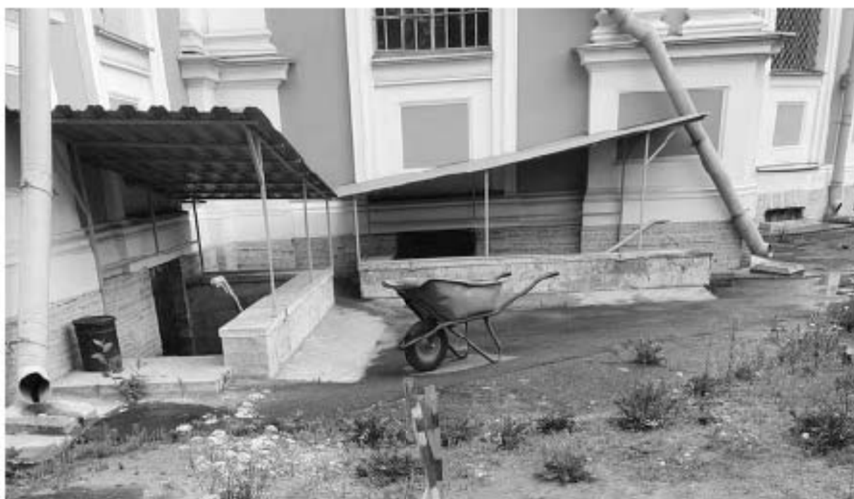
Фото 4. Приямки на юго- западном фасаде собора.
