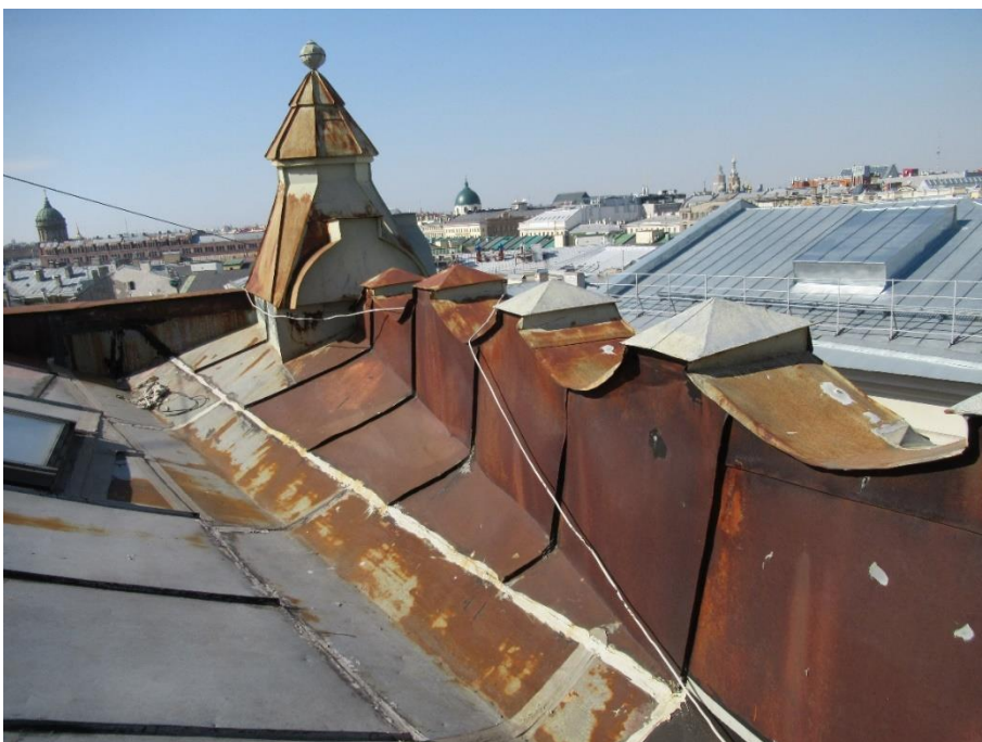
48. Объект культурного наследия регионального значения «Собственный дом архитектора Н.П. Басина», г. Санкт-Петербург, Крылова пер., 7/5, лит. А. Кровля. Фрагмент. Фото 28.08.2023г.
