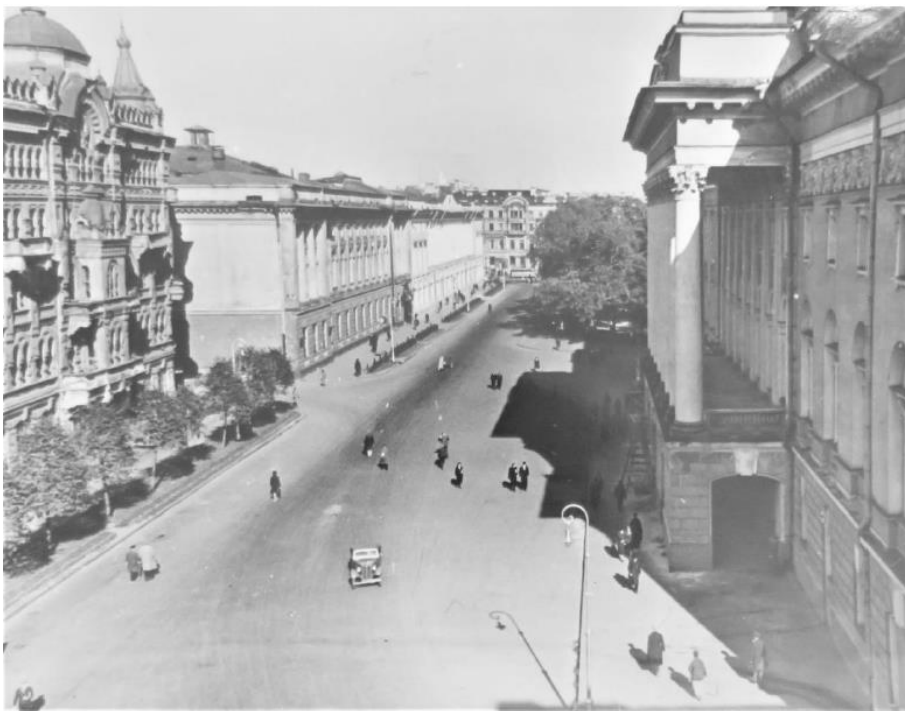
55. Вид северной части площади писателя Островского. Фотография. 28 сентября 1947 г. ЦГАКФФД СПб (инв. № Ар 113218).
