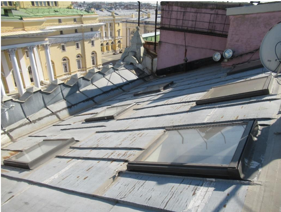
45. Объект культурного наследия регионального значения «Собственный дом архитектора Н.П. Басина», г. Санкт-Петербург, Крылова пер., 7/5, лит. А. Кровля. Фрагмент. Фото 28.08.2023г.
