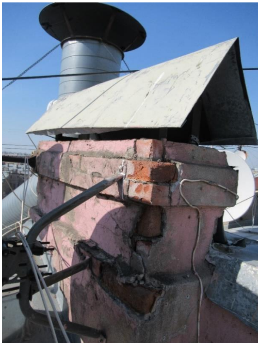
46. Объект культурного наследия регионального значения «Собственный дом архитектора Н.П. Басина», г. Санкт-Петербург, Крылова пер., 7/5, лит. А. Кровля. Фрагмент. Фото 28.08.2023г.
