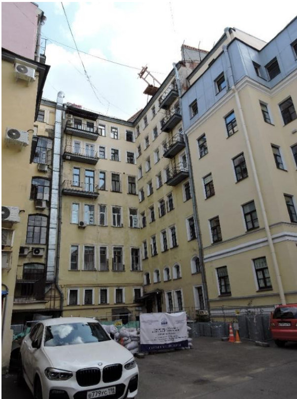
3. Объект культурного наследия регионального значения «Собственный дом архитектора Н.П. Басина», г. Санкт-Петербург, Крылова пер., 7/5, лит. А. Дворовый фасад. Общий вид. Фото 28.08.2023г.
