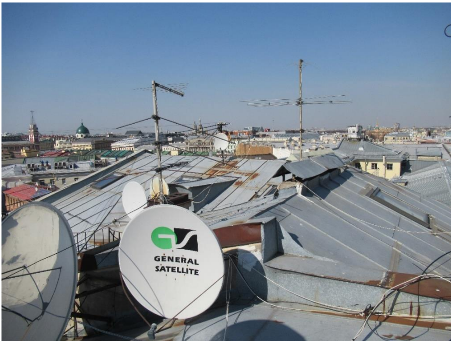
42. Объект культурного наследия регионального значения «Собственный дом архитектора Н.П. Басина», г. Санкт-Петербург, Крылова пер., 7/5, лит. А. Кровля. Общий вид. Фото 28.08.2023г.
