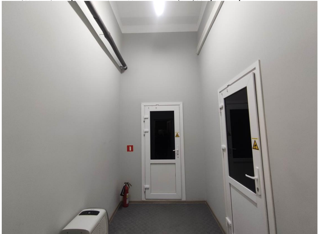
22. Объект культурного наследия регионального значения «Здание Физико-химического института Высших женских (Бестужевских) курсов», расположенный по адресу: г. Санкт-Петербург, Средний проспект В.О., дом 41, литера А. Фрагмент пом. № 1-Н(203) дворового флигеля.
