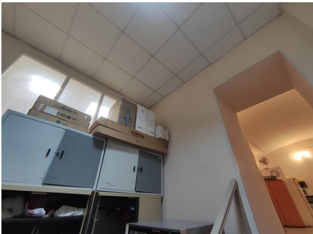
101. Объект культурного наследия регионального значения «Здание Физико-химического института Высших женских (Бестужевских) курсов», расположенный по адресу: г. Санкт-Петербург, Средний проспект В.О., дом 41, литера А. Общий вид пом. № 1-Н(166) флигеля, расположенного вдоль Среднего проспекта В.О.
