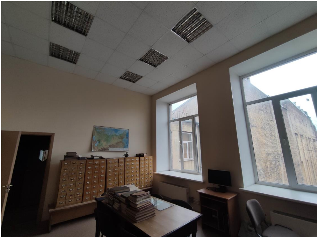
79. Объект культурного наследия регионального значения «Здание Физико-химического института Высших женских (Бестужевских) курсов», расположенный по адресу: г. Санкт-Петербург, Средний проспект В.О., дом 41, литера А. Общий вид пом. № 1-Н(338) дворового флигеля.
