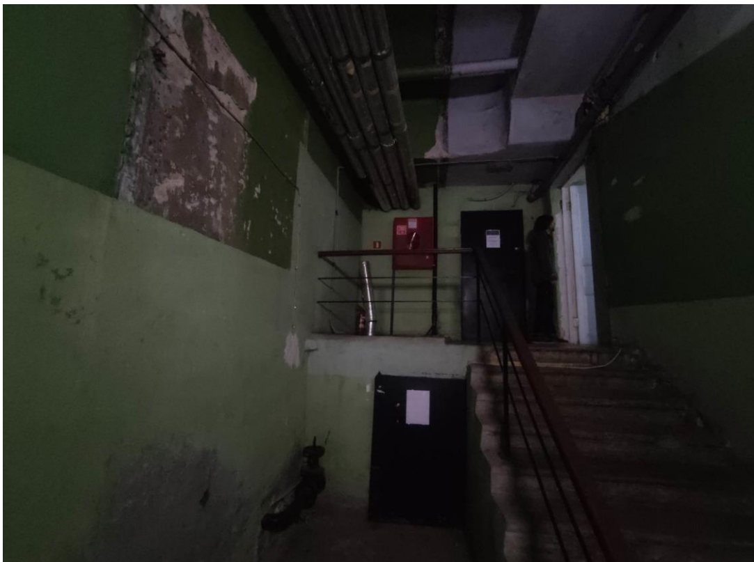
29. Объект культурного наследия регионального значения «Здание Физико-химического института Высших женских (Бестужевских) курсов», расположенный по адресу: г. Санкт-Петербург, Средний проспект В.О., дом 41, литера А. Фрагмент пом. № 1-Н(55) главного корпуса.
