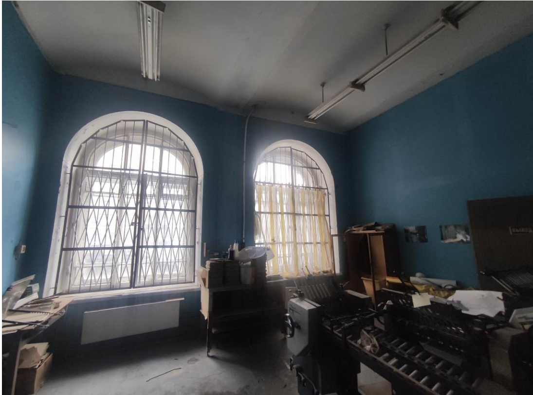
109. Объект культурного наследия регионального значения «Здание Физико-химического института Высших женских (Бестужевских) курсов», расположенный по адресу: г. Санкт-Петербург, Средний проспект В.О., дом 41, литера А. Общий вид пом. № 1-Н(85) флигеля, расположенного вдоль Среднего проспекта В.О.
