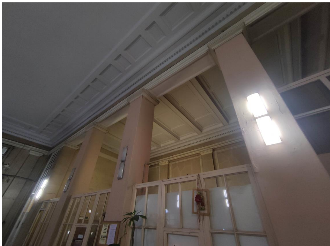
17. Объект культурного наследия регионального значения «Здание Физико-химического института Высших женских (Бестужевских) курсов», расположенный по адресу: г. Санкт-Петербург, Средний проспект В.О., дом 41, литера А. Общий вид пом. № 1-Н(104) главного корпуса, парадный вестибюль.
