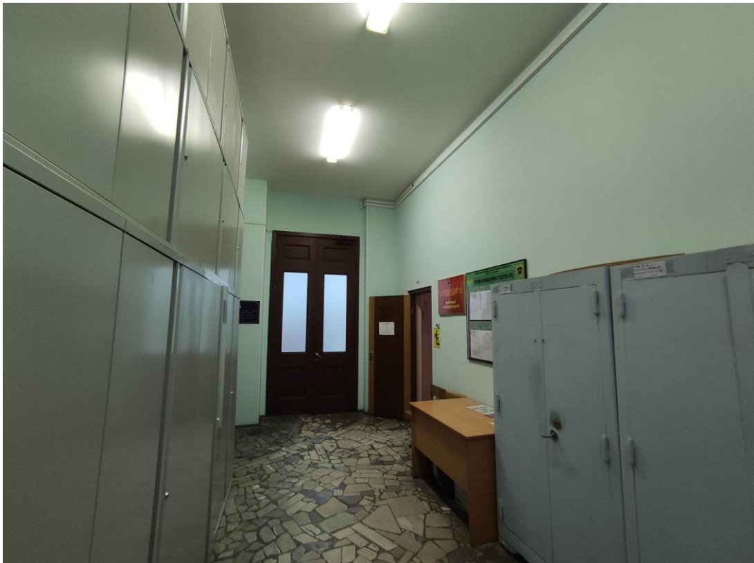
89. Объект культурного наследия регионального значения «Здание Физико-химического института Высших женских (Бестужевских) курсов», расположенный по адресу: г. Санкт-Петербург, Средний проспект В.О., дом 41, литера А. Общий вид пом. № 1-Н(378) дворового флигеля.
