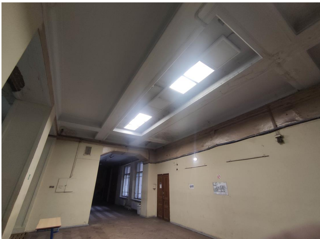
51. Объект культурного наследия регионального значения «Здание Физико-химического института Высших женских (Бестужевских) курсов», расположенный по адресу: г. Санкт-Петербург, Средний проспект В.О., дом 41, литера А. Общий вид пом. № 1-Н(321) главного корпуса.
