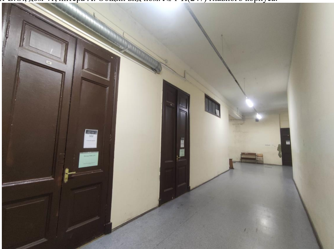
32. Объект культурного наследия регионального значения «Здание Физико-химического института Высших женских (Бестужевских) курсов», расположенный по адресу: г. Санкт-Петербург, Средний проспект В.О., дом 41, литера А. Общий вид пом. № 1-Н(243) главного корпуса.
