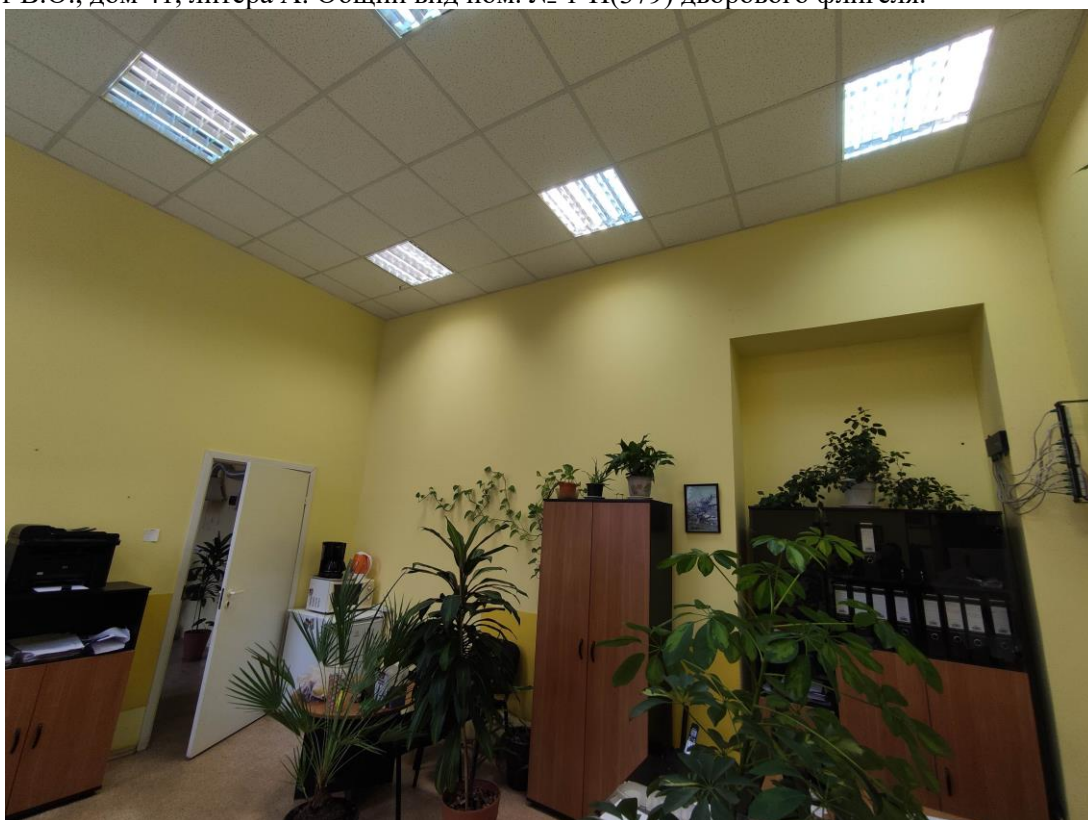
92. Объект культурного наследия регионального значения «Здание Физико-химического института Высших женских (Бестужевских) курсов», расположенный по адресу: г. Санкт-Петербург, Средний проспект В.О., дом 41, литера А. Общий вид пом. № 1-Н(381) дворового флигеля.
