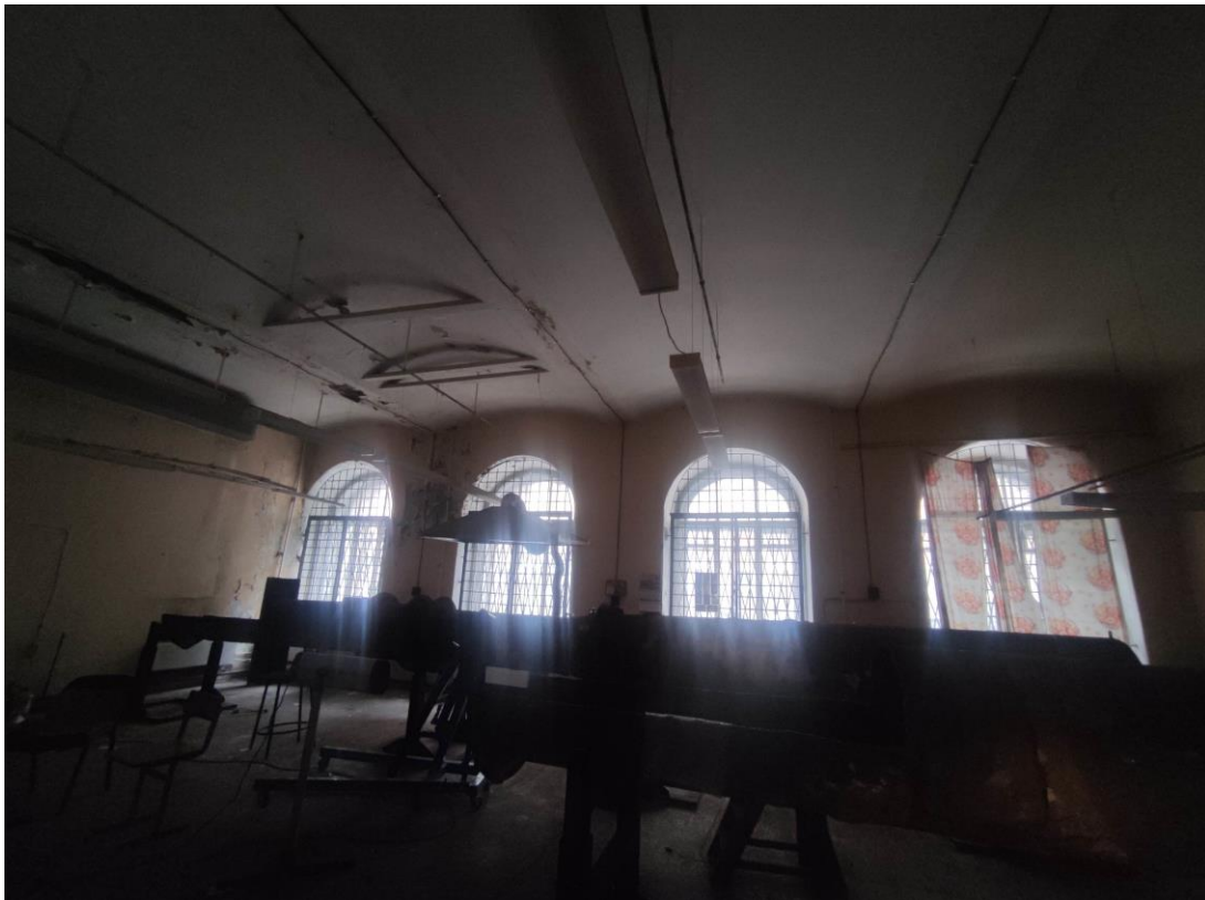
111. Объект культурного наследия регионального значения «Здание Физико-химического института Высших женских (Бестужевских) курсов», расположенный по адресу: г. Санкт-Петербург, Средний проспект В.О., дом 41, литера А. Общий вид пом. № 1-Н(80) флигеля, расположенного вдоль Среднего проспекта В.О.
