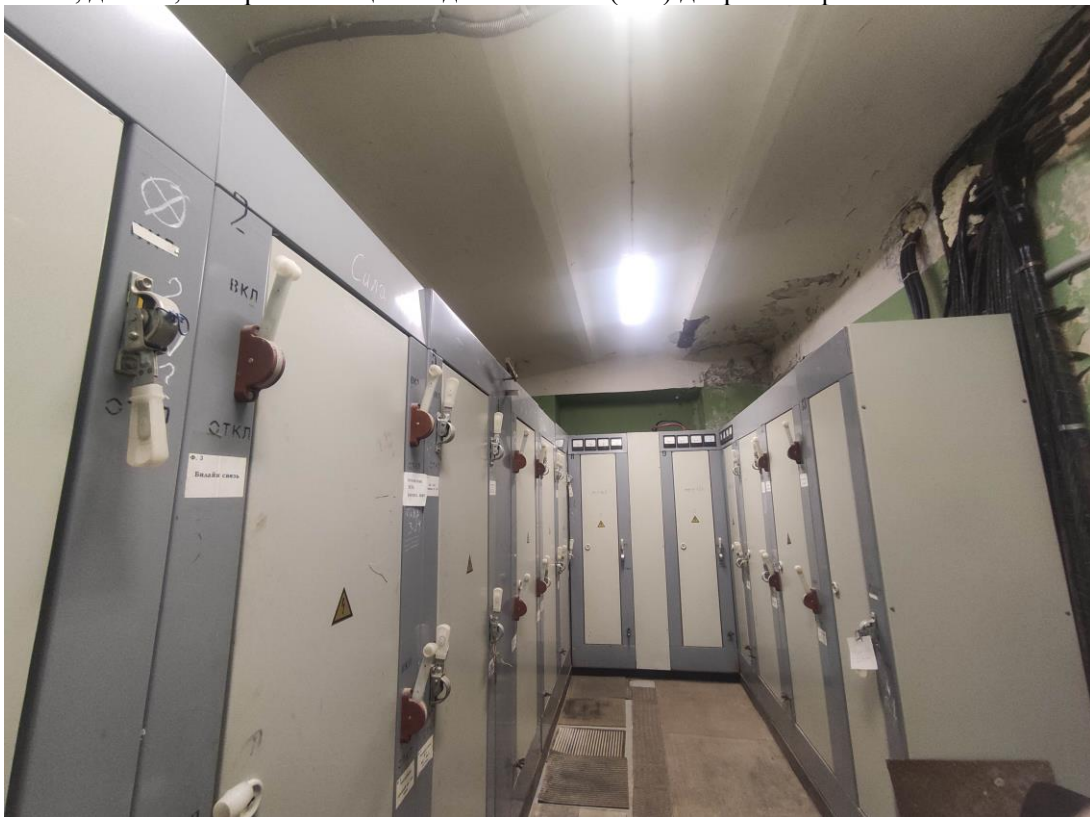
126. Объект культурного наследия регионального значения «Здание Физико-химического института Высших женских (Бестужевских) курсов», расположенный по адресу: г. Санкт-Петербург, Средний проспект В.О., дом 41, литера А. Общий вид пом. № 1-Н(138) дворового флигеля.
