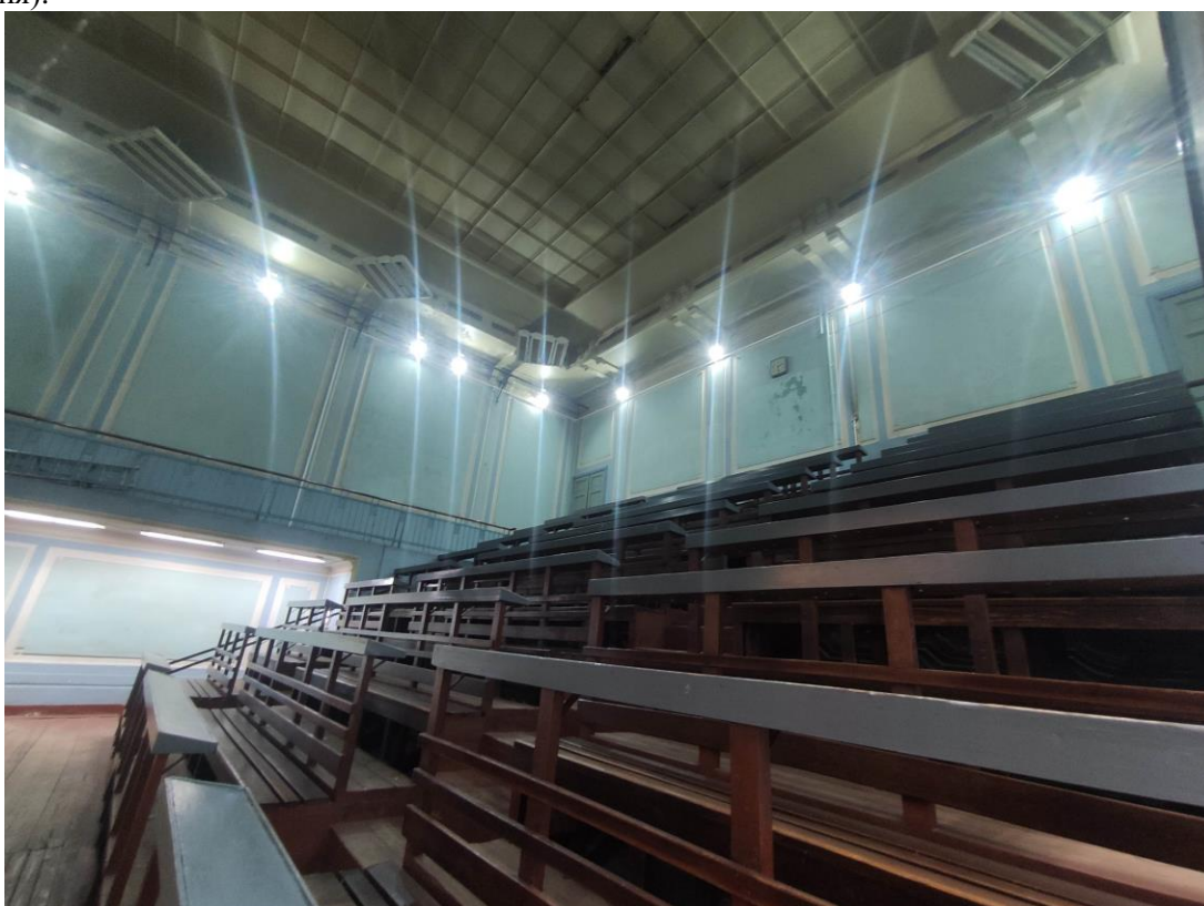
66. Объект культурного наследия регионального значения «Здание Физико-химического института Высших женских (Бестужевских) курсов», расположенный по адресу: г. Санкт-Петербург, Средний проспект В.О., дом 41, литера А. Общий вид пом. № 6/н главного корпуса (северо-западная большая аудитория).
