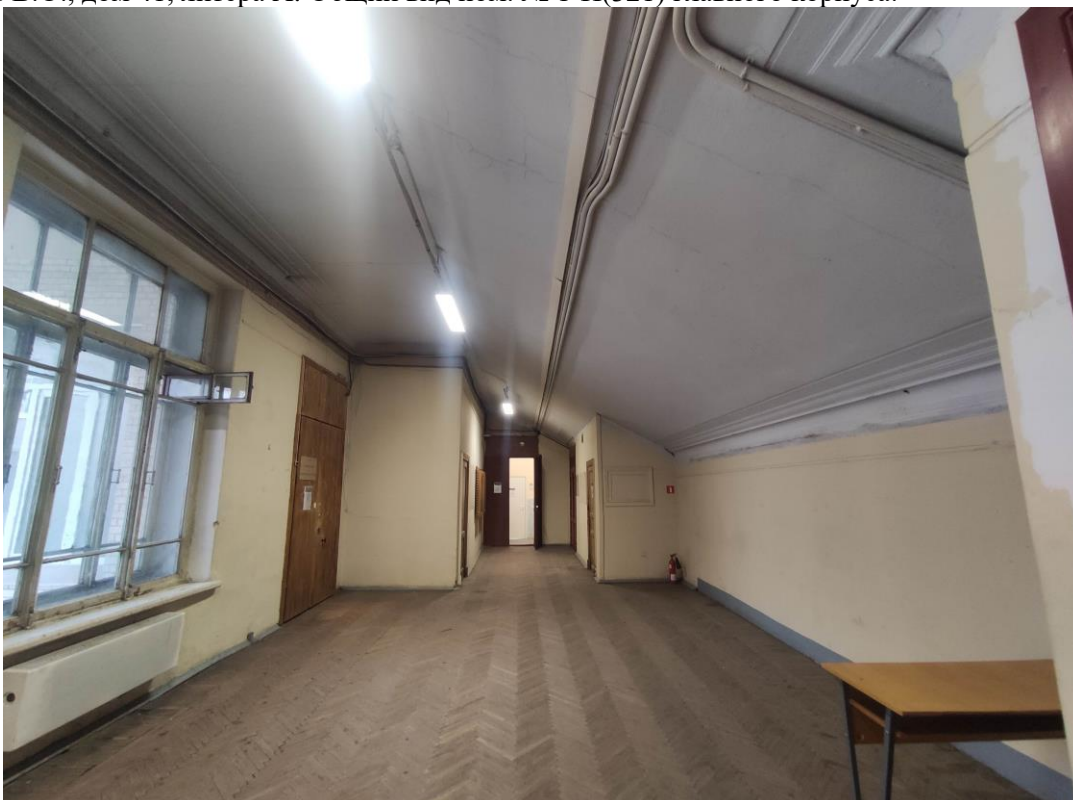
52. Объект культурного наследия регионального значения «Здание Физико-химического института Высших женских (Бестужевских) курсов», расположенный по адресу: г. Санкт-Петербург, Средний проспект В.О., дом 41, литера А. Общий вид пом. № 1-Н(317) главного корпуса.
