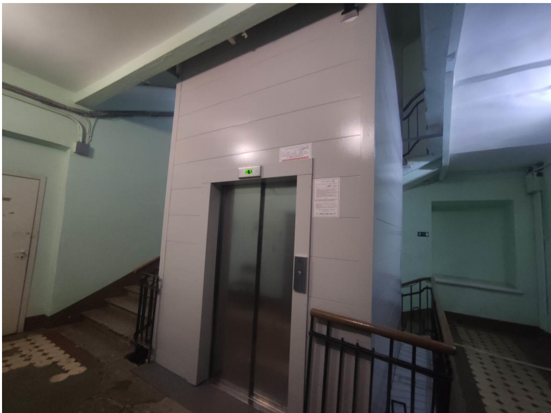
127. Объект культурного наследия регионального значения «Здание Физико-химического института Высших женских (Бестужевских) курсов», расположенный по адресу: г. Санкт-Петербург, Средний проспект В.О., дом 41, литера А. Общий вид пом. № 1-Н(128) дворового флигеля.
