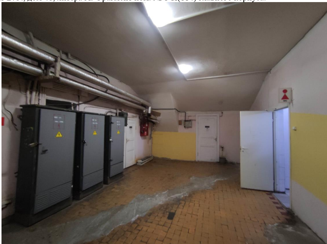
28. Объект культурного наследия регионального значения «Здание Физико-химического института Высших женских (Бестужевских) курсов», расположенный по адресу: г. Санкт-Петербург, Средний проспект В.О., дом 41, литера А. Общий вид пом. № 1-Н(13) главного корпуса.
