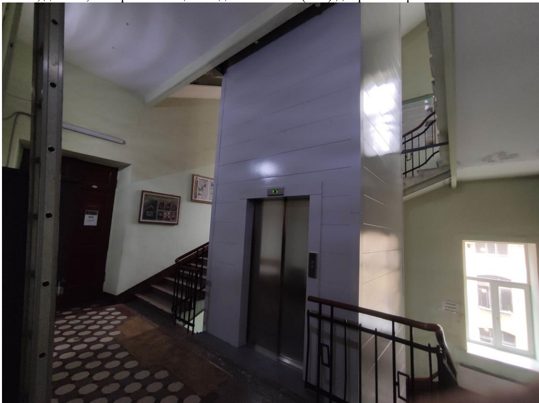
80. Объект культурного наследия регионального значения «Здание Физико-химического института Высших женских (Бестужевских) курсов», расположенный по адресу: г. Санкт-Петербург, Средний проспект В.О., дом 41, литера А. Общий вид пом. № 1-Н(342) дворового флигеля.
