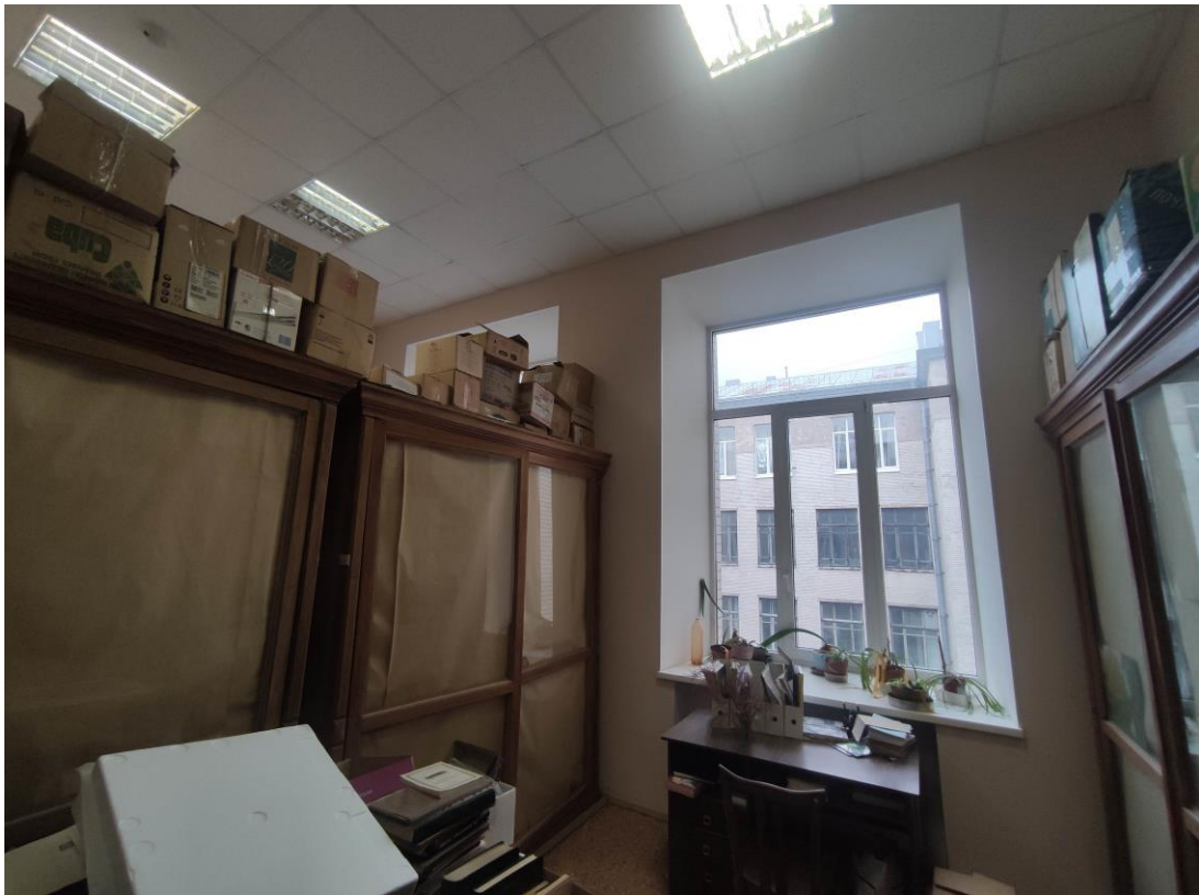
57. Объект культурного наследия регионального значения «Здание Физико-химического института Высших женских (Бестужевских) курсов», расположенный по адресу: г. Санкт-Петербург, Средний проспект В.О., дом 41, литера А. Общий вид пом. № 1-Н(296) флигеля, расположенного вдоль Среднего проспекта В.О.
