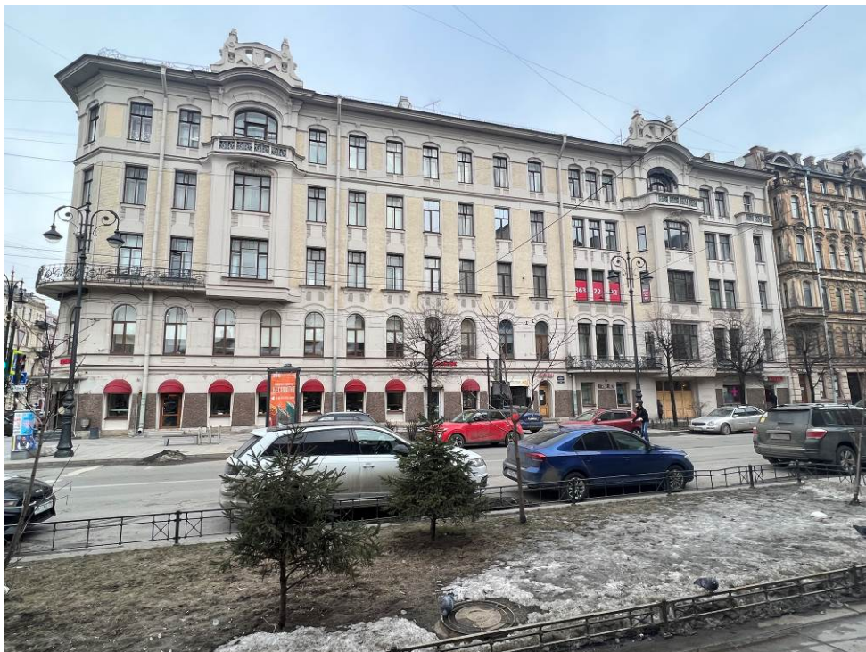
1. Выявленный объект культурного наследия «Дом А.Д. и Н.К. Чижовых». Лицевой фасад по ул. Чайковского. Вид с юго-востока.
