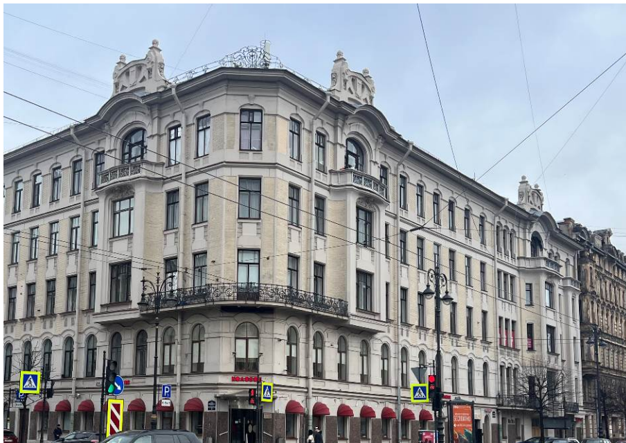
2. Выявленный объект культурного наследия «Дом А.Д.и Н.К.Чижовых». Общий вид здания с юго-запада.
