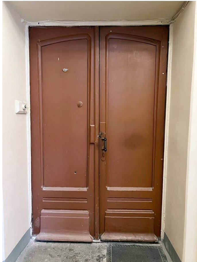
18. Выявленный объект культурного наследия «Дом А.Д.и Н.К.Чижовых». Интерьер парадной лестницы (вход с ул. Чайковского).
