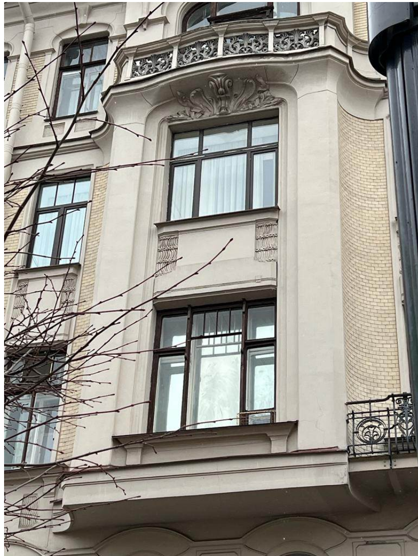
5. Выявленный объект культурного наследия «Дом А.Д.и Н.К.Чижовых». Фрагмент лицевого фасада по пр. Чернышевского. Эркер 3-4 этажей. На 3 этаже – образец исторической расстекловки оконного заполнения.
