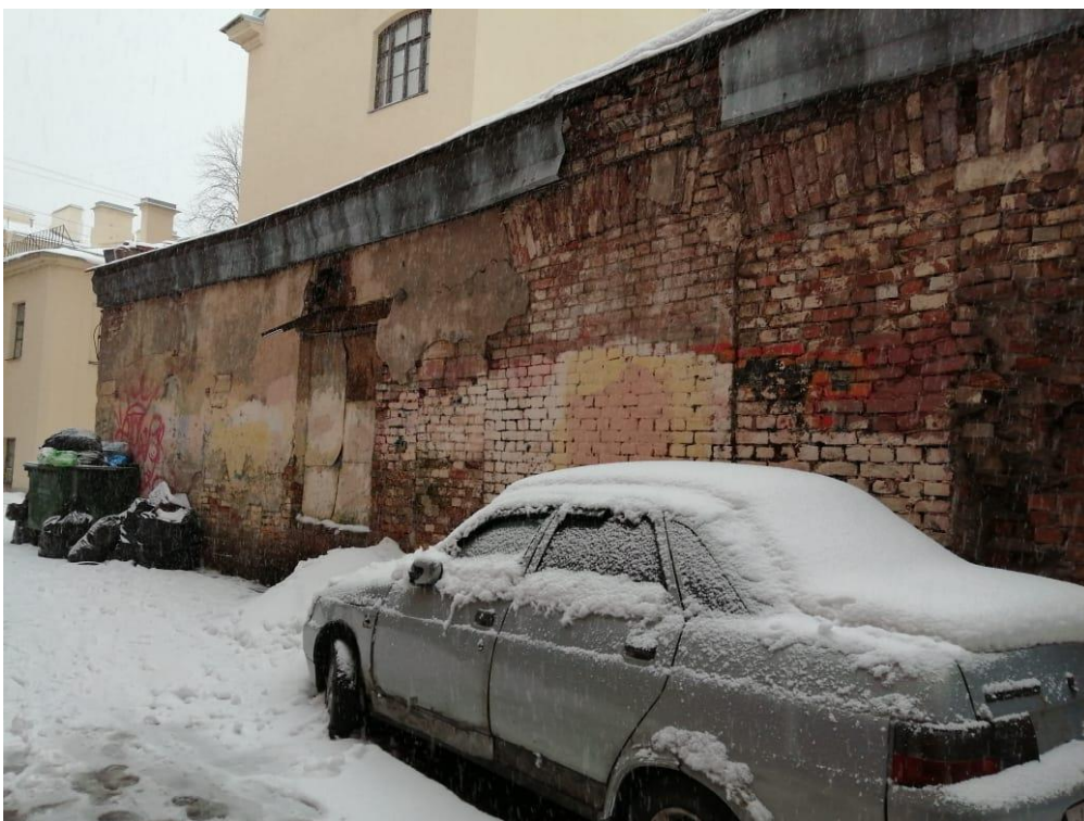
Фото 3. Выявленный объект культурного наследия «Доходные дома М.С. Воронина», расположенный по адресу: Санкт-Петербург, Адмиралтейский район, наб. реки Мойки, д. 82, литера А, Б, Ш. Надворный флигель (литера Ш), северный фасад.
