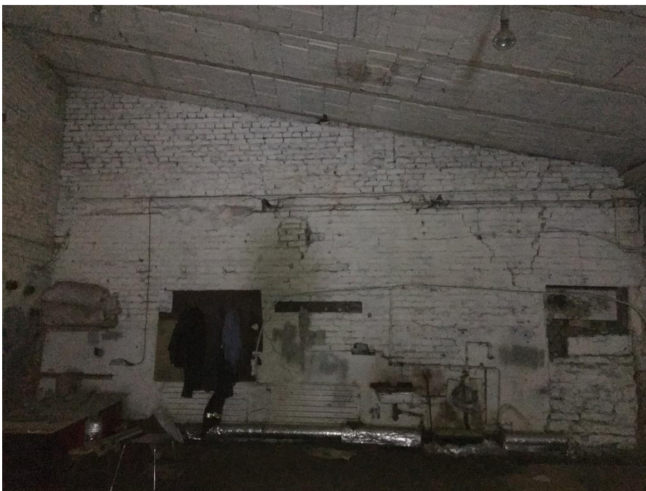
Фото 6. Выявленный объект культурного наследия «Доходные дома М.С. Воронина», расположенный по адресу: Санкт-Петербург, Адмиралтейский район, наб. реки Мойки, д. 82, литера А, Б, Ш. Надворный флигель (литера Ш), помещение 41(Н), внутренняя перегородка, разделяющая помещения флигеля.
