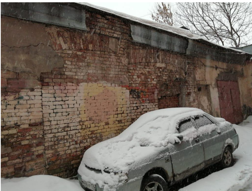
Фото 4. Выявленный объект культурного наследия «Доходные дома М.С. Воронина», расположенный по адресу: Санкт-Петербург, Адмиралтейский район, наб. реки Мойки, д. 82, литера А, Б, Ш. Надворный флигель (литера Ш), северный фасад (фрагмент).
