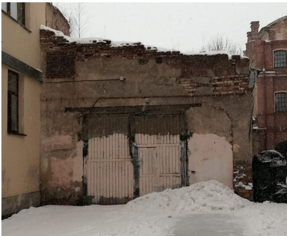
Фото 2. Выявленный объект культурного наследия «Доходные дома М.С. Воронина», расположенный по адресу: Санкт-Петербург, Адмиралтейский район, наб. реки Мойки, д. 82, литера А, Б, Ш. Надворный флигель (литера Ш), восточный фасад.
