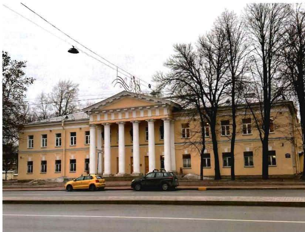
1. Западный лицевой фасад объекта культурного наследия.
