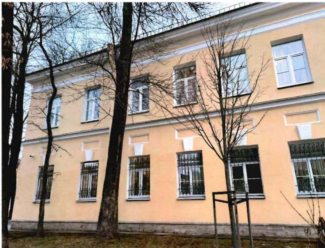
3. Южный фасад объекта культурного наследия.
