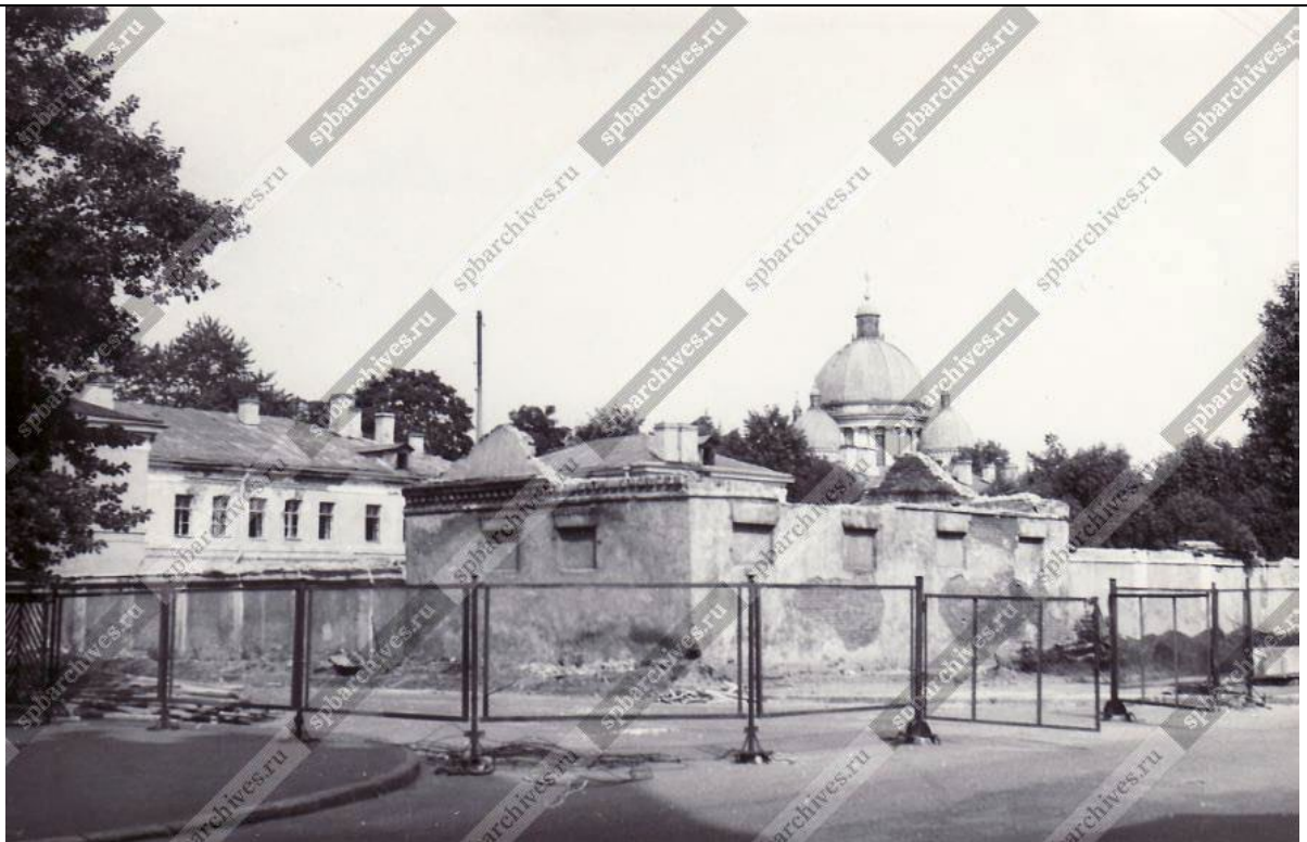
5. Снос старого здания для строительства Детского театра «На Неве»; вид на дворовый фасад Солдатской казармы. Фото 20 июля 1986 г. ЦГАКФФД СПб. Ар 217908
