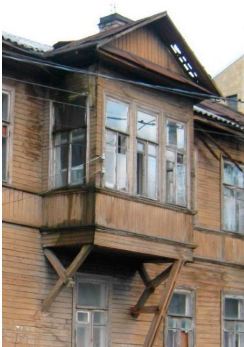
Илл. 9. Эркер на жилом доме по адресу: ул.Михайловская, 8 в г. Ломоносове. Столярные заполнения и кронштейны - подлинные.
