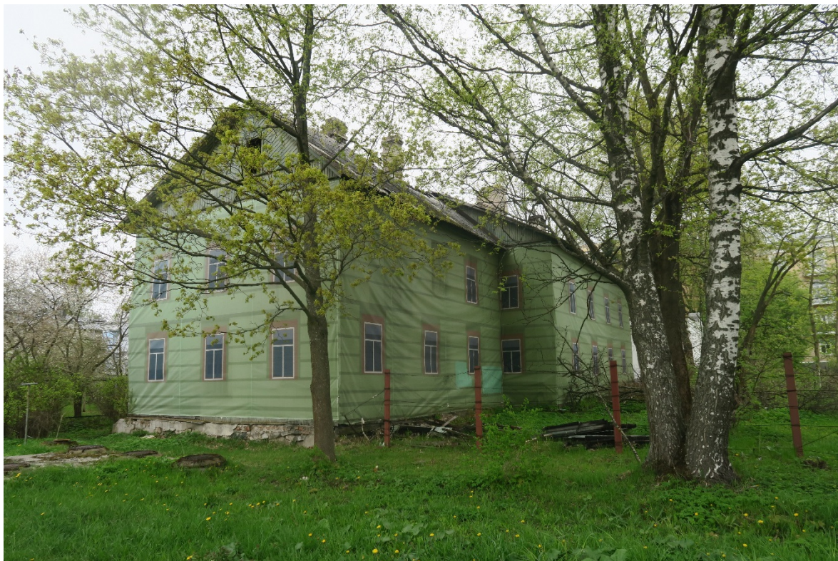
Илл. 8. Жилой дом по адресу г. Ломоносов, ул. Михайловская, д.19а, лит. А. после пожара. Вид с юго-запада. Фасады закрыты баннером. 2019 г.
