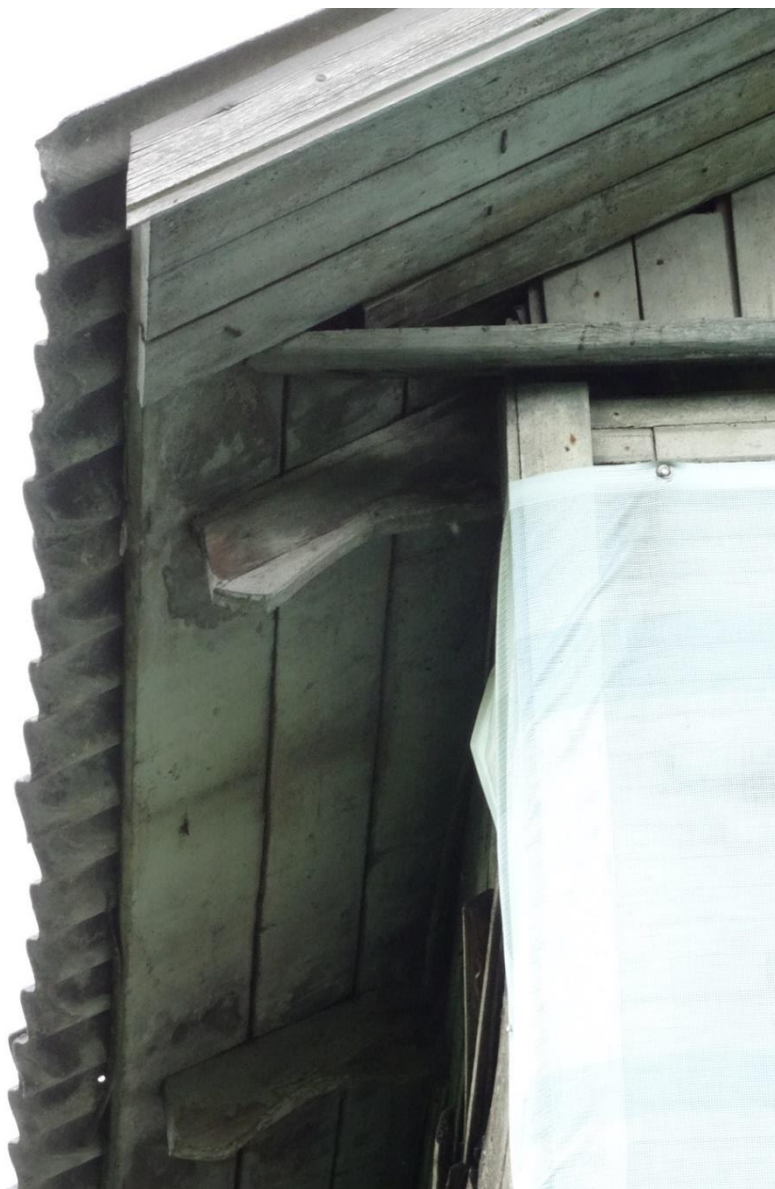
Фото 13. Карнизный свес по деревянным кобылкам. Северный фасад. Вид с запада.
