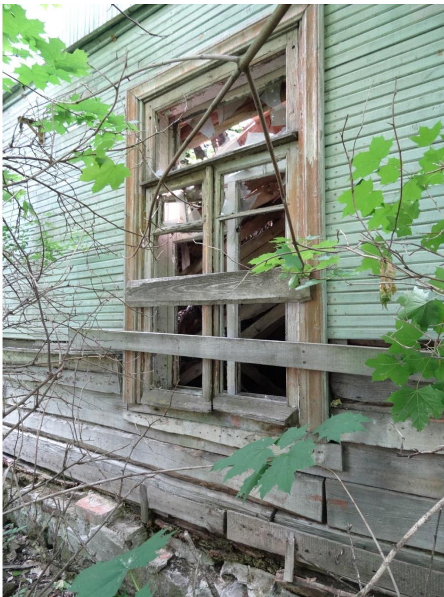
Фото 11. Оконный проем на северном фасаде. Ниже проема утрачена деревянная обшивка и виден сруб. Вид с северо-запада.
