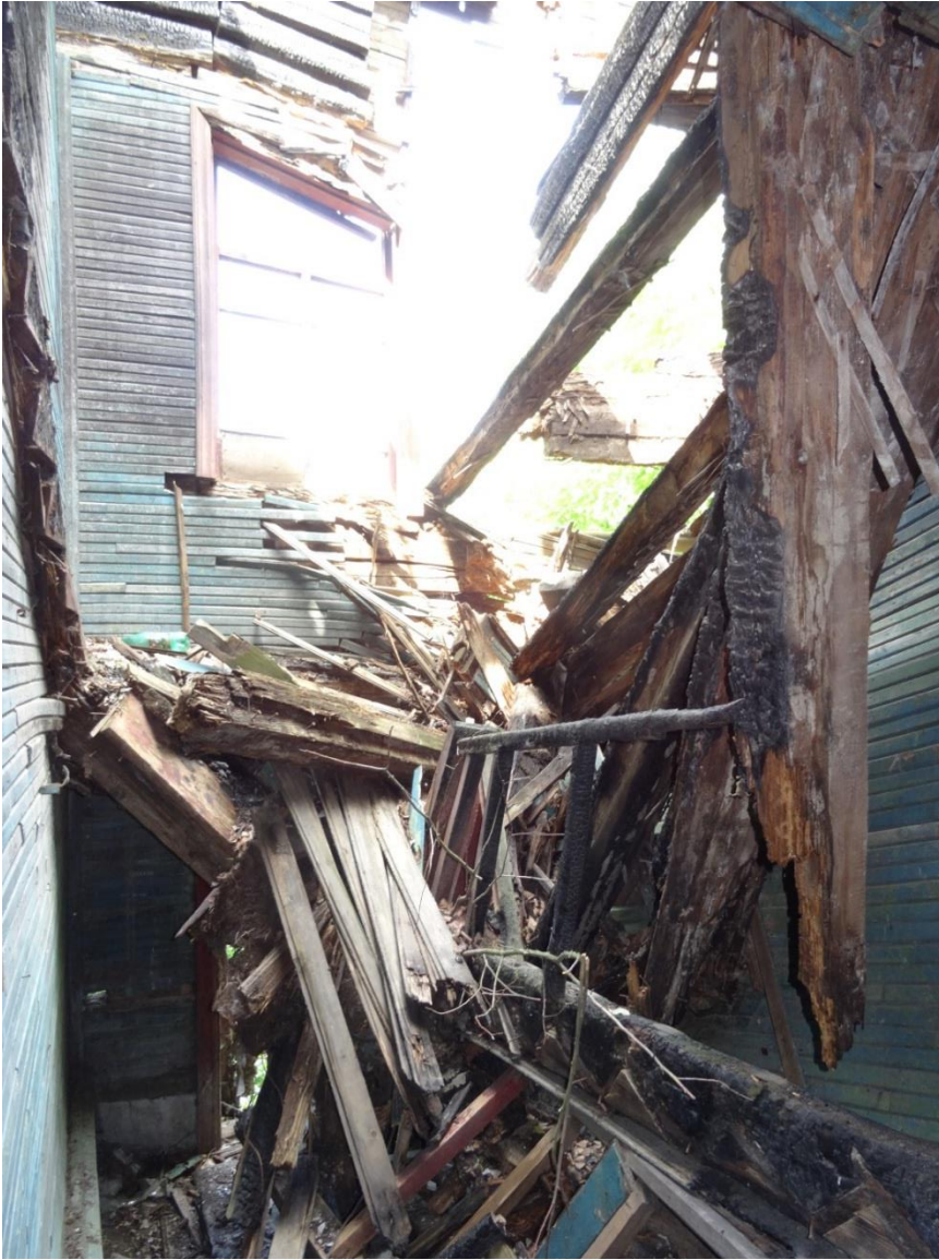
Фото 15. Общий вид помещения лестницы. Лестничные марши обрушены.
