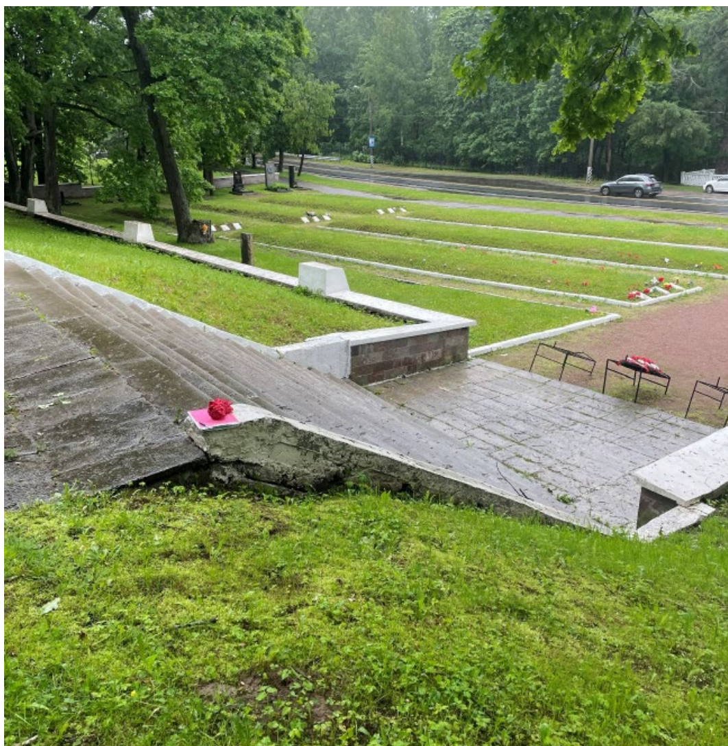
4. Южная часть объекта культурного наследия регионального значения «Братское воинское захоронение», расположенного по адресу: г. Санкт-Петербург, пос. Мартышкино, ул. Морская. 30.05.2023
