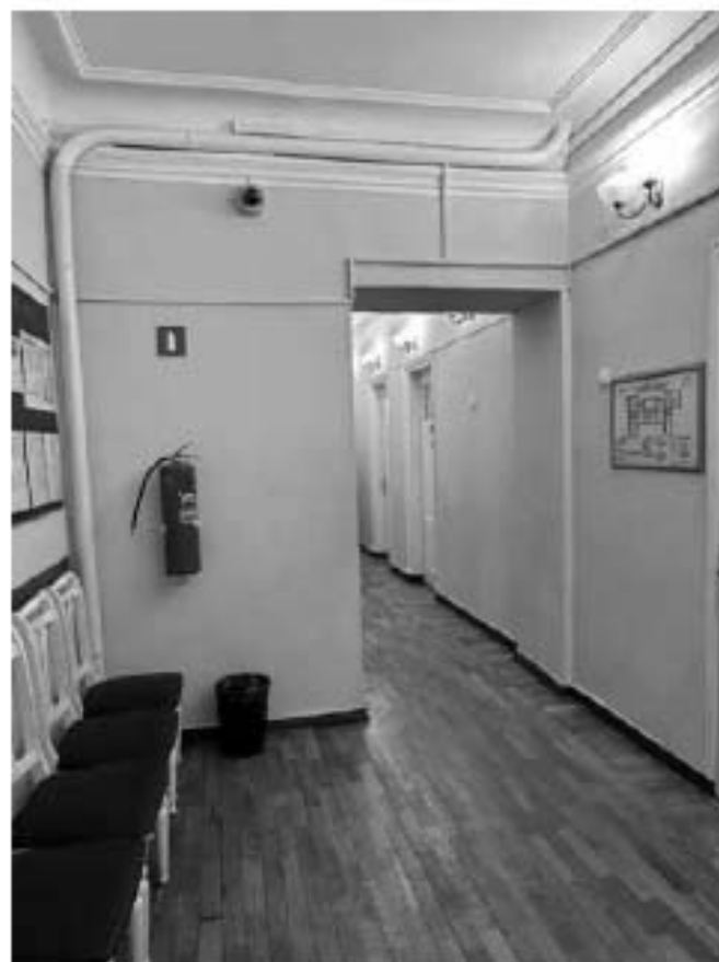
Фото 9. Коридор 2 этажа (Пом. 050)
