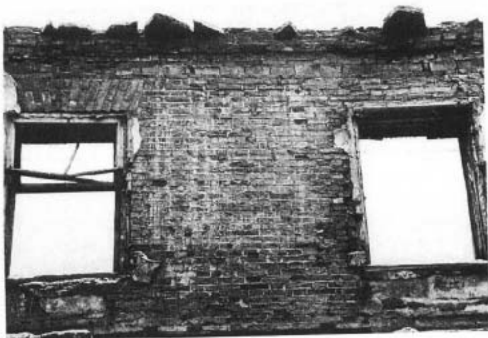
Илл. 20 1949 г. Деталь торцевого фасада. Фото А.Н. Петрова из Исторической справки по зданию Кикиных палат
