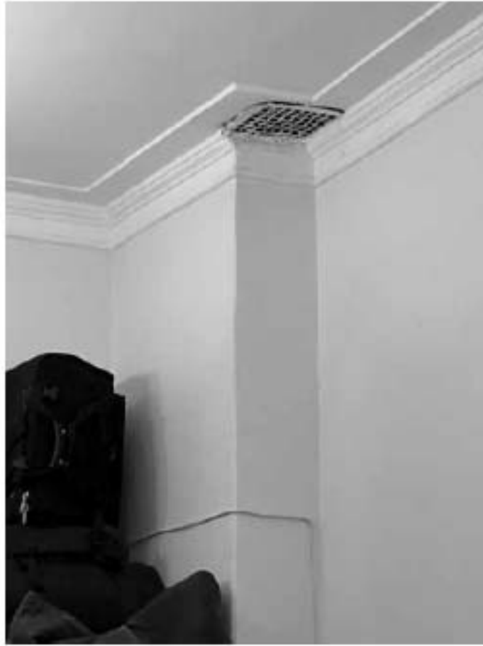
Фото 12. Вентиляционная шахта в помещении 3 этажа (Пом. 32)
