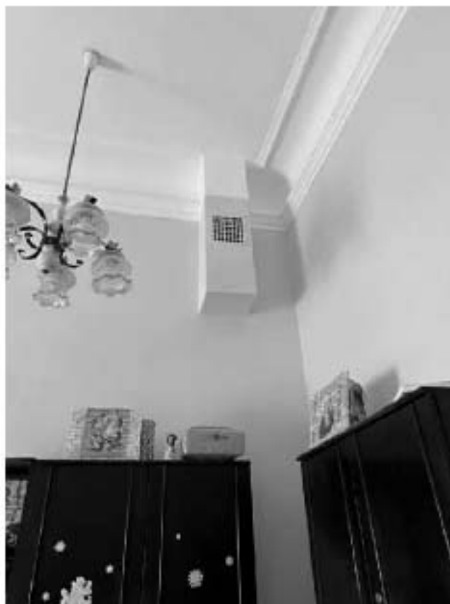
Фото 14. Вентиляционная шахта в помещении 2 этажа (Пом. 25)
