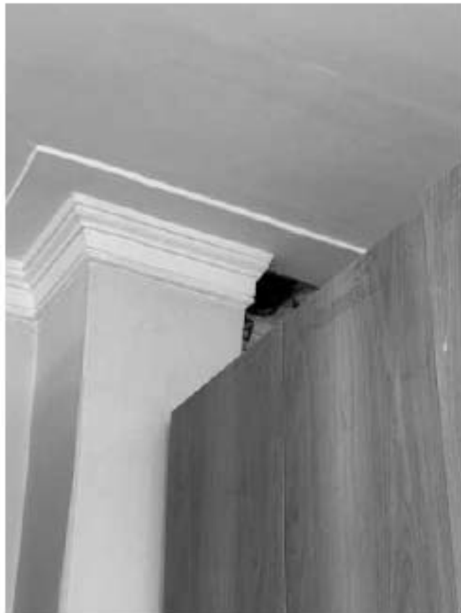
Фото 13. Вентиляционная шахта в помещении 3 этажа (Пом. 33)
