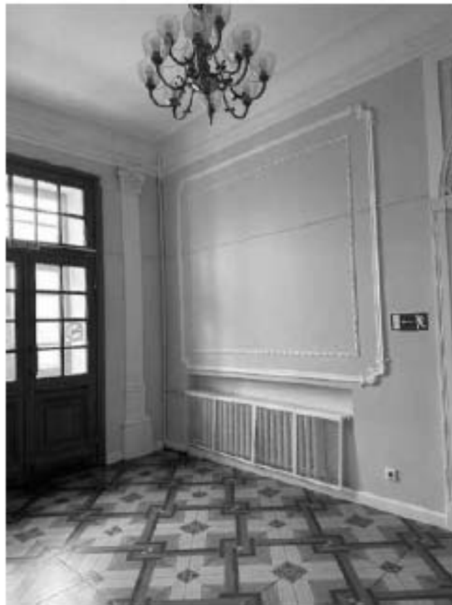
Фото 7. Входной тамбур 1-ого этажа (Пом. 028)
