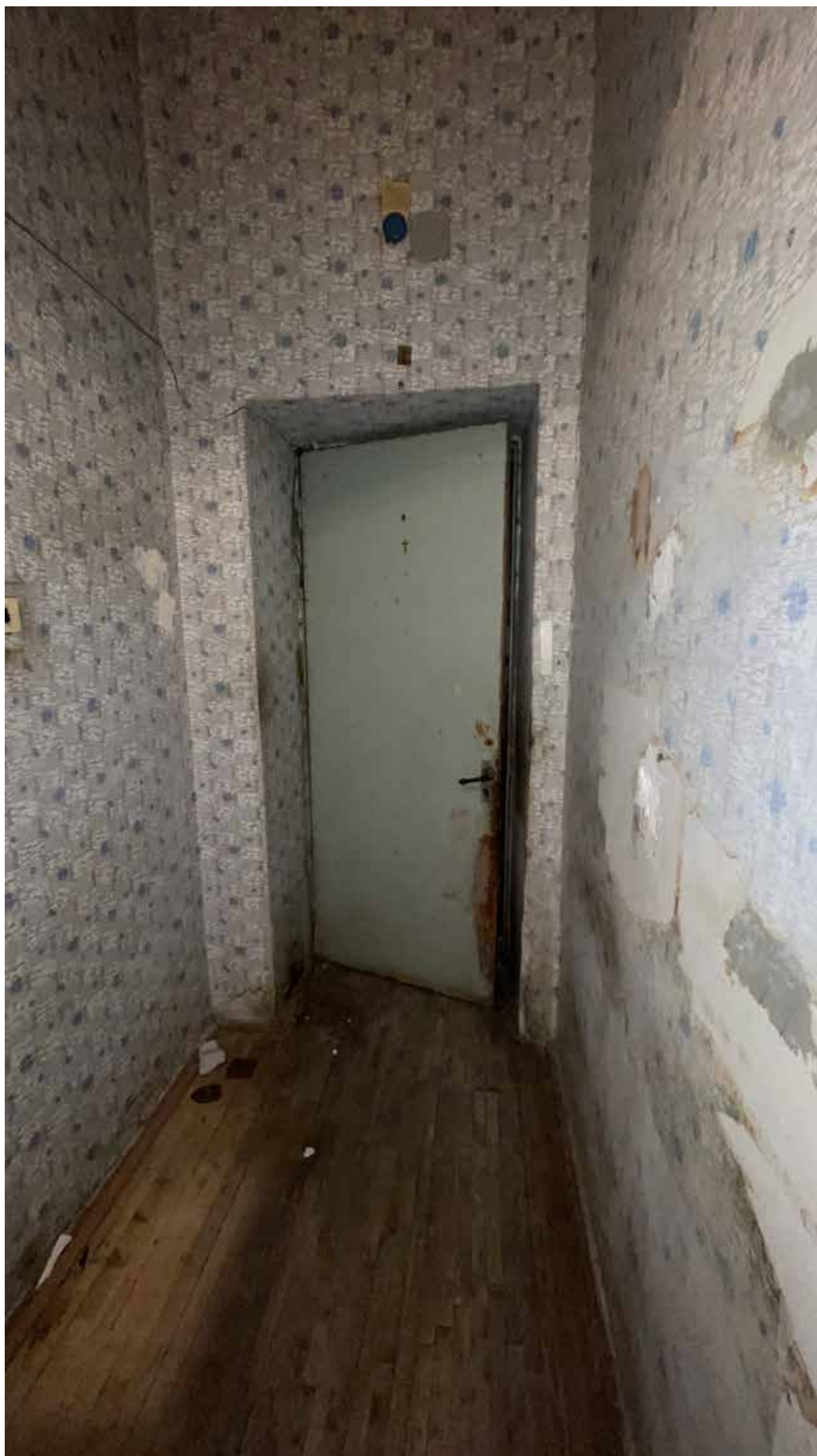
3. Вид на входную дверь в квартире;
