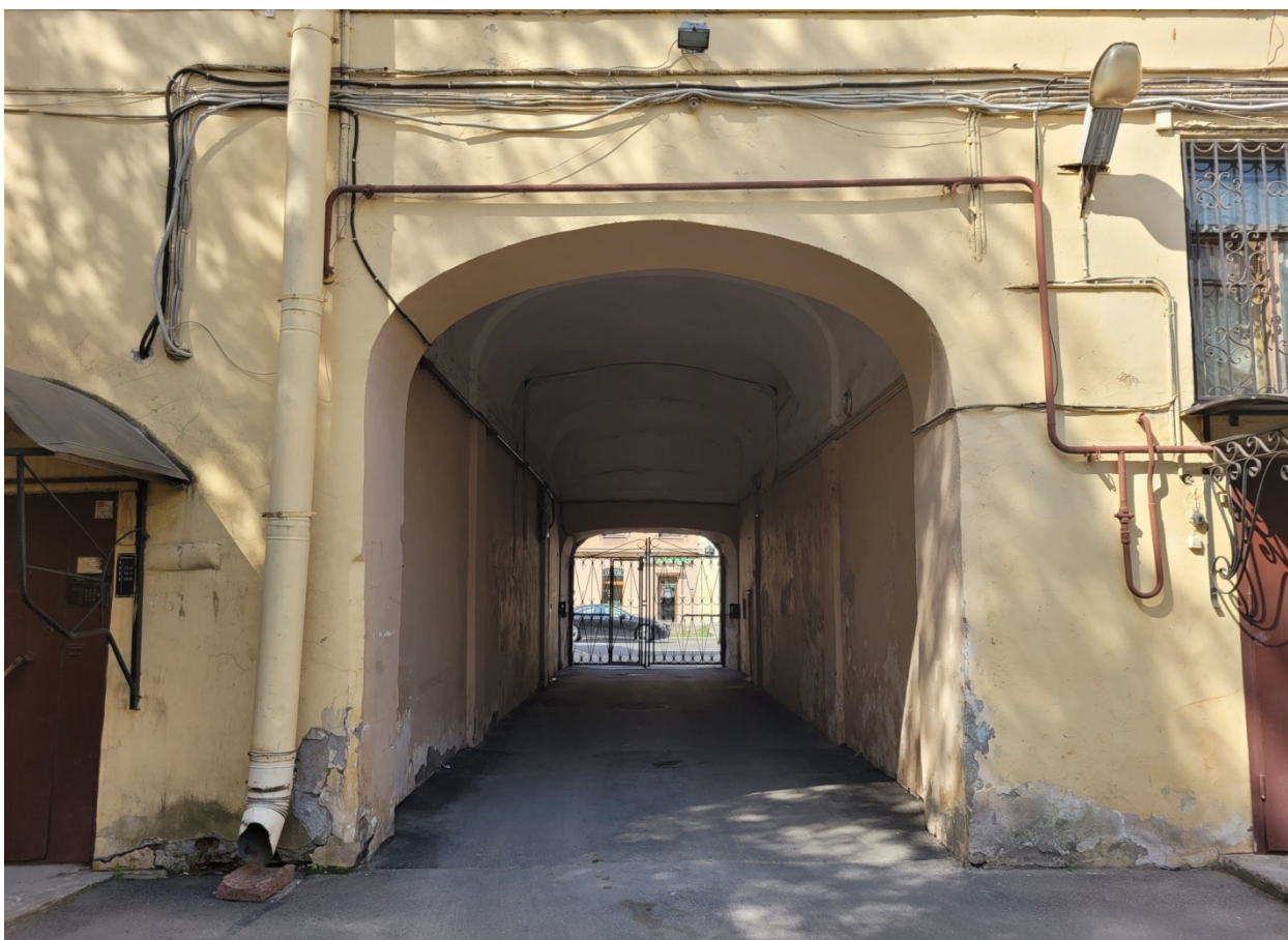
8. ОКНРЗ «Комплекс построек Главного управления государственного коннозаводства и Санкт-Петербургской аукционной конюшни», расположенный по адресу: Санкт-Петербург, улица Маяковского, дом 15, литера А. Воротный проезд. Вид со двора. Дата съемки: 28.04.2023г.
