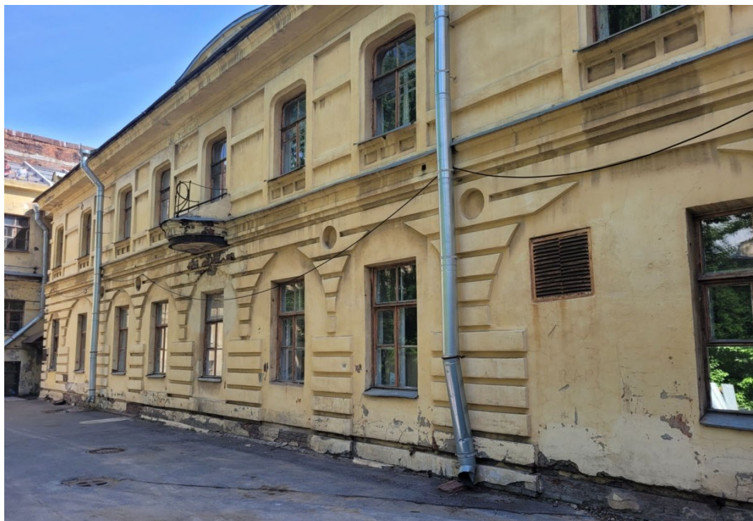
24. ОКНРЗ «Комплекс построек Главного управления государственного коннозаводства и Санкт-Петербургской аукционной конюшни», расположенный по адресу: Санкт-Петербург, улица Маяковского, дом 15, литера А. Служебный флигель (восточный). Аттик фасада по оси балкона. Дощатый руст первого этажа, образующий ложную аркаду. Дата съемки: 28.04.2023г.
