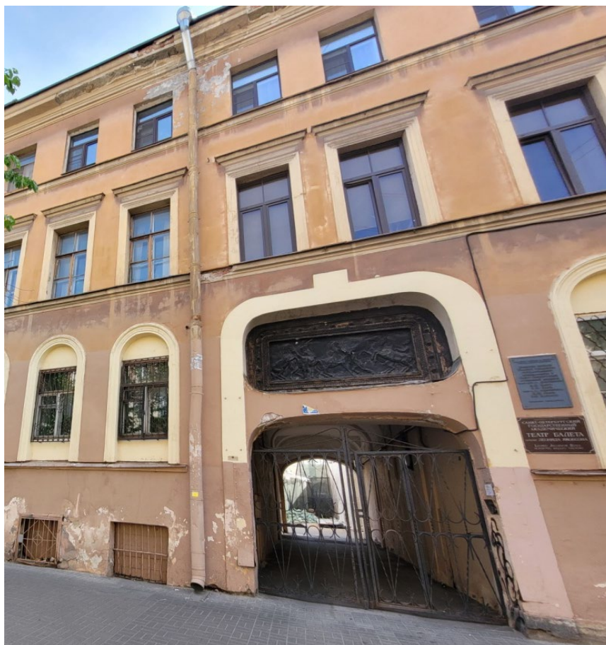
4. ОКНРЗ «Комплекс построек Главного управления государственного коннозаводства и Санкт-Петербургской аукционной конюшни», расположенный по адресу: Санкт-Петербург, улица Маяковского, дом 15, литера А. Исторические входные проемы коробовой конфигурации. Дата съемки: 28.04.2023г.
