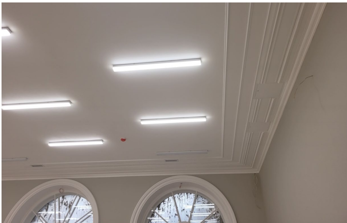
30. ОКНРЗ «Комплекс построек Главного управления государственного коннозаводства и Санкт-Петербургской аукционной конюшни», расположенный по адресу: Санкт-Петербург, улица Маяковского, дом 15, литера А. Исторические отметки междуэтажных перекрытий. Дата съемки: 28.04.2023г.
