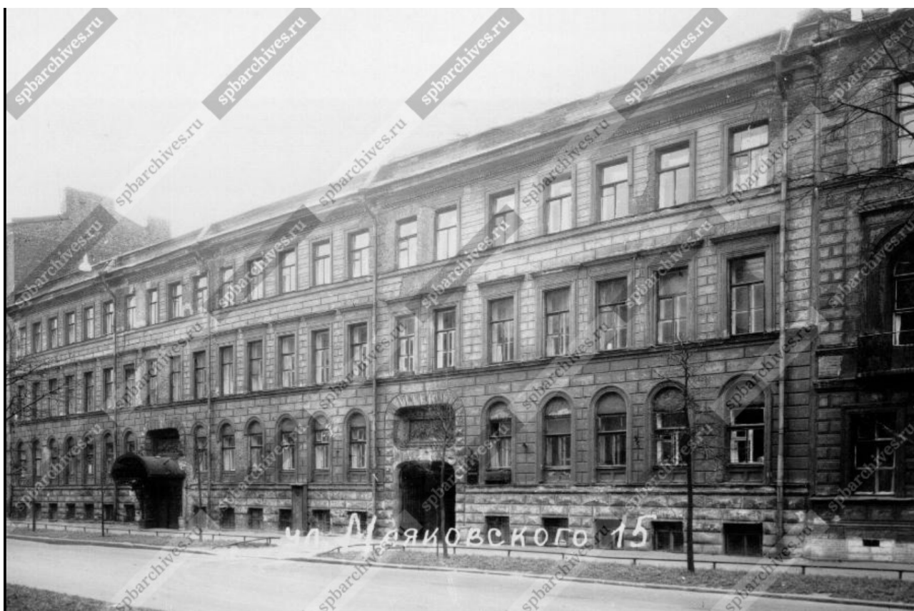
20. Фасад дома № 15 по улице Маяковского. 1960г. ЦГАКФФД СПб. Гр 75445.
