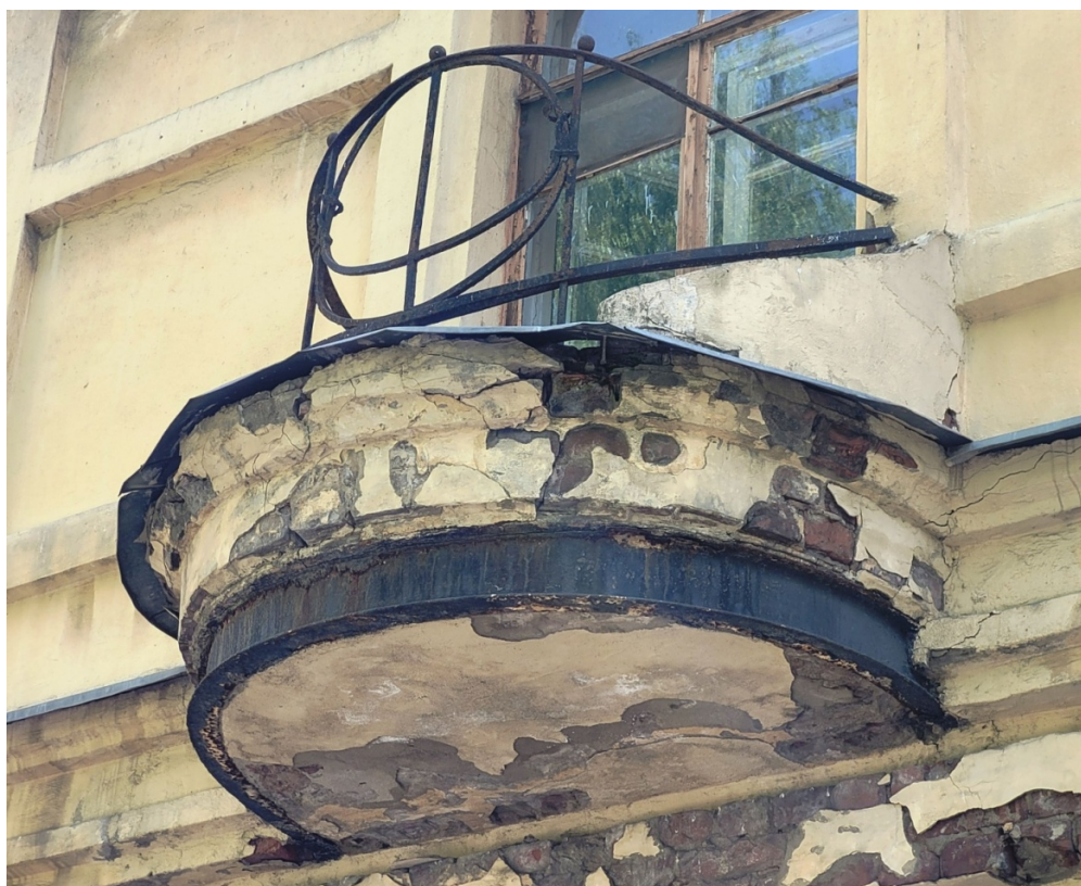
26. ОКНРЗ «Комплекс построек Главного управления государственного коннозаводства и Санкт-Петербургской аукционной конюшни», расположенный по адресу: Санкт-Петербург, улица Маяковского, дом 15, литера А. Балкон Служебного флигеля (восточного) – оштукатуренный парапет с металлическим ограждением в стиле модерн. Двухбашенное основание. Дата съемки: 28.04.2023г.
