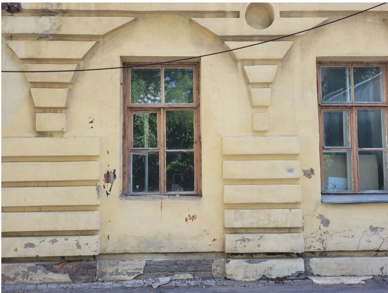
27. ОКНРЗ «Комплекс построек Главного управления государственного коннозаводства и Санкт-Петербургской аукционной конюшни», расположенный по адресу: Санкт-Петербург, улица Маяковского, дом 15, литера А. Гладкая штукатурка фасада Служебного флигеля (восточного). Дощатый руст в уровне первого этажа. Исторические (прямоугольные) оконные проемы первого этажа. Историческое заполнение оконных проемов (дерево), рисунок расстекловки. Дата съемки: 28.04.2023г.
