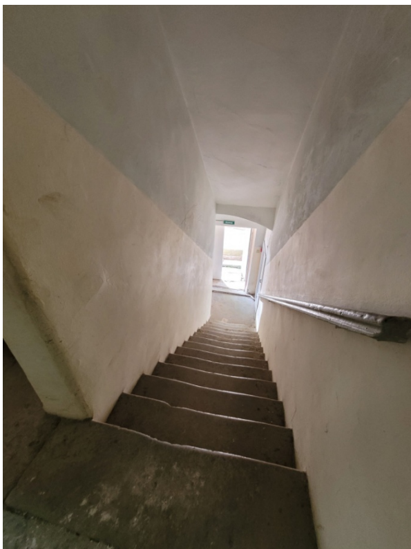
44. ОКНРЗ «Комплекс построек Главного управления государственного коннозаводства и Санкт-Петербургской аукционной конюшни», расположенный по адресу: Санкт-Петербург, улица Маяковского, дом 15, литера А. Интерьер Служебного флигеля (северного). Историческая лестница. Тип свода перекрытия – лучковый. Материал ступеней – известняк. Дата съемки: 28.04.2023г.
