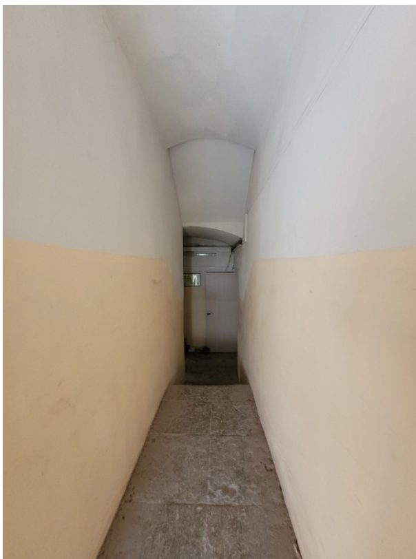
42. ОКНРЗ «Комплекс построек Главного управления государственного коннозаводства и Санкт-Петербургской аукционной конюшни», расположенный по адресу: Санкт-Петербург, улица Маяковского, дом 15, литера А. Интерьер Служебного флигеля (северного). Историческая лестница. Тип свода перекрытия – лучковый. Материал площадок – лещадная плита. Дата съемки: 28.04.2023г.
