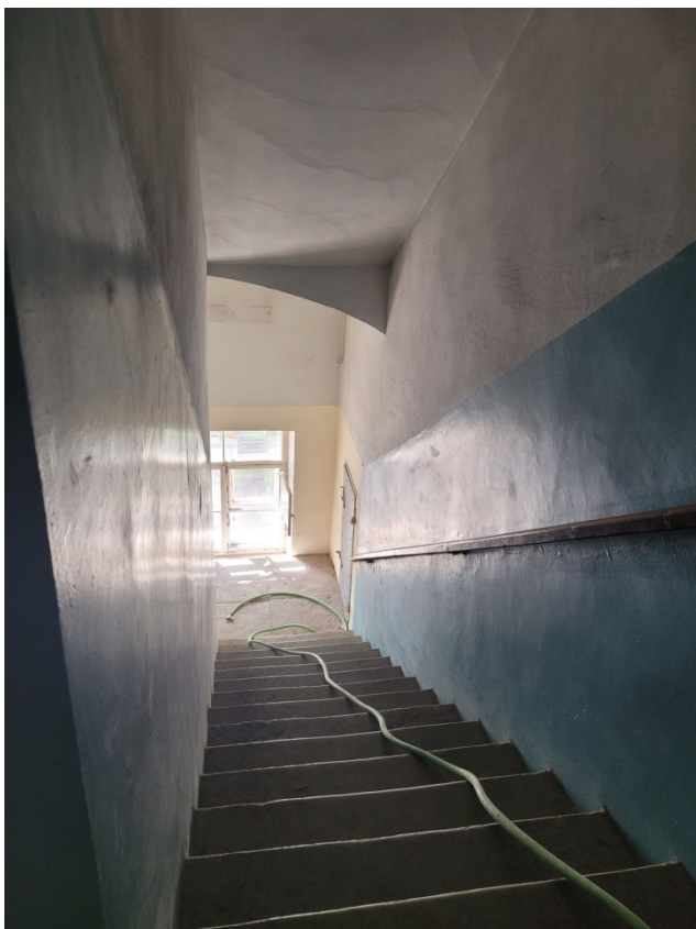
40. ОКНРЗ «Комплекс построек Главного управления государственного коннозаводства и Санкт-Петербургской аукционной конюшни», расположенный по адресу: Санкт-Петербург, улица Маяковского, дом 15, литера А. Интерьер Служебного флигеля (северного). Лучковый тип свода перекрытия исторической лестницы. Дата съемки: 28.04.2023г.
