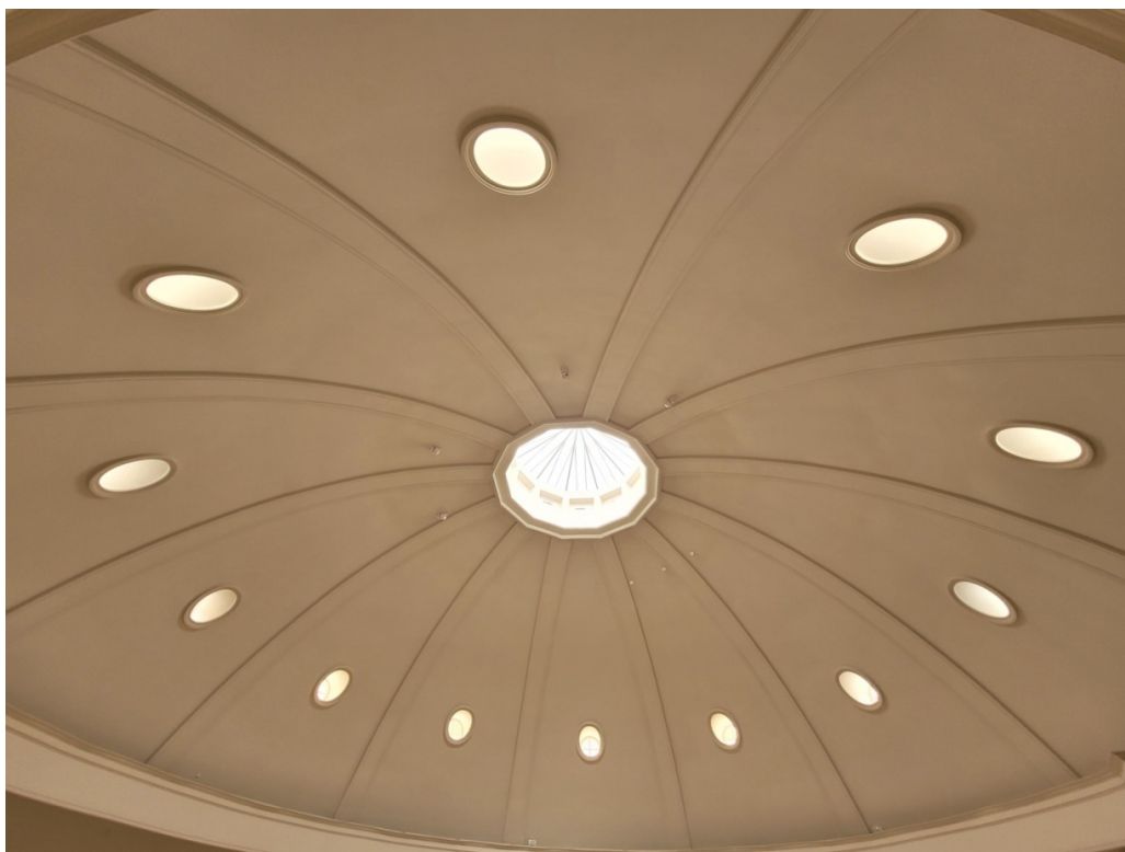
32. ОКНРЗ «Комплекс построек Главного управления государственного коннозаводства и Санкт-Петербургской аукционной конюшни», расположенный по адресу: Санкт-Петербург, улица Маяковского, дом 15, литера А. Интерьер Выводного манежа. Световой фонарь (в виде жесткого граненого барабана с конусовидным завершением) в завершении купола. Дата съемки: 28.04.2023г.
