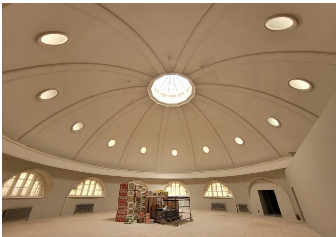
31. ОКНРЗ «Комплекс построек Главного управления государственного коннозаводства и Санкт-Петербургской аукционной конюшни», расположенный по адресу: Санкт-Петербург, улица Маяковского, дом 15, литера А. Интерьер Выводного манежа. Сферический монолитный с ребрами жесткости купол. Световой фонарь. Дата съемки: 28.04.2023г.
