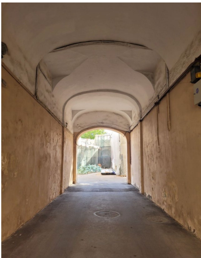
7. ОКНРЗ «Комплекс построек Главного управления государственного коннозаводства и Санкт-Петербургской аукционной конюшни», расположенный по адресу: Санкт-Петербург, улица Маяковского, дом 15, литера А. Воротный проезд – коробовый тип свода перекрытий с распалубками на подпружинных арках. Дата съемки: 28.04.2023г.
