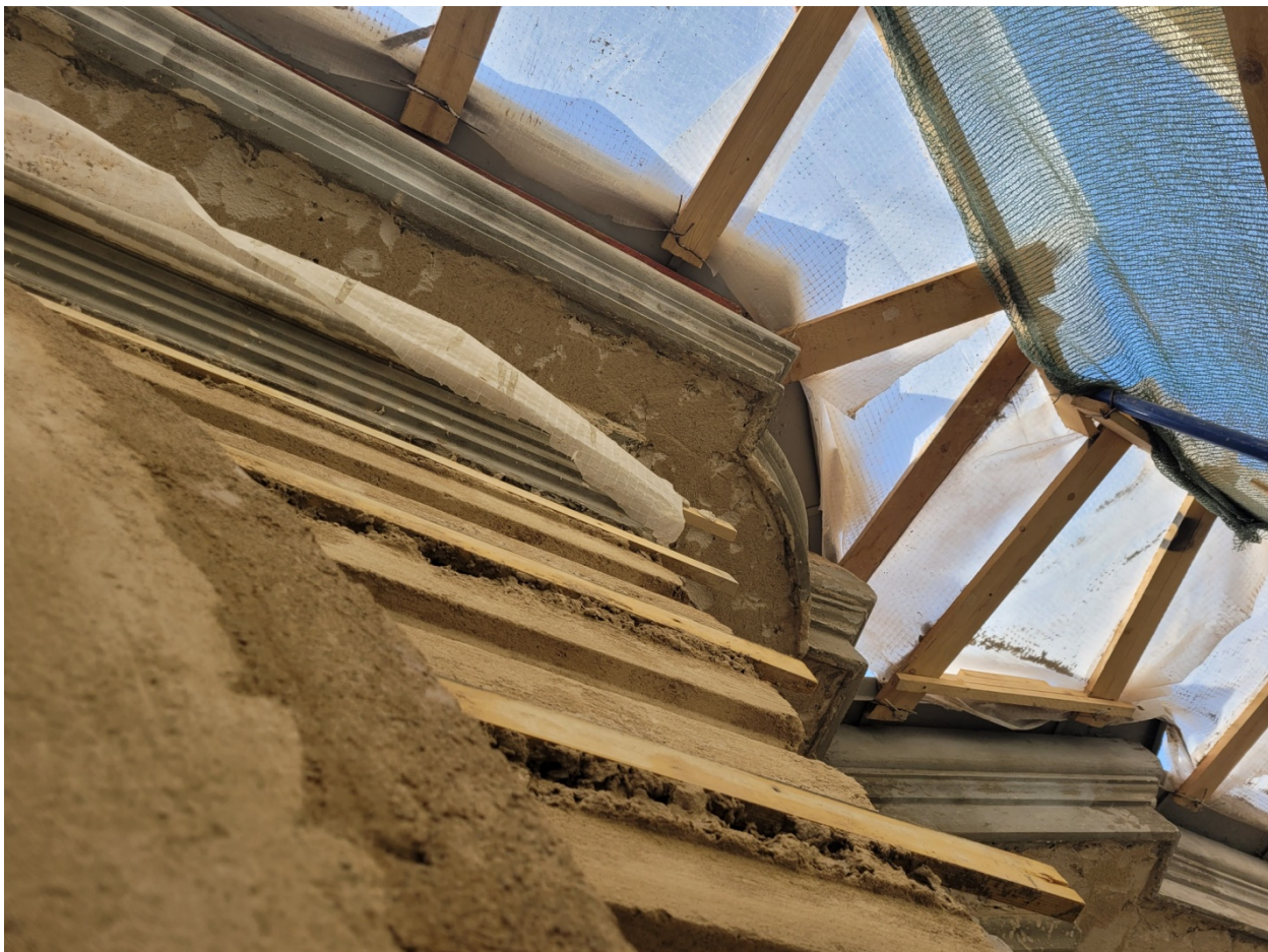
48. ОКНРЗ «Комплекс построек Главного управления государственного коннозаводства и Санкт-Петербургской аукционной конюшни», расположенный по адресу: Санкт-Петербург, улица Маяковского, дом 15, литера А. Выводной манеж. Фасад: материал отделки – гладкая штукатурка. Профилированная тяга с гладким фризом, профилированный раскрепованный венчающий выносной карниз. Дата съемки: 28.04.2023г.
