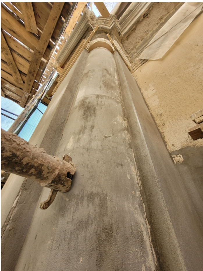
47. ОКНРЗ «Комплекс построек Главного управления государственного коннозаводства и Санкт-Петербургской аукционной конюшни», расположенный по адресу: Санкт-Петербург, улица Маяковского, дом 15, литера А. Выводной манеж. Фасад: материал отделки – гладкая штукатурка. Филенки. Дата съемки: 28.04.2023г.
