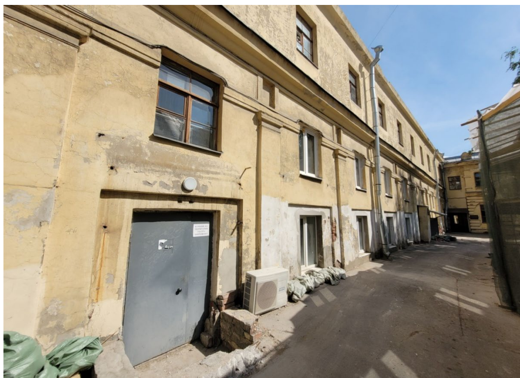
20. ОКНРЗ «Комплекс построек Главного управления государственного коннозаводства и Санкт-Петербургской аукционной конюшни», расположенный по адресу: Санкт-Петербург, улица Маяковского, дом 15, литера А. Служебный флигель (северный), западная часть. Неисторическая дверь вместо оконного проема. Прямок перед неисторическим входом. Дата съемки: 28.04.2023г.
