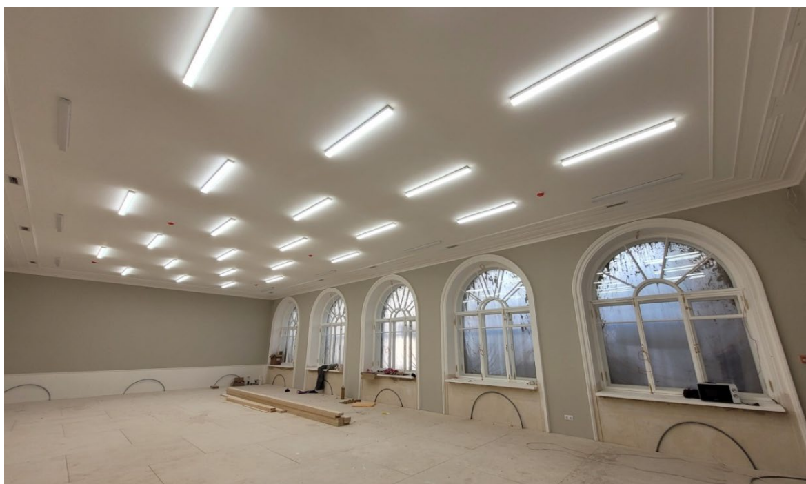
29. ОКНРЗ «Комплекс построек Главного управления государственного коннозаводства и Санкт-Петербургской аукционной конюшни», расположенный по адресу: Санкт-Петербург, улица Маяковского, дом 15, литера А. Исторические оконные проемы по фасаду Аукционной конюшни – местоположение, полуциркулярной конфигурации, габариты; материал (дерево), рисунок расстекловки. Дата съемки: 28.04.2023г.
