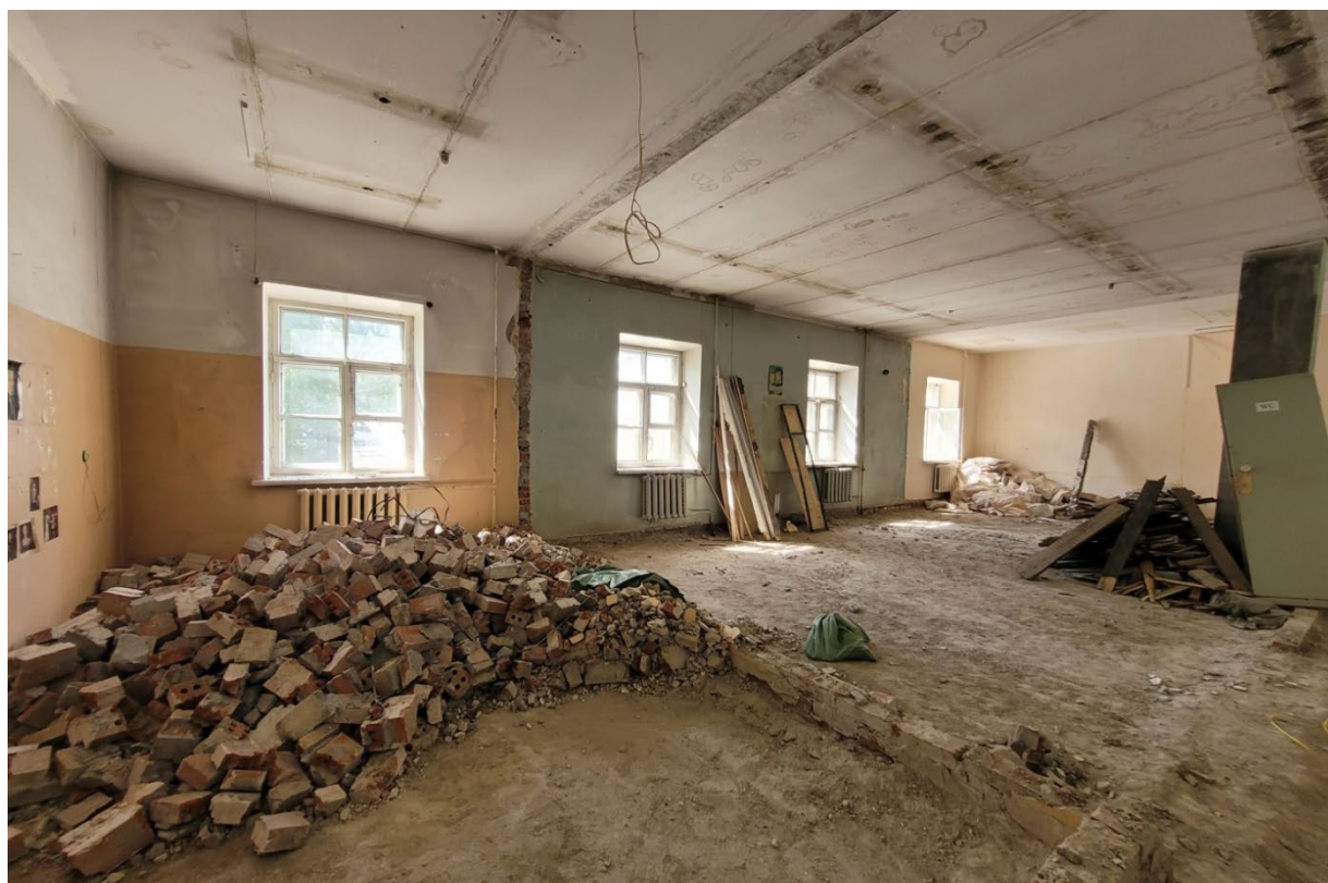
41. ОКНРЗ «Комплекс построек Главного управления государственного коннозаводства и Санкт-Петербургской аукционной конюшни», расположенный по адресу: Санкт-Петербург, улица Маяковского, дом 15, литера А. Интерьер Служебного флигеля (северного). 3-й этаж. Исторические оконные проемы (прямоугольные); рисунок расстекловки. Дата съемки: 28.04.2023г.
