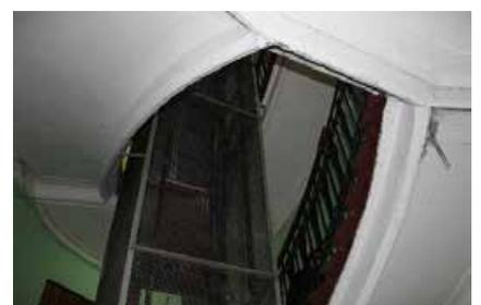
двухмаршевая межэтажная лестница 16 ЛК – с известняковыми ступенями по металлическим косоурам, с криволинейными маршами и площадками, с перильным кованым ограждением черного металла, рисунок (мотив меандра в нижней части, цветочные и круглые розетки в верхней, перехваты),\* деревянный профилированный поручень;
