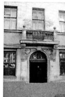
крыльцо: с шестью полуциркульными в плане ступенями (материал – известняковая плита), верхней площадкой и перспективным порталом парадного входа с замковым камнем;
