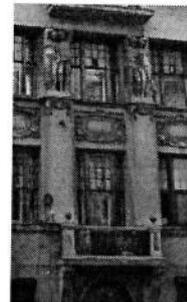
проемы балконных дверей: прямоугольного завершения с откосами, отделанными облицовочным кирпичом, трехчастные – с профилированным наличником и замковым камнем;
