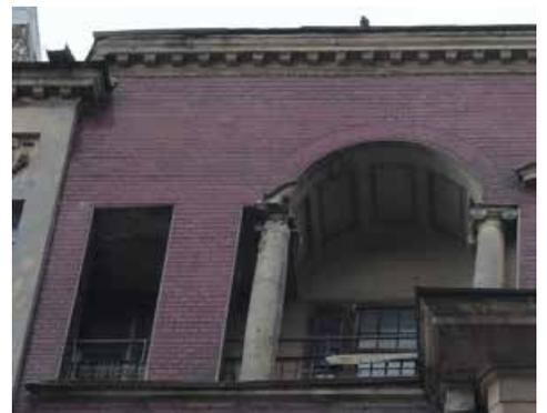
угловые лоджии в уровне 5-го этажа фасадов курдонера – с массивной колонной и полуколоннами с поясом иоников в капителях, с ограждением в виде оштукатуренных опорных тумб, завершенных сферами, и металлических секций;\*
