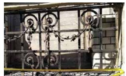
французские балконы на орнаментированных кронштейнах, в одну световую ось в уровне 4-го этажа угловых частей северного фасада и курдонера, с ограждением в виде оштукатуренных опорных тумб, завершенных сферами, и металлических секций;\*
