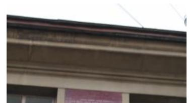
венчающий профилированный карниз с «сухариками» - в части угловой башни и щипцов;
