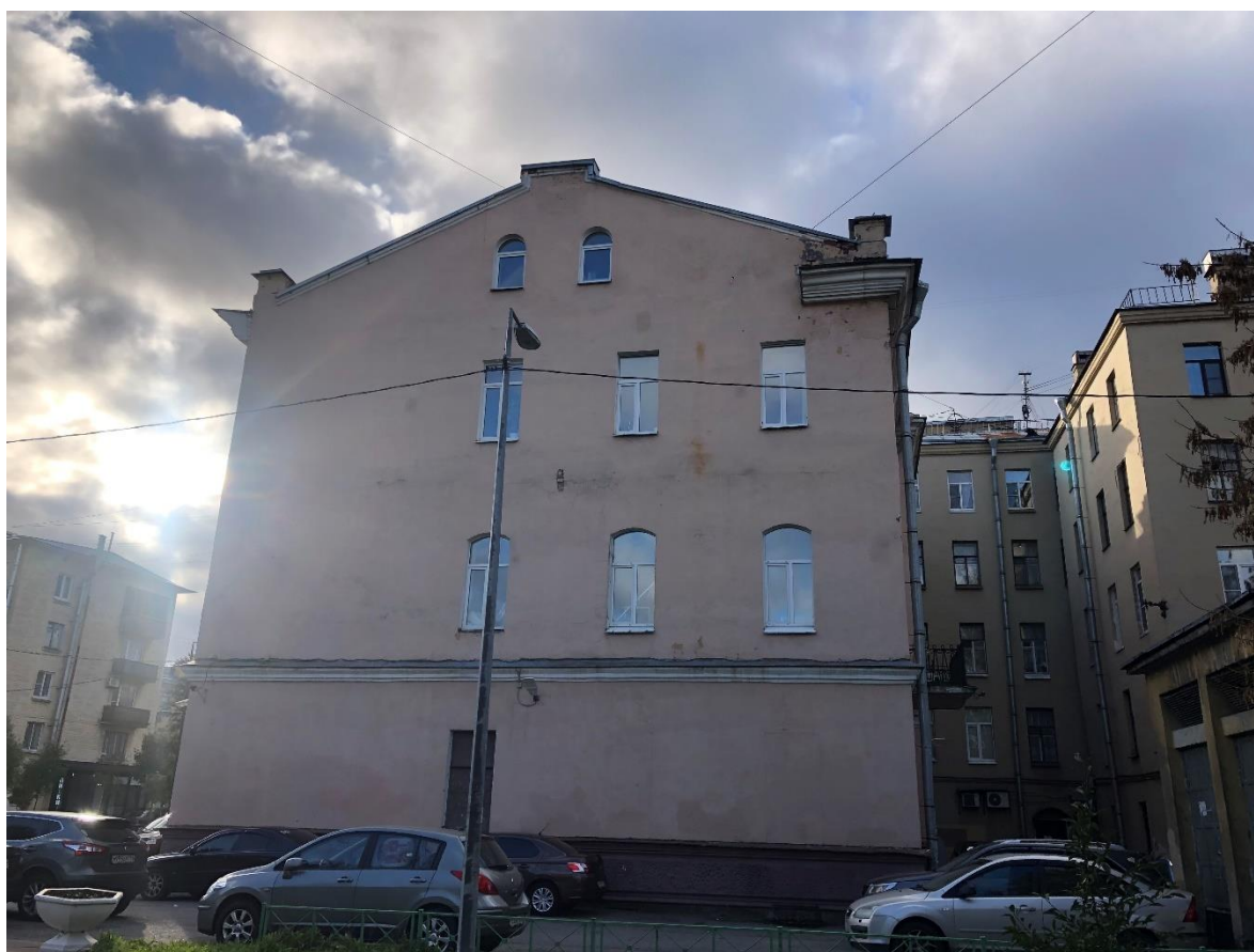
Фото 5. Северный фасад здания.
