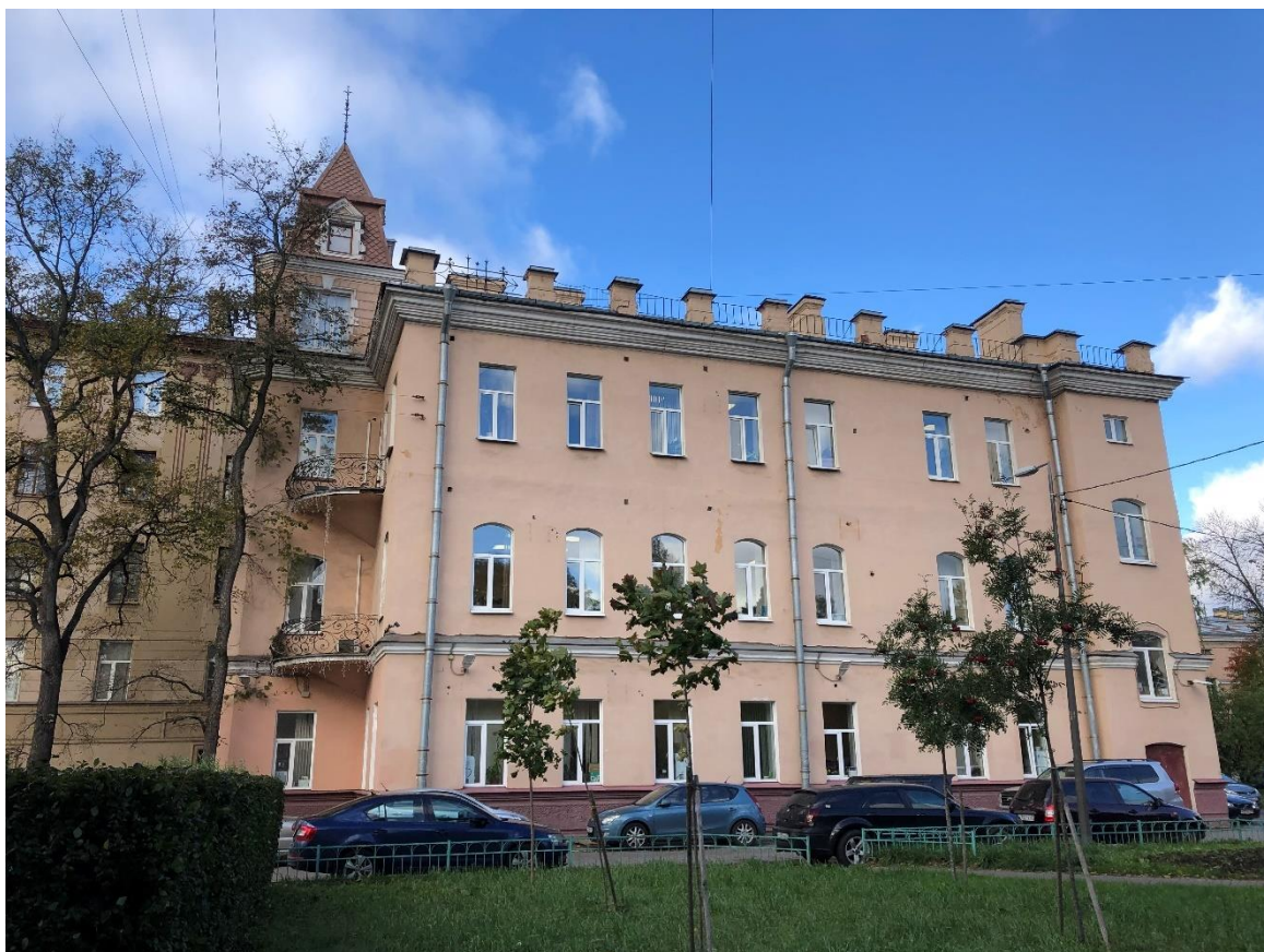
Фото 4. Восточный фасад здания.
