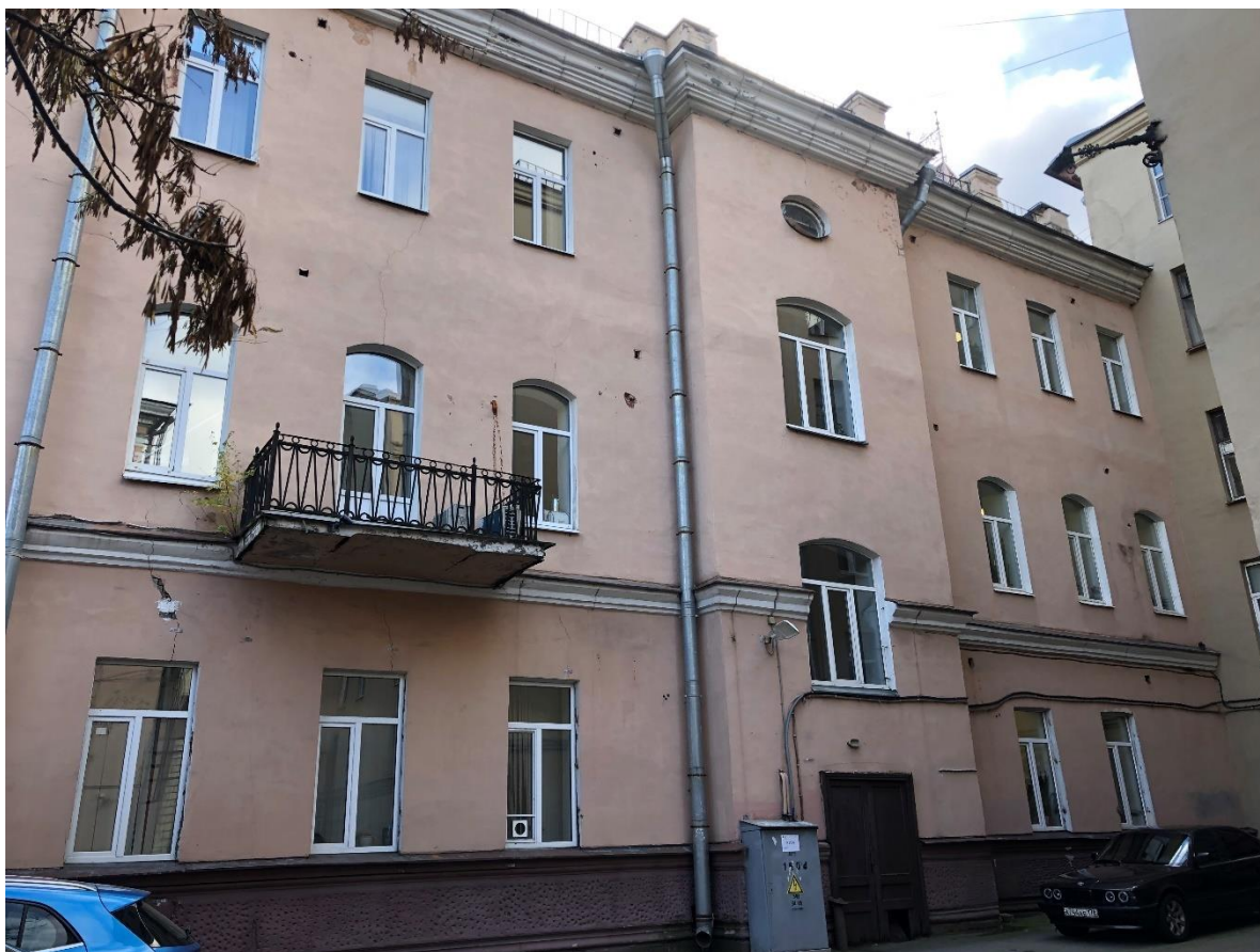
Фото 6. Западный фасад здания.
