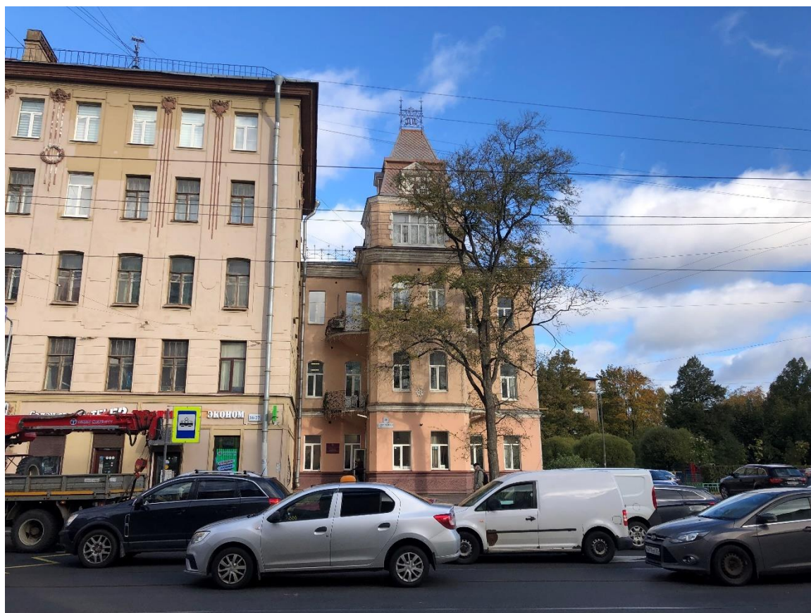
Фото 2. Лицевой фасад (южный) здания с Большой Пороховской улицы.
