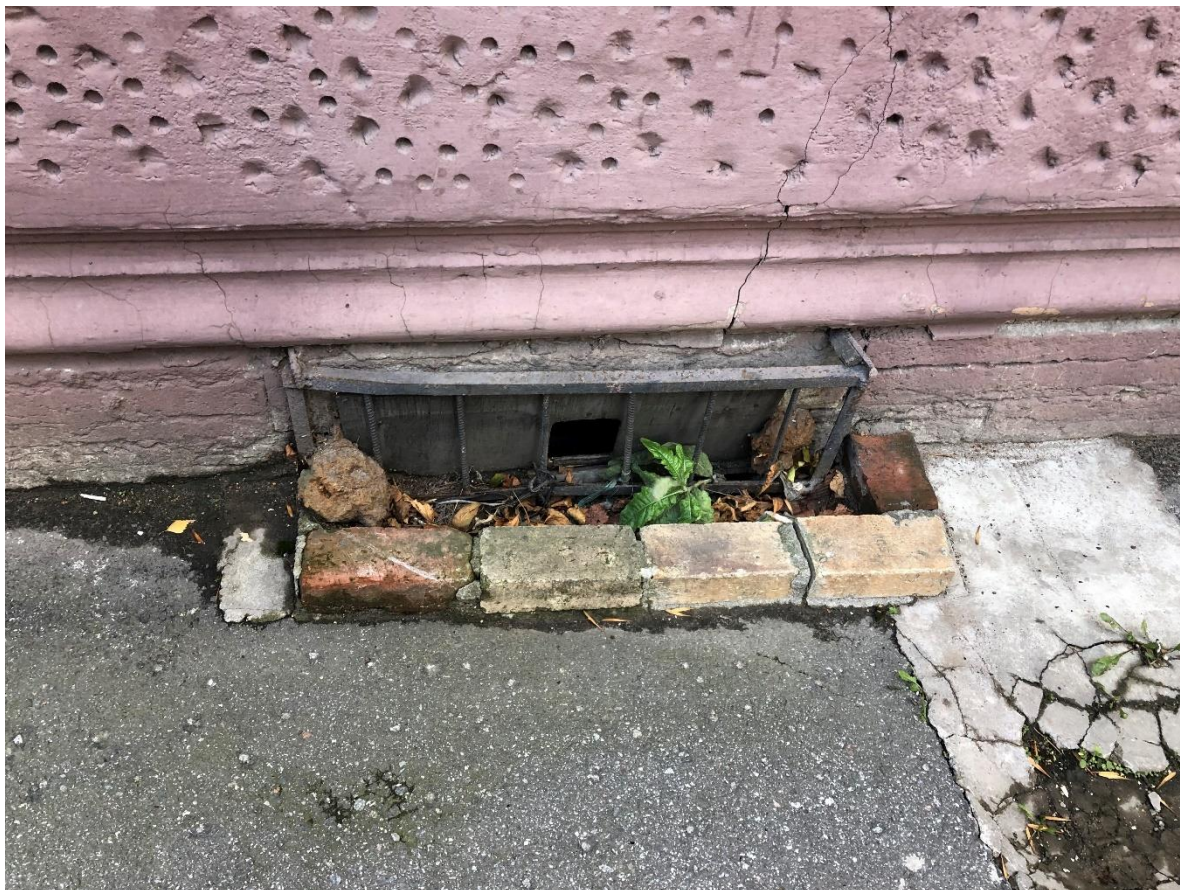
Фото 7. Фрагмент западного фасада (заложенный приямок).
