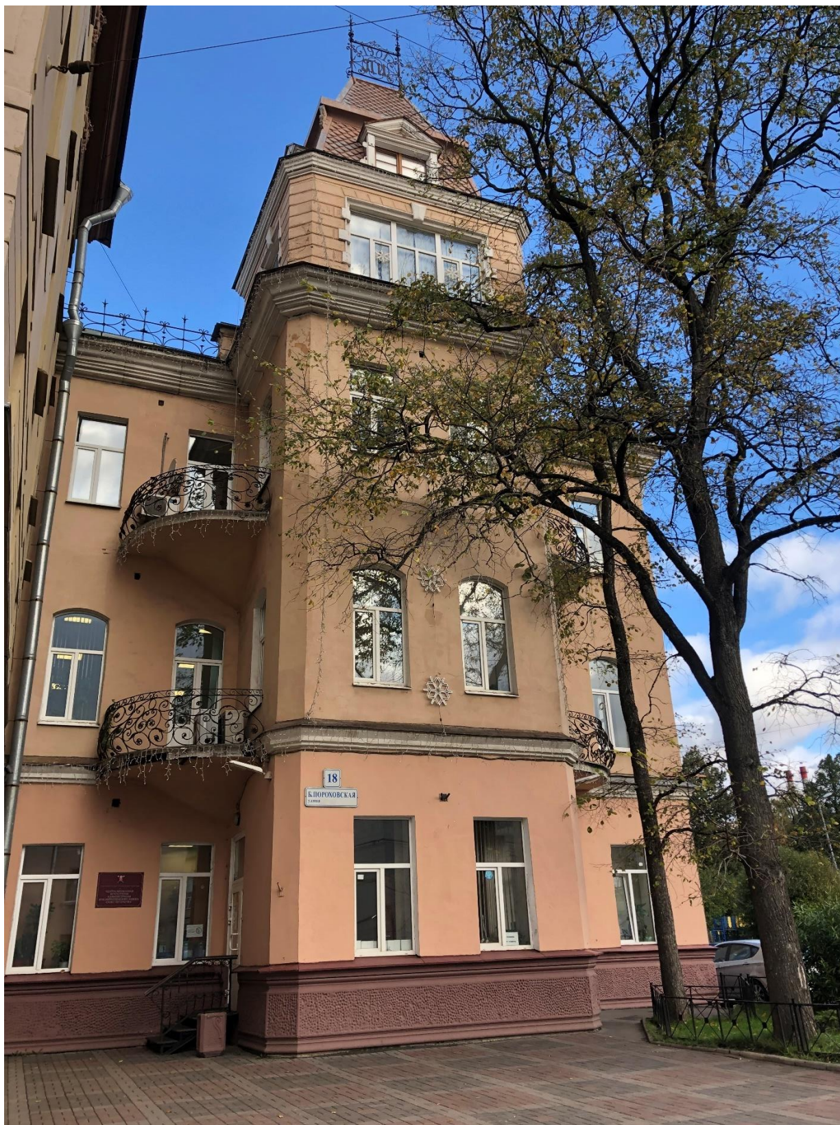
Фото 3. Лицевой фасад (южный) здания.
