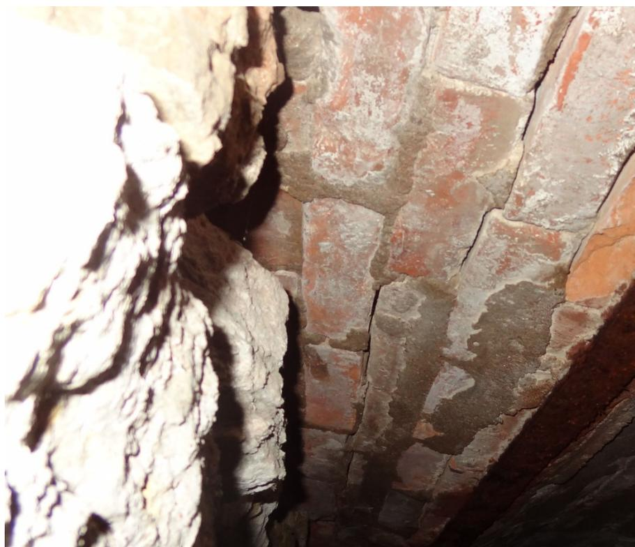
Фото 22. Фрагмент деформированного прусского свода в восточной части подвала.
