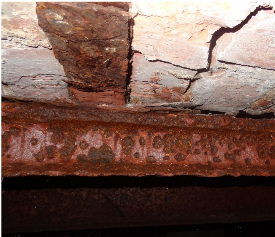
Фото 13. Трещина в сводах. Фрагмент. Дата фотофиксации: 22.09.23
