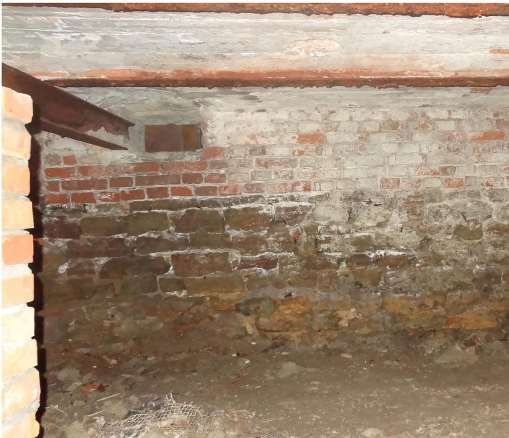
Фото 15. Фрагмент западной стены. Подвальное окно в кирпичной кладке.
