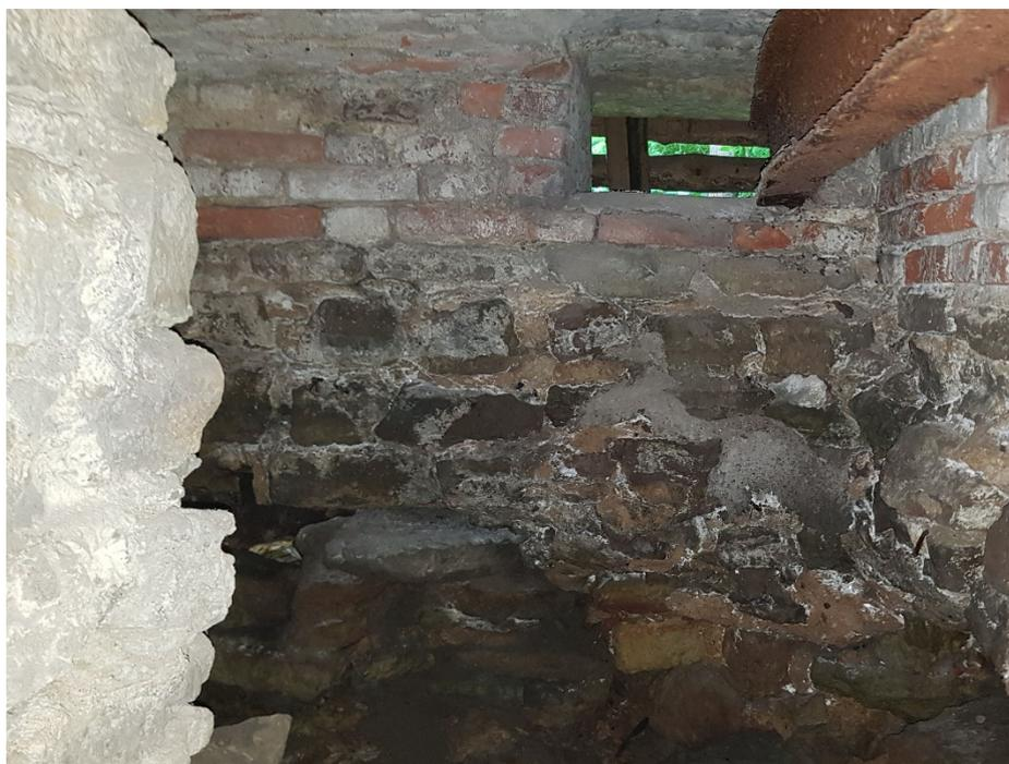
Фото 20. Конструкции фундамента. Подвальное окно в кирпичной кладке. Дата фотофиксации: 22.09.23
