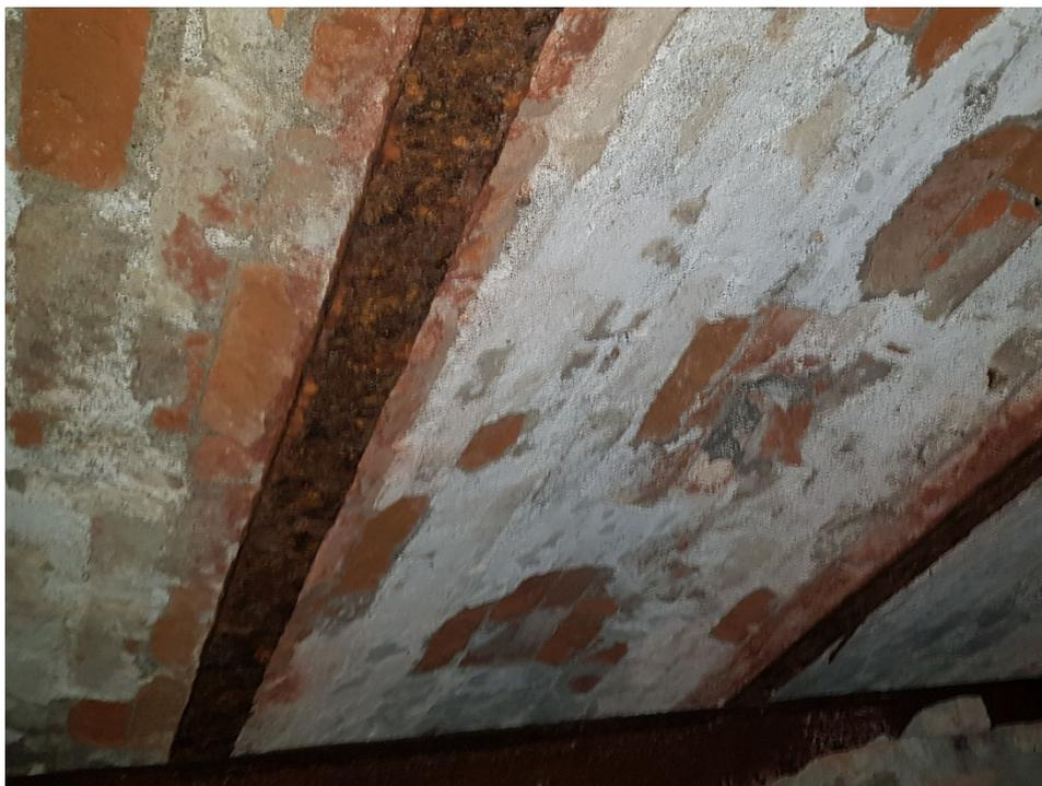
Фото 17. Фрагмент деформированного прусского свода в центральной части подвала.
