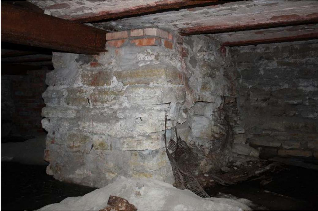
Фото 11. Фрагмент фундамента, служившего основанием для утраченной изразцовой печи.
