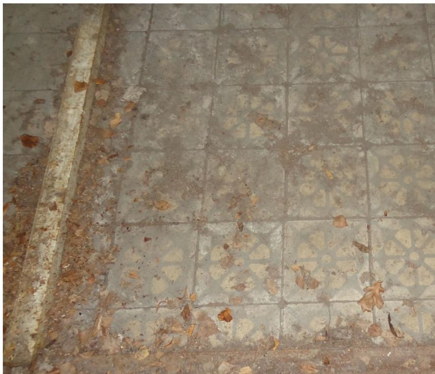
Фото 8. Фрагмент сохранившейся метлахской плитки пола в уровне первого этажа в южной части. Дата фотофиксации: 22.09.23
