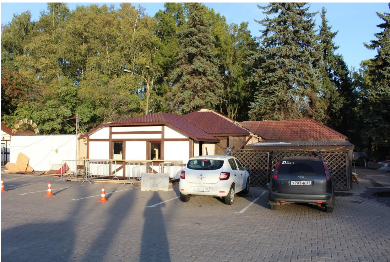
Фото 25. Вид на восточную часть участка объекта культурного наследия регионального значения «Приморский парк Победы» в границах проектирования.
