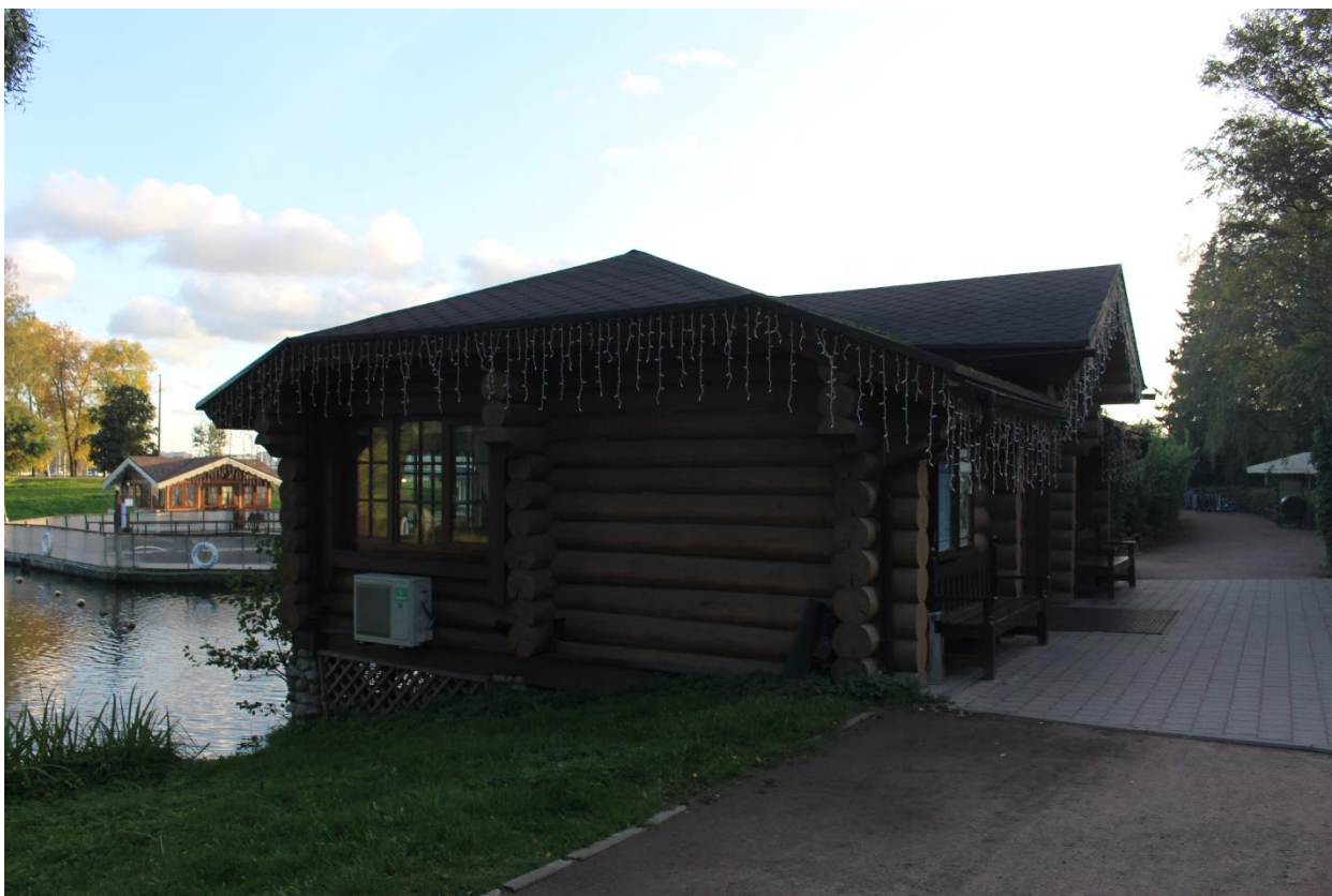
Фото 17. Вид на восточную часть участка объекта культурного наследия регионального значения «Приморский парк Победы» в границах проектирования.
