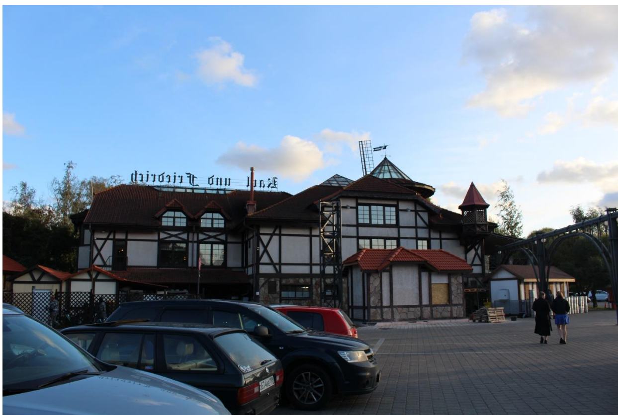
Фото 23. Вид на центральную часть участка объекта культурного наследия регионального значения «Приморский парк Победы» в границах проектирования.
