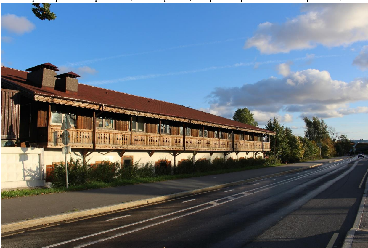
Фото 2. Вид на участок объекта культурного наследия регионального значения «Приморский парк Победы» в границах проектирования с северо-запада.
