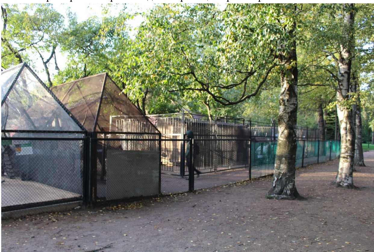
Фото 20. Вид на восточную часть участка объекта культурного наследия регионального значения «Приморский парк Победы» в границах проектирования.
