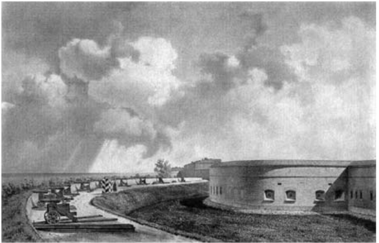
Илл. 10. Укрепление северной стороны. Акварель XIX в. // Раздолгин А. А., Скориков Ю. А. Кронштадтская крепость. — Стройиздат, Ленинградское отделение, 1988
