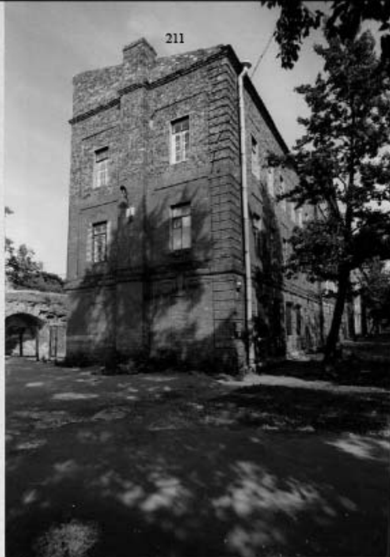
Российская Федерация Санкт – Петербург, Кронштадтский район г. Кронштадт Крепость Кронштадт. Козырек. 1710-1724 гг., 1761-1764 гг., 1825-1840 гг., 1872- 1873 гг., 1903-1906 гг., 1930е г., 1979-1981 гг. Северный фронт. За северной оборонительной казармой. 1837-1839 гг., 1950е г. Фрагмент заднего фасада. Вид с юго-запада. Натурал съёмка. июль-август 2000 г. Фото В.П. Орлова.
