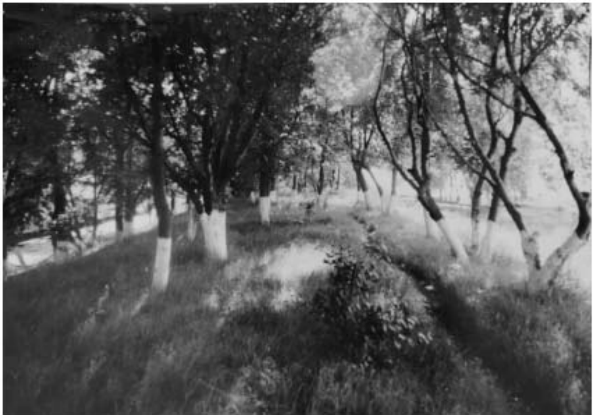
Илл. 22. Фрагмент плотины у 4-й северной казармы. Вид с запада. Фото июнь-август 2002 г. Фото В.П. Орлова. // Паспорт памятника истории и культуры «Оборонительные сооружения. Крепость Кронштадт». Сост. В.П. Орлов. СПб. –Кронштадт, 2002. Архив КГИОП № 615-V-1108п.
