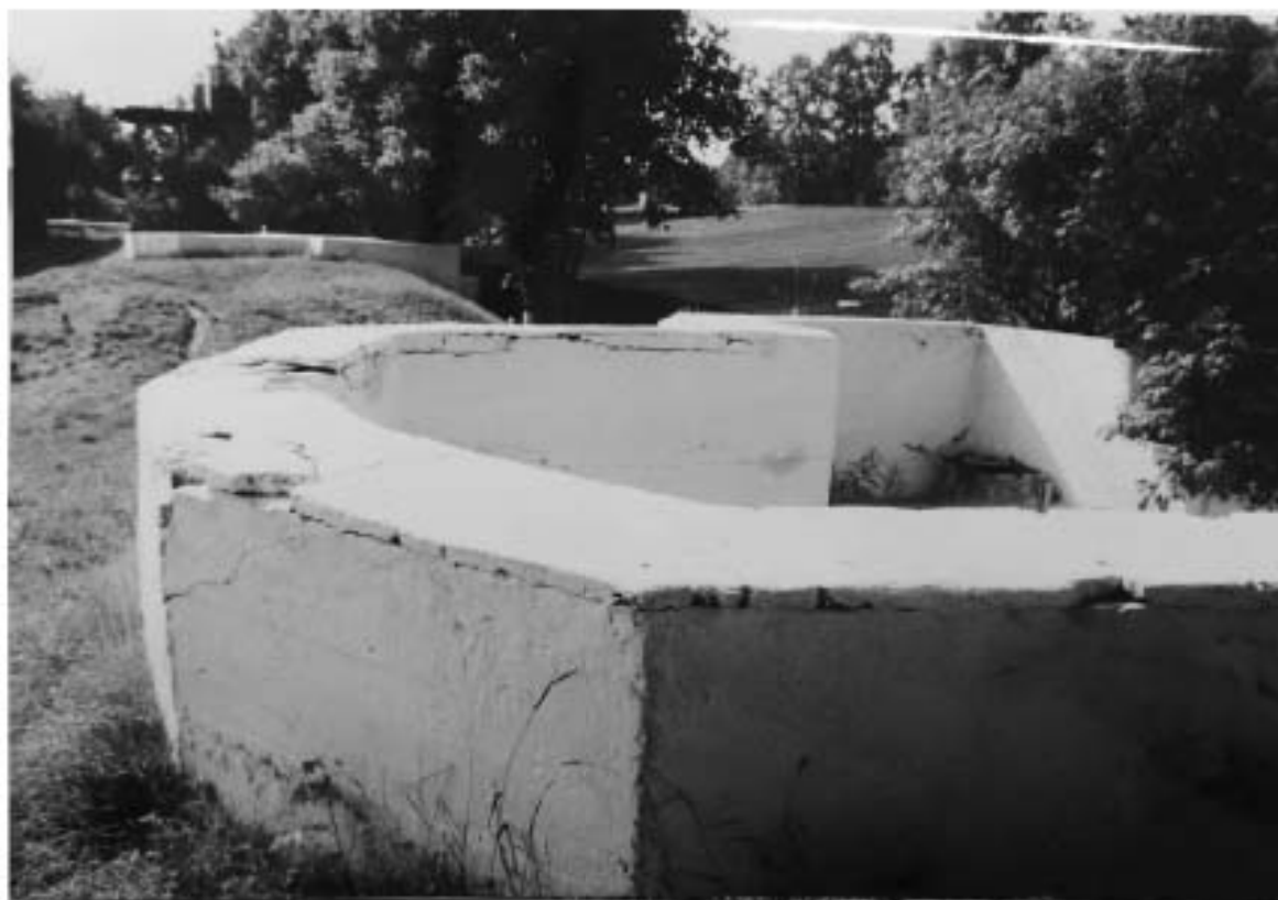
Илл. 23. Фрагмент плотины у 4-й северной казармы. Открытые бетонные дворники. Вид с запада. Фото июль-август 2002 г. Фото В.П. Орлова. // Паспорт памятника истории и культуры «Оборонительные сооружения. Крепость Кронштадт». Сост. В.П. Орлов. СПб. –Кронштадт, 2002. Архив КГИОП № 615-V-1108п.
