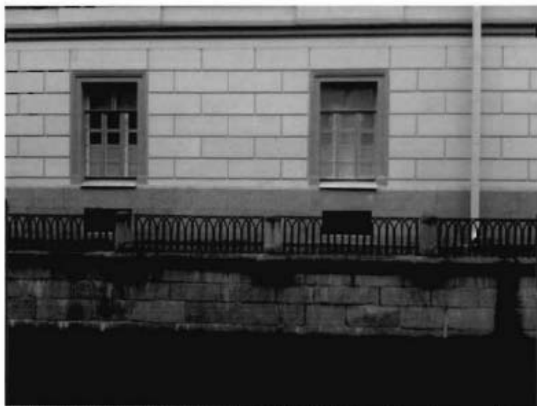
6. Стенка набережной, перильное ограждение, металлический кованый рым
