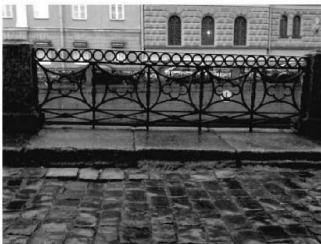
8. Перильное ограждение на участке набережной от Зимнего моста до р. Мойки. Гранитные тротуарные плиты
