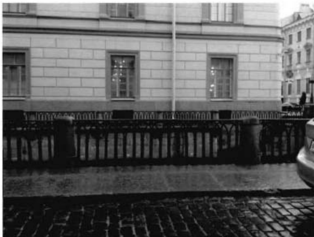
7. Перильное ограждение на участке набережной от Эрмитажного моста до Зимнего моста. Гранитные тротуарные плиты
