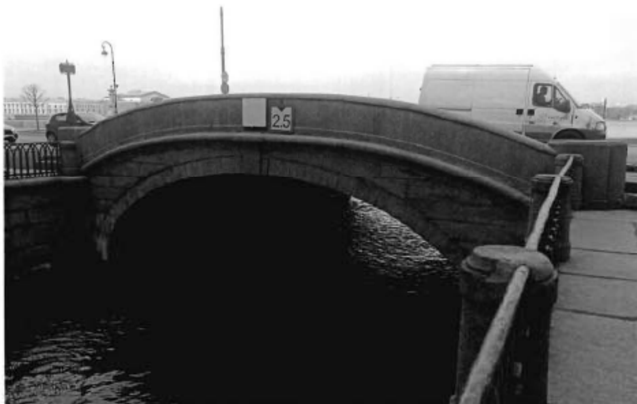
1. Вид на объект культурного наследия с юго-восточной стороны. Низовой фасад.
