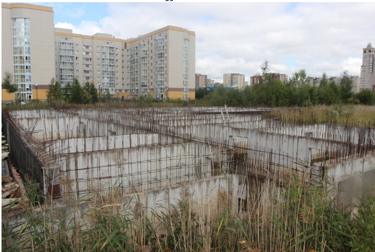
Рис. 21. СПб-2023. Загребский б. КН: 78:13:0744702:1607. Точка фотофиксации 3, вид на север.
