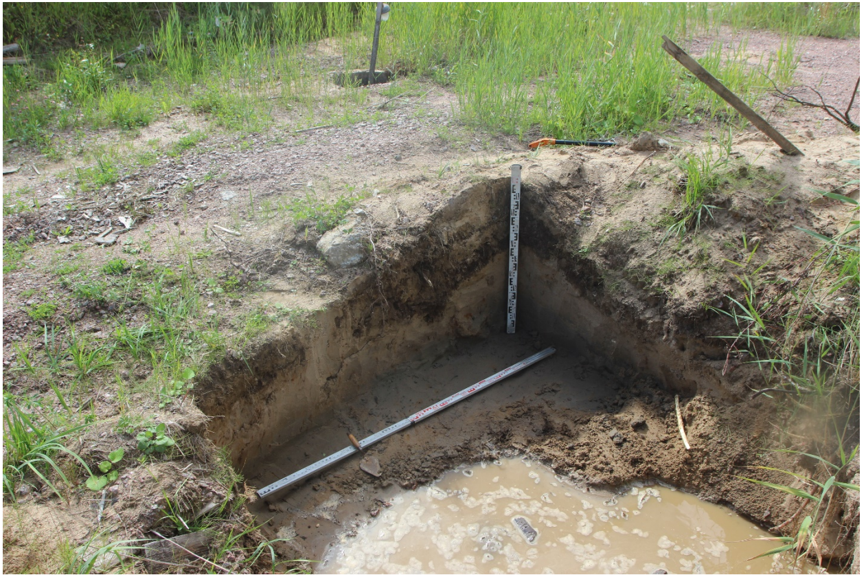
Рис. 29. СПБ-2023. Загребский б. КН: 78:13:0744702:1607. Шурф 1. Фиксация по уровню окончания работ, вид на юго-запад, южная и западная стенки.
