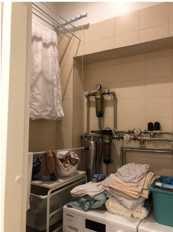
Фото 26. Вид на помещение № 12.
