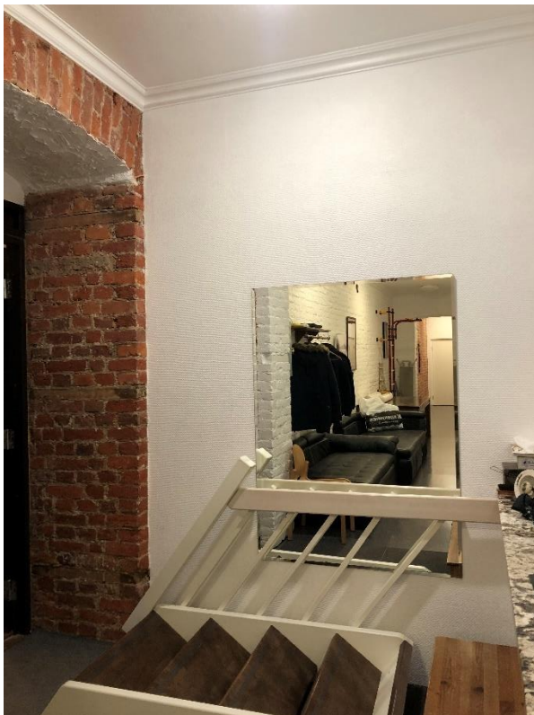
Фото 3. Вид на перегородку между квартирами №№ 6 и 7.
