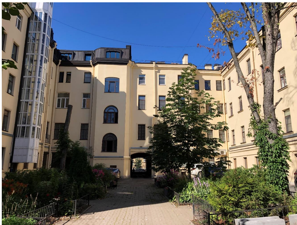
Фото 6. Вид на северный дворовый фасад.
