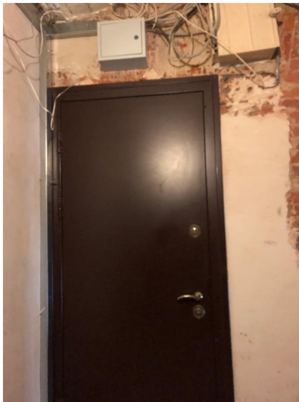
Фото 2. Вид на входную квартиру № 6 с черной лестницы.
