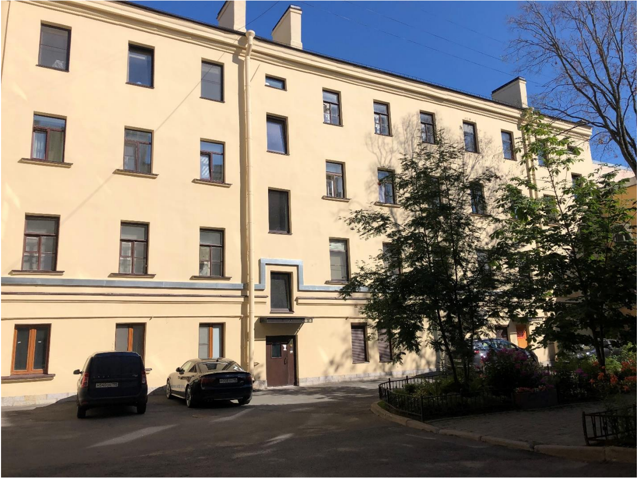
Фото 7. Вид на восточный дворовый фасад.
