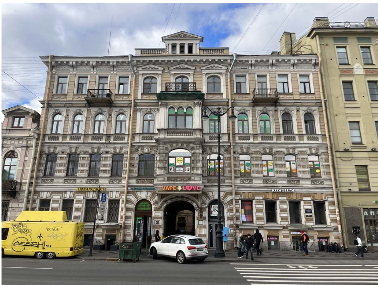
Фото №1. Лицевой восточный фасад.
