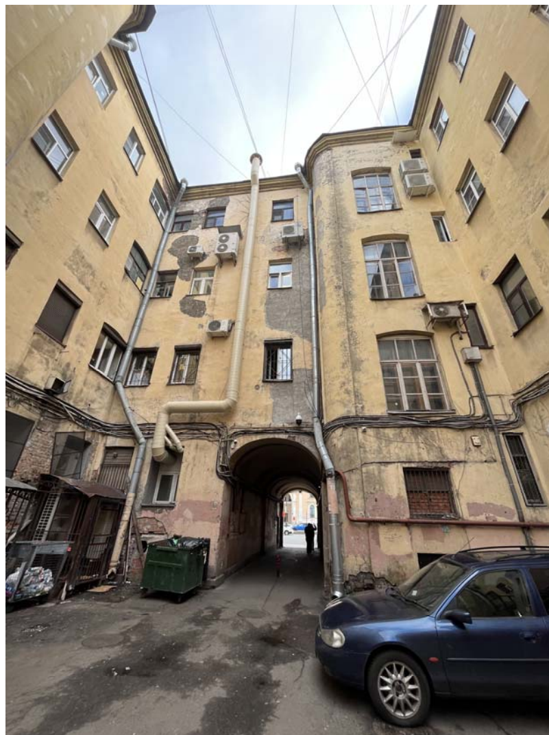
Фото №3. Дворовый западный фасад, общий вид.
