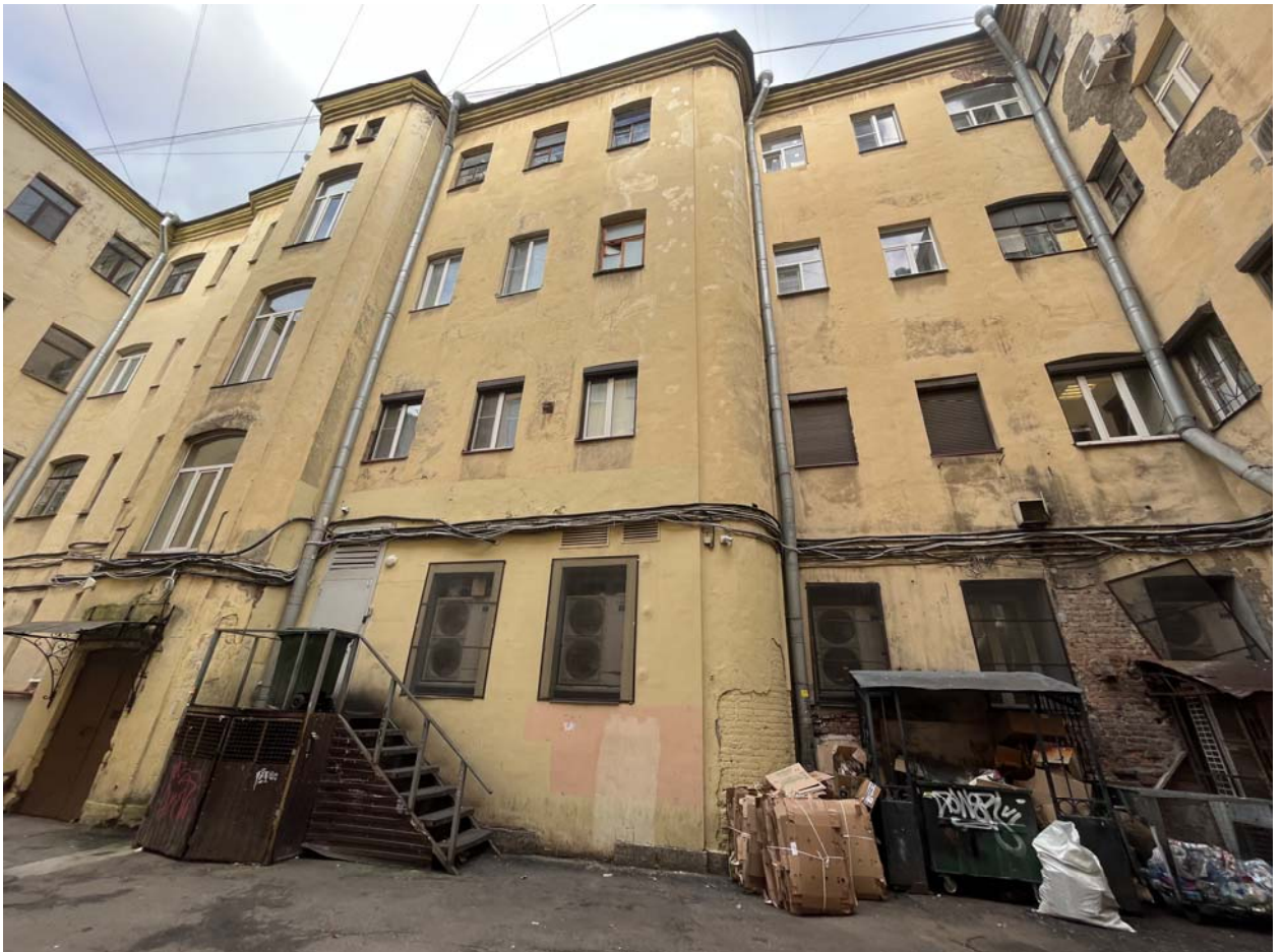
Фото №4. Дворовый южный фасад, общий вид.
