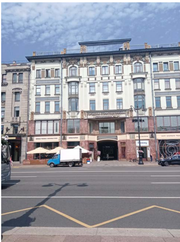
Фото 1. Лицевой фасад объекта культурного наследия регионального значения «Дом Московского купеческого банка»
