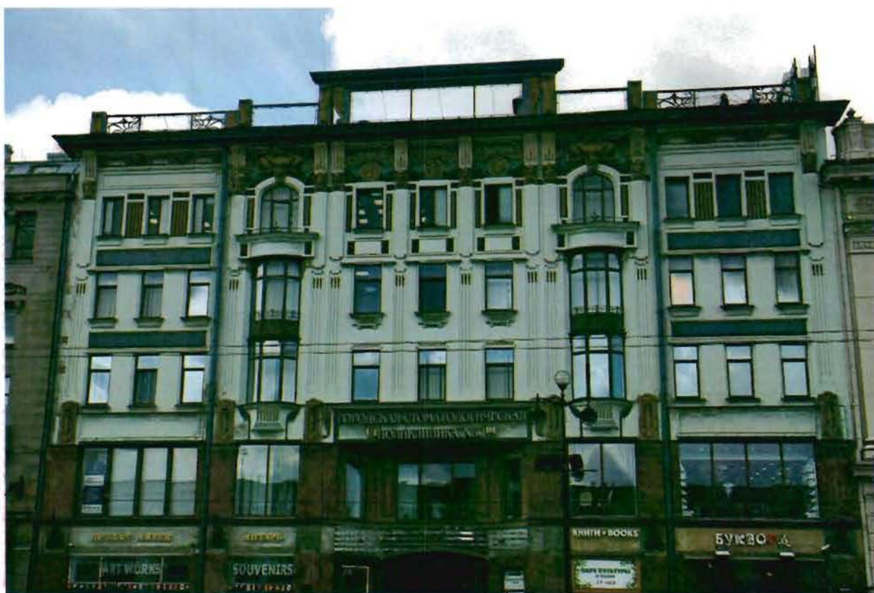
1. Лицевой фасад. Общий вид.
