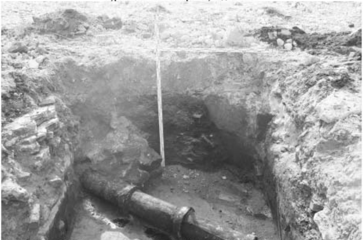
Рис. 61. СПб-2023. Кожевенная л., д. 39, к. 5 (КН78:06:0002114:21). Шурф 1-2, фиксация по уровню окончания работ, южная стенка.
