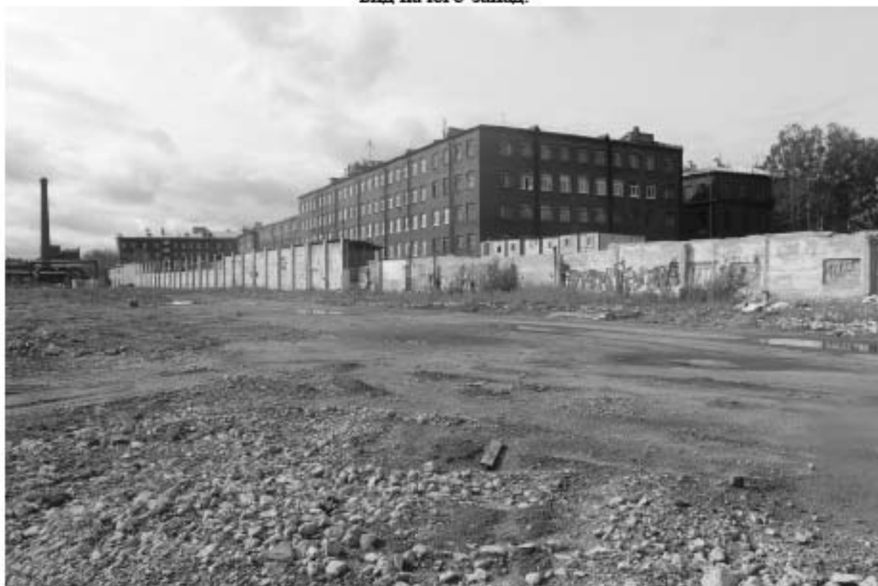
Рис. 29. СПб-2023. Кожевенная л., д. 39, к. 5 (КН78:06:0002114:21). Точка фотофиксации 2, вид на запад.
