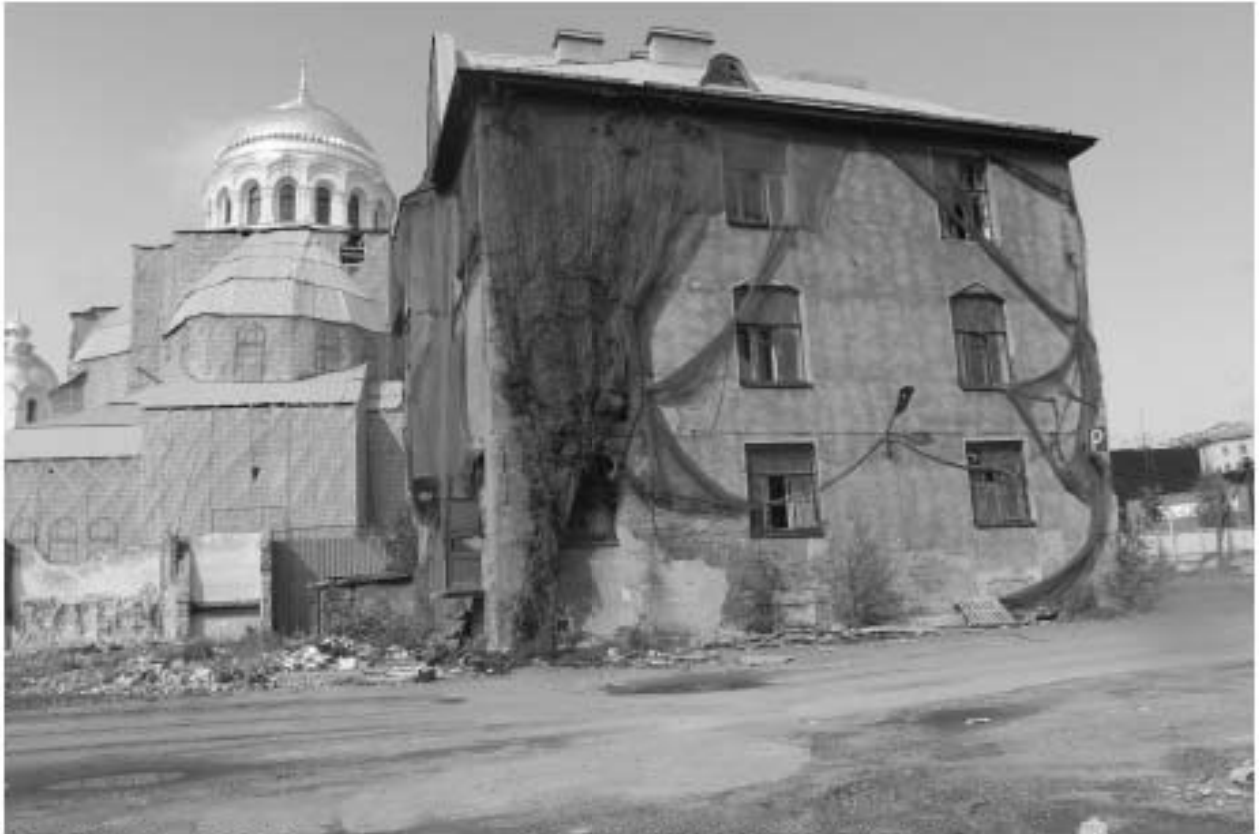
Рис. 30. СПб-2023. Кожевенная л., д. 39, к. 5 (КН78:06:0002114:21). Точка фотофиксации 2, вид на северо-запад.
