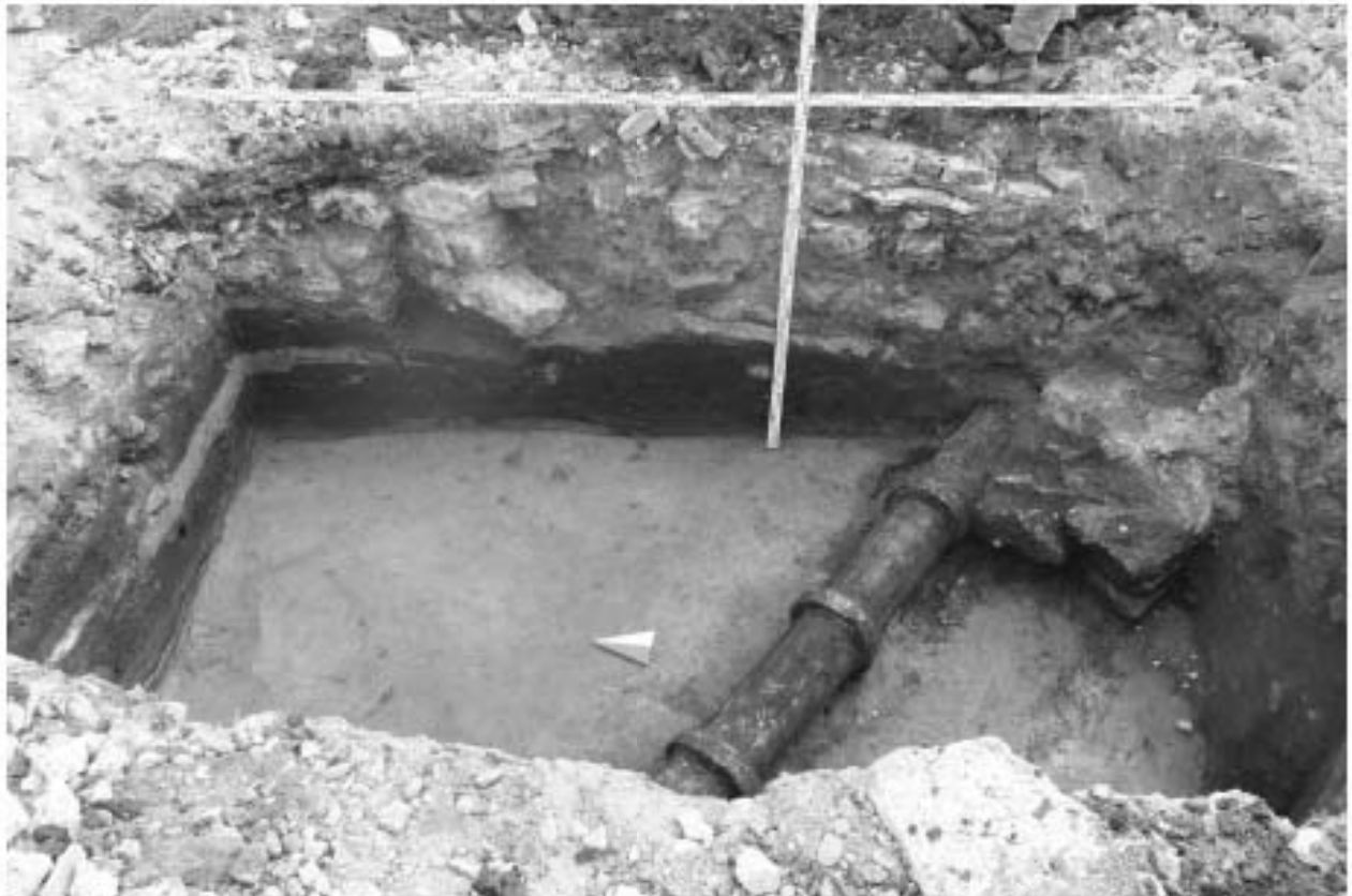
Рис. 54. СПб-2023. Кожевенная л., д. 39, к. 5 (КН78:06:0002114:21). Шурф 1-2, фиксация по уровню окончания работ, вид на восток.
