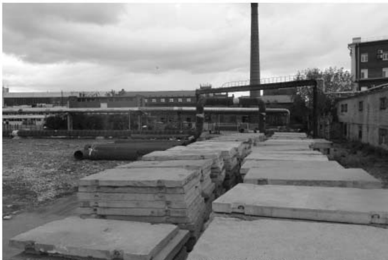
Рис. 46. СПб-2023. Кожевенная л., д. 39, к. 5 (КН78:06:0002114:21). Точка фотофиксации 6, вид на юго-запад.
