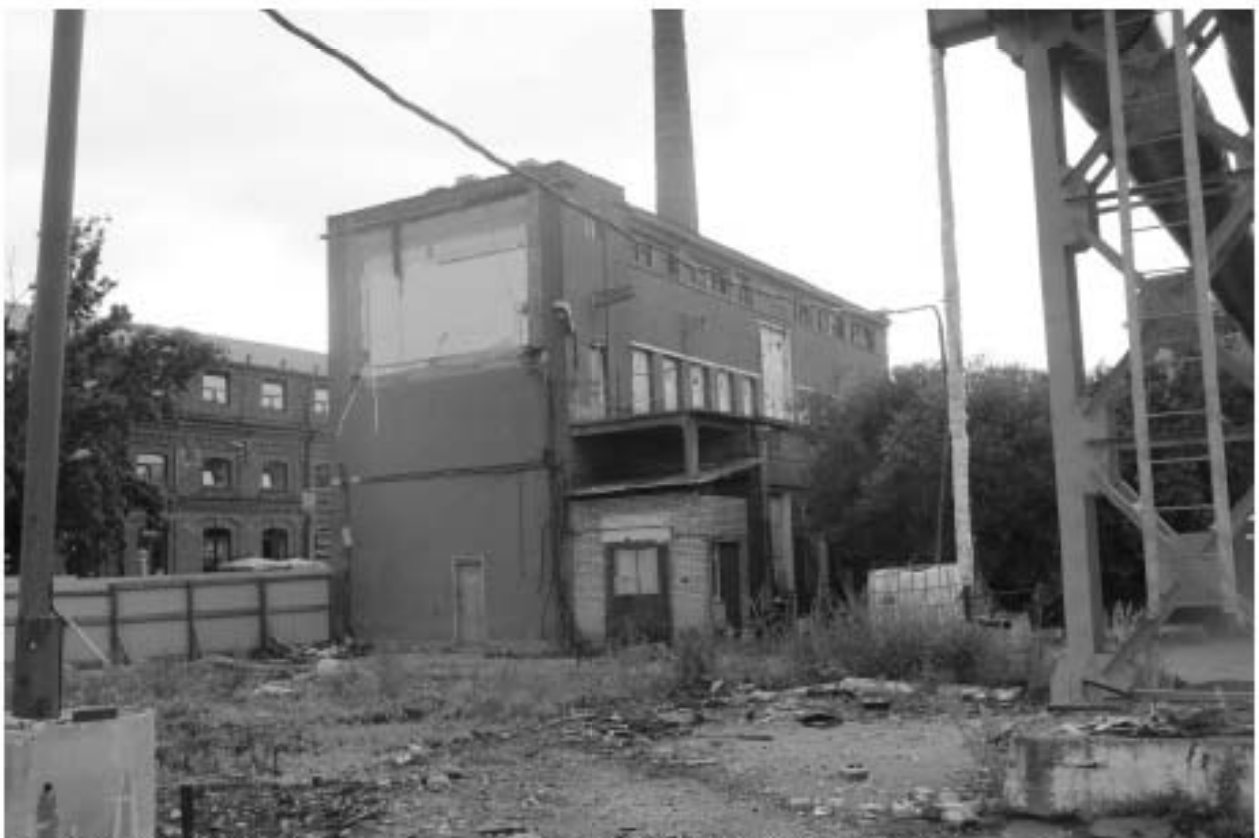
Рис. 39. СПб-2023. Кожевенная л., д. 39, к. 5 (КН78:06:0002114:21). Точка фотофиксации 5, вид на запад.
