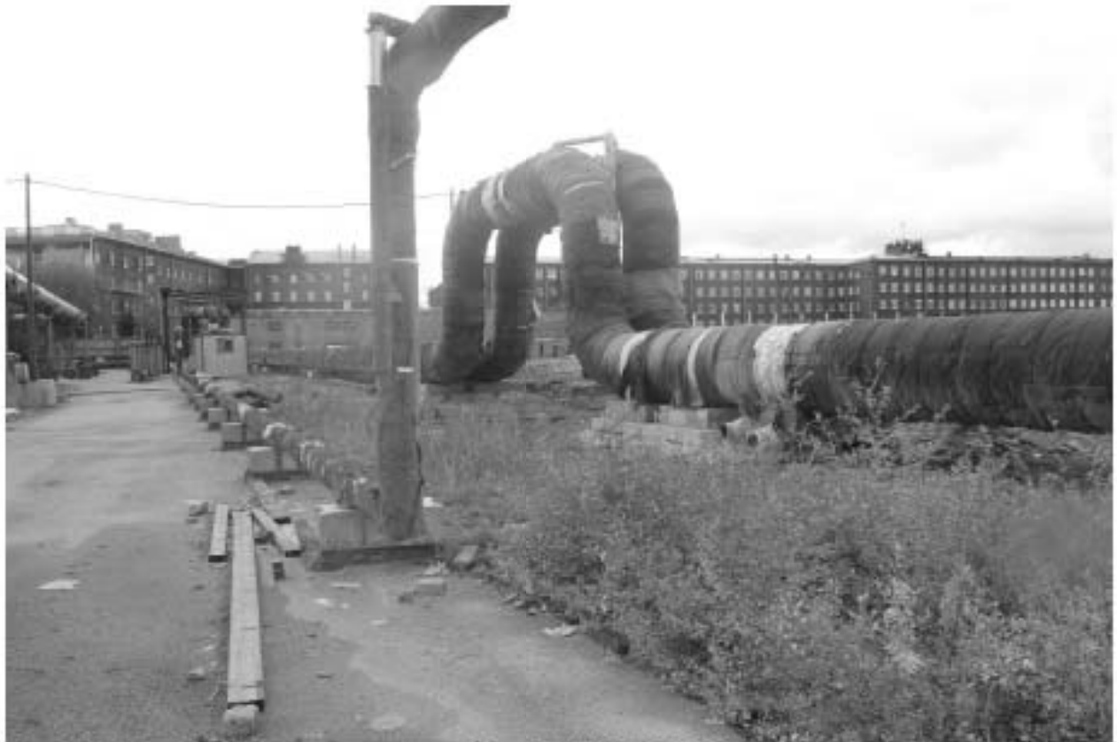
Рис. 40. СПб-2023. Кожевенная л., д. 39, к. 5 (КН78:06:0002114:21). Точка фотофиксации 5, вид на северо-запад.
