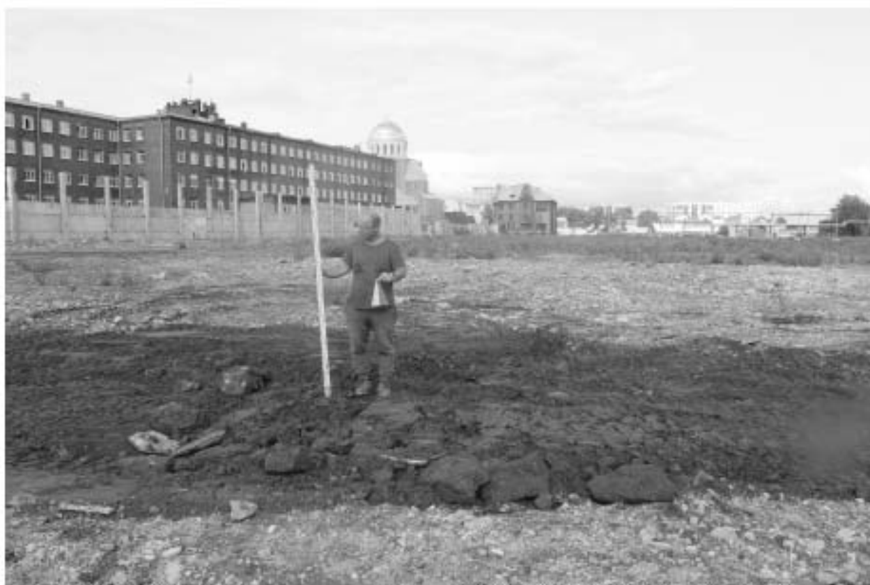
Рис. 116. СПб-2023. Кожевенная л., д. 39, к. 5 (КН78:06:0002114:21). Шурф 9-10 после рекультивации, вид на север.
