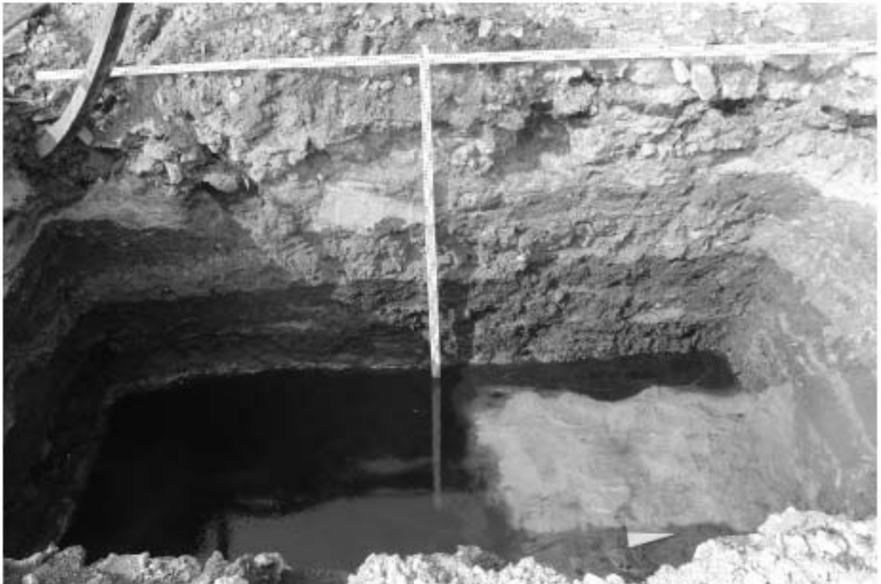
Рис. 74. СПб-2023. Кожевенная л., д. 39, к. 5 (КН78:06:0002114:21). Шурф 3-4, фиксация по уровню окончания работ, вид на запад.
