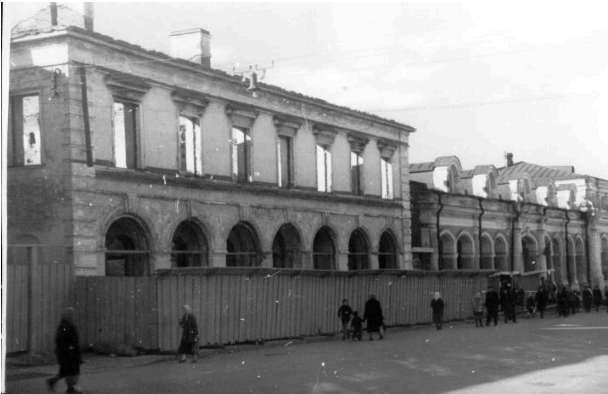
27. Разрушенный дом № 20 по улице Коминтерна (Оранжерейной). Фото: Лаптев Сергей Дмитриевич. 1946–1948 гг. // Источник: ЦГАКФФД СПб. Фотодокумент Ар 202524.
