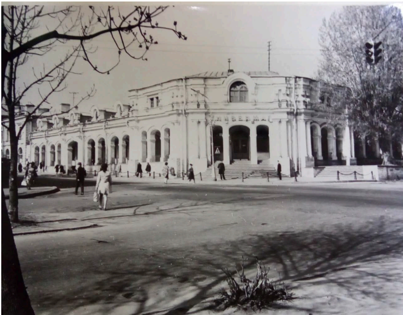
29. Фасад по ул. Коминтерна и Московской. 1977 г. // Источник: Архив КГИОП, Инв. № П-226-Г-3; К№ Н-1991.
