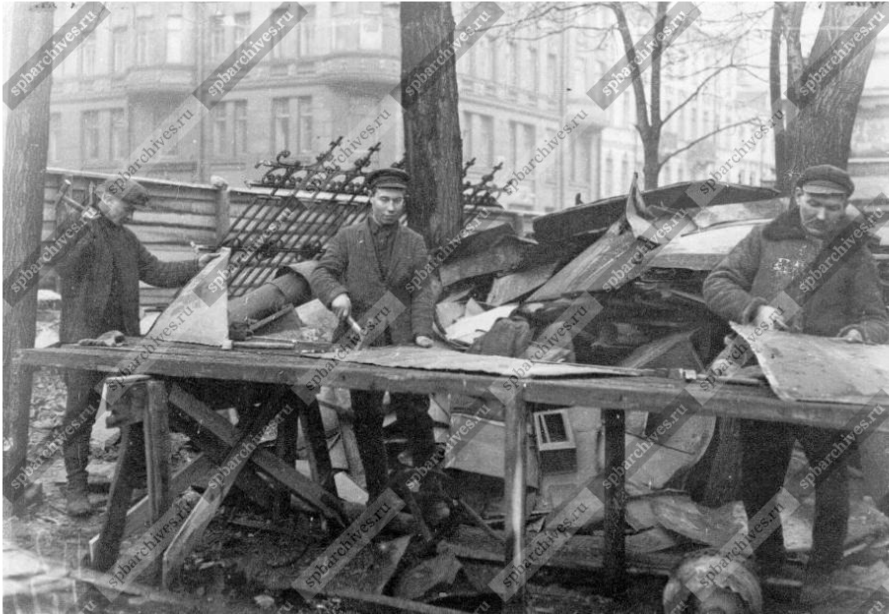
97. Выпрямление кровельного железа, снятого с разрушенной церкви Покрова Пресвятой Богородицы на площади Тургенева. 1934 г. // Источник: ЦГАКФД СПб Бр 7804.
