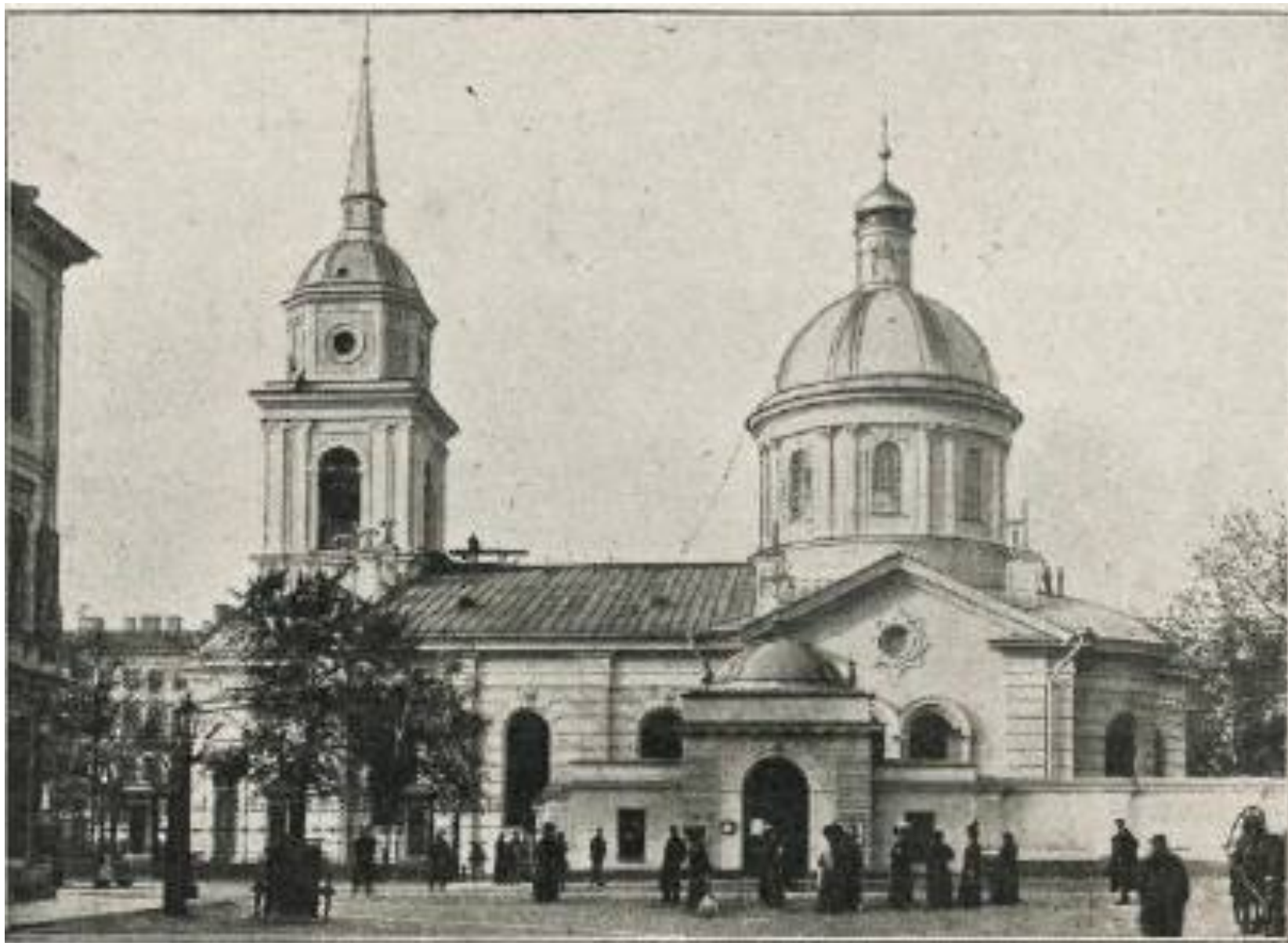
72. Покровская церковь. 1912 г. // Источник: Citywalls. Церковь Покрова Пресвятой Богородицы в Большой Коломне. URL: https://p3.citywalls.ru/photo_370-379779.jpg?mt=1548618219 (дата обращения: 16.10.2023).
