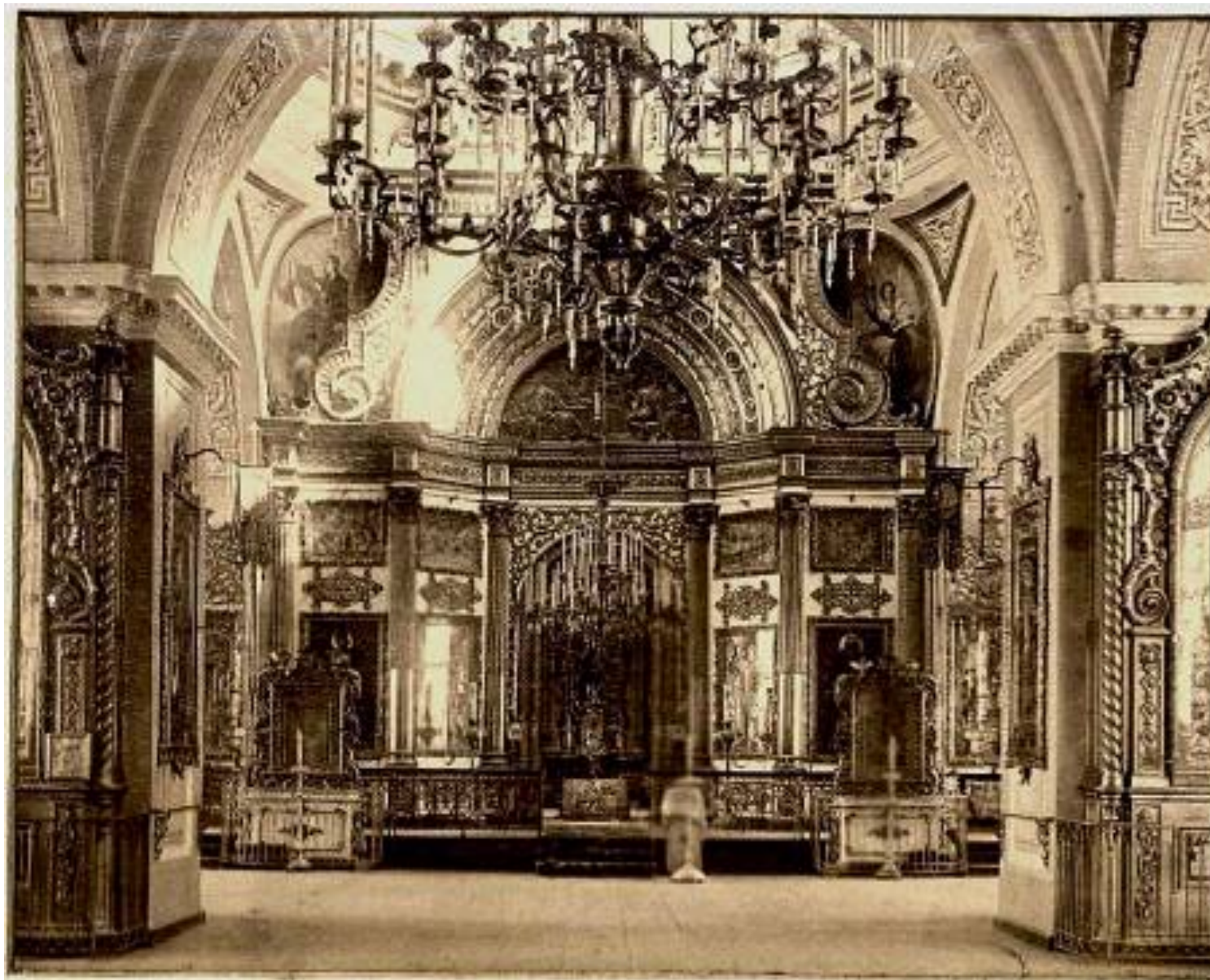
76. Покровская церковь. Внутренний вид. Нач. XX в. // Источник: Citywalls. Церковь Покрова Пресвятой Богородицы в Большой Коломне. URL: https://p0.citywalls.ru/photo_611-626248.jpg?mt=1682422364 (дата обращения: 16.10.2023).
