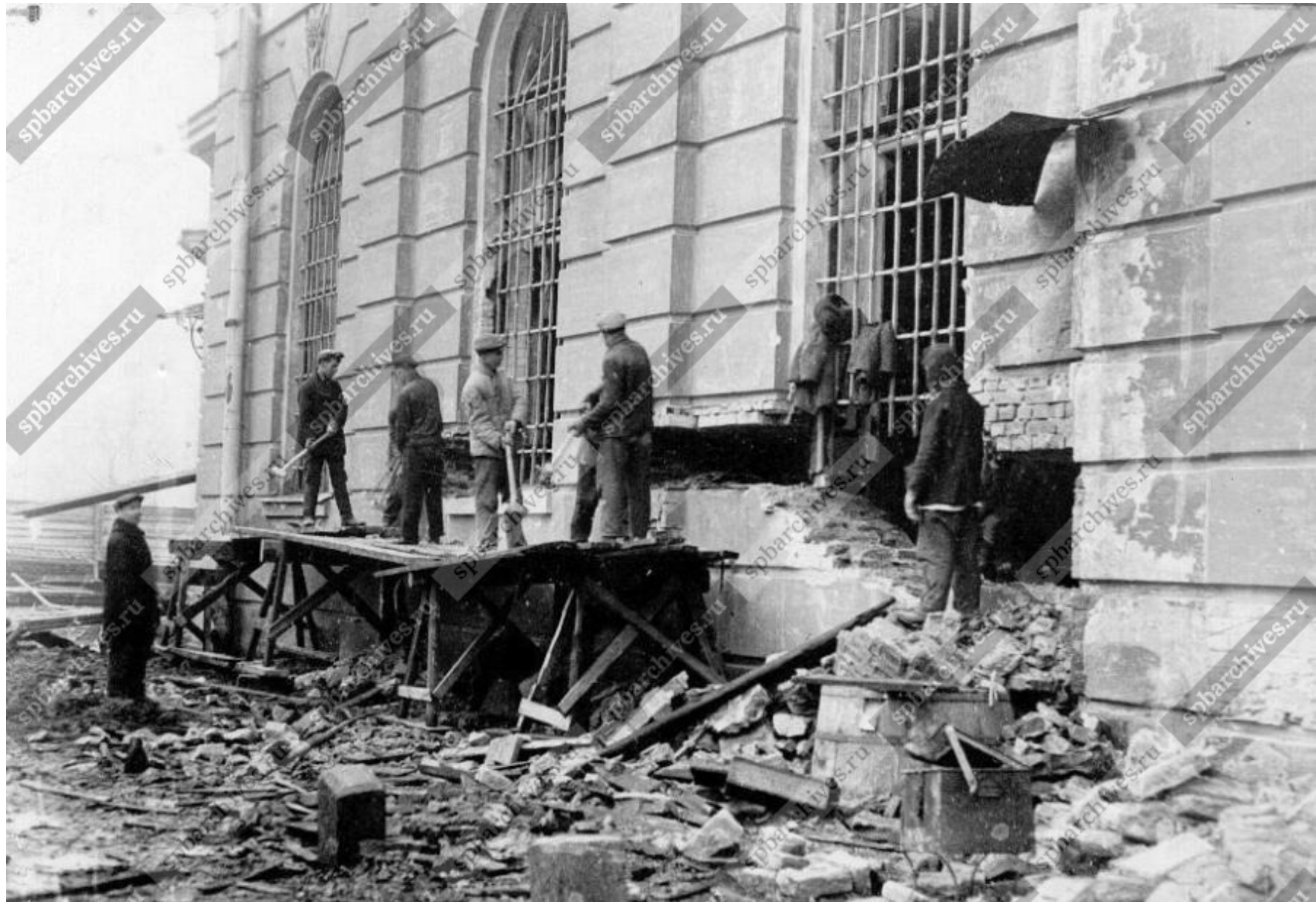
96. Работы по разборке разрушенной церкви Покрова Пресвятой Богородицы на площади Тургенева. 1934 г. // Источник: ЦГАКФФД СПб Бр 7803.
