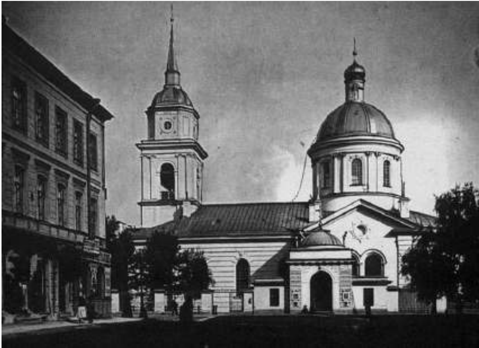
57. Покровская церковь. Вид от Прядильной (совр. Лабутина) ул. Фото Н.Г. Матвеева. 1900-е гг. // Источник: Citywalls. Церковь Покрова Пресвятой Богородицы в Большой Коломне. URL: https://p1.citywalls.ru/photo_294-302069.jpg?mt=1507998996 (дата обращения: 16.10.2023).
