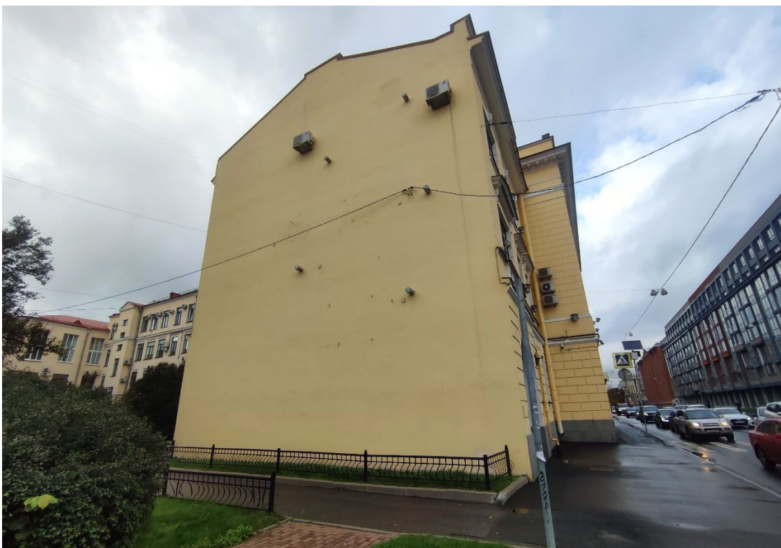
3. Выявленный объект культурного наследия «Здание института», расположенный по адресу: г. Санкт-Петербург, Большой Сампсониевский проспект, дом 86, литера А, в составе выявленного объекта культурного наследия «Санкт-Петербургский учительский институт им. императора Александра II». Общий вид южного торцевого фасада лицевого корпуса.
