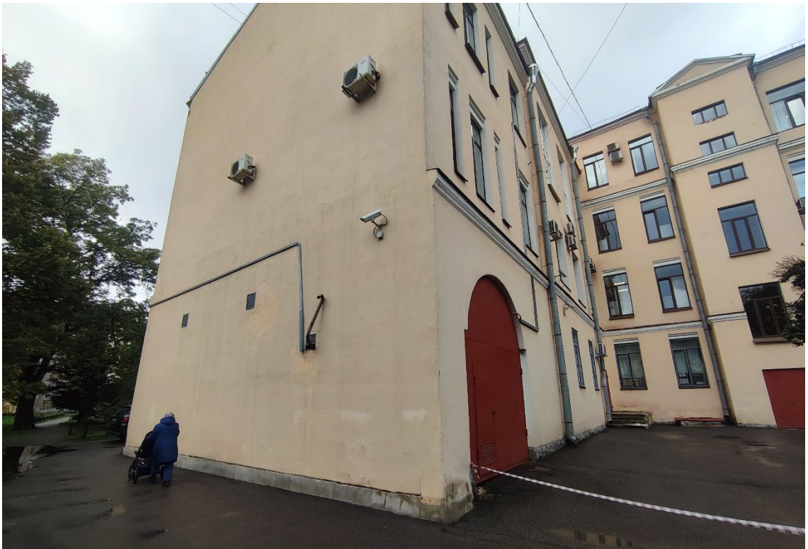
8. Выявленный объект культурного наследия «Здание института», расположенный по адресу: г. Санкт-Петербург, Большой Сампсониевский проспект, дом 86, литера А, в составе выявленного объекта культурного наследия «Санкт-Петербургский учительский институт им. императора Александра II». Общий вид южного торцевого фасада трехэтажного дворового корпуса.
