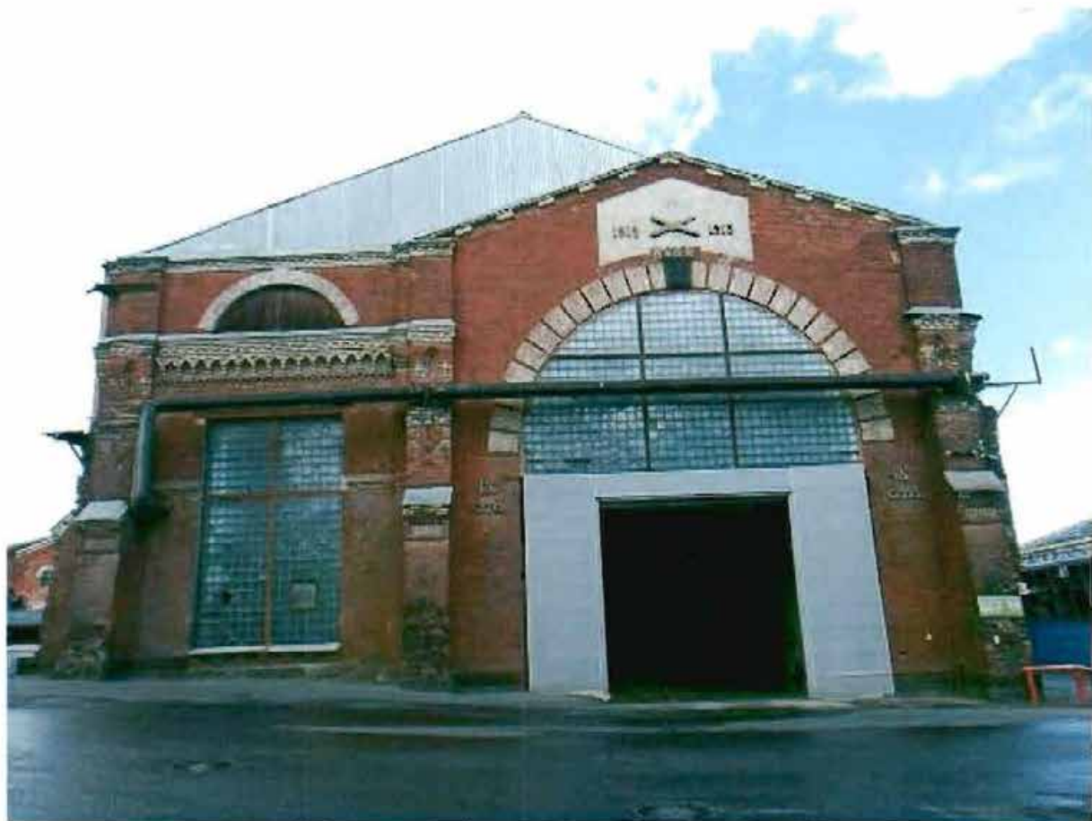
8. Восточный фасад. Строение 5 (литера АЕ).
