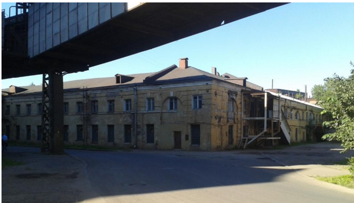
Ф.3. . Общий вид на юго-западный и юго-восточный фасады объекта культурного наследия регионального значения «Казармы Александровской инвалидной команды (Казармы для инвалидов и мастеров или 2-й квадратный корпус Александровской мануфактуры, Тигельная Обуховского сталелитейного завода)» (в составе «Императорская Александровская мануфактура (Обуховский сталелитейный завод)») по адресу: Санкт-Петербург, проспект Обуховской Обороны, дом 120, литера АВ.)
