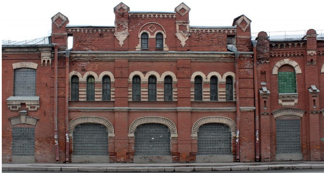
Ф.8. Фрагмент западного фасада объекта культурного наследия регионального значения «Пушечная мастерская Обуховского сталелитейного завода» (в составе «Императорская Александровская мануфактура (Обуховский сталелитейный завод)») по адресу: Санкт-Петербург, проспект Обуховской Обороны, дом 120, литера АЕ, АМ, О
