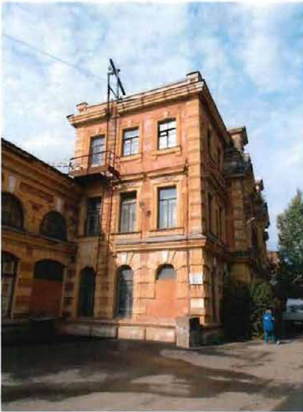
2. Восточный фасад объекта культурного наследия.
