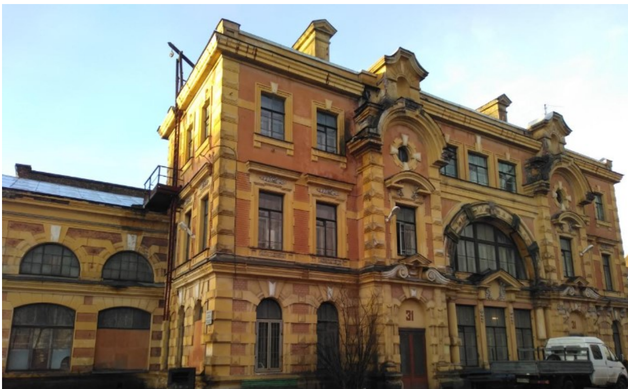
Ф. 12. Вид на северный фасад объекта культурного наследия регионального значения «Главная электрическая станция Обуховского сталелитейного завода» (в составе «Императорская Александровская мануфактура (Обуховский сталелитейный завод)») по адресу: Санкт-Петербург, проспект Обуховской Обороны, дом 120, литера Щ,
