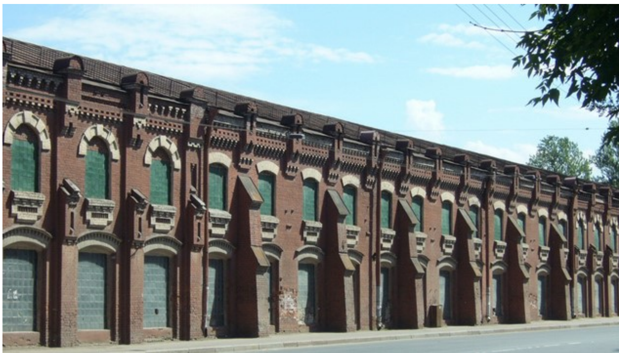
Ф.6. Вид на западный фасад объекта культурного наследия регионального значения «Пушечная мастерская Обуховского сталелитейного завода» (в составе «Императорская Александровская мануфактура (Обуховский сталелитейный завод)») по адресу: Санкт-Петербург, проспект Обуховской Обороны, дом 120, литера АЕ, АМ, О.
