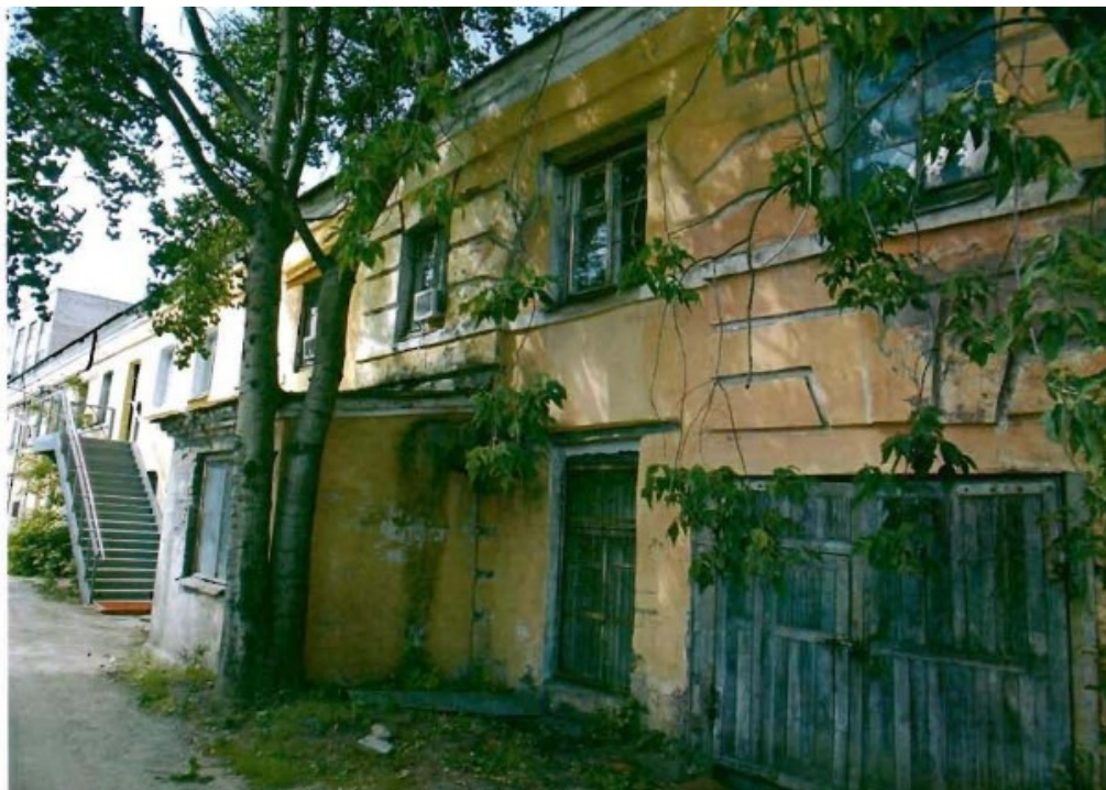
Ф.4. Фрагмент юго-восточного фасада объекта культурного наследия регионального значения «Казармы Александровской инвалидной команды (Казармы для инвалидов и мастеров или 2-й квадратный корпус Александровской мануфактуры, Тигельная Обуховского сталелитейного завода)» (в составе «Императорская Александровская мануфактура (Обуховский сталелитейный завод)») по адресу: Санкт-Петербург, проспект Обуховской Обороны, дом 120, литера АВ.
