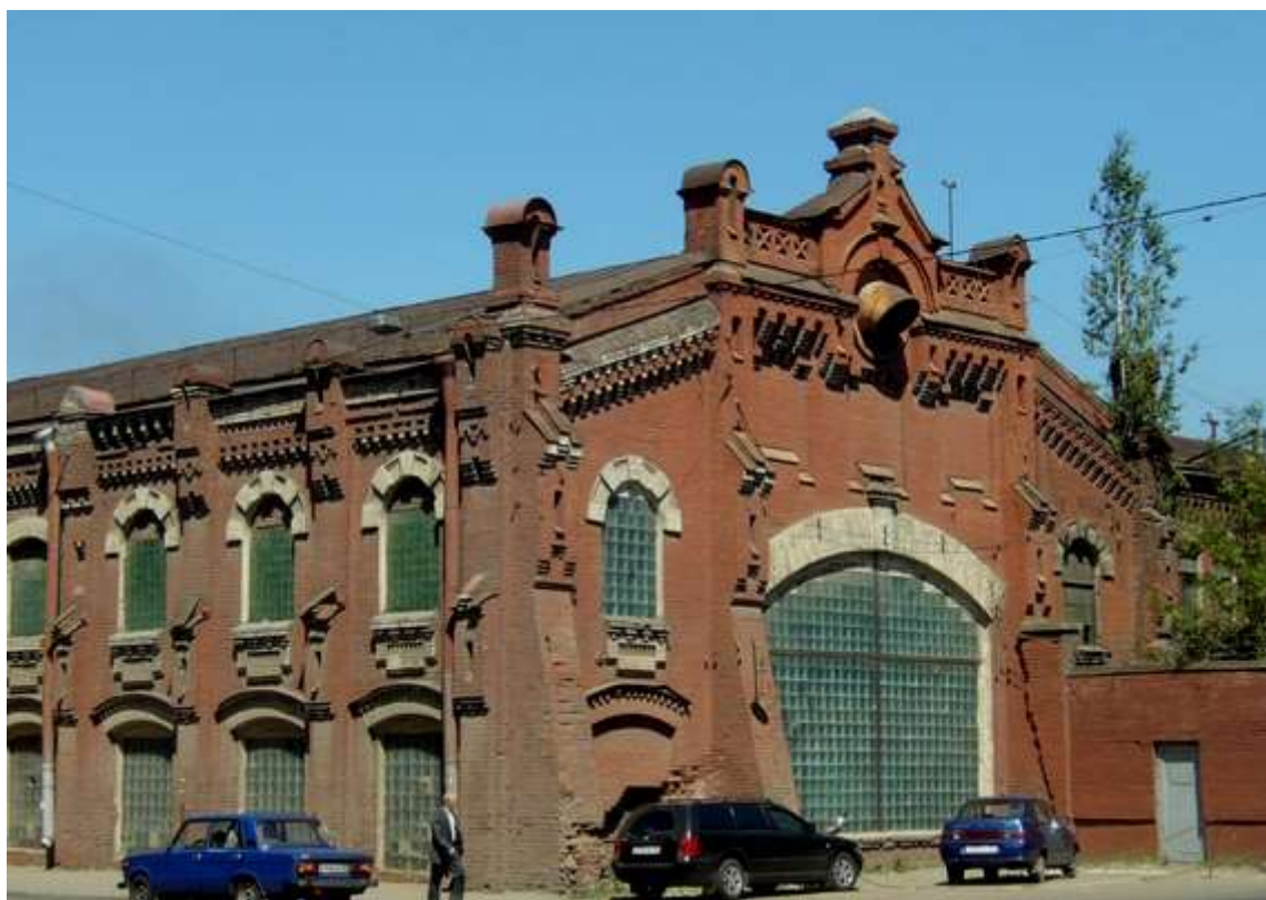
Ф.7. Вид на западный и южный фасады объекта культурного наследия регионального значения «Пушечная мастерская Обуховского сталелитейного завода» (в составе «Императорская Александровская мануфактура (Обуховский сталелитейный завод)») по адресу: Санкт-Петербург, проспект Обуховской Обороны, дом 120, литера АЕ, АМ, О
