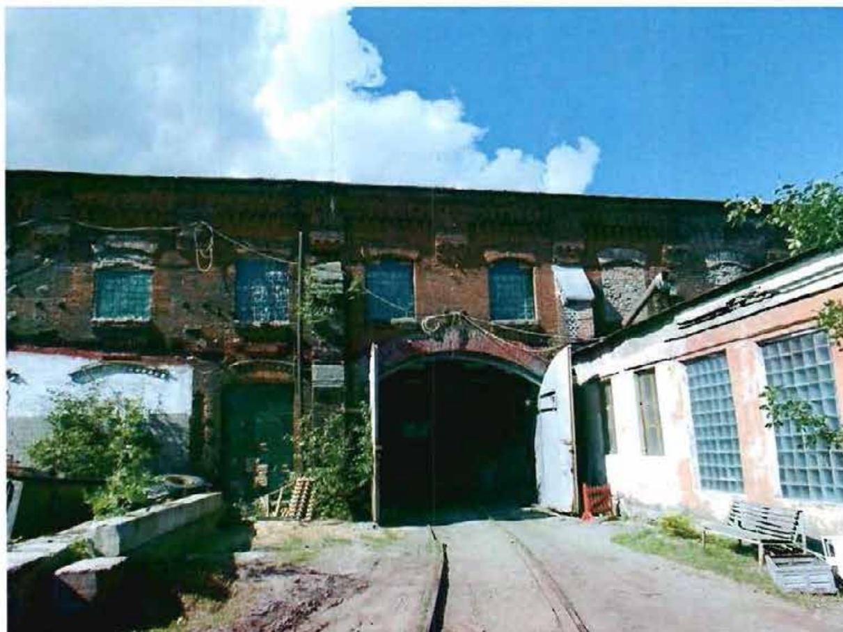
15. Восточный фасад. Литера О.
