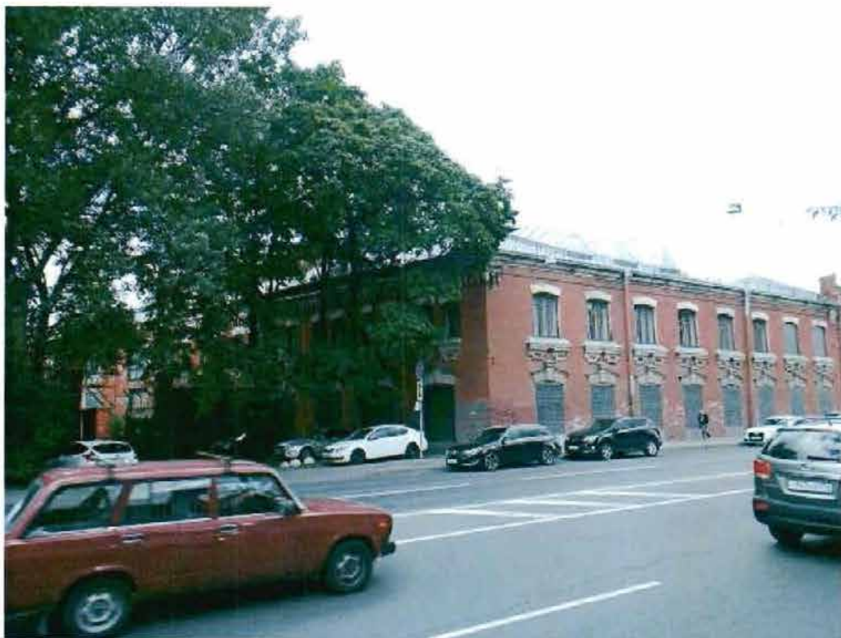
2. Южный и западный фасады. Литера АМ.
