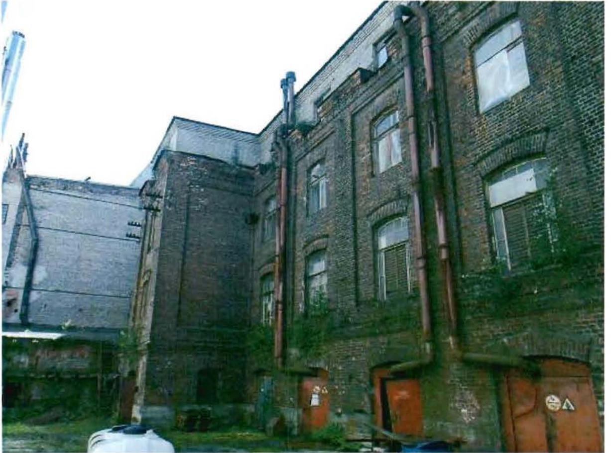
4. Северный фасад. Литера АМ.
