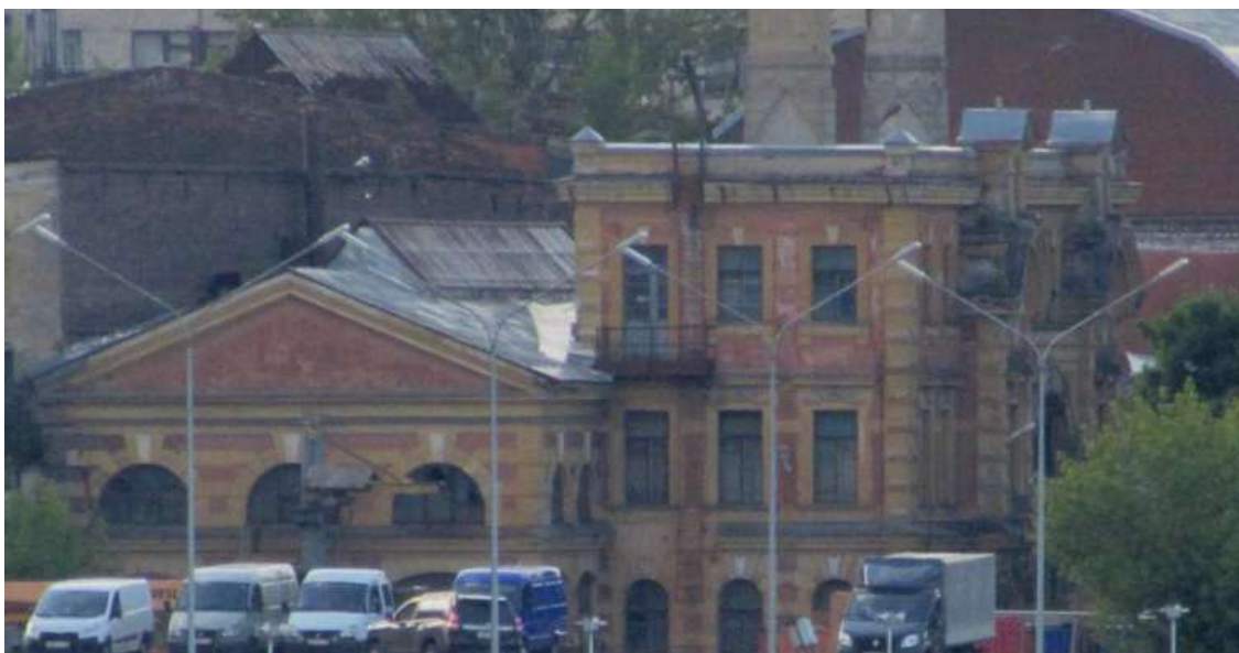
Ф.10 Вид на восточный фасад объекта культурного наследия регионального значения «Главная электрическая станция Обуховского сталелитейного завода» (в составе «Императорская Александровская мануфактура (Обуховский сталелитейный завод)») по адресу: Санкт-Петербург, проспект Обуховской Обороны, дом 120, литера Щ.
