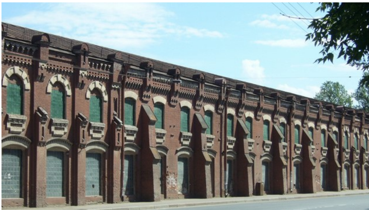
Ф.6. Вид на западный фасад объекта культурного наследия регионального значения «Пушечная мастерская Обуховского сталелитейного завода» (в составе «Императорская Александровская мануфактура (Обуховский сталелитейный завод)») по адресу: Санкт-Петербург, проспект Обуховской Обороны, дом 120, литера АЕ, АМ, О.
