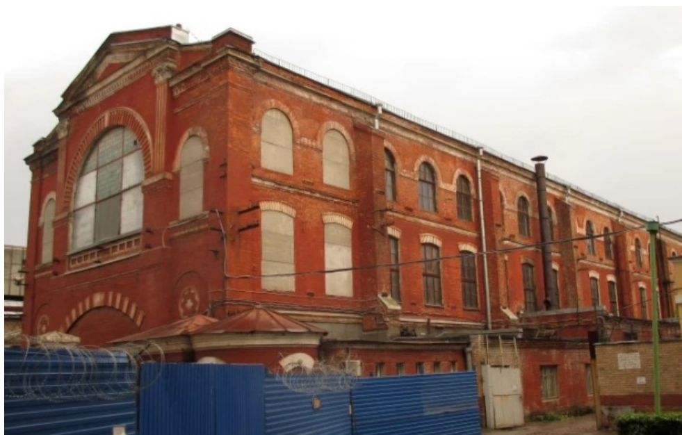
Ф.9. Вид на северо-восточный корпус объекта культурного наследия регионального значения «Пушечная мастерская Обуховского сталелитейного завода» (в составе «Императорская Александровская мануфактура (Обуховский сталелитейный завод)») по адресу: Санкт-Петербург, проспект Обуховской Обороны, дом 120, литера АЕ, АМ, О
