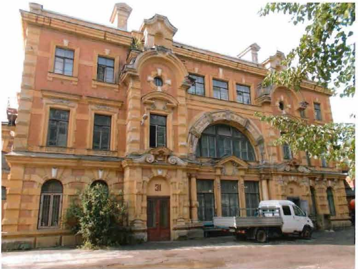
1. Северный фасад объекта культурного наследия.
