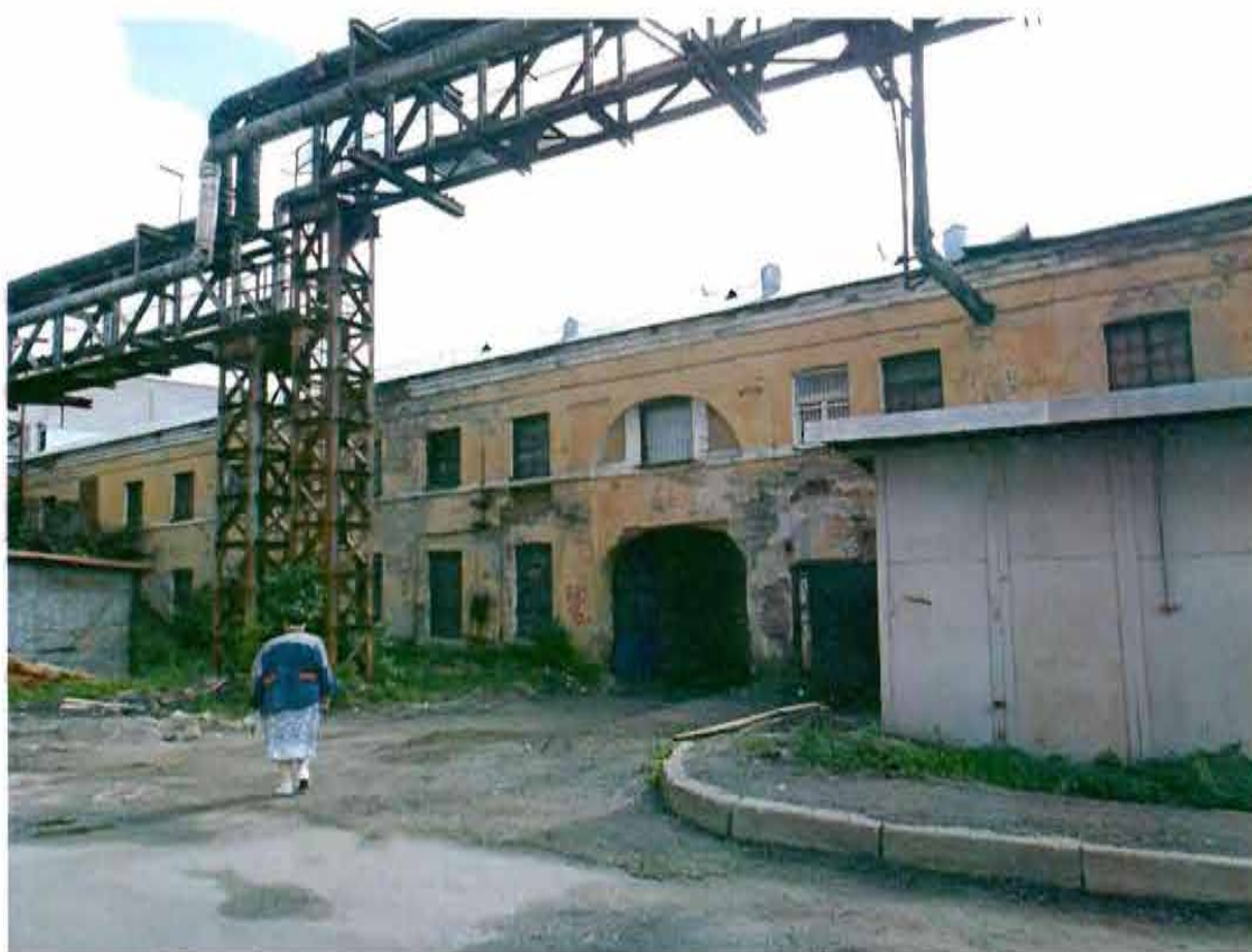
5. Фрагмент северо-западного фасада.
