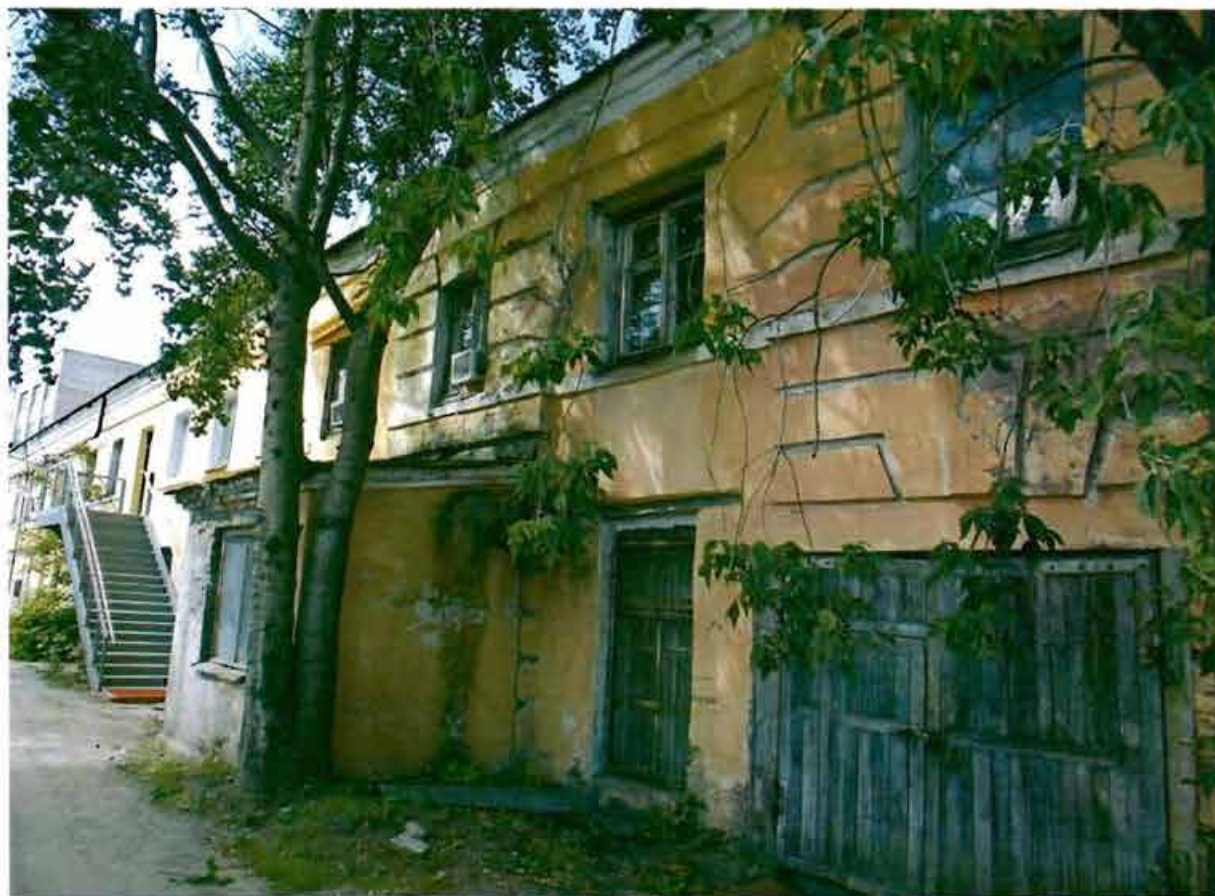
4. Фрагмент юго-восточного фасада.
