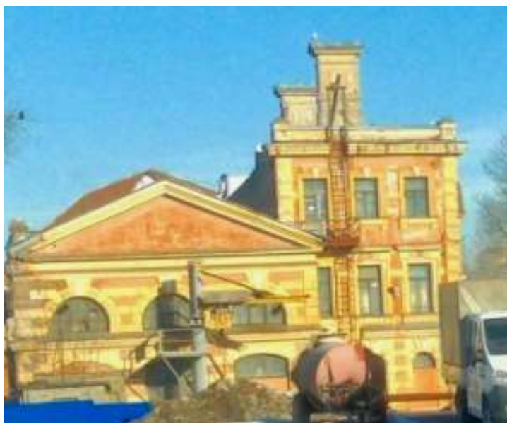
Ф.11. Вид на восточный фасад объекта культурного наследия регионального значения «Главная электрическая станция Обуховского сталелитейного завода» (в составе «Императорская Александровская мануфактура (Обуховский сталелитейный завод)») по адресу: Санкт-Петербург, проспект Обуховской Обороны, дом 120, литера Щ,.
