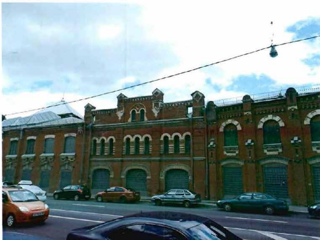
13.Западный фасад. Литера О.
