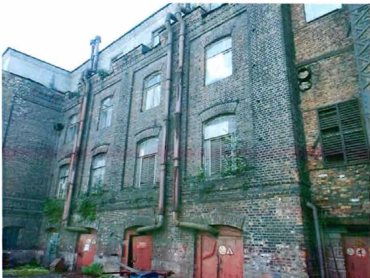
3. Северный фасад. Литера АМ.
