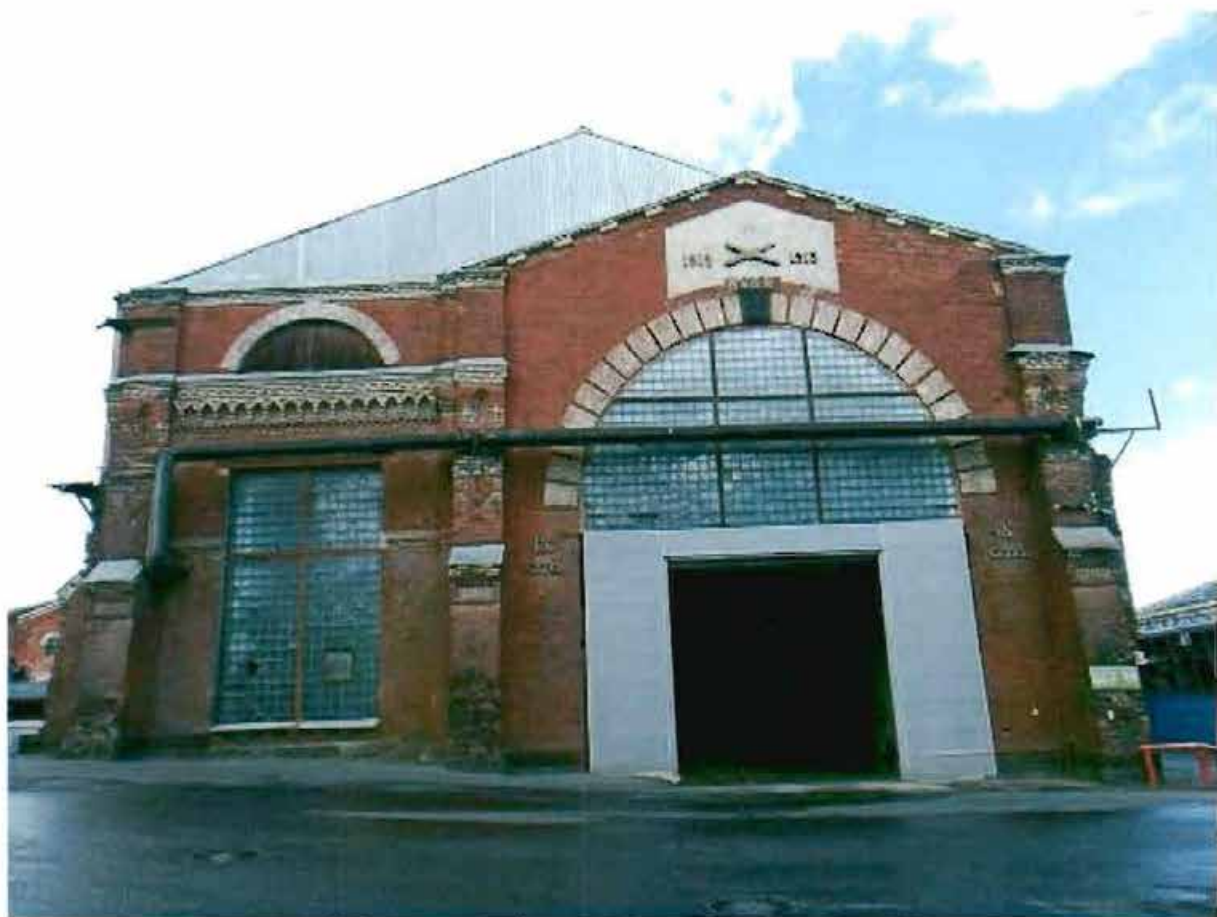
8. Восточный фасад. Строение 5 (литера АЕ).
