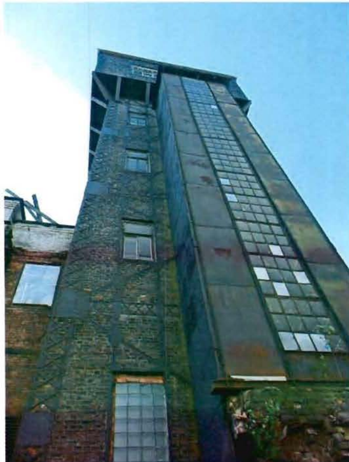
5.Северо-восточная башня. Литера АМ.
