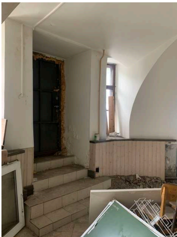
Фото 6. Южный фасад. Общий вид со стороны ул. Сторожевой дашни.
