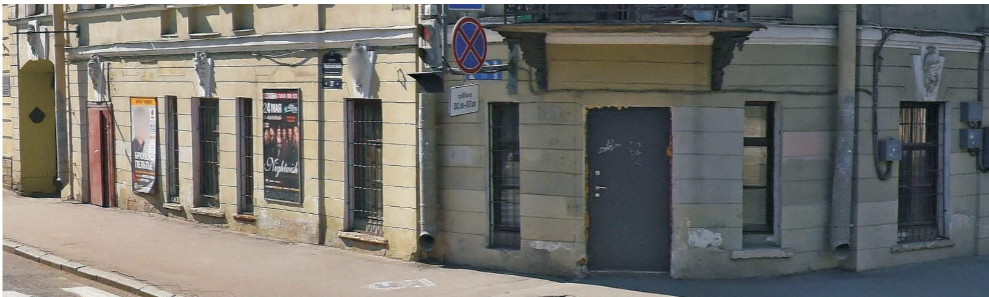
Ил. 54. Дом по адресу: пр. Римского-Корсакова, 37, ул. Глинки, 15. Фото 2016 г. Из интернета. Фрагмент лицевых фасадов с фасадом помещения 19-Н.
