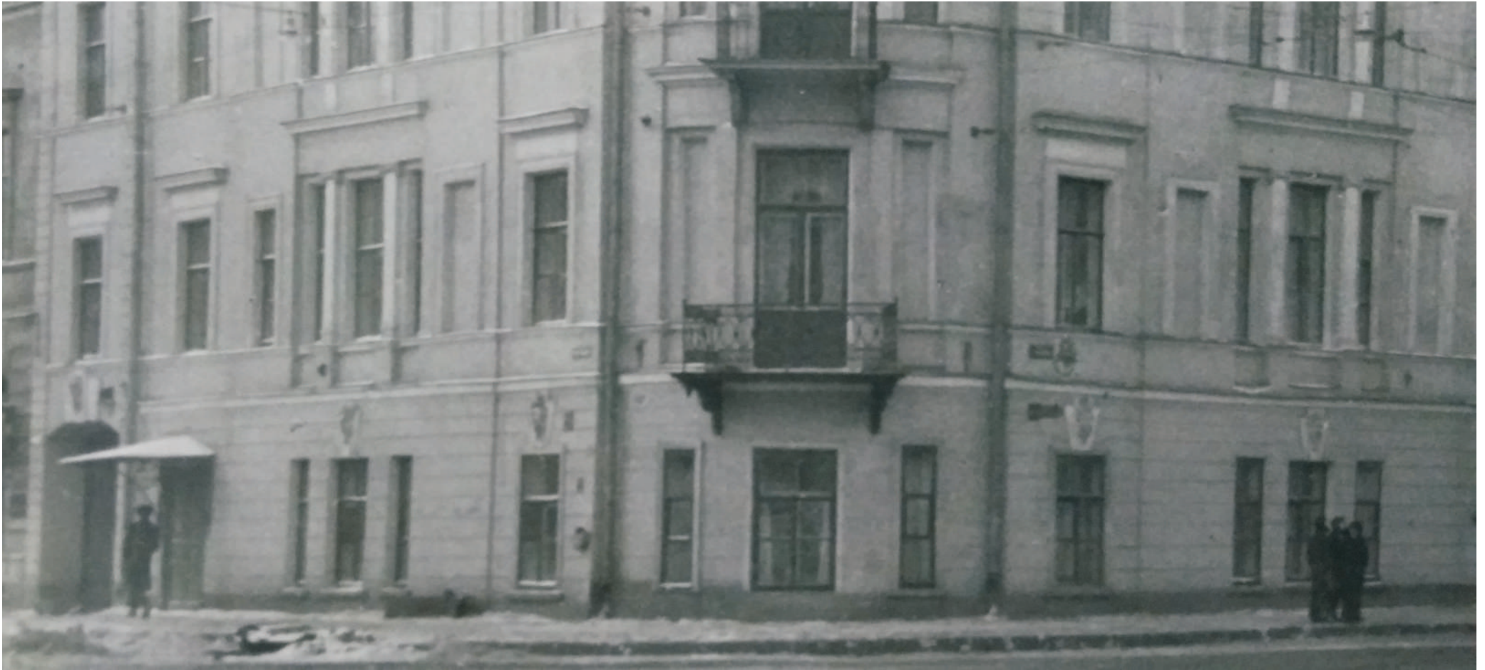
Ил. 38. Дом по адресу: пр. Римского-Корсакова, 37, ул. Глинки, 15. Фасады помещения 19-Н. Фрагмент снимка. Фото середины XX в. Фотография из паспорта исторического памятника. Пр. Римского-Корсакова, д. 37/15. Бывш. дом Бенуа. Л., 1951 г. КГИОП. Переписка.
