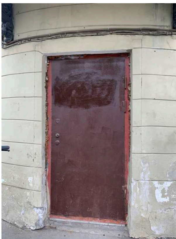
Фото 4. Южный фасад. Общий вид со стороны ул. Сторожевой башни.
