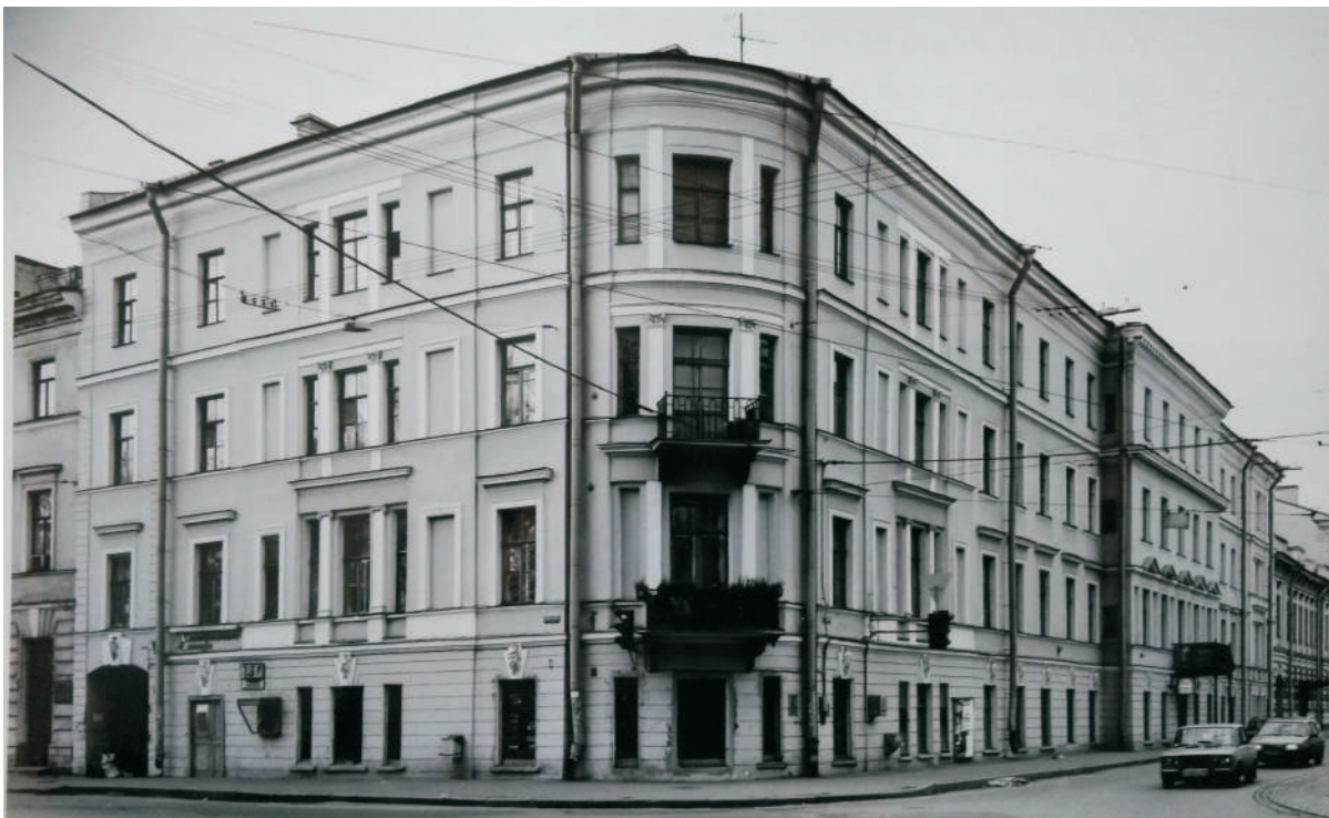
Ил. 49. Дом по адресу: пр. Римского-Корсакова, 37, ул. Глинки, 15. Фотограф С. Шмидт, 1997 г. Из архива КГИОП. п. 393.
