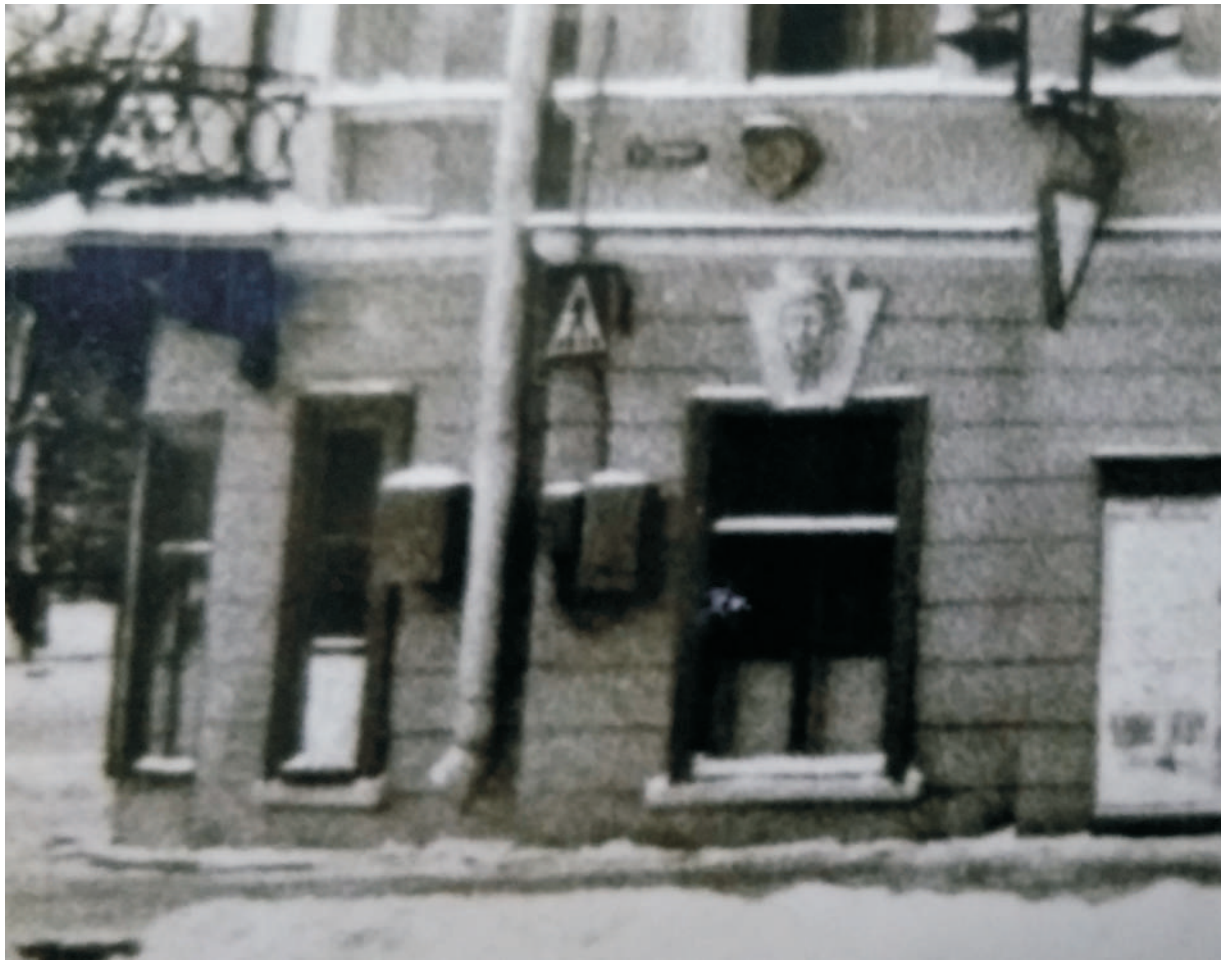
Ил. 43. Дом по адресу: пр. Римского-Корсакова, 37, ул. Глинки, 15. Фасад по улице Глинки. Фото Емельянова, 1978 г. Из архива КГИОП. Фрагмент с фасадом рассматриваемого помещения 19-Н.
