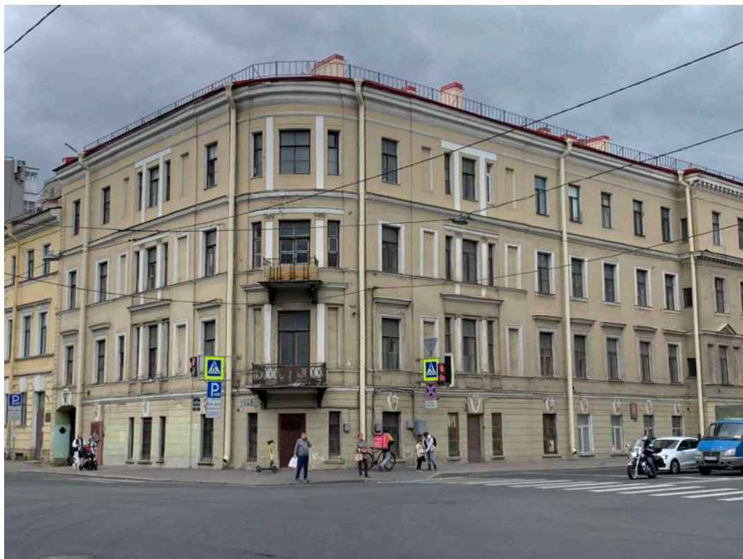
Фото 3. Южный фасад. Общий вид со стороны ул. Сторожевой башни.
