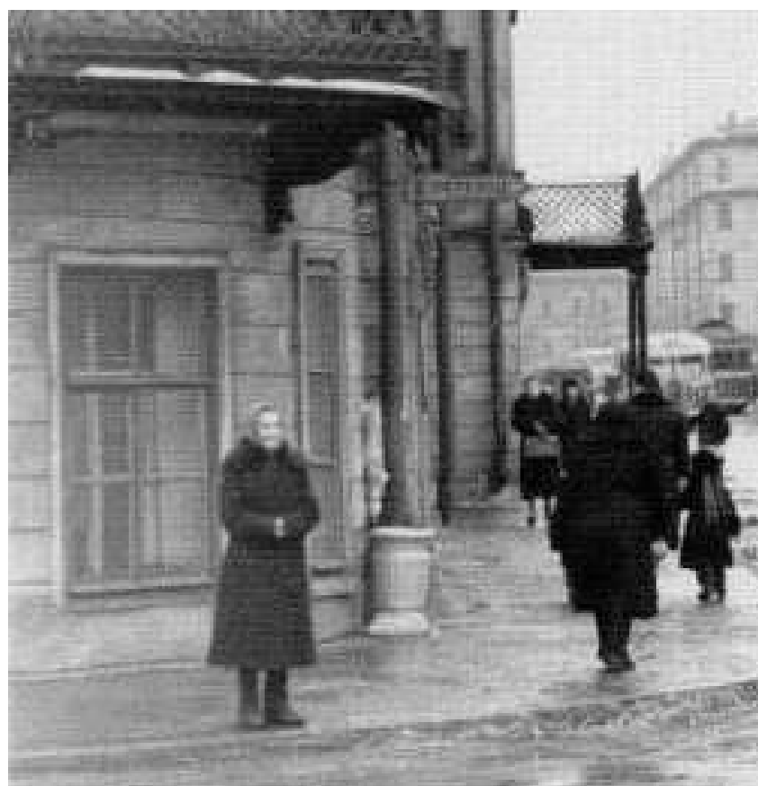
Фрагмент снимка с угловой частью дома №37 по пр. Римского-Корсакова, 37/15. Оконный проем под балконом.
