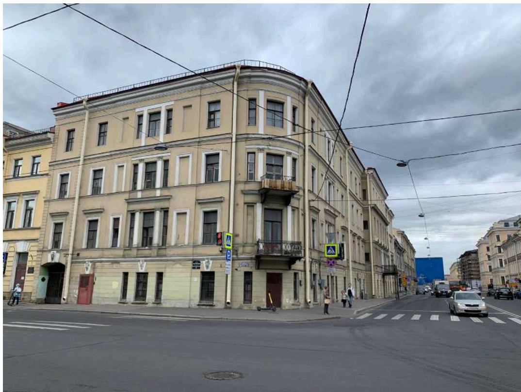
Фото 1. Южный фасад. Общий вид со стороны ул. Сторожевой башни.
