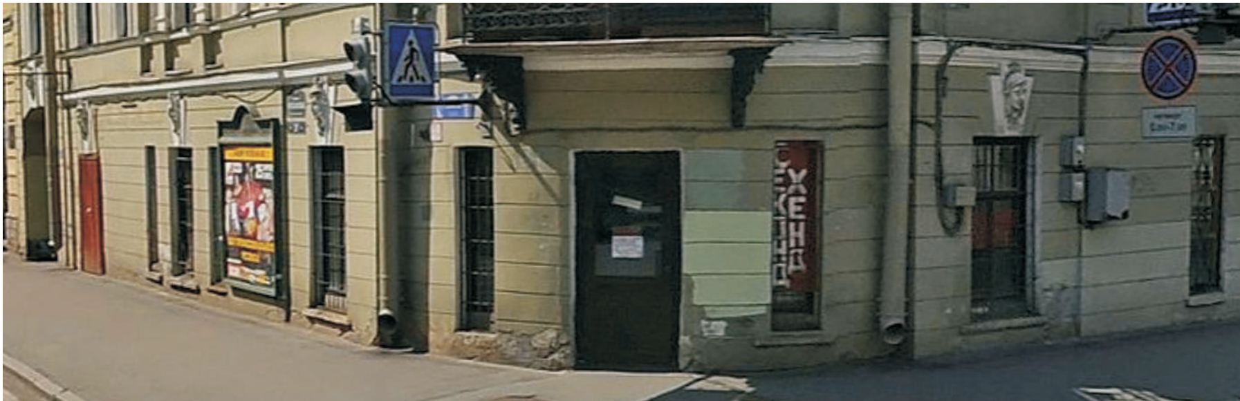
Ил. 53. Дом по адресу: пр. Римского-Корсакова, 37, ул. Глинки, 15. Фото 2013 г. Из интернета. Фрагмент лицевых фасадов с фасадом помещения 19-Н.
