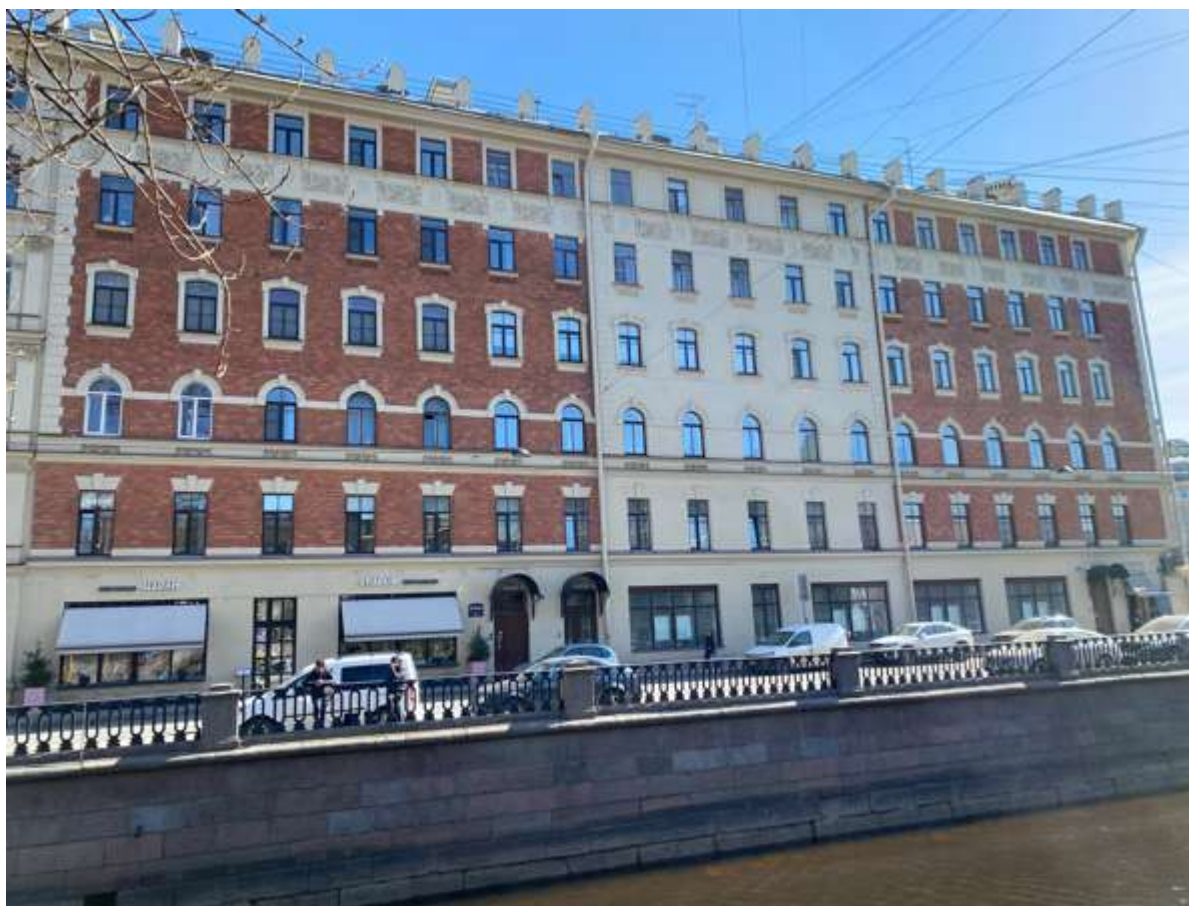
16. Фрагмент фасада со стороны канала Грибоедова
