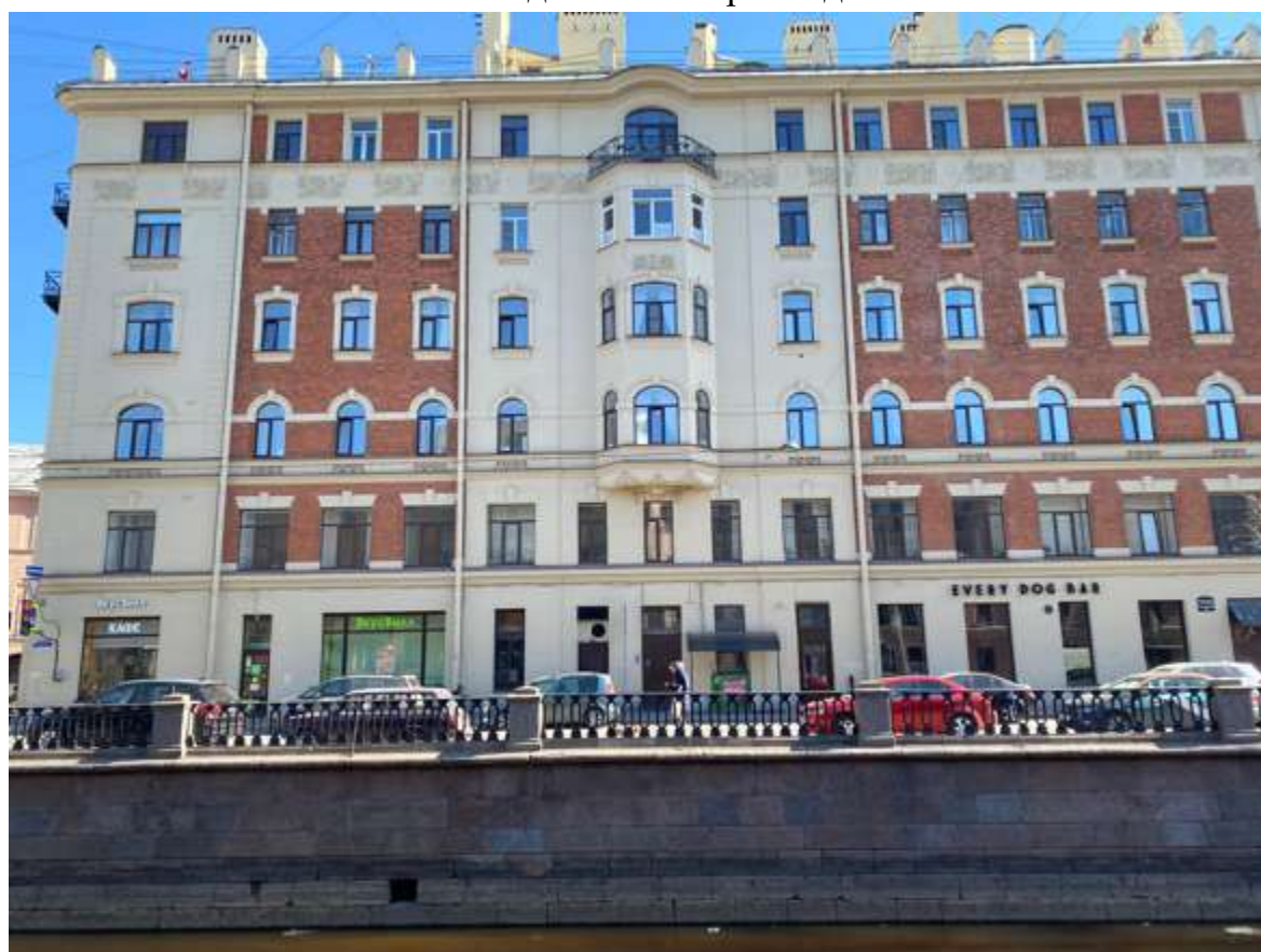
21. Фрагмент фасада со стороны канала Грибоедова
