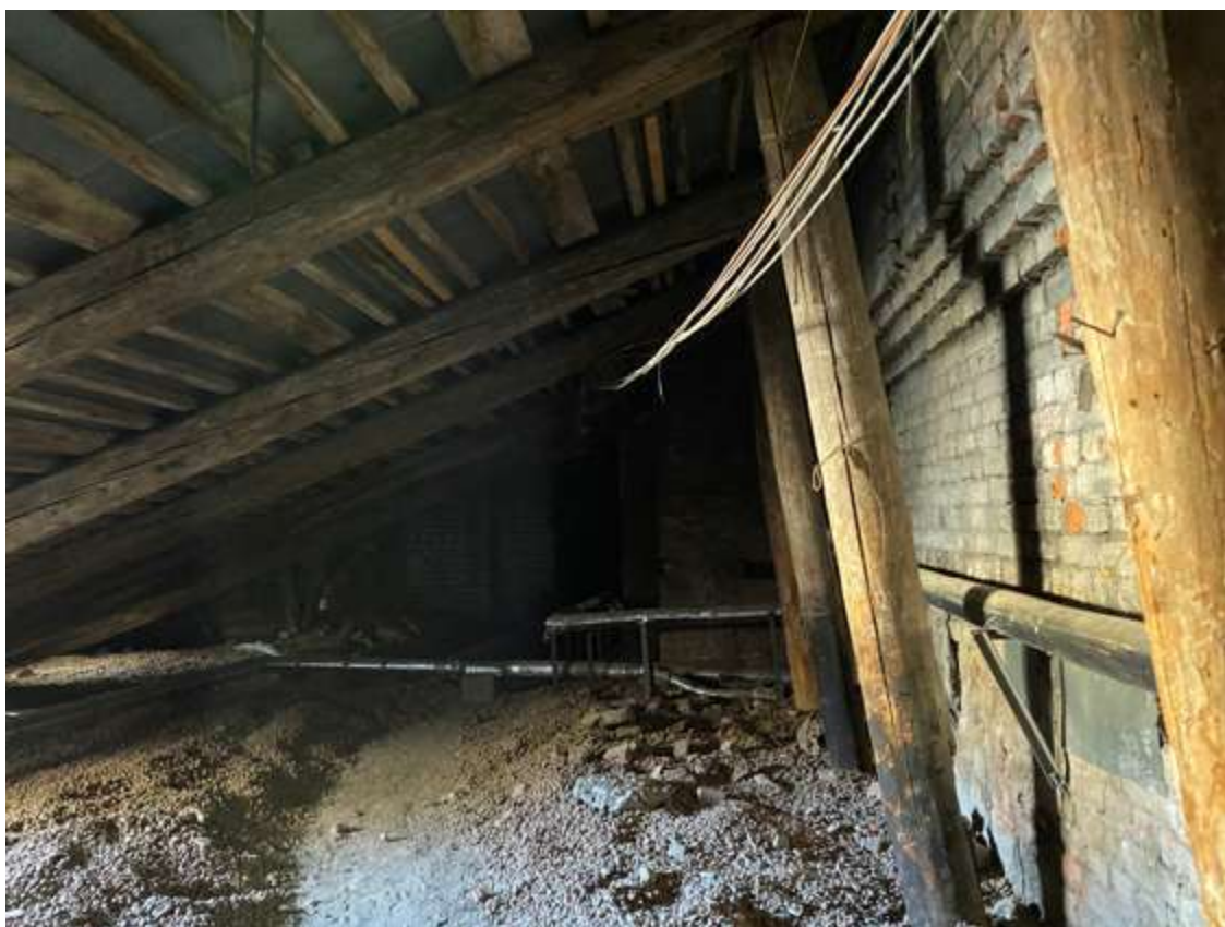
177. Фрагмент интерьера чердака
