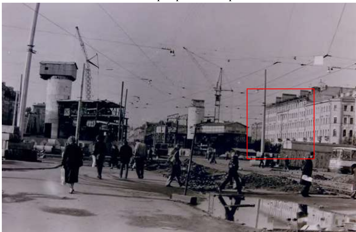
166. Строительство ст. м. "Площадь Мира-3" ("Садовая"). 1986 [Электронный ресурс] URL: https://pastvu.com/p/479798
