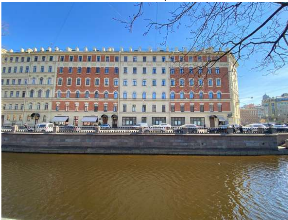
15. Фрагмент фасада со стороны канала Грибоедова
