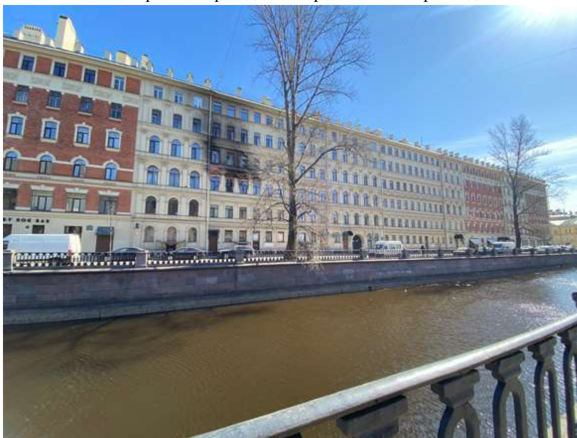
23. Фрагмент фасада со стороны канала Грибоедова
