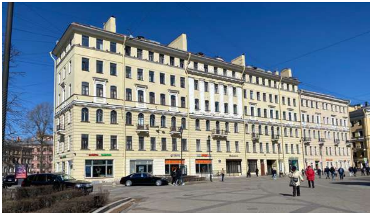
1. Фасад со стороны Сенной площади
