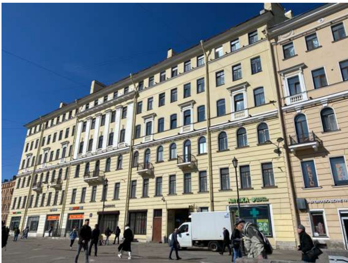
3. Фасад со стороны Сенной площади
