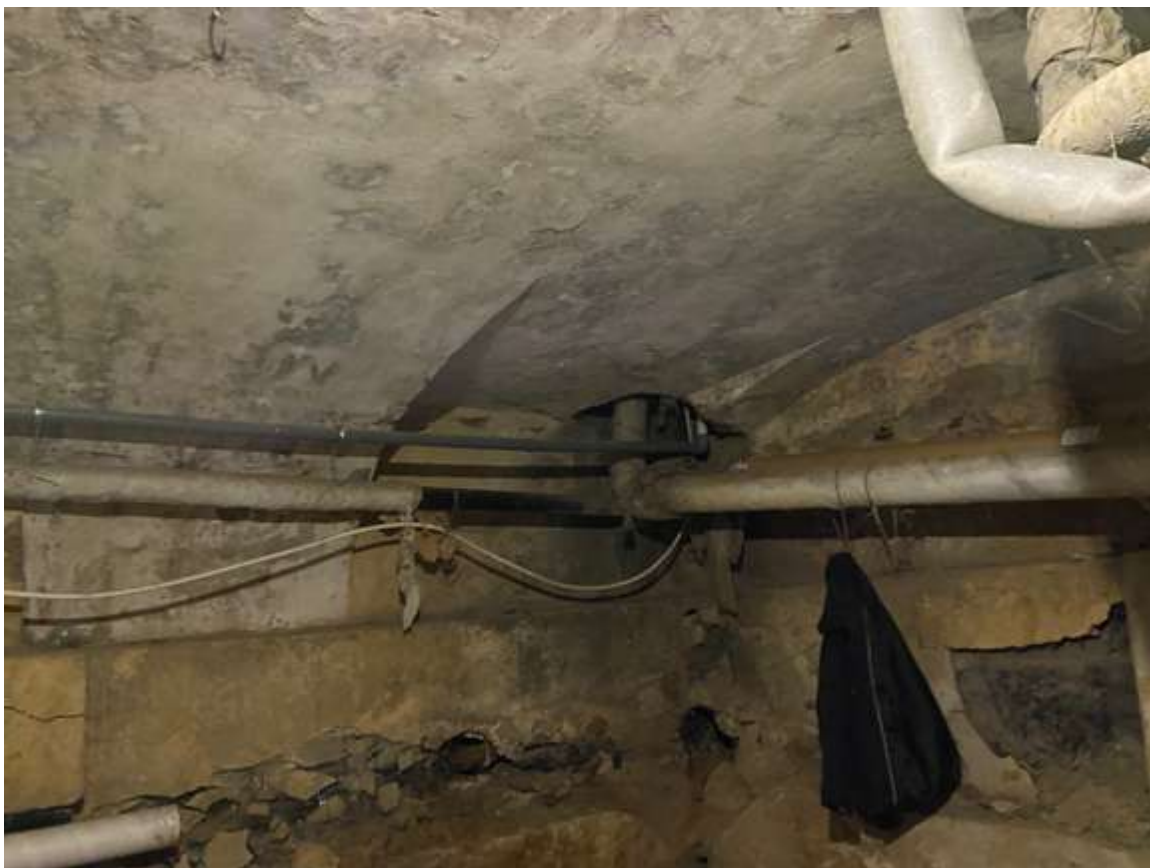
90. Фрагмент интеръера подвала
