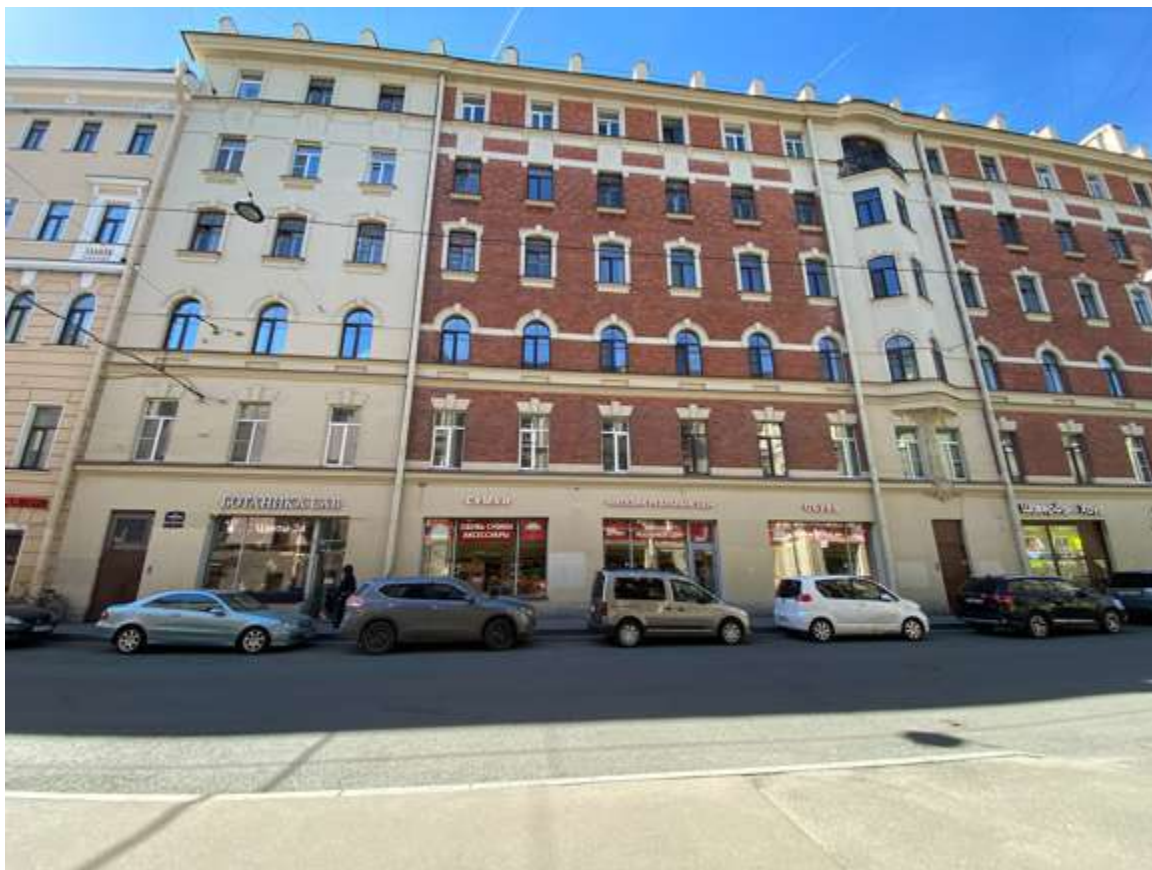
18. Фрагмент фасада со стороны переулка Гривцова
