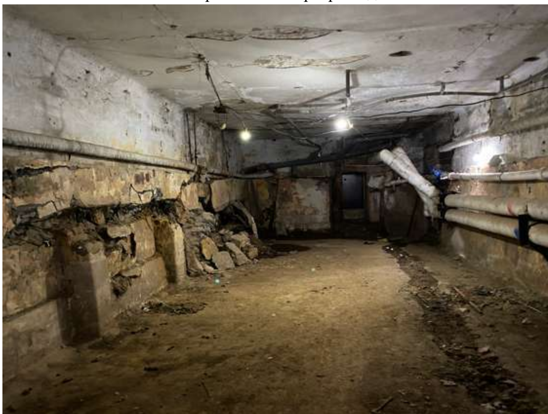
91. Фрагмент интеръера подвала
