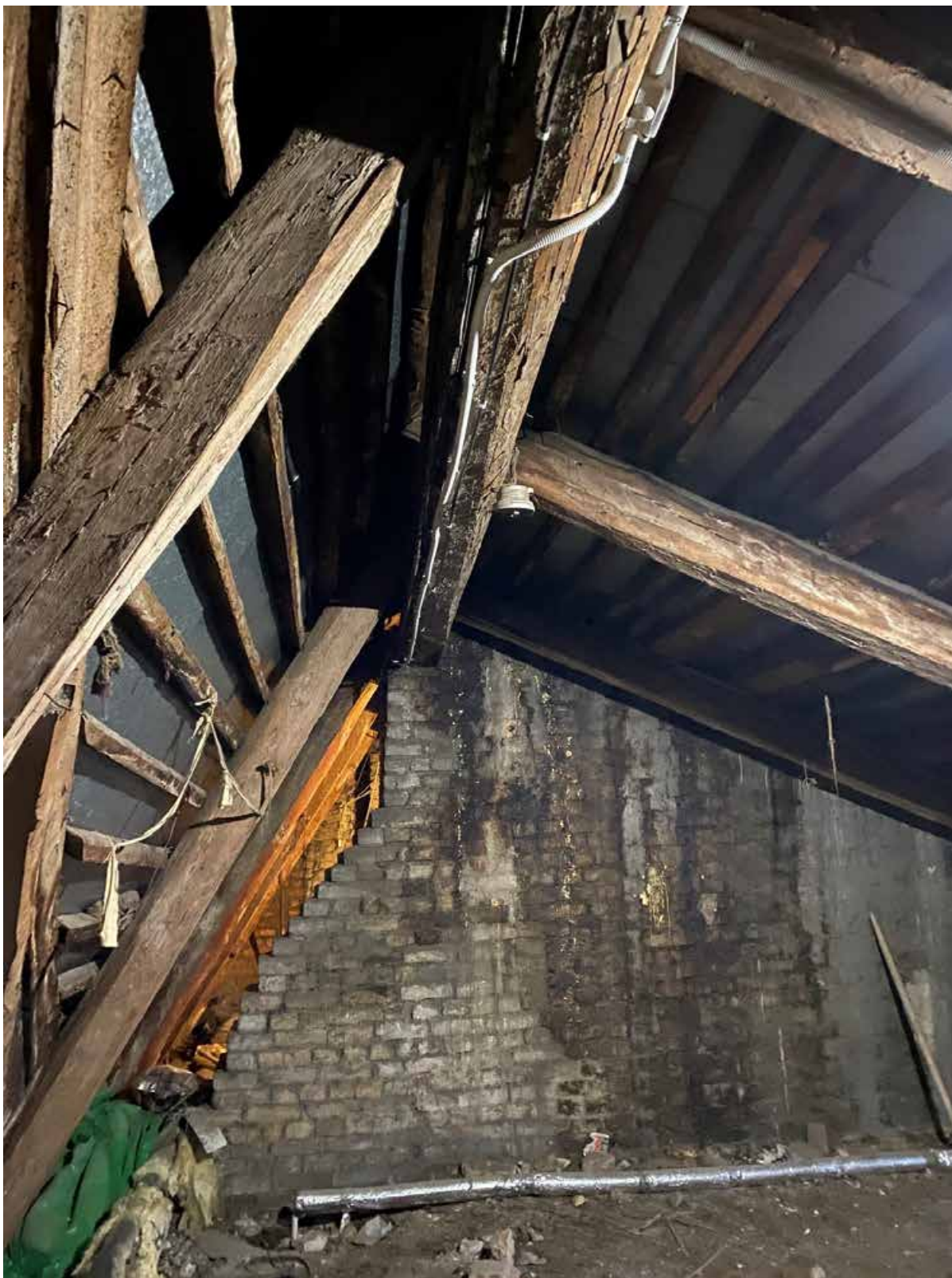
50. Общий вид чердачного помещения
