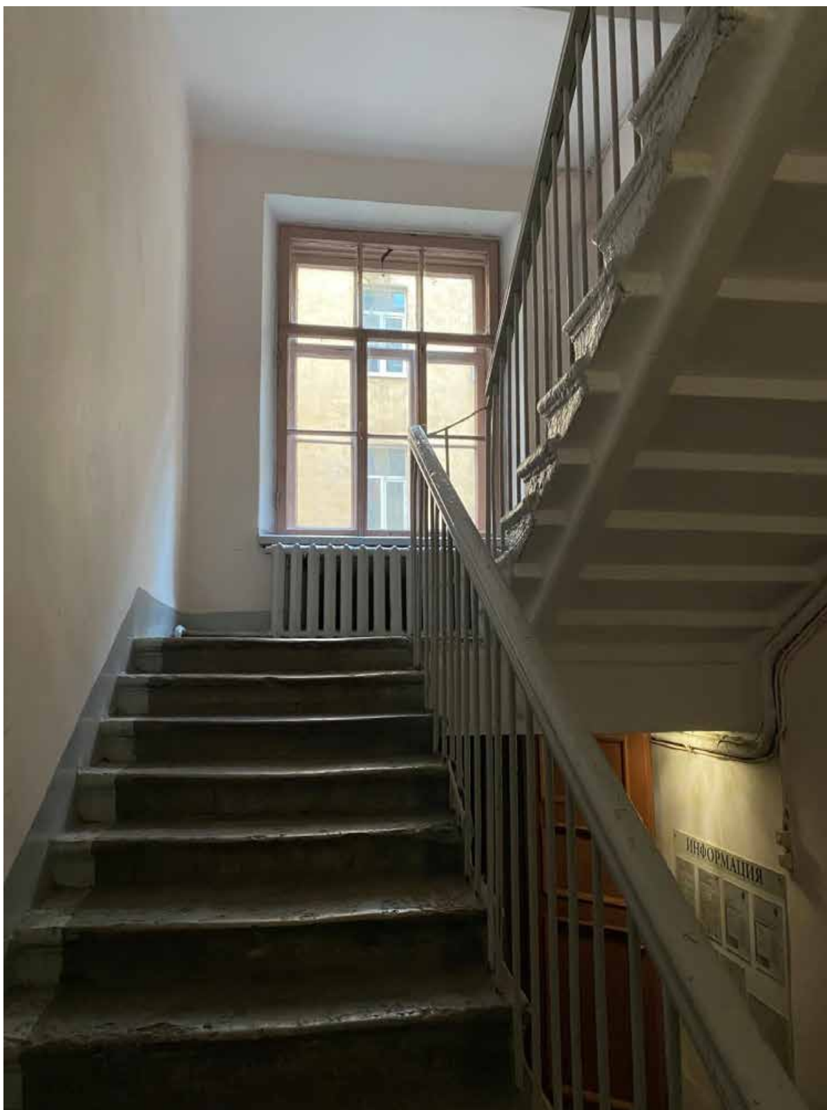
86. Общий вид лестницы БЛК в уровне 1-го этажа
