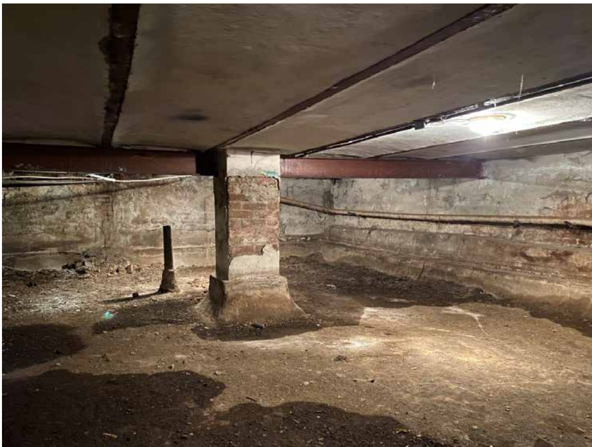
34. Общий вид подвального помещения
