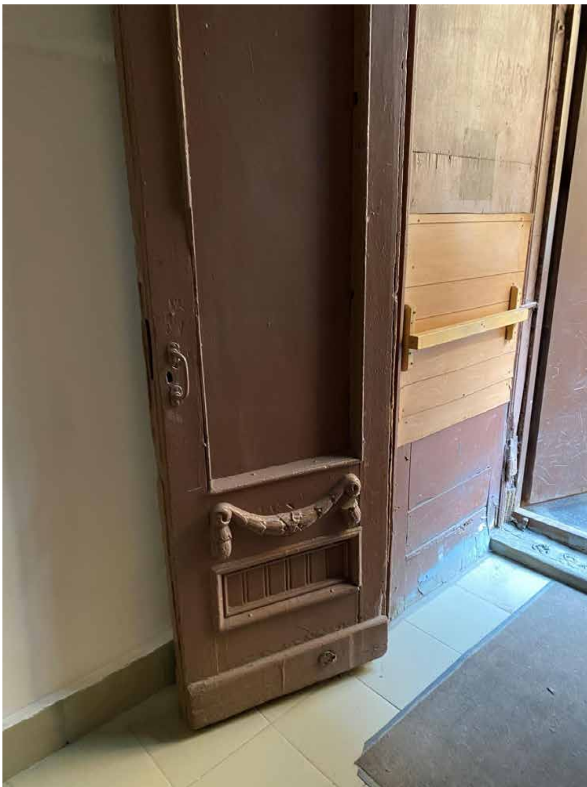
51. Фрагмент дверного заполнения тамбура лестницы 4ЛК
