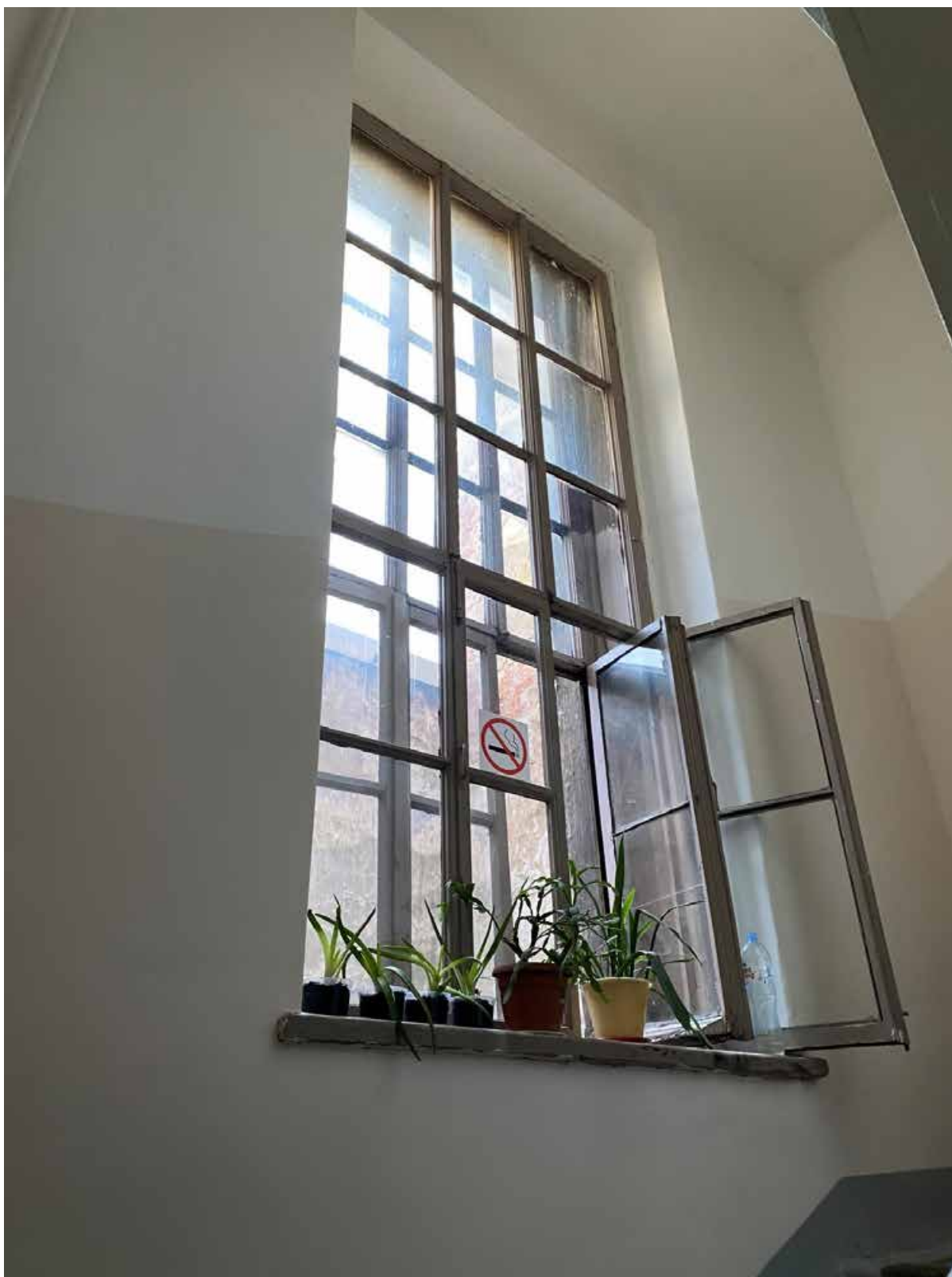
62. Оконное заполнение в части лестницы 4ЛК в уровне 4-го этажа
