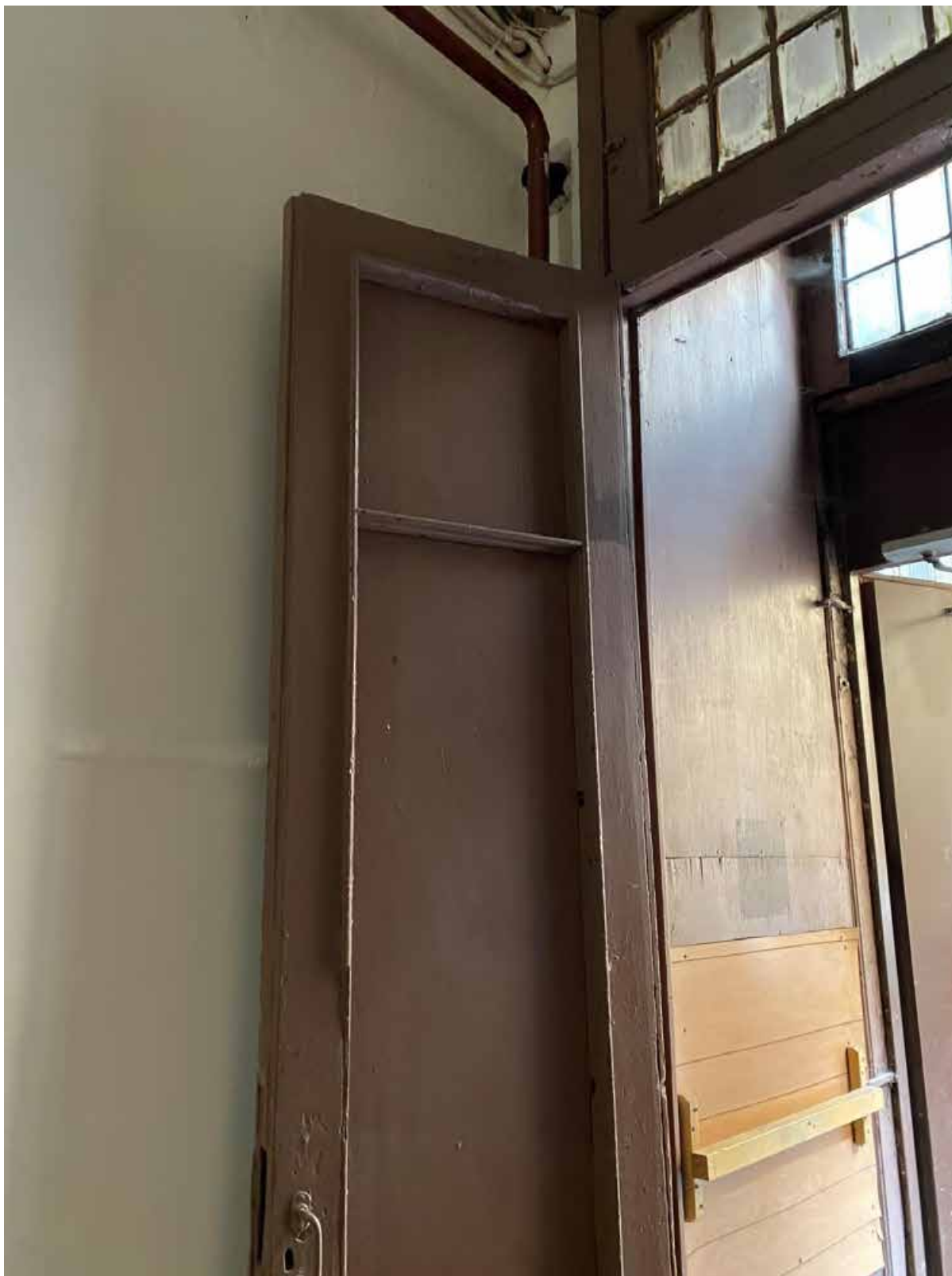
52. Фрагмент дверного заполнения тамбура лестницы 4ЛК
