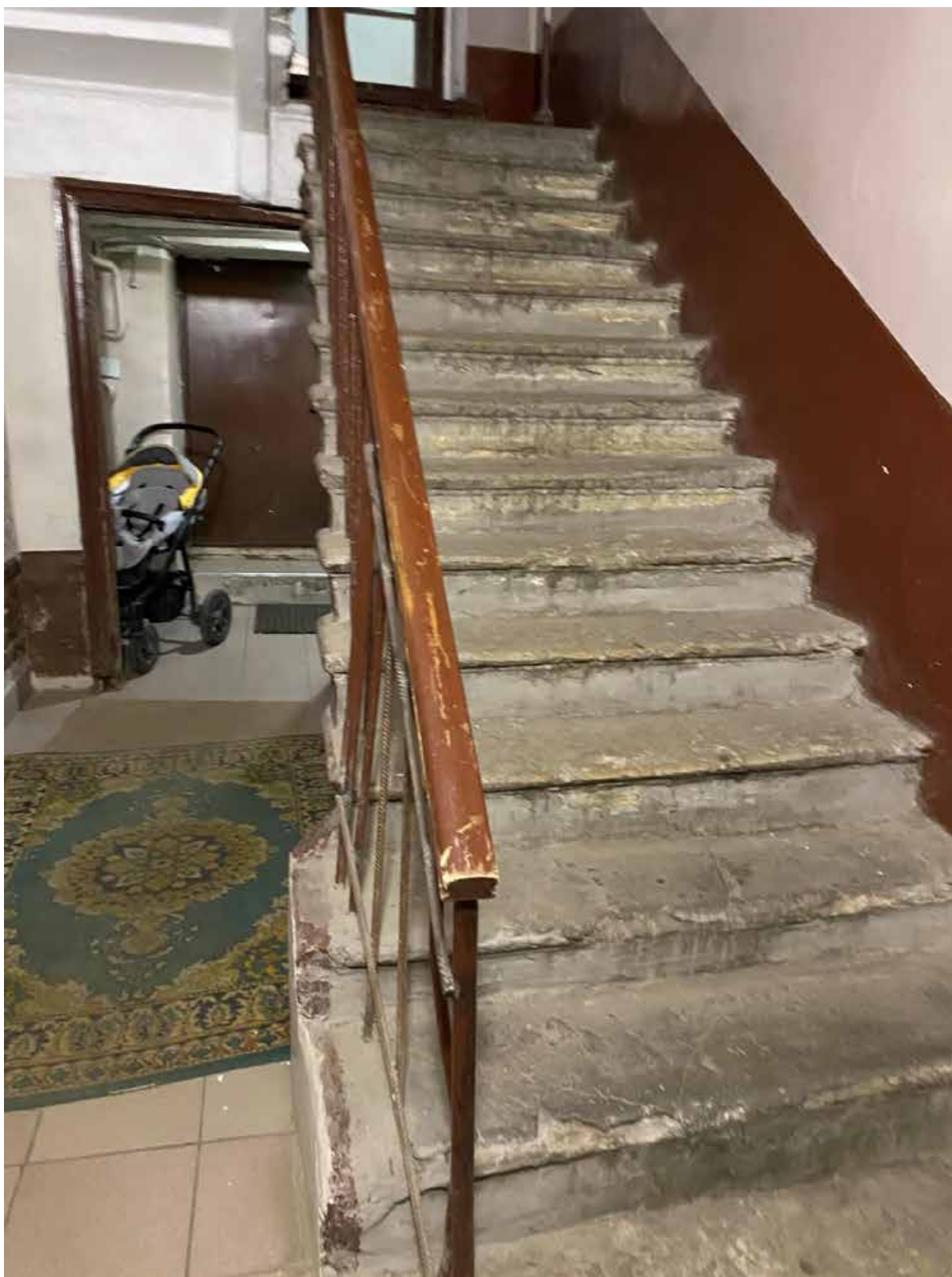
69. Общий вид лестницы 5ЛК в уровне 1-го этажа
