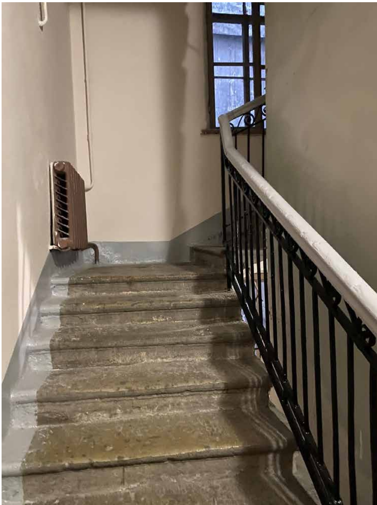
58. Общий вид лестницы 4ЛК в уровне 2-го этажа
