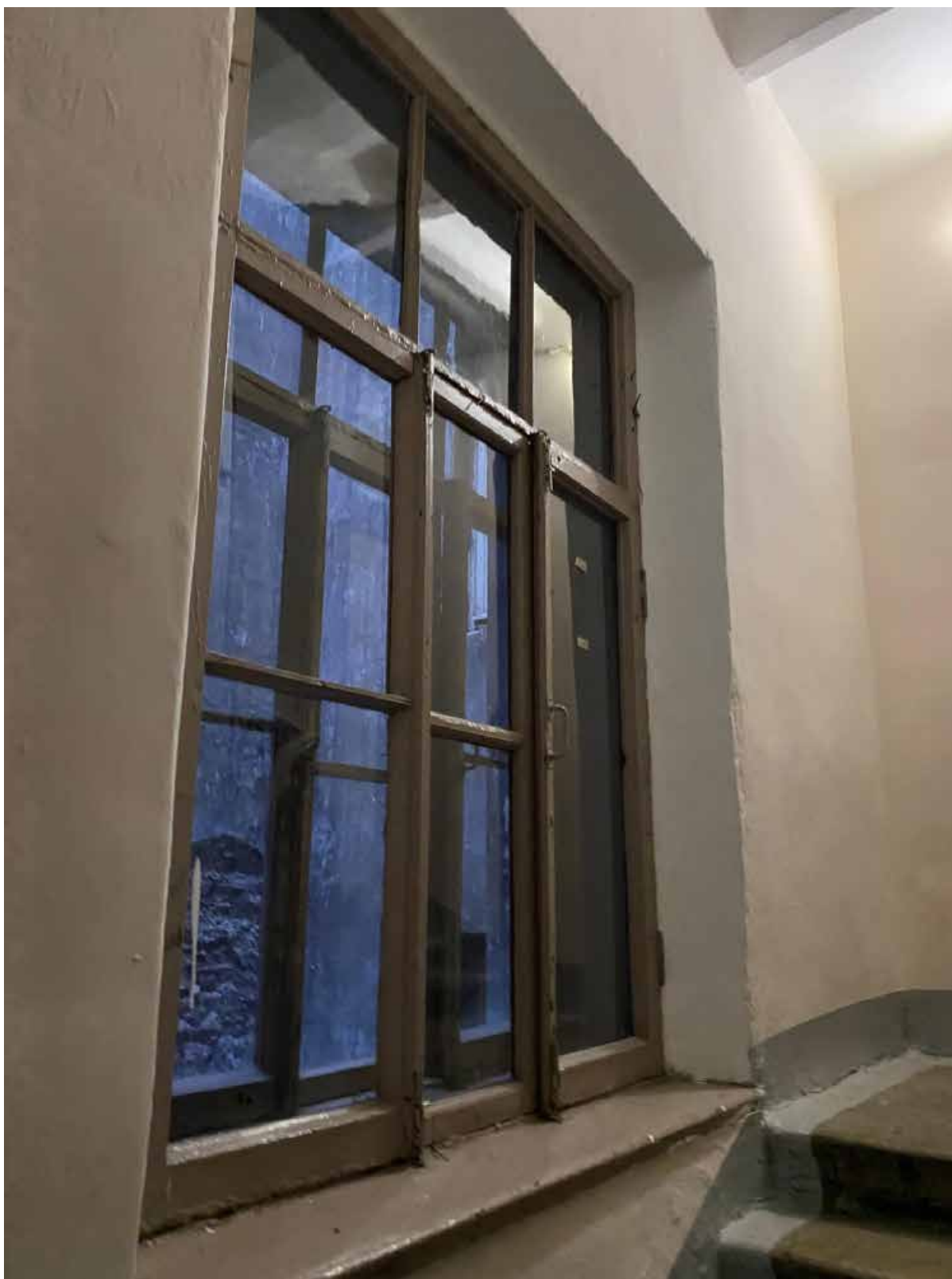
56. Оконное заполнение в части лестницы 4ЛК в уровне 1-го этажа
