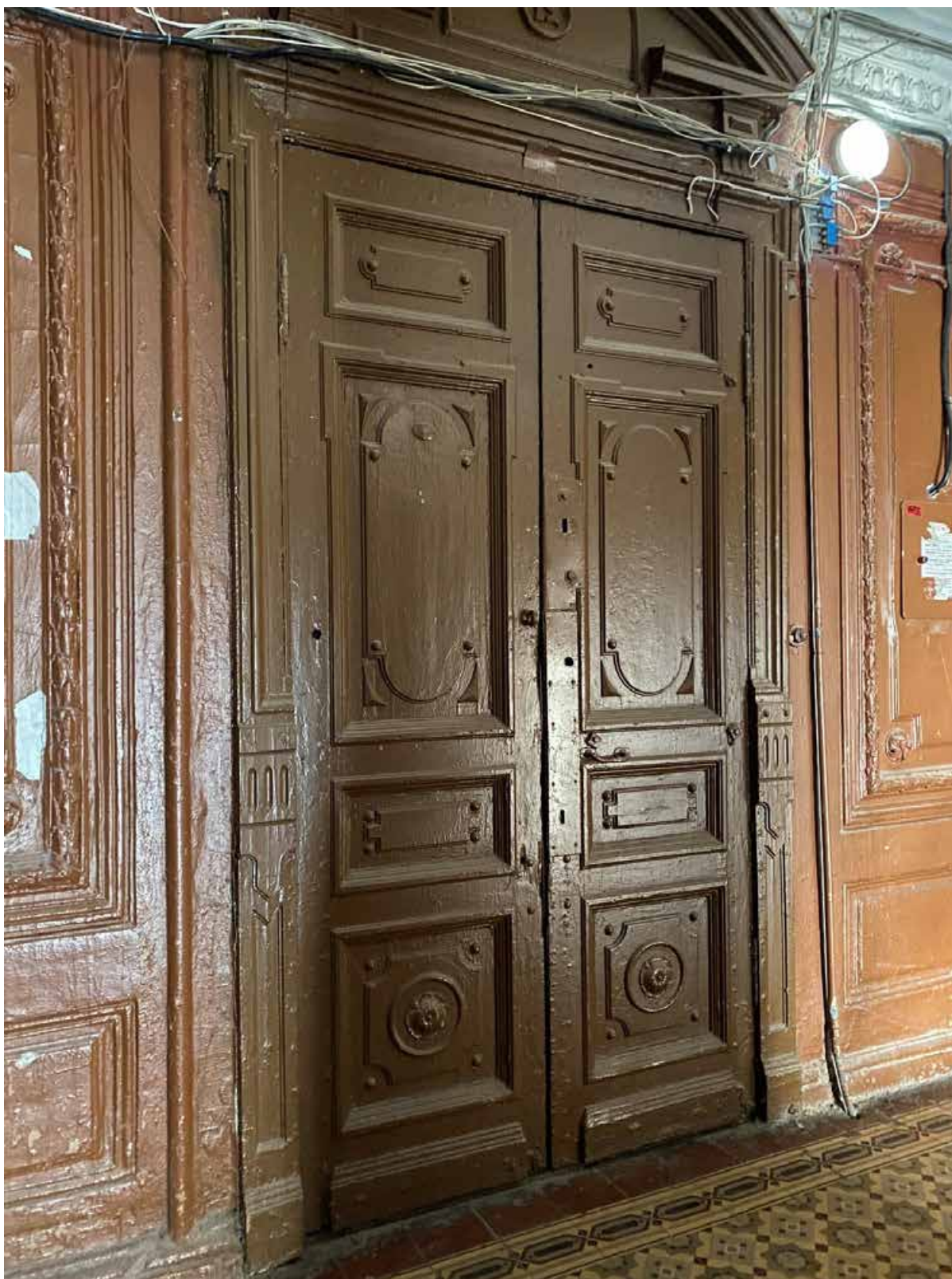
31. Общий вид дверного заполнения в части лестницы 1ЛК в уровне 4-го этажа
