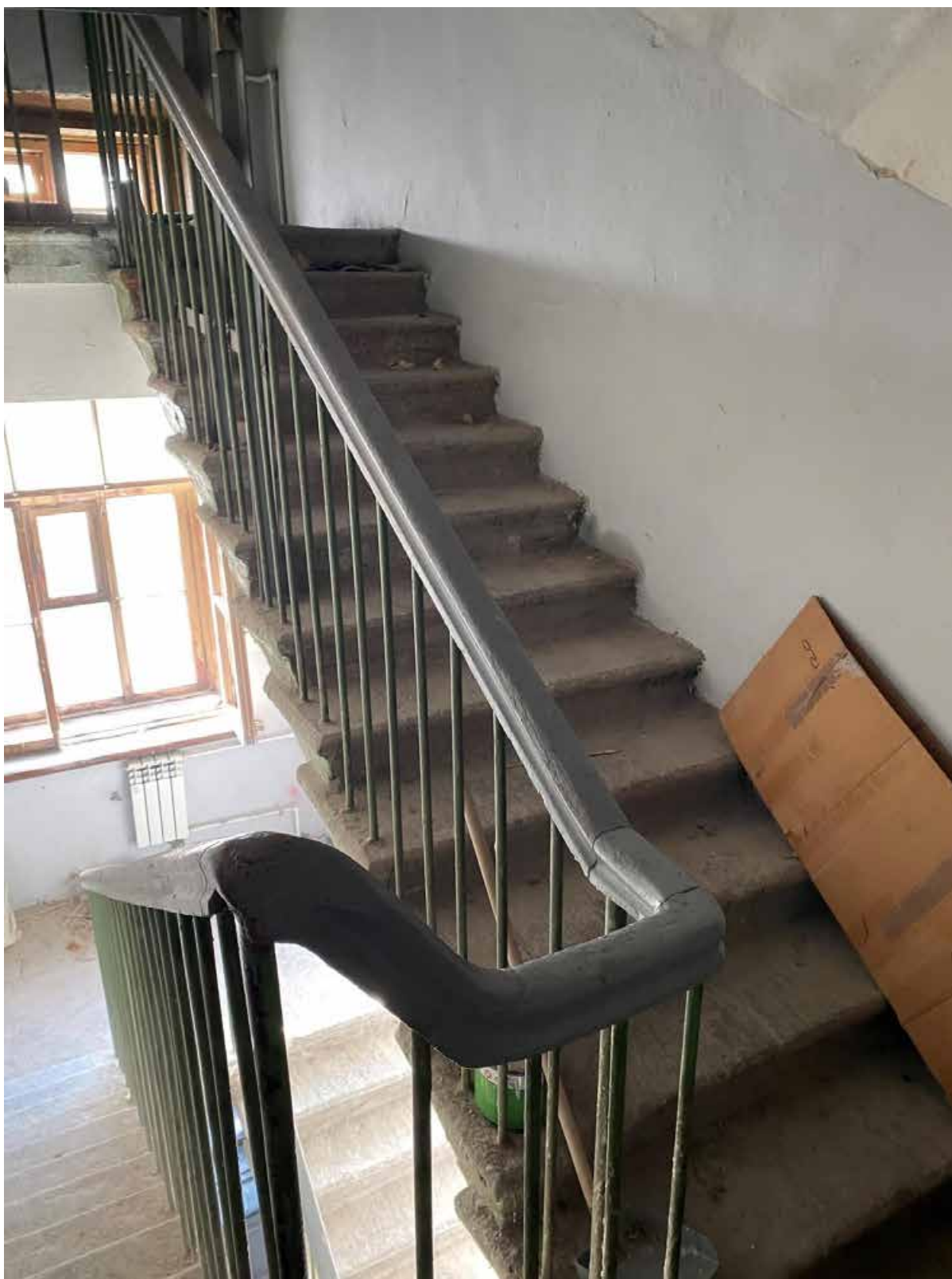
45. Общий вид лестницы ЗЛК в уровне 5-го этажа
