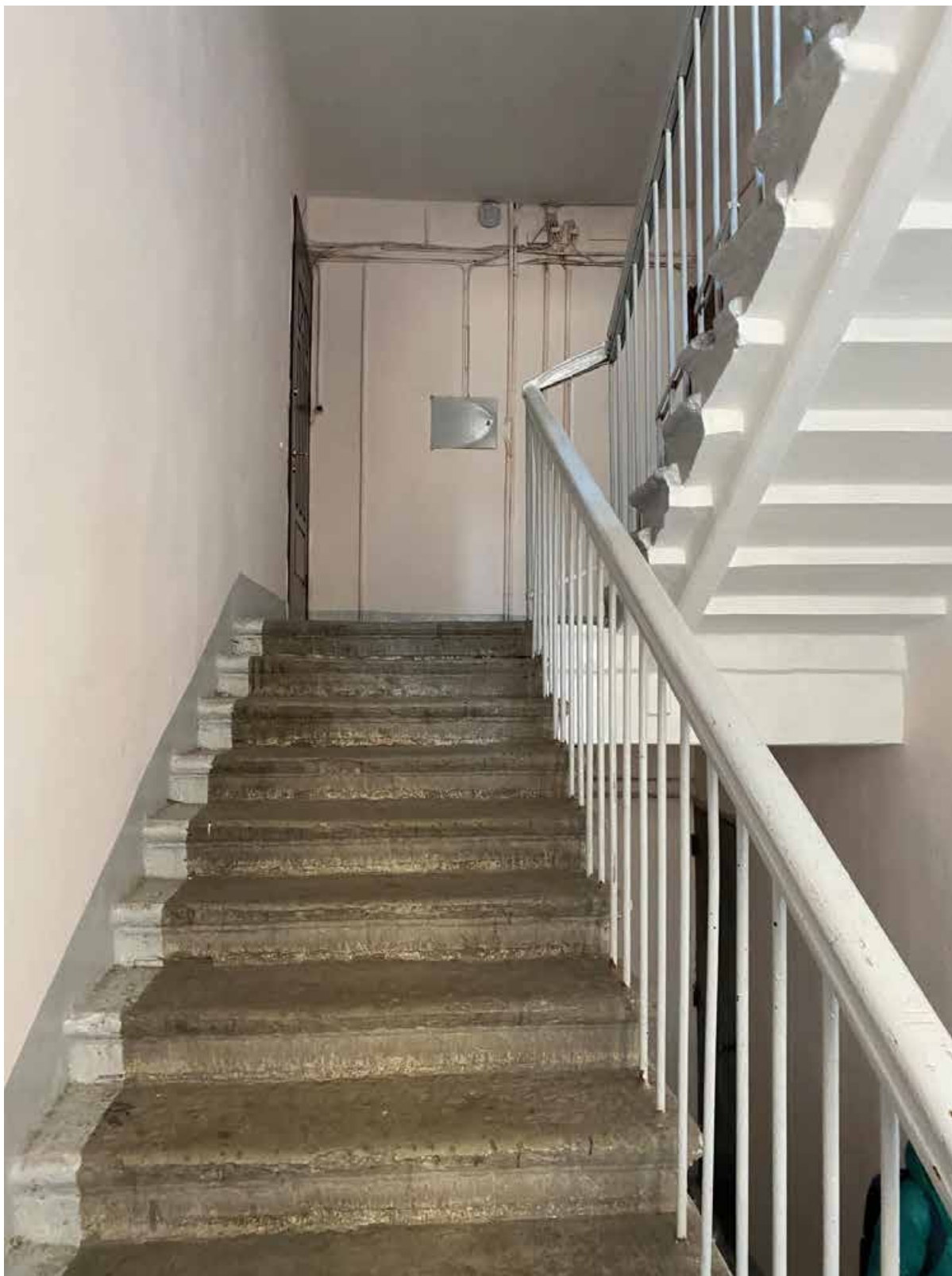
89. Общий вид лестницы БЛК в уровне 2-го этажа
