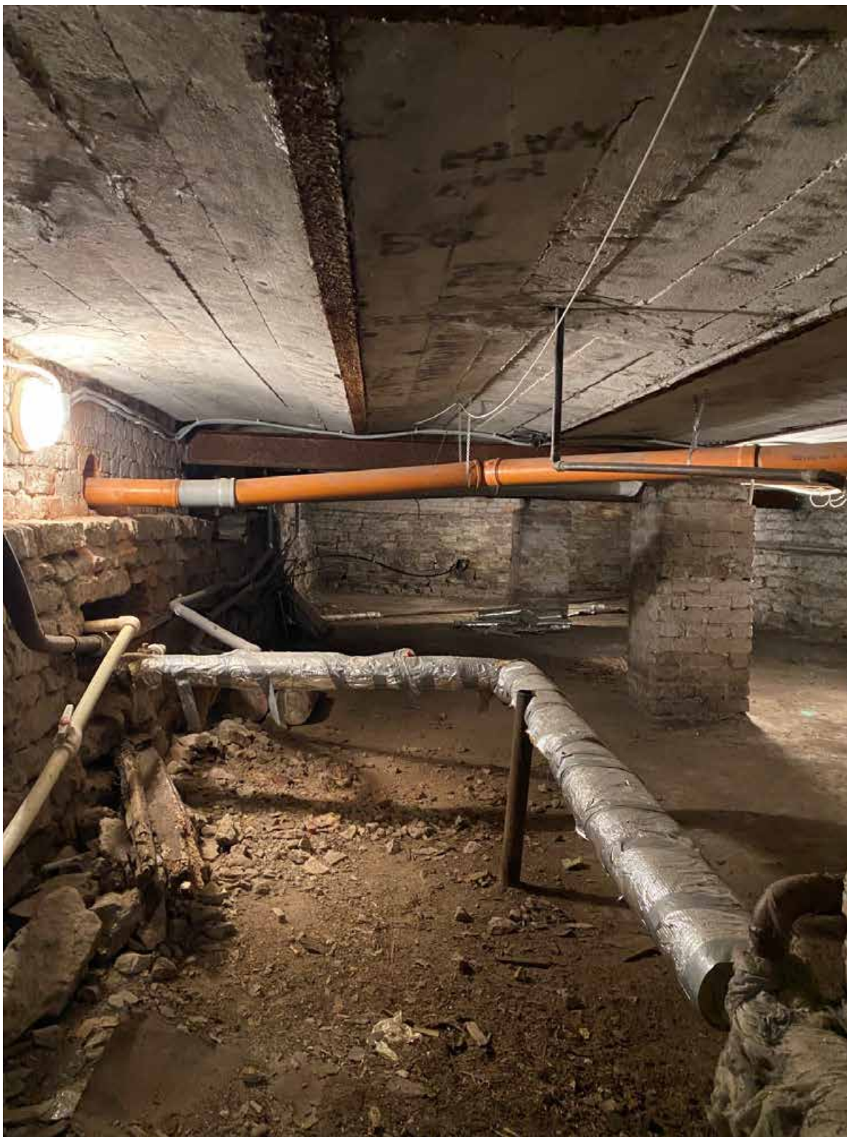
68. Общий вид подвального помещения
