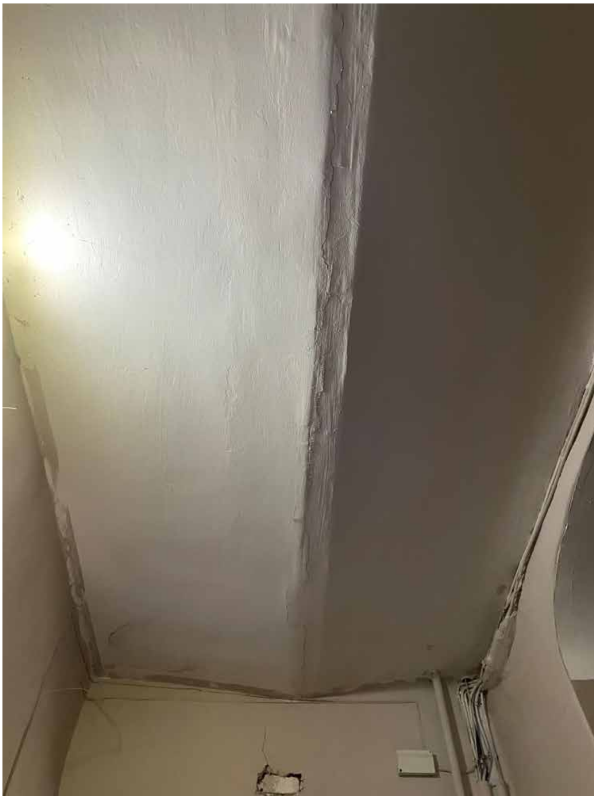
73. Перекрытие лестницы 5JK в уровне 2-го этажа
