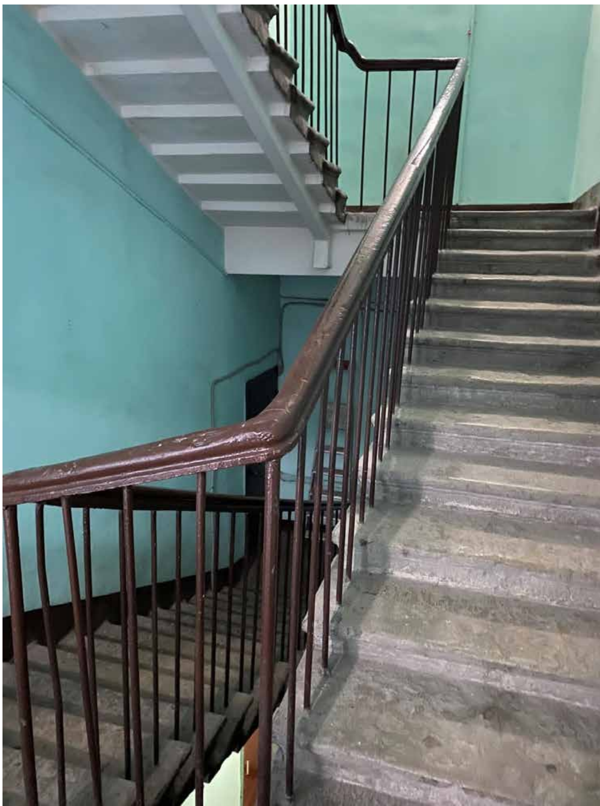
82. Общий вид лестницы 5ЛК в уровне 5-го этажа
