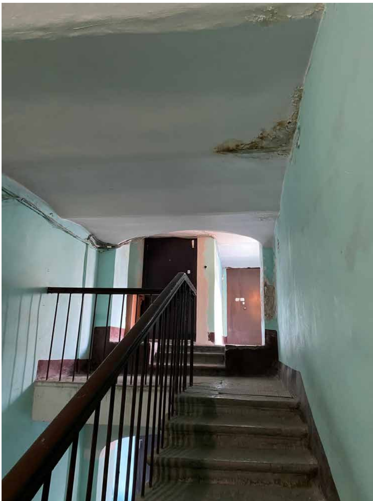
84.Перекрытие лестницы 5ЛК в уровне 5-го этажа
