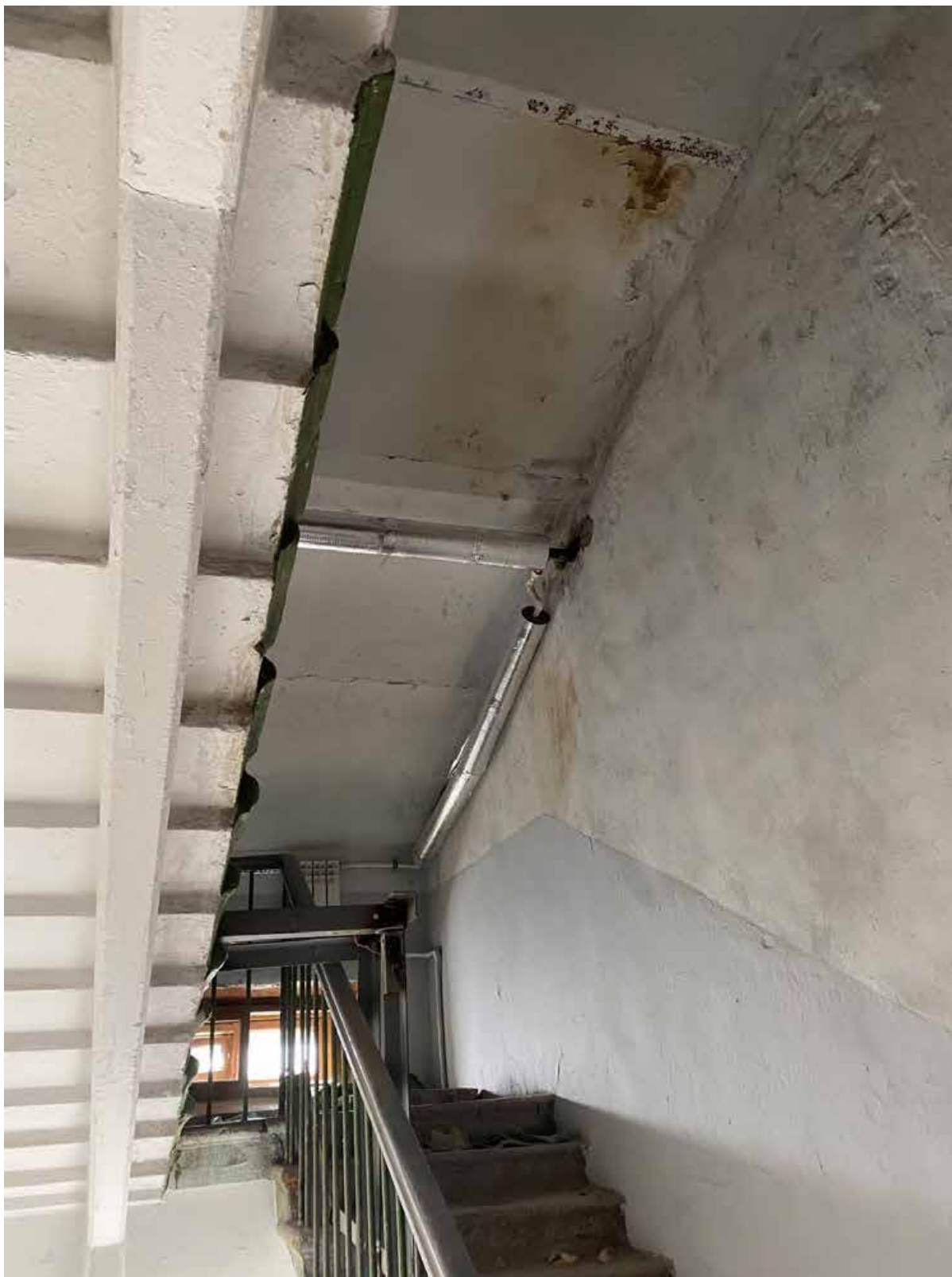
46.Общий вид лестницы ЗЛК в уровне 5-го этажа
