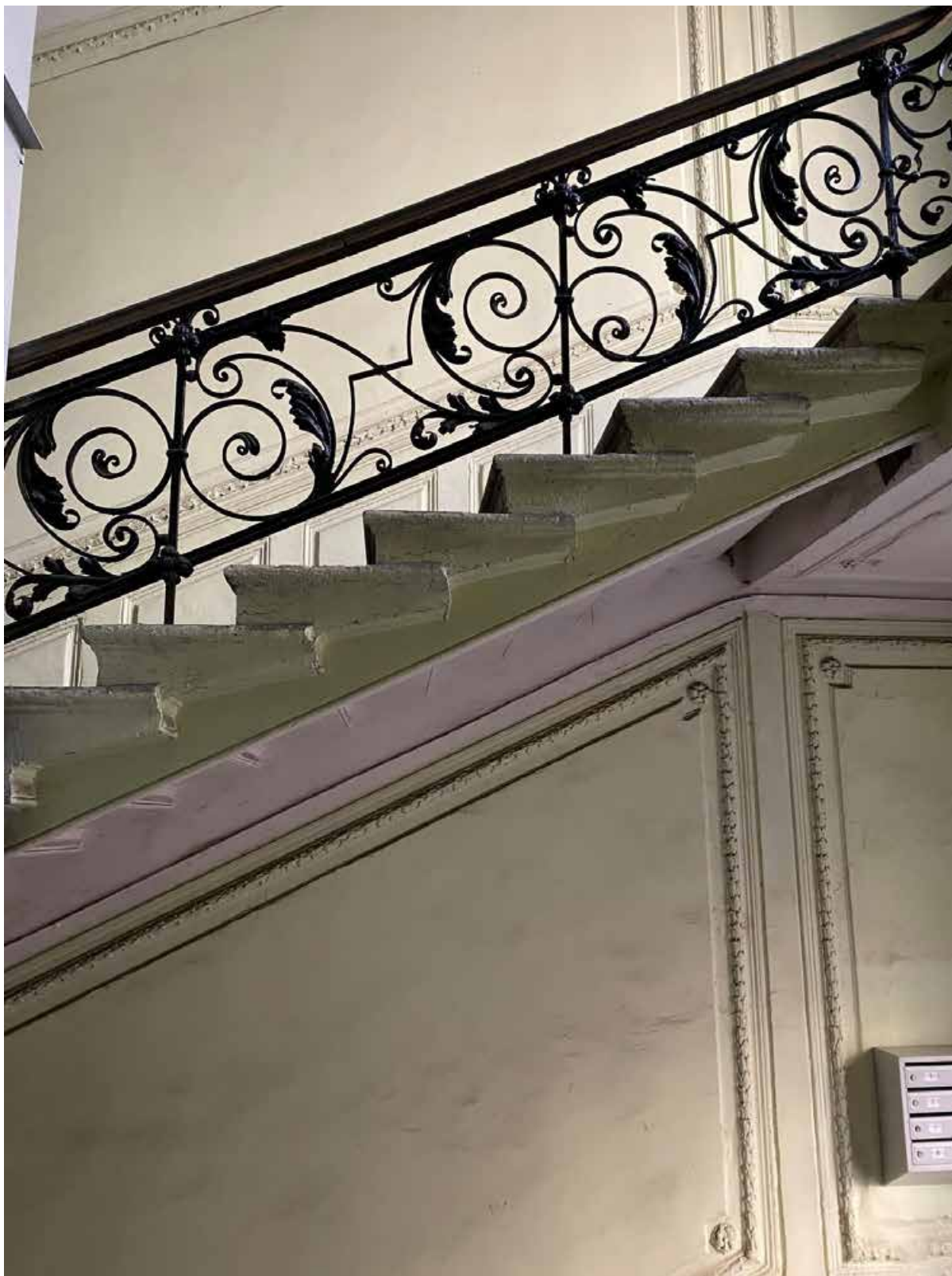
25. Ограждение лестницы 1ЛК в уровне 2-го этажа
