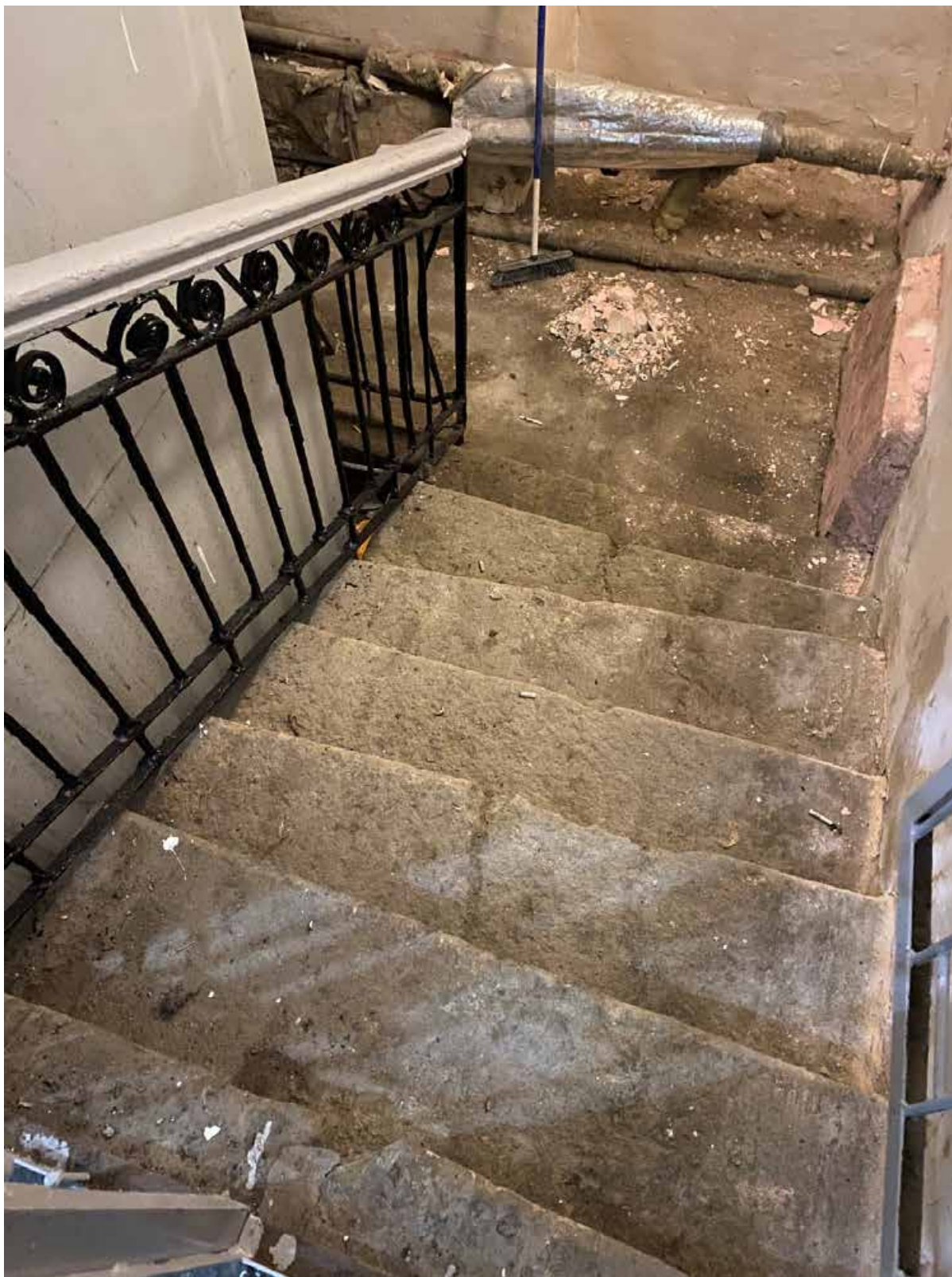
67. Площадка лестницы 4ЛК в уровне подвала
