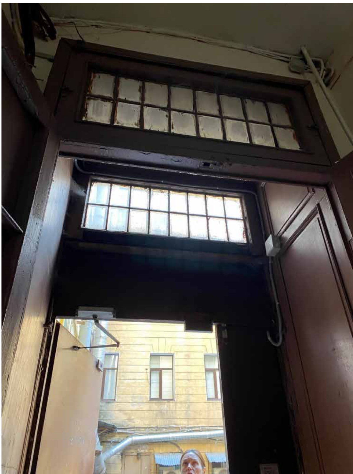
53. Фрагмент дверного заполнения тамбура лестницы 4ЛК
