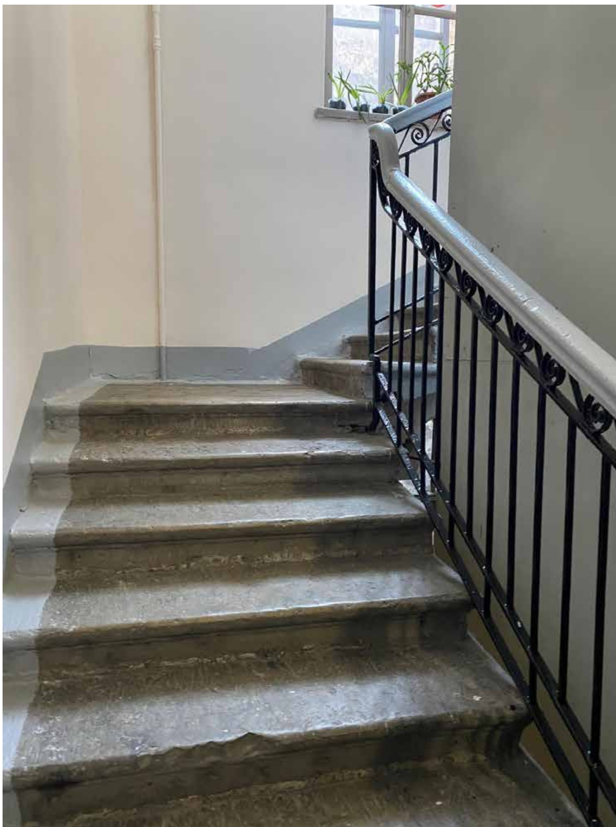
61. Общий вид лестницы 4ЛК в уровне 4-го этажа
