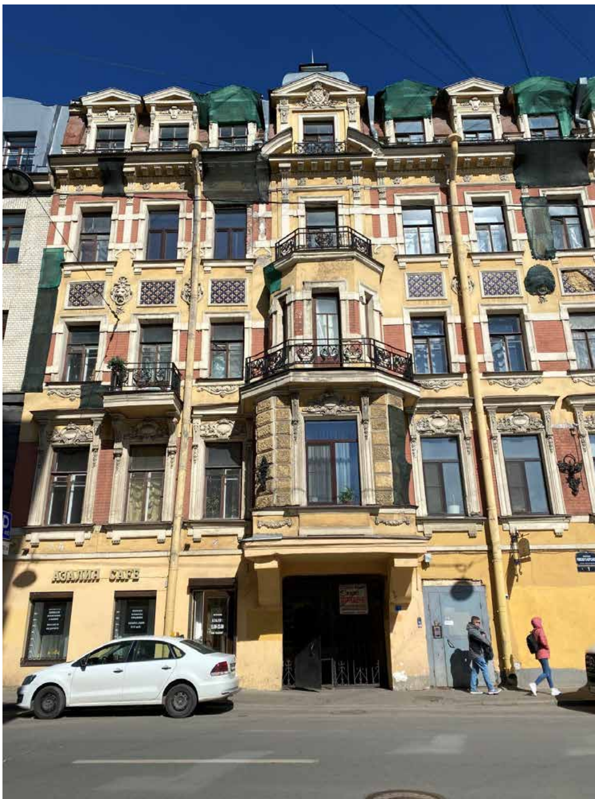
2. Фрагмент лицевого фасада по проспекту Римского-Корсакова
