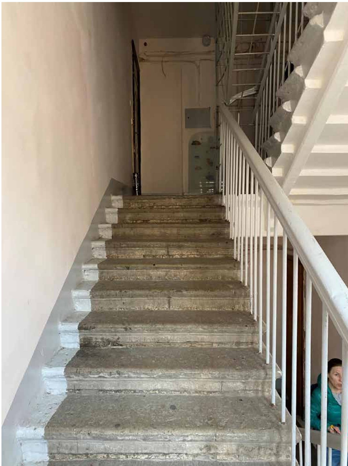
94. Общий вид лестницы БЛК в уровне 5-го этажа
