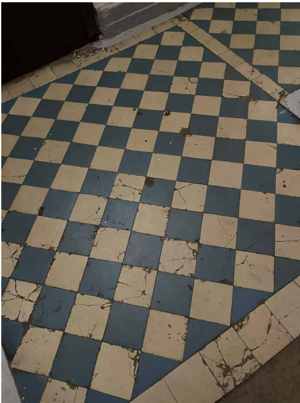
54. Покрытие пола лестницы 4ЛК в уровне 1-го этажа
