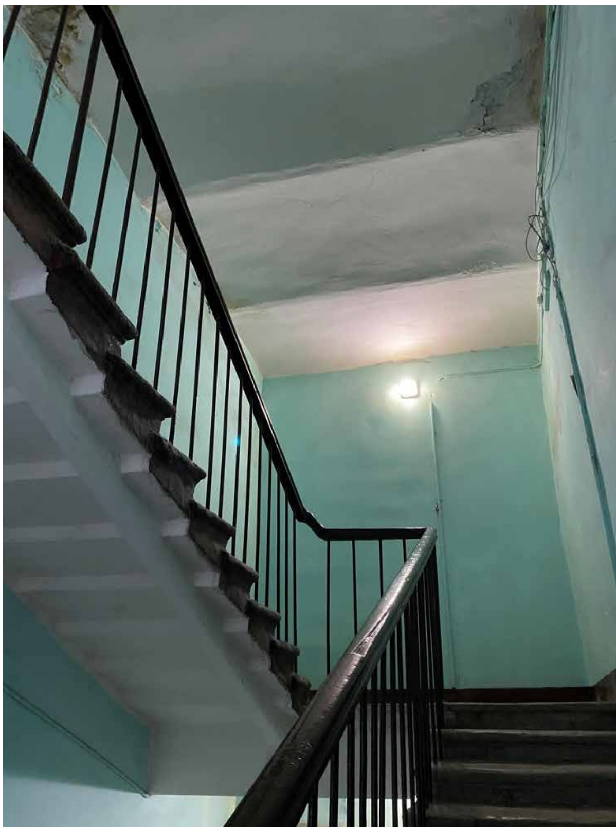
83. Перекрытие лестницы 5ЛК в уровне 5-го этажа
