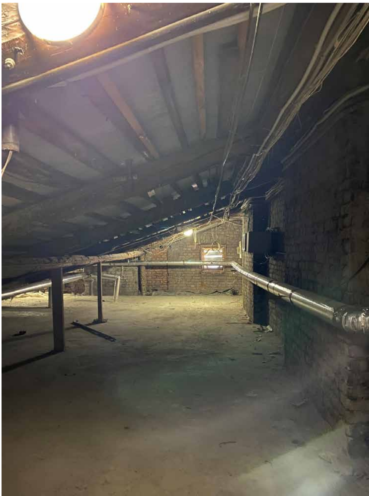
47. Общий вид чердачного помещения
