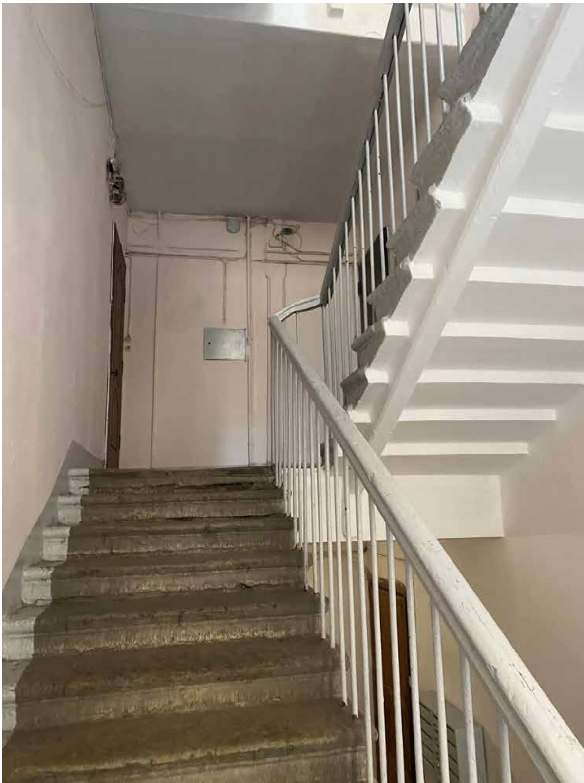
87. Общий вид лестницы БЛК в уровне 1-го этажа
