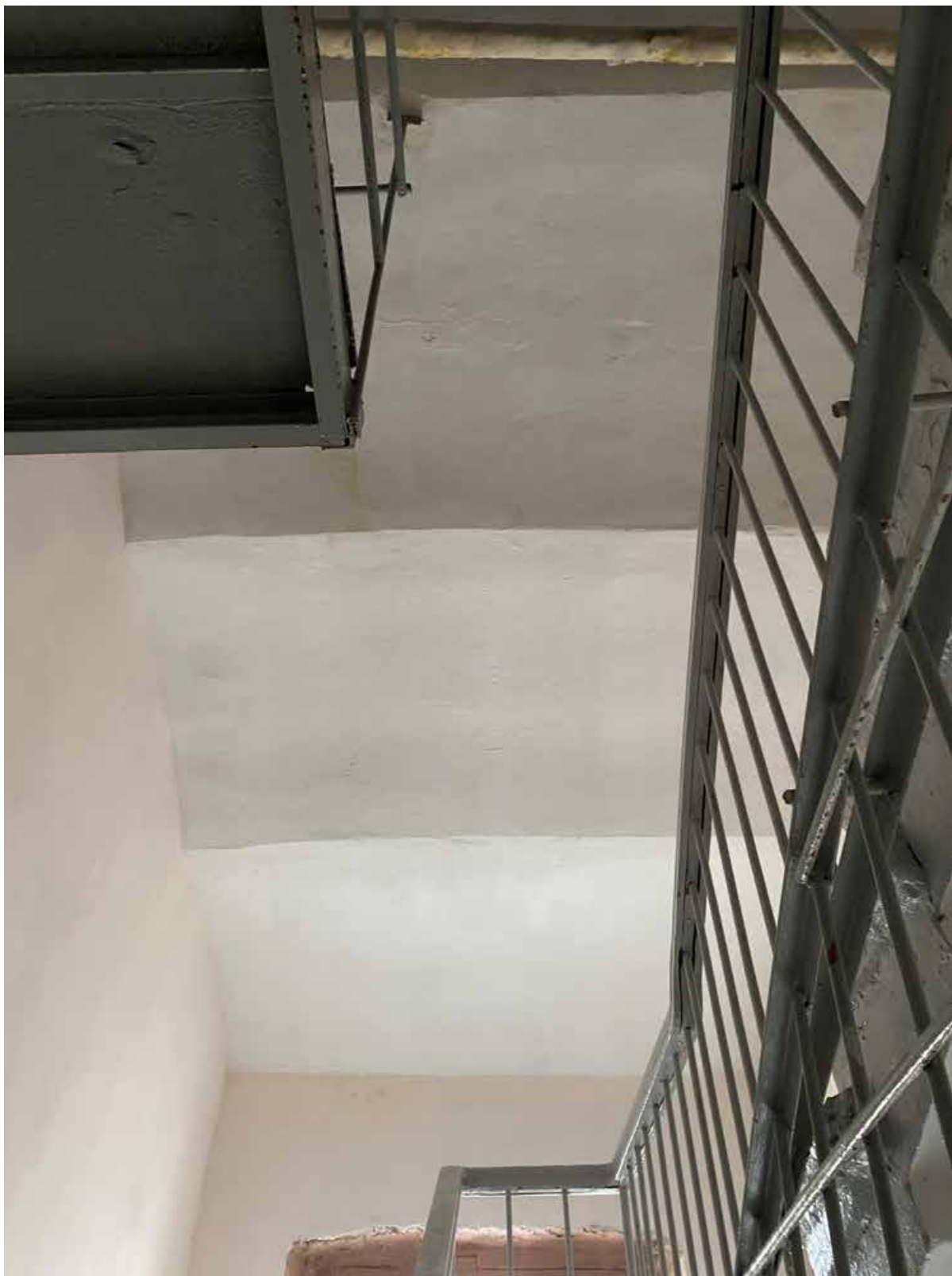
96. Перекрытие лестницы БЛК в уровне 5-го этажа
