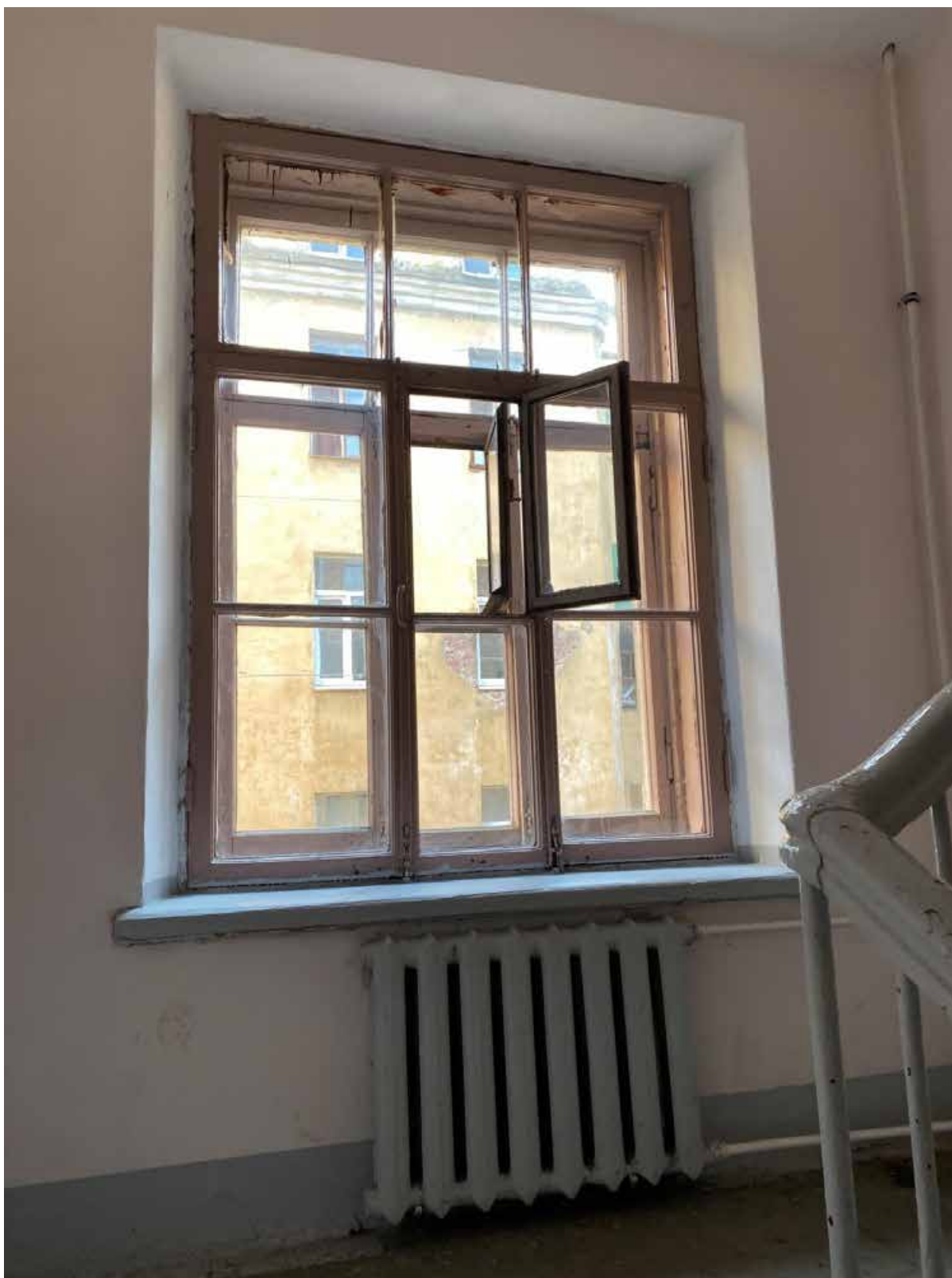
90. Общий вид лестницы БЛК в уровне 3-го этажа
