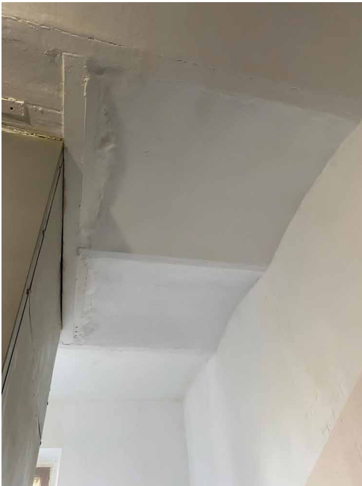
65. Верхнее перекрытие лестницы 4ЛК в уровне 5-го этажа
