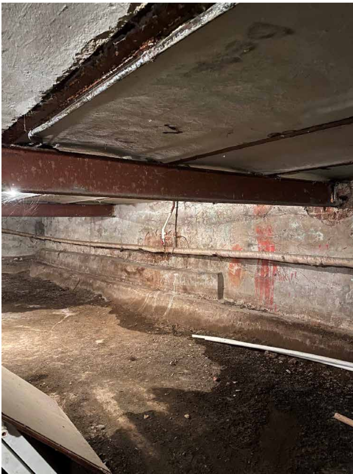
33.Общий вид подвального помещения
