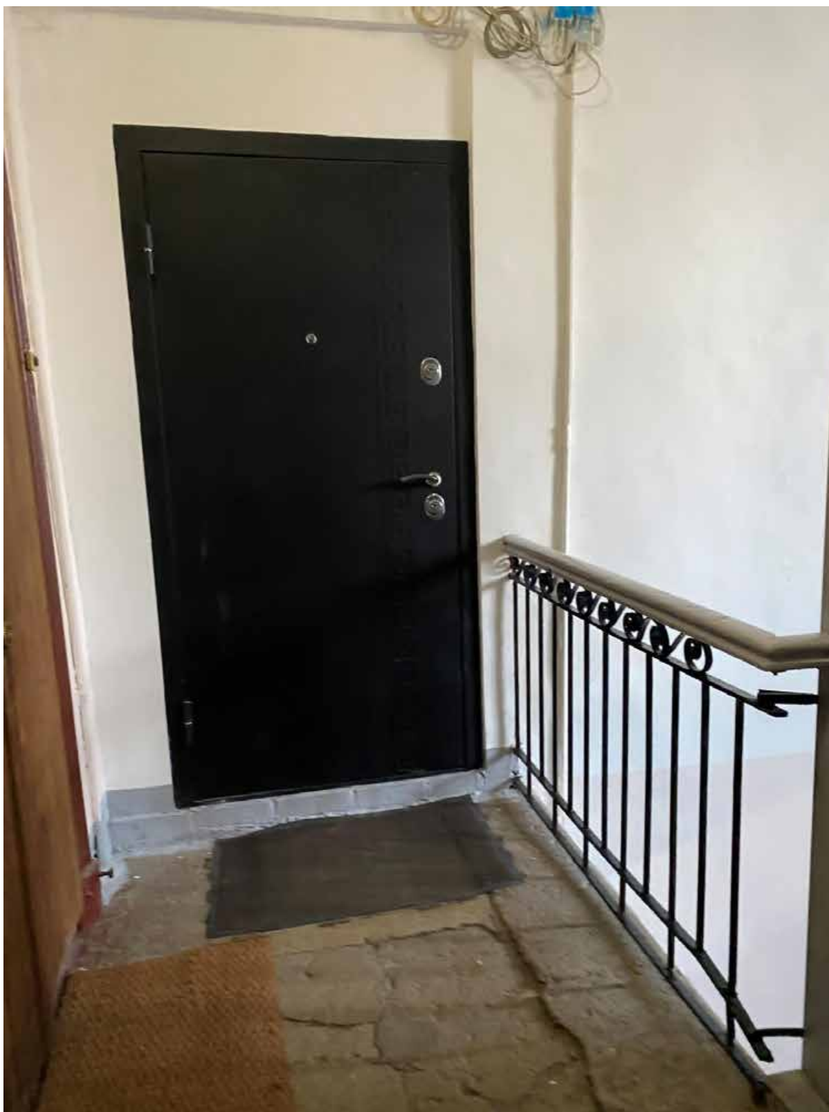
66. Площадка лестницы 4ЛК в уровне 5-го этажа
