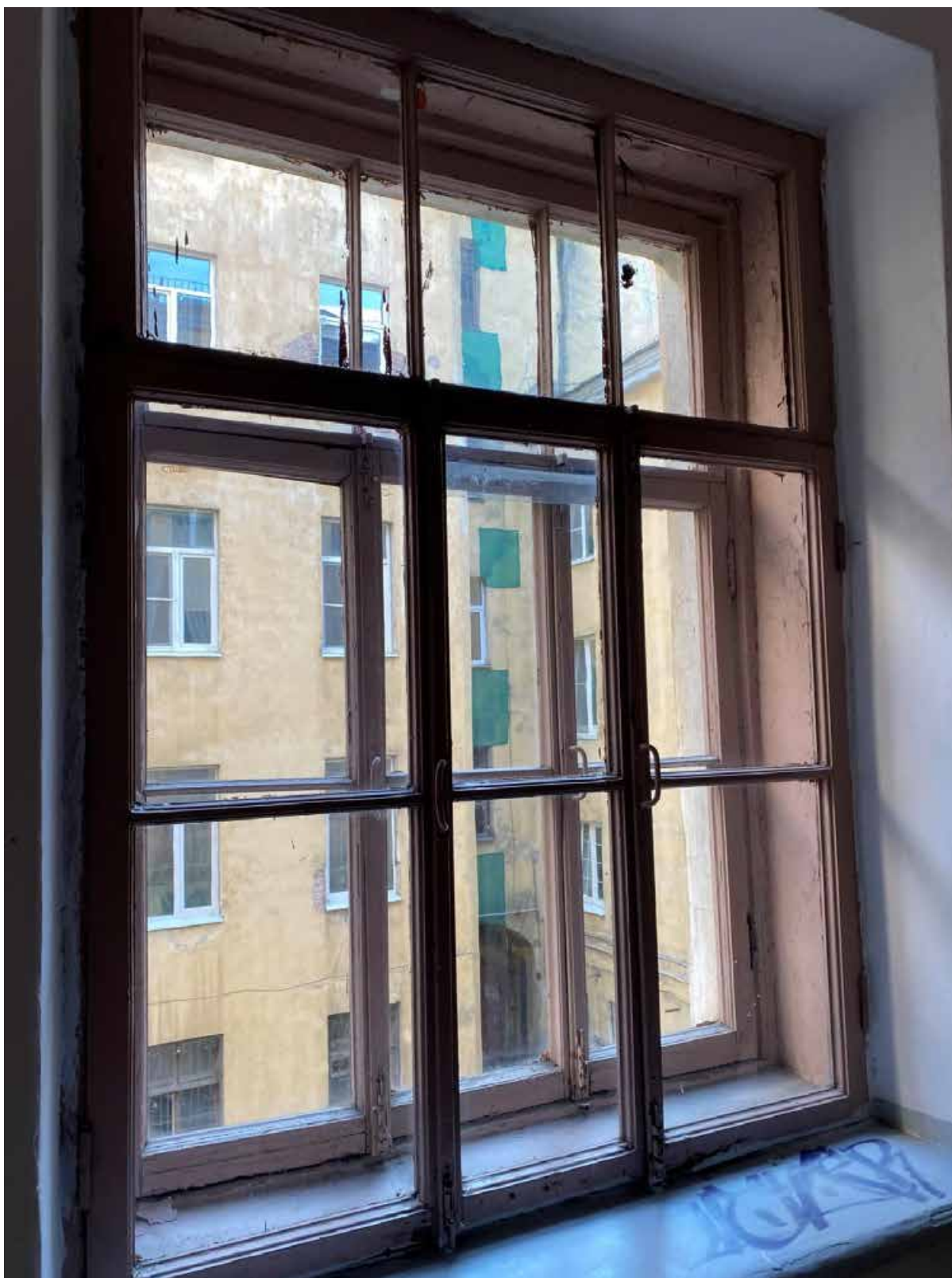
88. Оконное заполнение в части лестницы БЛК в уровне 2-го этажа
