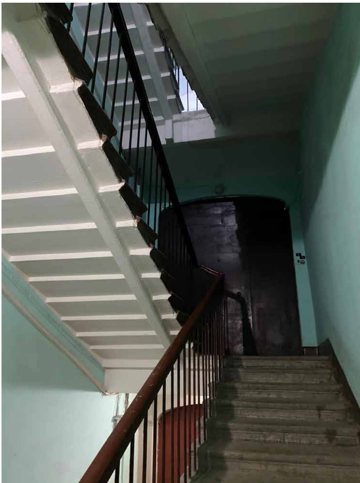
78. Общий вид лестницы 5JK в уровне 3-го этажа
