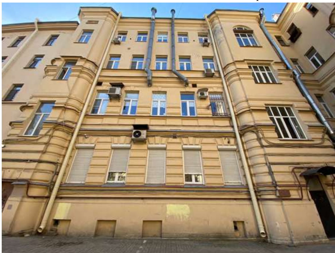
8. Фрагмент дворового фасада
