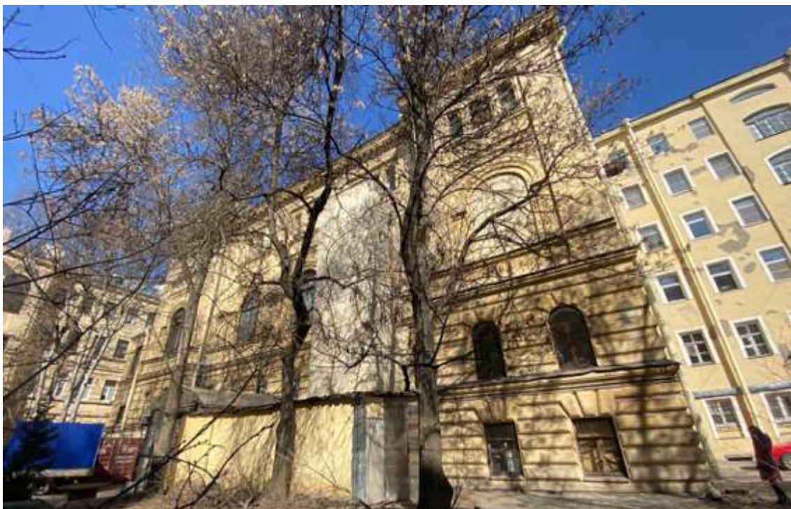
1. Вид на здание
