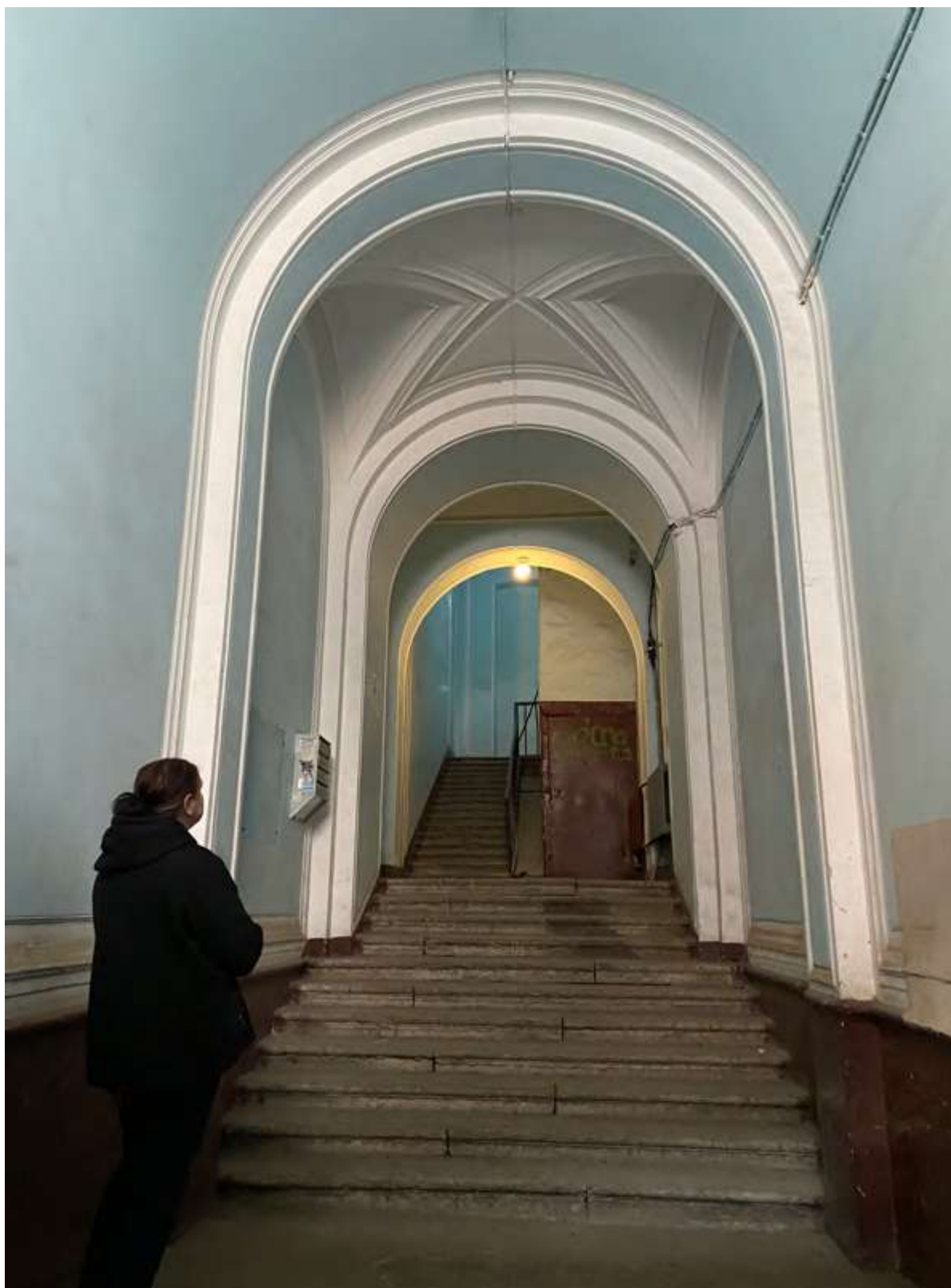
18. Вестибюль лестницы 1 ЛК
