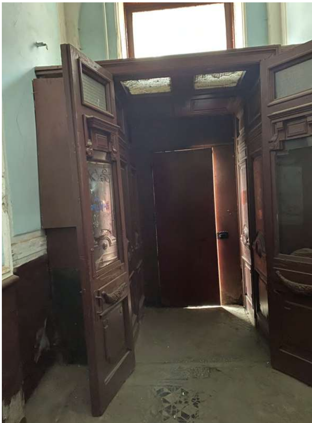
16. Тамбур лестницы 1 ЛК
