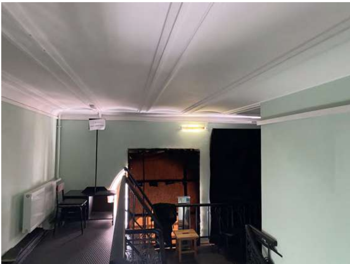
12. Лестница на балкон зрительного зала
