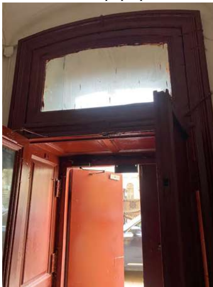
30. Тамбур лестницы 12ЛК
