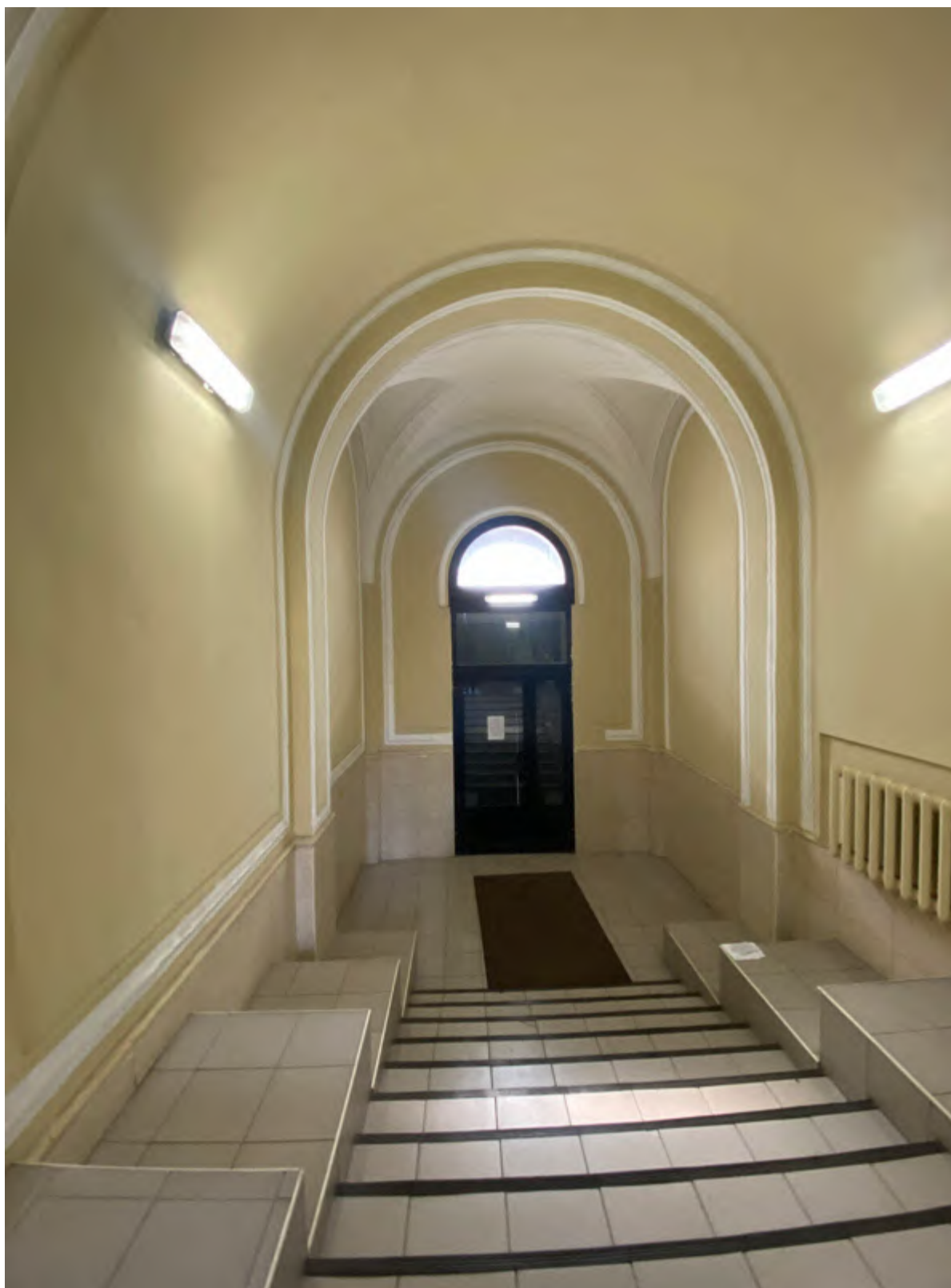
28. Вестибюль лестницы 3 ЛК
