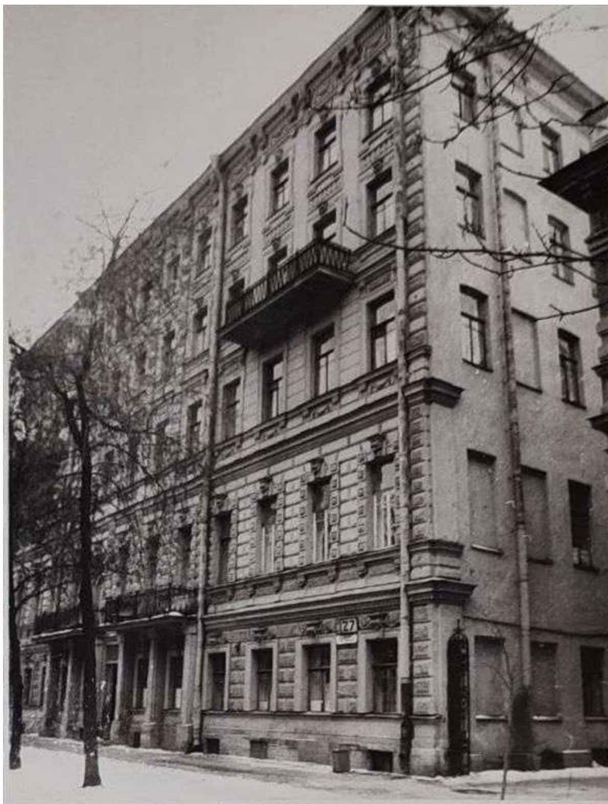
127. Фрагмент фасада. 1995 г. Архив КГИОП п. 950-VI-14 А-936
