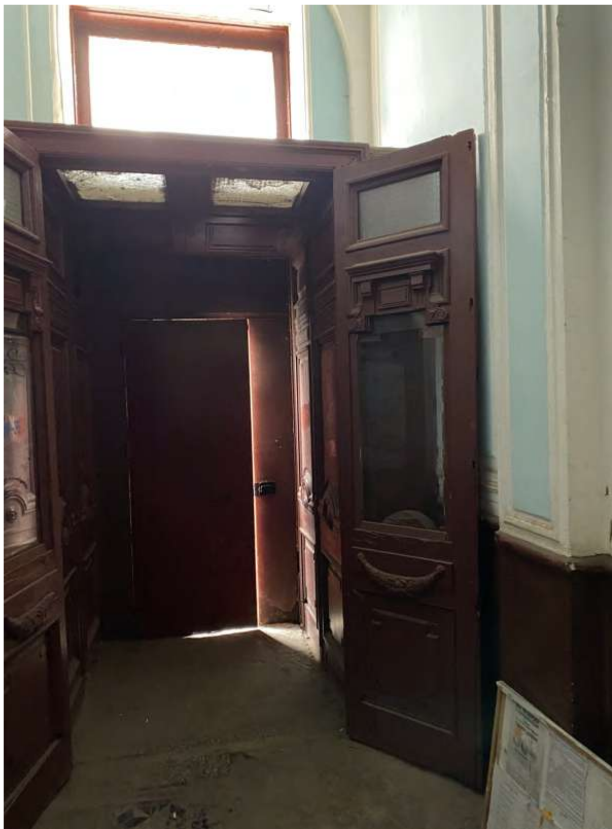
17. Тамбур лестницы 1 ЛК
