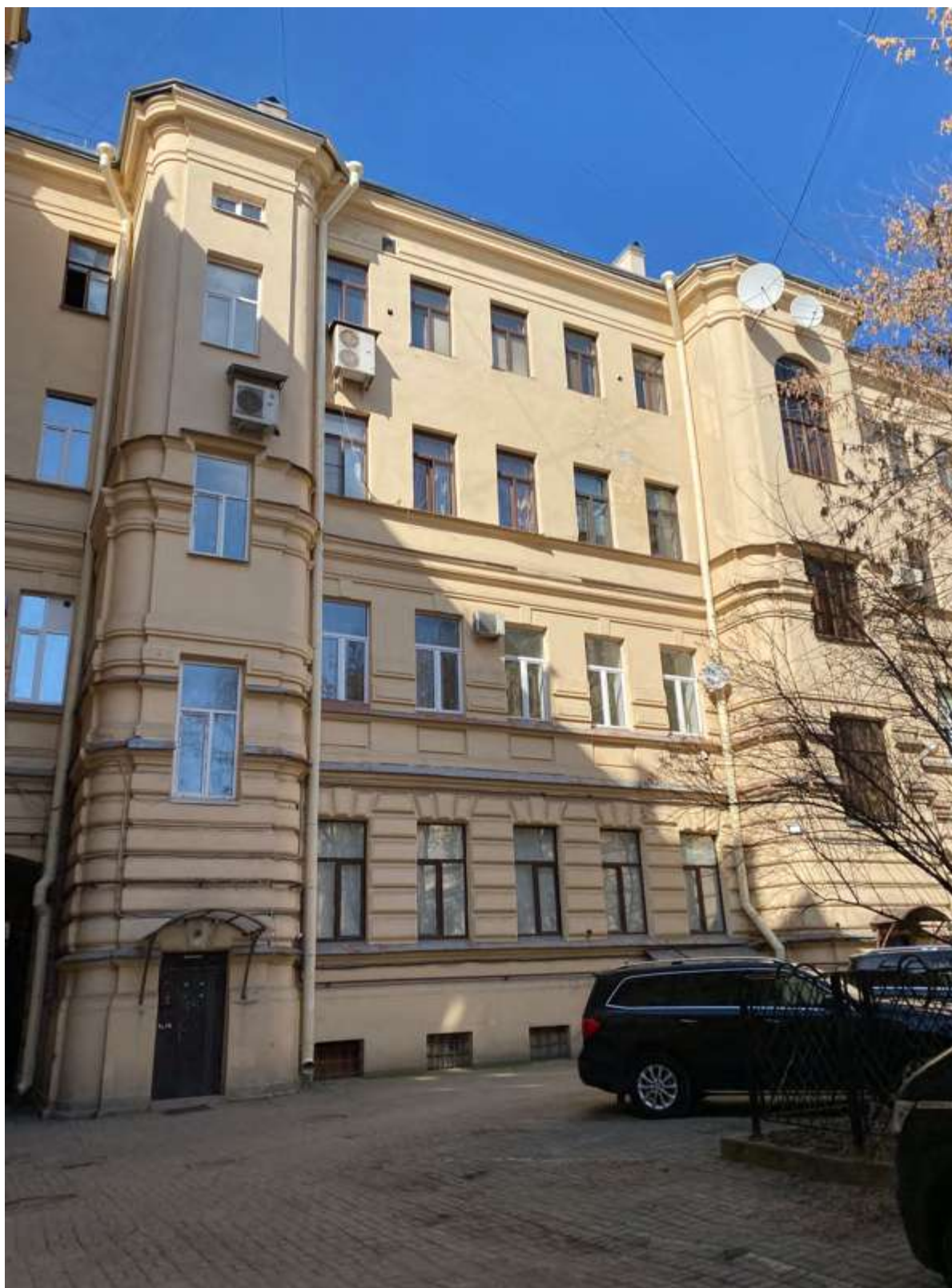
11. Фрагмент дворового фасада
