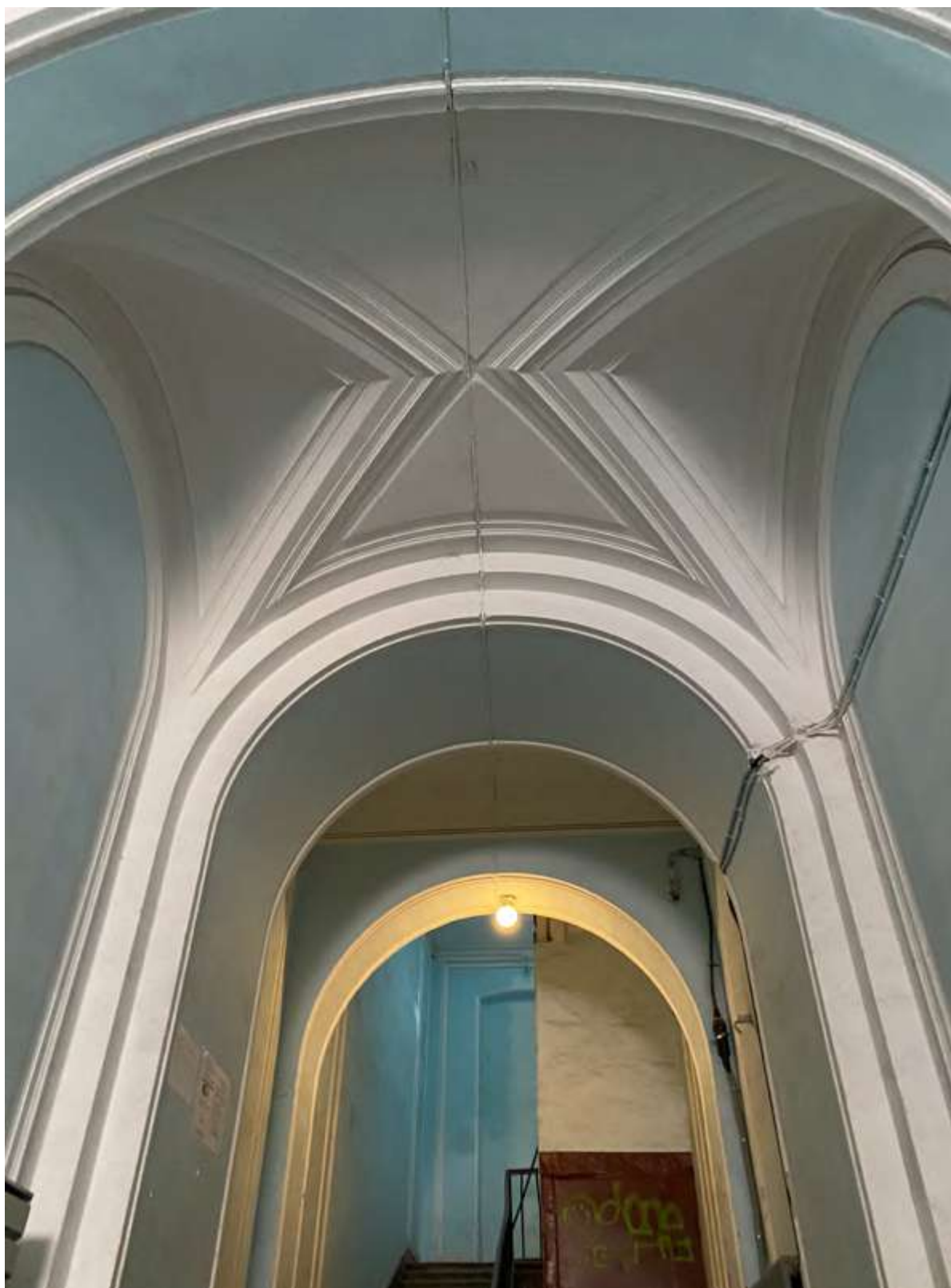
19. Вестибюль лестницы 1 ЛК
