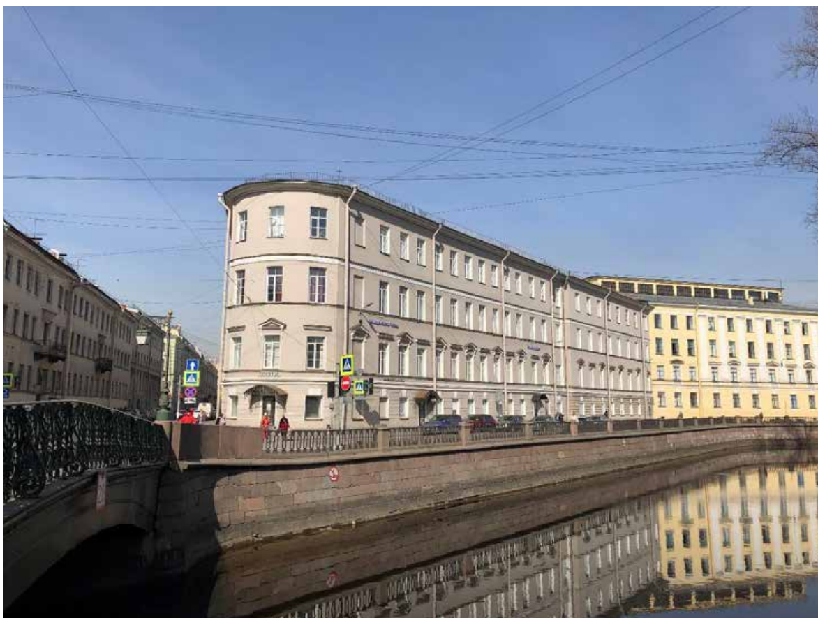
Фото 3. Вид на объект культурного наследия с набережной канала Грибоедова.
