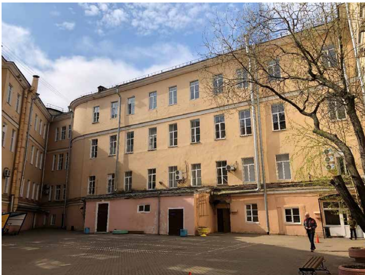
Фото 9. Вид на дворовой фасад.
