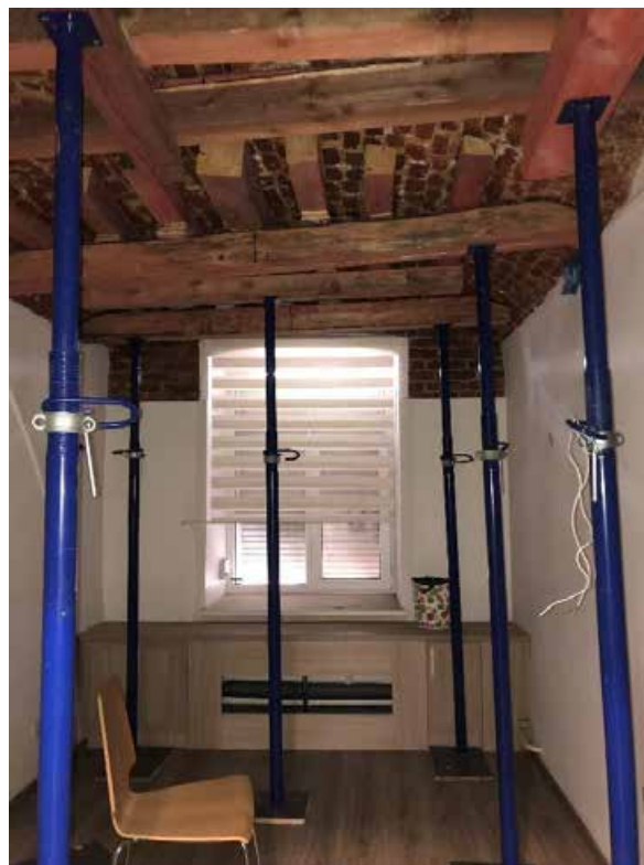
Фото 30. 1 этаж. Помещение № 8 (4-Н).
