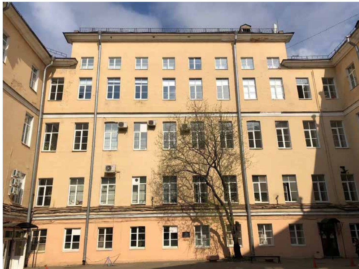
Фото 12. Вид на дворовой фасад.
