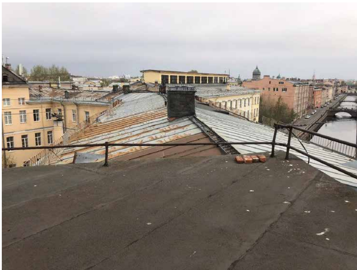
Фото 119. Вид на крышу здания.
