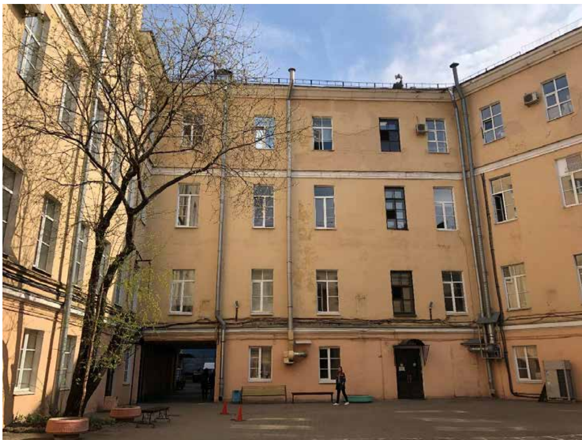
Фото 11. Вид на дворовой фасад.
