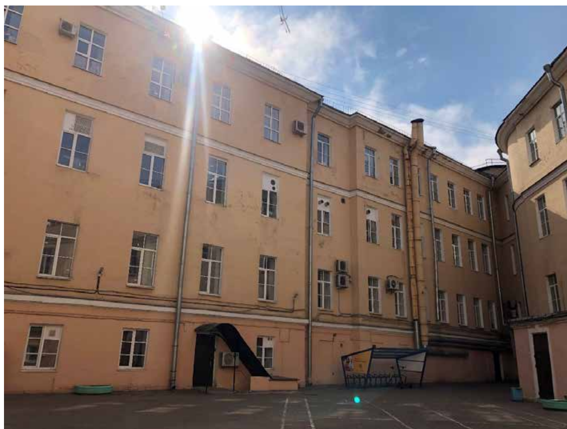
Фото 10. Вид на дворовой фасад.
