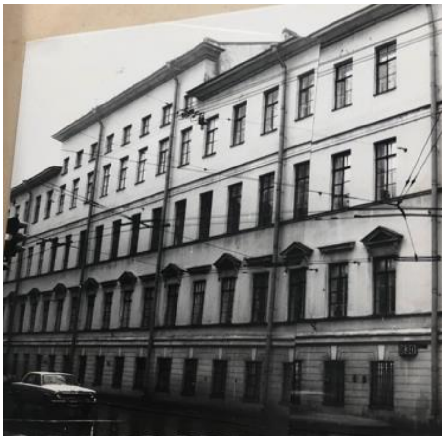
Илл. 19. Фасад по Казанской ул. Дата: 1985 г. Источник: отчет «Инженерное обследование строительных конструкций Учебного корпуса № 2 по переулку Гривцова, дом № 14», предоставленный администрацией ИТМО.
