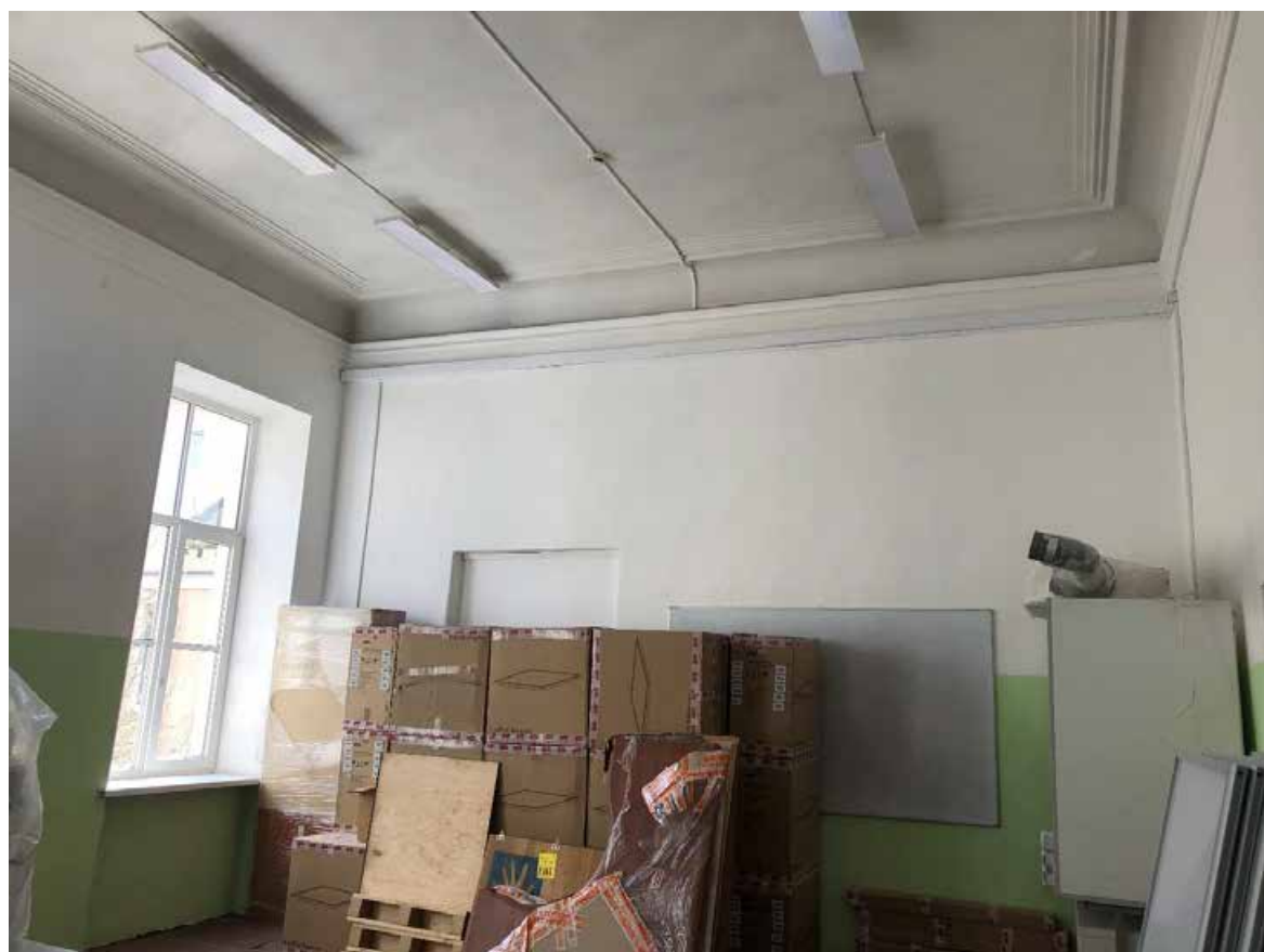
Фото 88. 3 этаж. Помещение № 12 (12-Н).
