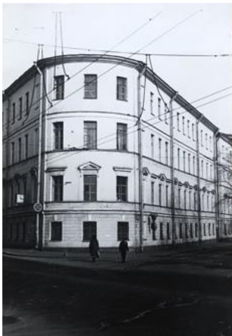
Илл. 21. Фасад по наб. канала Грибоедова и пер. Гривцова. Дата: 1985 г. Источник: отчет «Инженерное обследование строительных конструкций Учебного корпуса № 2 по переулку Гривцова, дом № 14», предоставленный администрацией ИТМО.
