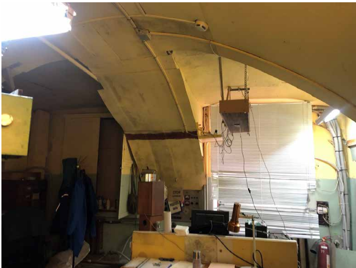
Фото 22. 1 этаж. Помещение № 2 (33-Н).
