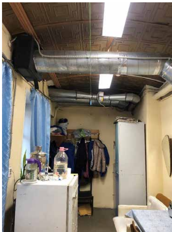
Фото 21. 1 этаж. Помещение № 2 (22-Н).
