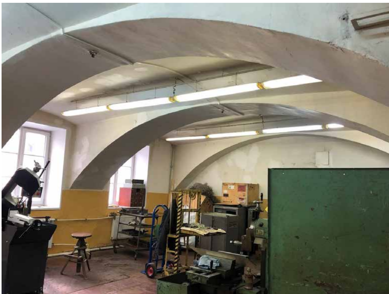
Фото 35. 1 этаж. Помещение № 20 (1-Н).
