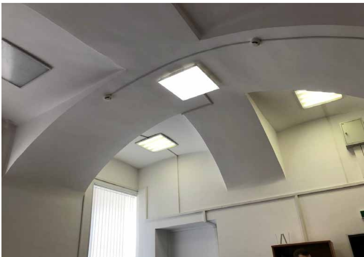
Фото 49. 2 этаж. Помещение № 5 (7-Н).
