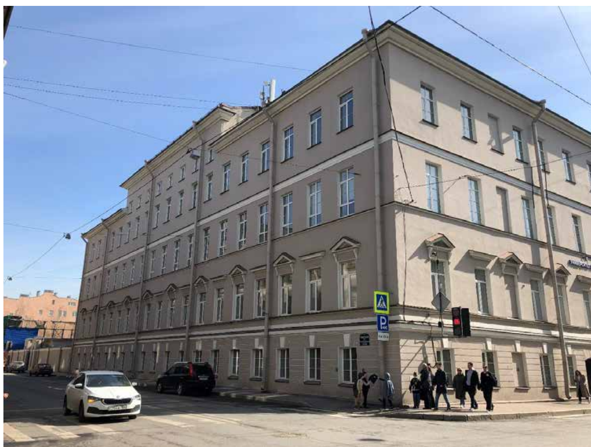
Фото 6. Вид на лицевой фасад по Казанской улице.
