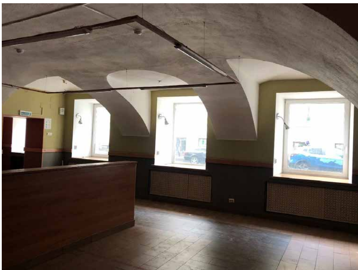
Фото 19. 1 этаж. Помещение № 20 (6-Н).
