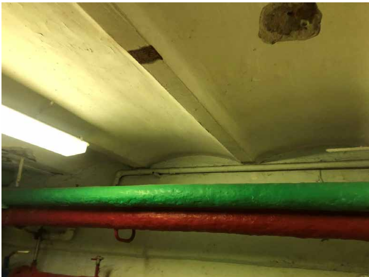
Фото 4. Прусские своды в помещении подвала.
