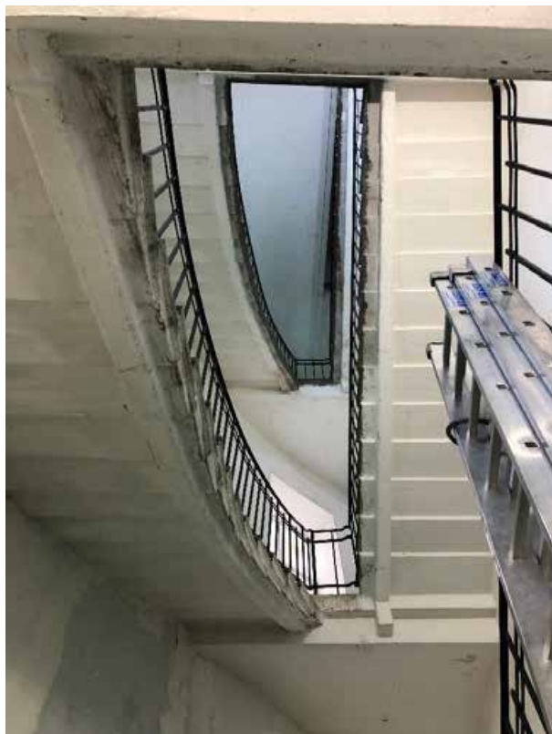
Фото 23. Вид на лестницу 5 ЛК.
