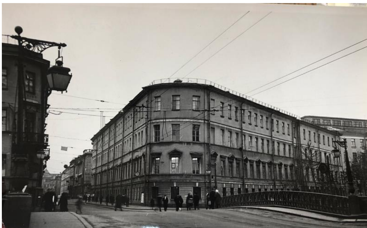
Илл. 17. Вид на здание на углу пересечения переулка Гривцова и набережной канала Грибоедова. Дата: 1967 г. Источник: архив КГИОП.
