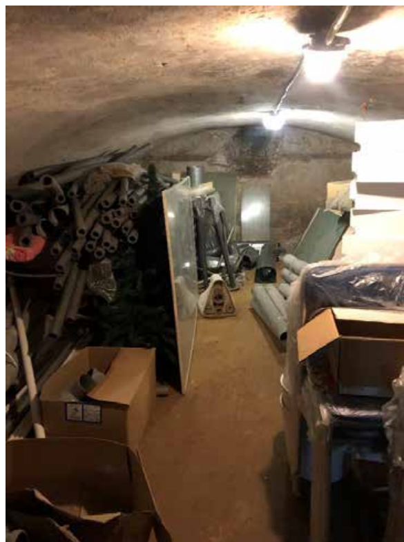
Фото 2. Вид на помещение подвала.
