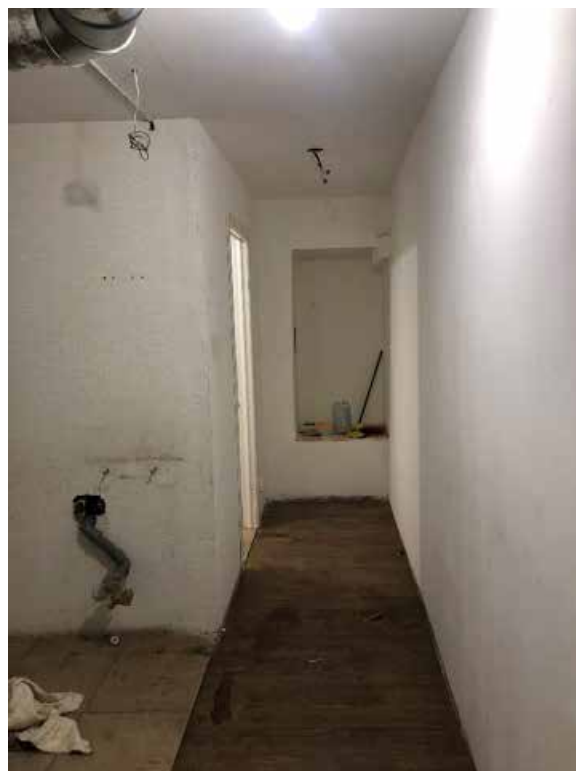
Фото 10. 1 этаж. Помещение № 4 (50-Н).
