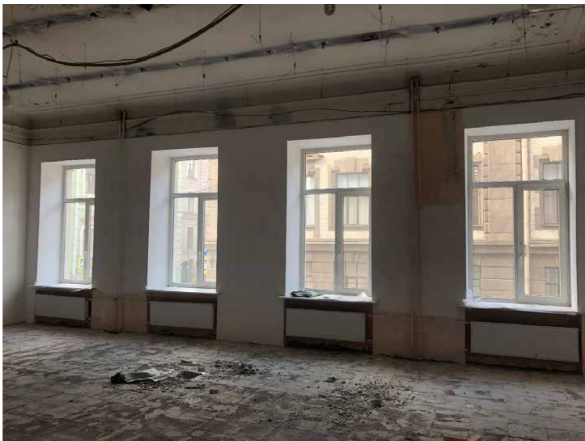
Фото 48. 2 этаж. Помещение № 32 (7-Н).
