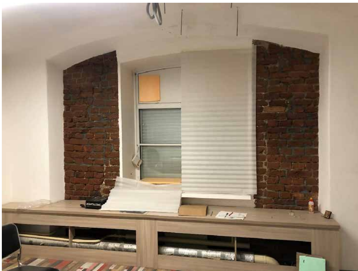
Фото 32. 1 этаж. Помещение № 12 (4-Н).
