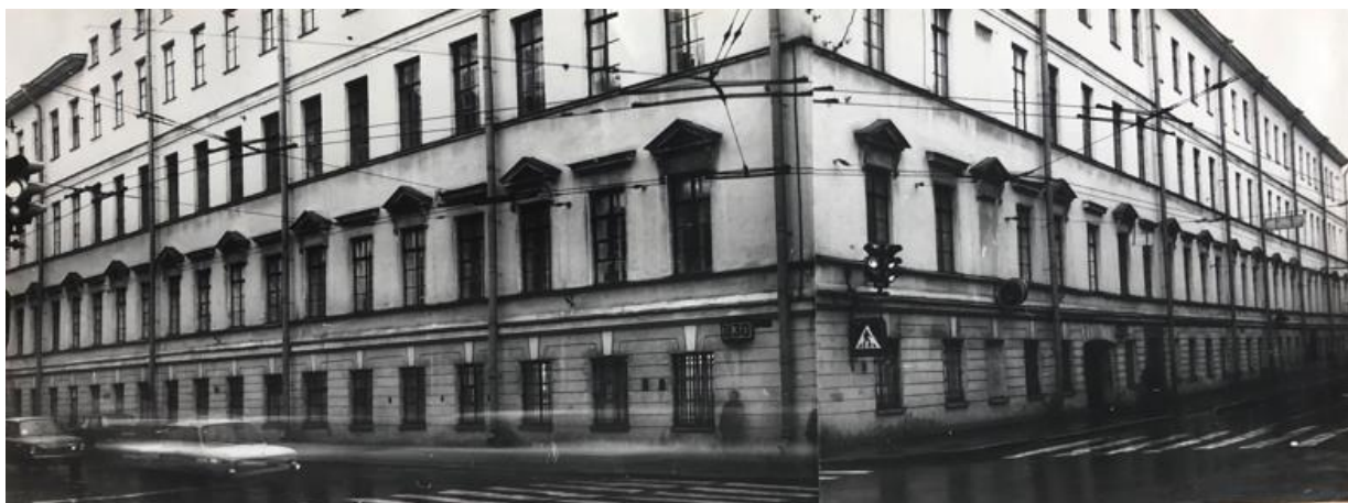
Илл. 20. Фрагмент фасадов на пересечении пер. Гривцова и ул. Казанской. Дата: 1985 г. Источник: отчет «Инженерное обследование строительных конструкций Учебного корпуса № 2 по переулку Гривцова, дом № 14», предоставленный администрацией ИТМО.
