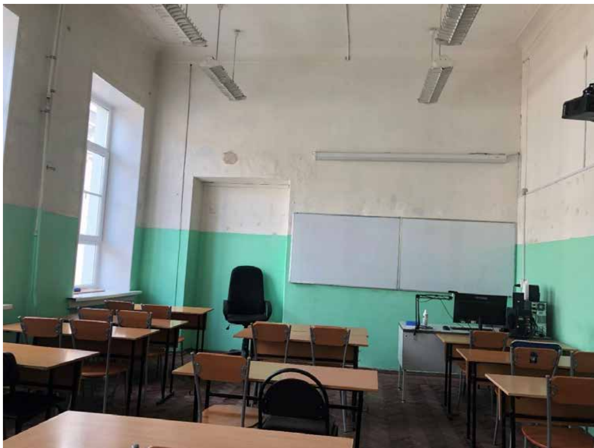
Фото 87. 3 этаж. Помещение № 3 (12-Н).
