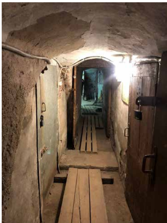
Фото 1. Вид на помещение подвала.
