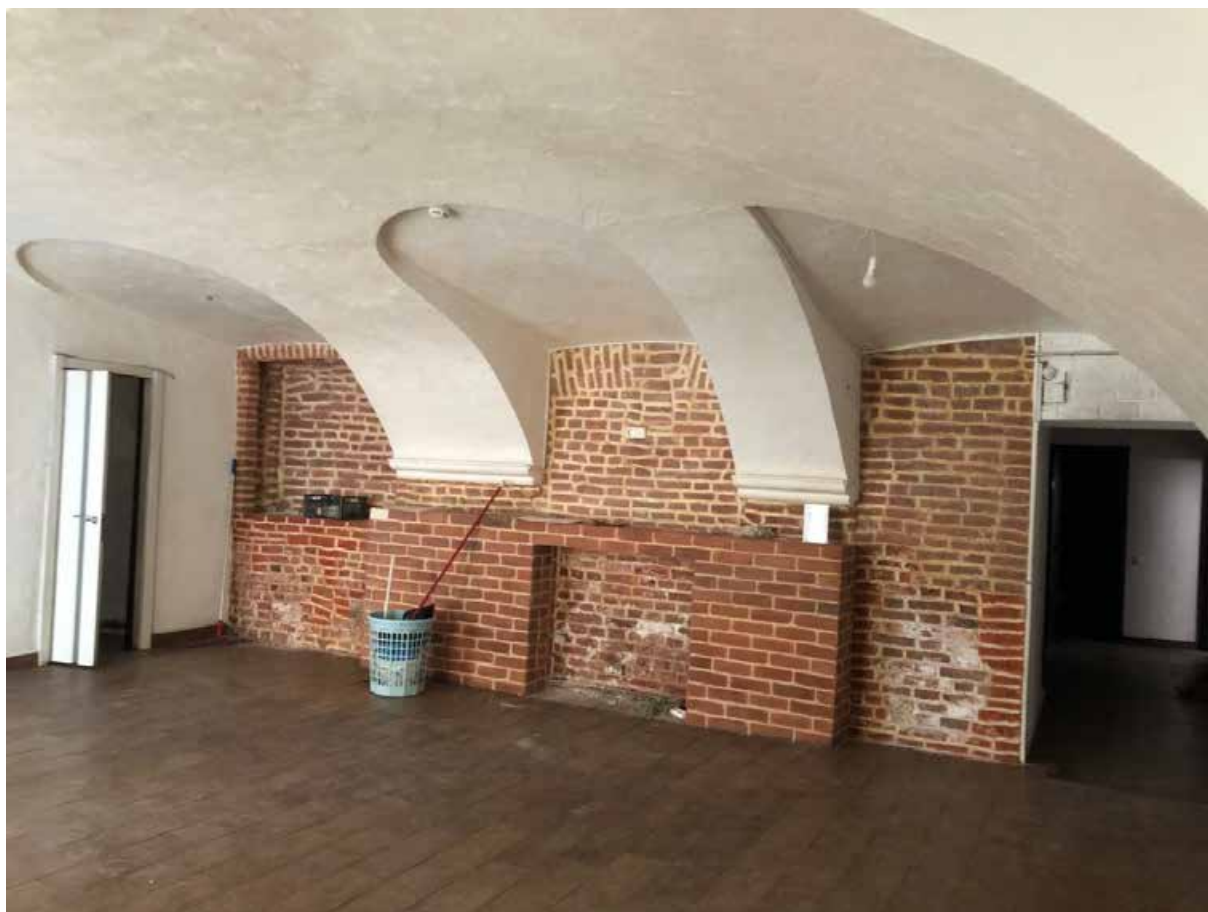
Фото 14. 1 этаж. Помещение № 1 (5-Н).
