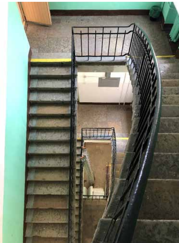
Фото 24. Вид на лестницу 5 ЛК.
