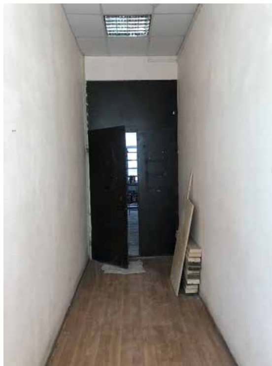
Фото 45. 2 этаж. Помещение № 38 (7-Н).
