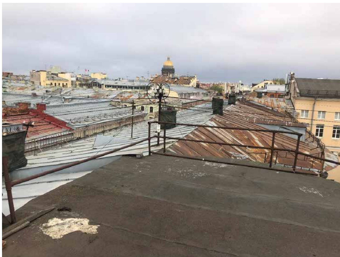
Фото 120. Вид на крышу здания.
