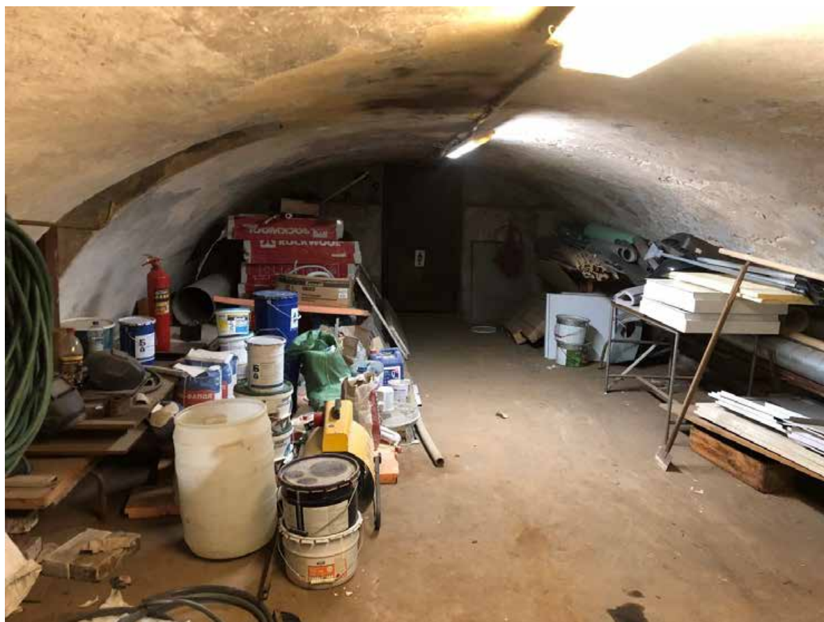
Фото 3. Вид на помещение подвала.
