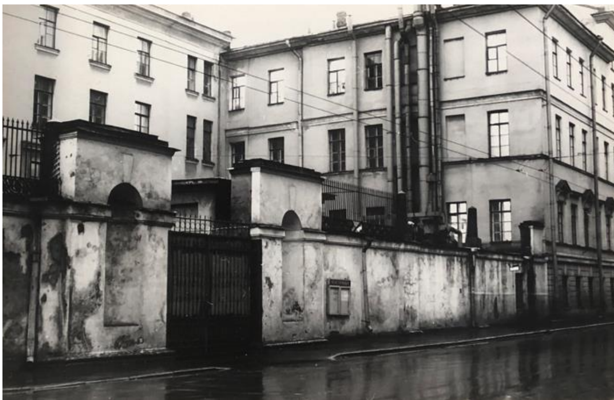
Илл. 23. Каменный забор исследуемого здания по ул. Казанской. Дата: 1985 г. Источник: отчет «Инженерное обследование строительных конструкций Учебного корпуса № 2 по переулку Гривцова, дом № 14», предоставленный администрацией ИТМО.
