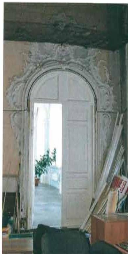
оформление стен – пилястры коринфского ордера, каннелированные в нижней части, декорированные рокайлями, волотами, креповки, профилированные архивольты с лепными композициями с рокайлями, картушами, херувимами, профилированные фигурные рамы, в том числе с лепными композициями барочного характера;
