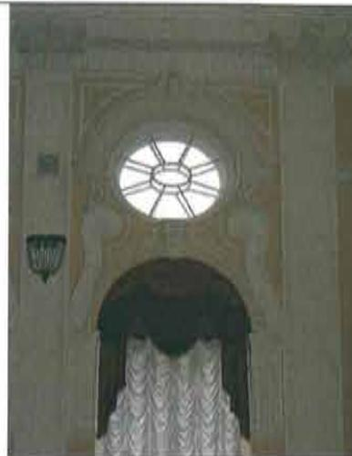
профилированный орнаментированный карниз, переходящий в архивольт окон второго света, расположенных в овальных нишах, — с замковым камнем в виде картуша с маскаронном и растительными завитками;
