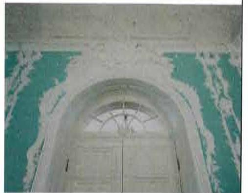
дверное заполнение – материал (дерево), конструкция (двустворчатое, филенчатое, с полуциркульной остекленной фрамугой), рисунок заполнения;
