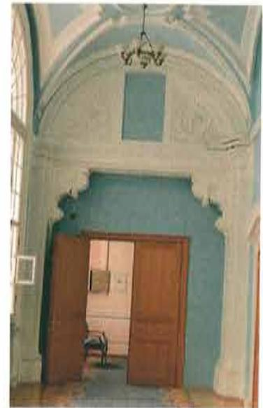
оформление торцевой стены – местоположение (6 подъезд, пом. ХХІХ) два кронштейна, декорированные акантовыми листьями и растительными гирляндами; оформление поля потолка между кронштейнами двумя профилированными филеками и круглой цветочной розеткой; профилированный карниз; в тимпане арочного завершения – две лепные композиции из растительных завитков в профилированном обрамлении;
