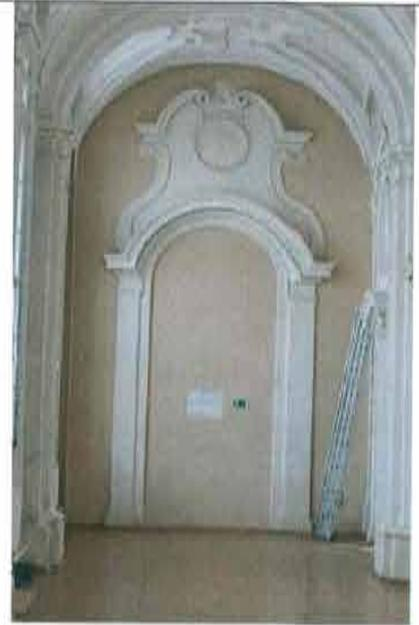
порталы проемов с лучковым завершением - гладкие пилястры, поддерживающие профилированный карниз; профилированные наличники прямоугольных дверных проемов;
