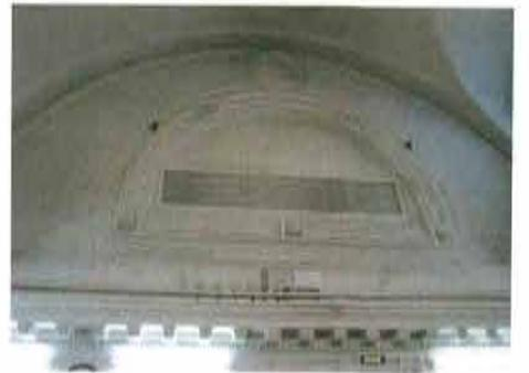
профилированный карниз с большим выносом, поясом иоников, на модульонах, декорированных акантовым листом;
