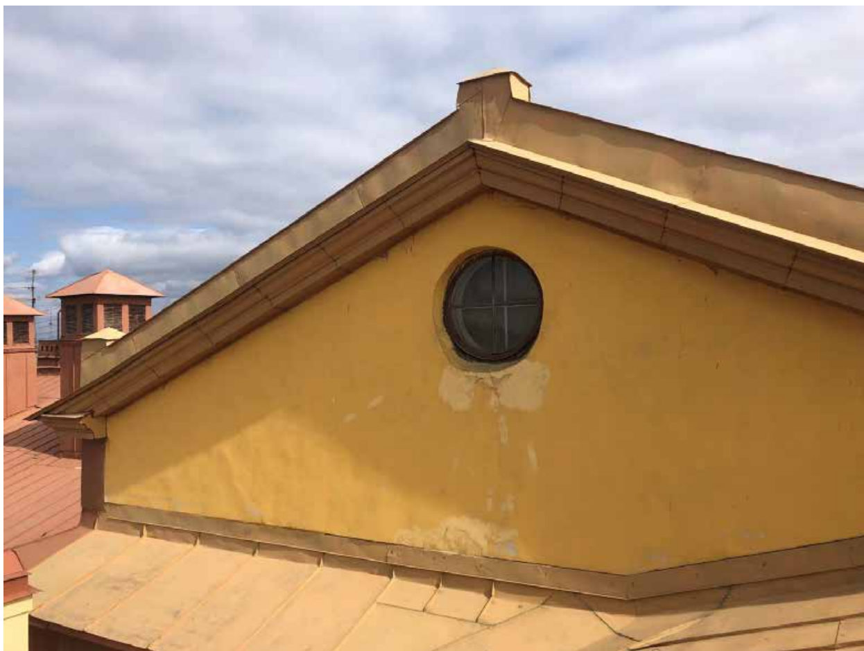
Фото 4. Брандмаурная стена объекта культурного наследия.
