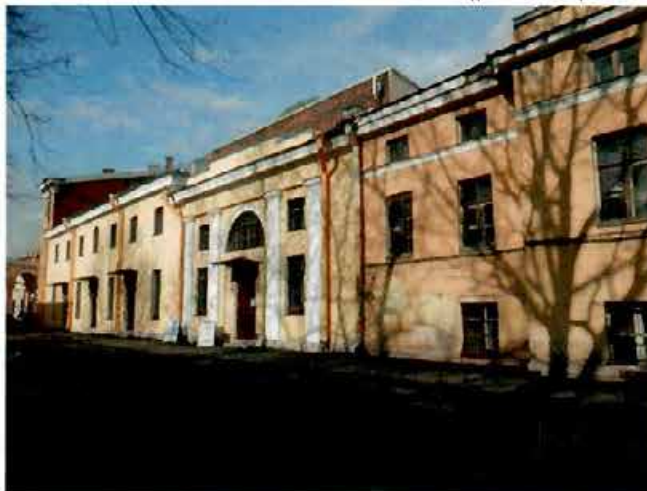
9. Восточный дворовый фасад (флигели)
