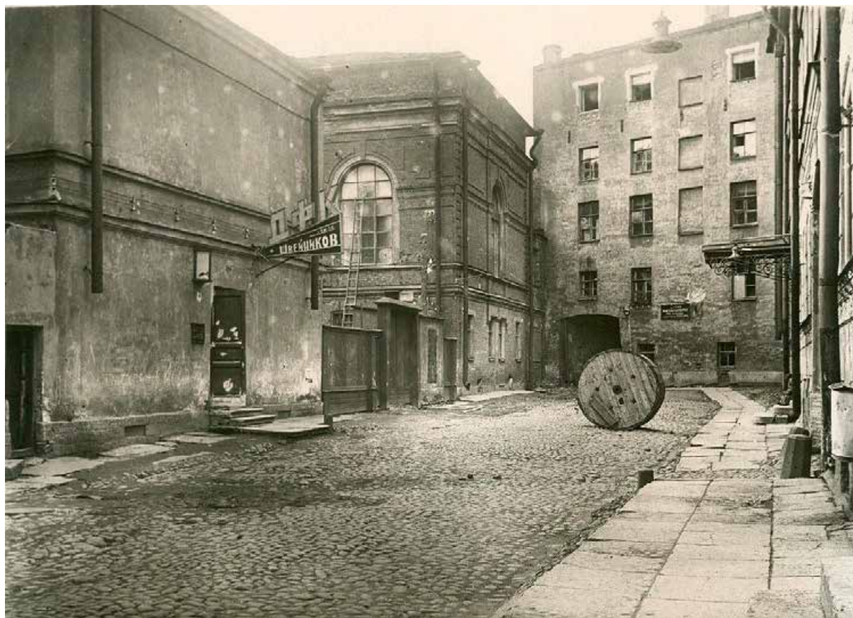
Илл. 18. Вид на фасады флигелей Юсуповского дворца в переулке Пирогова. 1935 г. // Электронный ресурс: https://pastvu.com/
