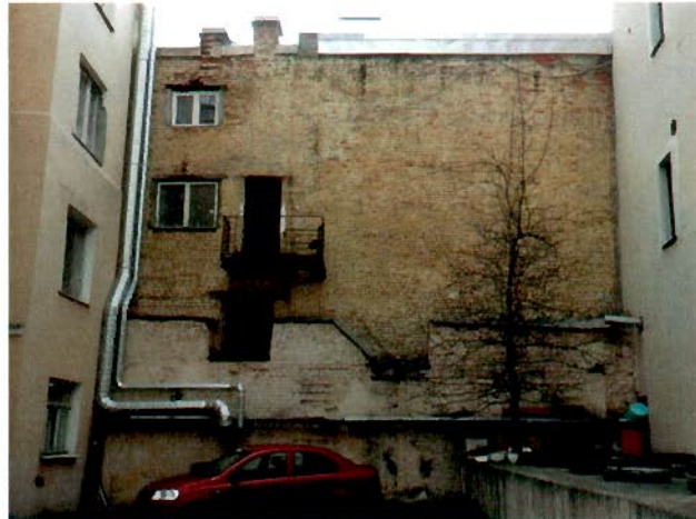
4. Восточный дворовый фасад (флигели)
