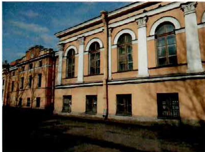
10. Восточный дворовый фасад (флигели)
