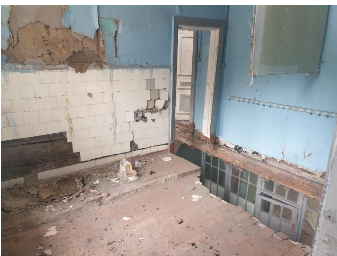
24. «Финская усадьба Заеца», Санкт-Петербург, город Зеленогорск, Приморское шоссе, дом 597, литера К. Помещение второго этажа. Общий вид. Фото 27.02.2023г.
