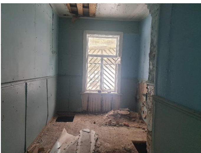
25. «Финская усадьба Заеца», Санкт-Петербург, город Зеленогорск, Приморское шоссе, дом 597, литера К. Помещение второго этажа. Общий вид. Фото 27.02.2023г.
