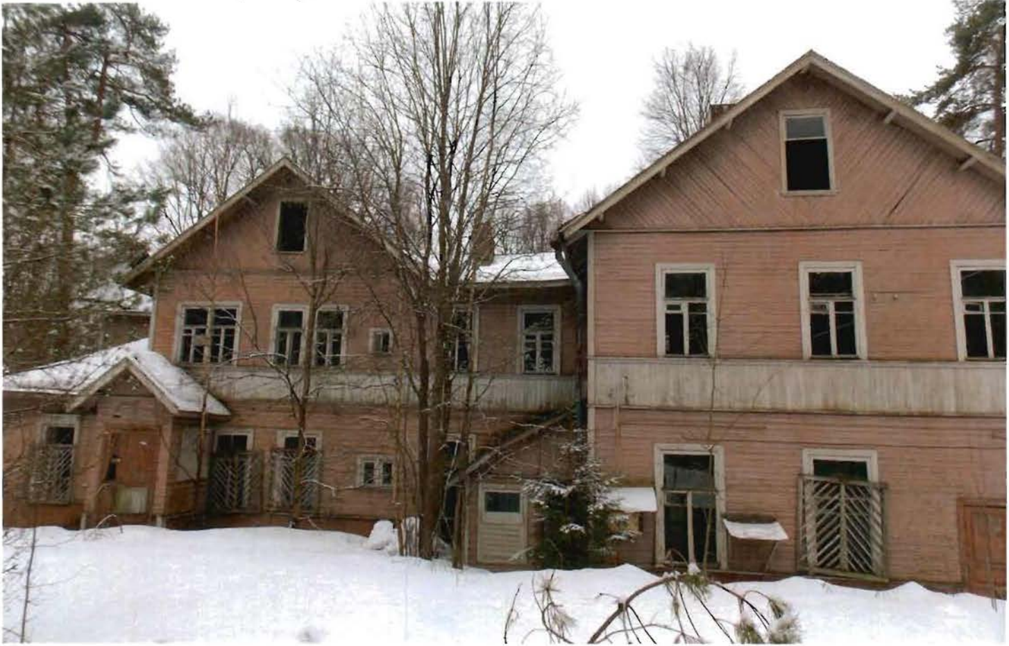
2. Северный фасад здания.
