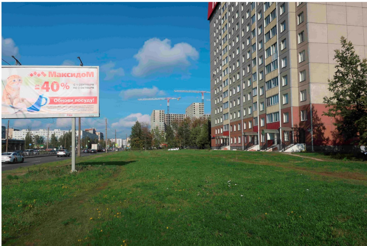
Точка фотофиксации 1. Проспект Большевиков в районе производства работ. Вид с Ю.
