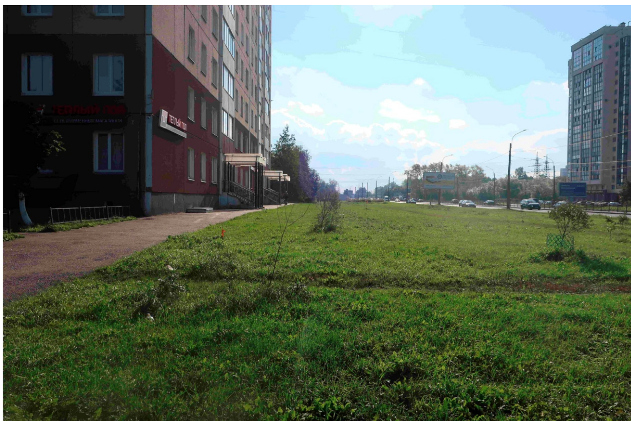
Точка фотофиксации 2. Проспект Большевиков в районе производства работ. Вид с С.
