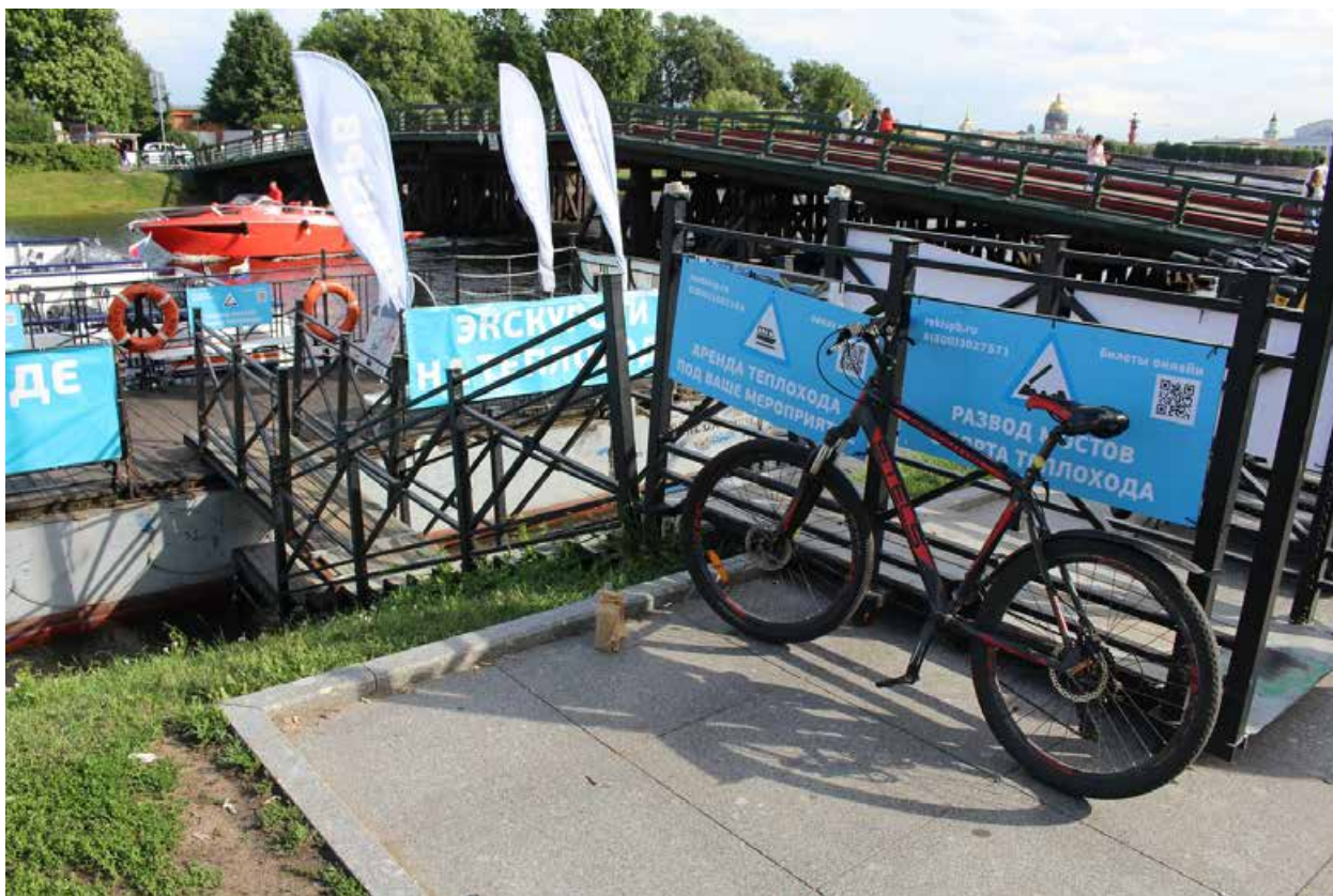
Фото 3. Вид на спуск-лестницу, ведущую к понтону на участке набережной Кронверкского пролива «Западный Артиллерийский мост – Кронверкский мост», литера А с запада.
