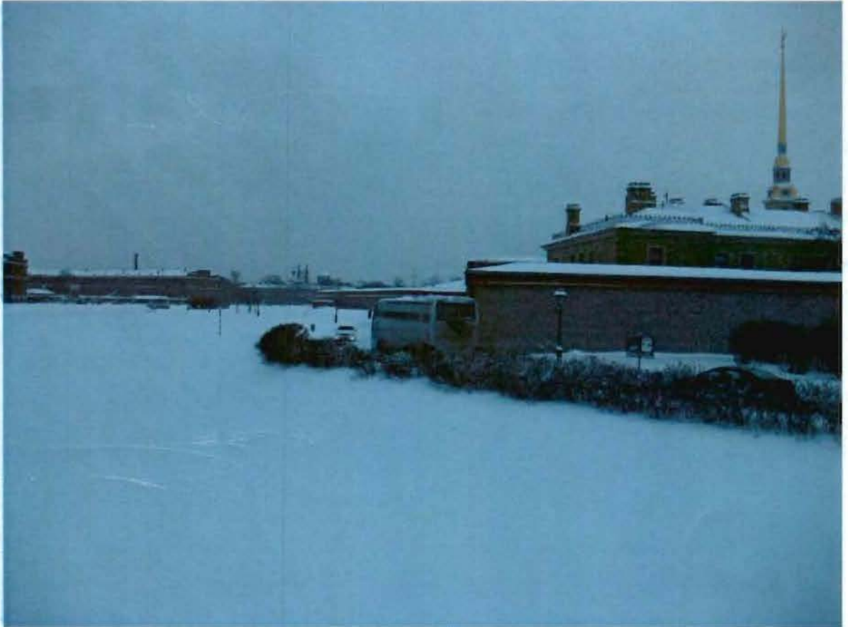
5. Левобережная набережная. Вид с Кронверкского моста
