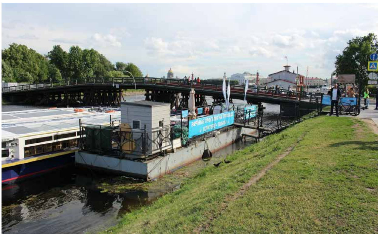
Фото 2. Вид на объект культурного наследия федерального значения «Набережные Кронверкского пролива» на участке набережной Кронверкского пролива «Западный Артиллерийский мост – Кронверкский мост», литера А с северо-востока.
