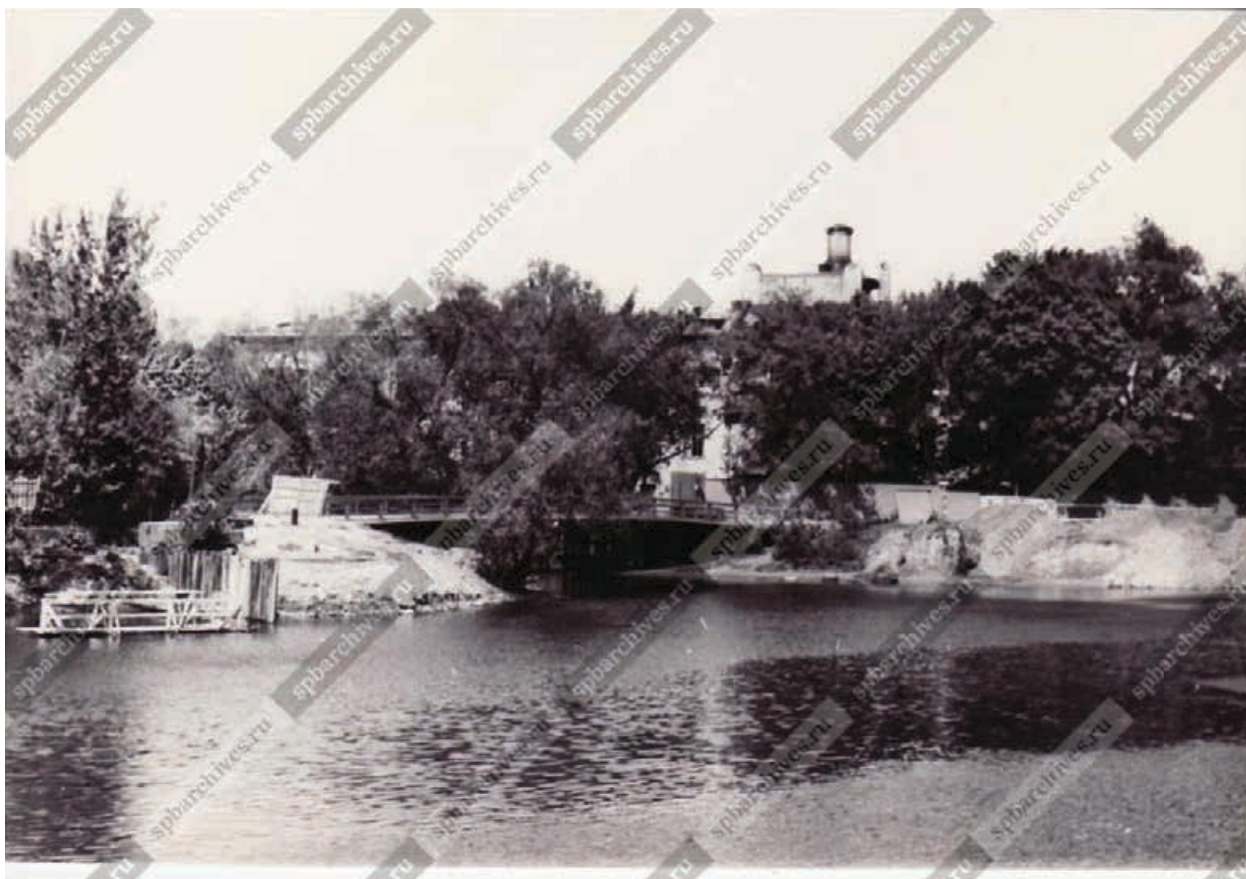
20. Вид с Кронверкского пролива на деревянный Западный Артиллерийский мост через Кронверкский проток, 1976 – ЦГАКФФД СПб – Фотодокумент Ар 215780
