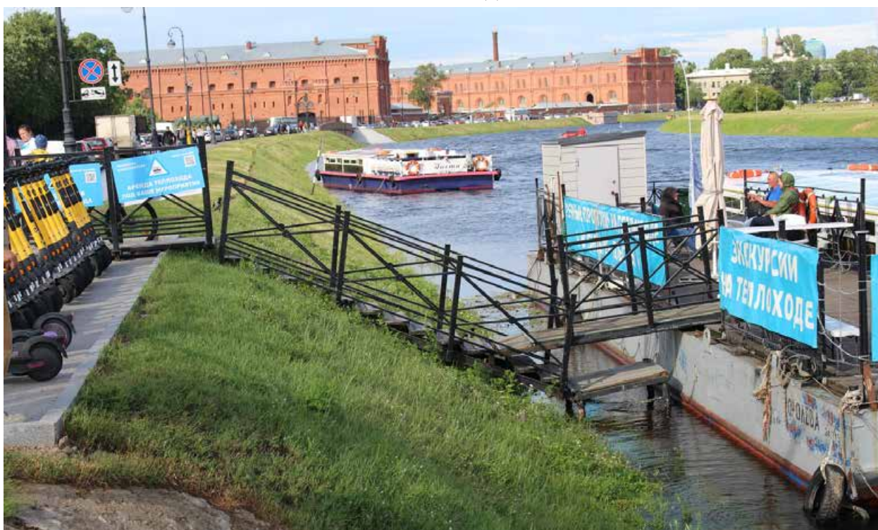
Фото 6. Вид на объект культурного наследия федерального значения «Набережные Кронверкского пролива» на участке набережной Кронверкского пролива «Западный Артиллерийский мост – Кронверкский мост», литера А с юго-запада.
