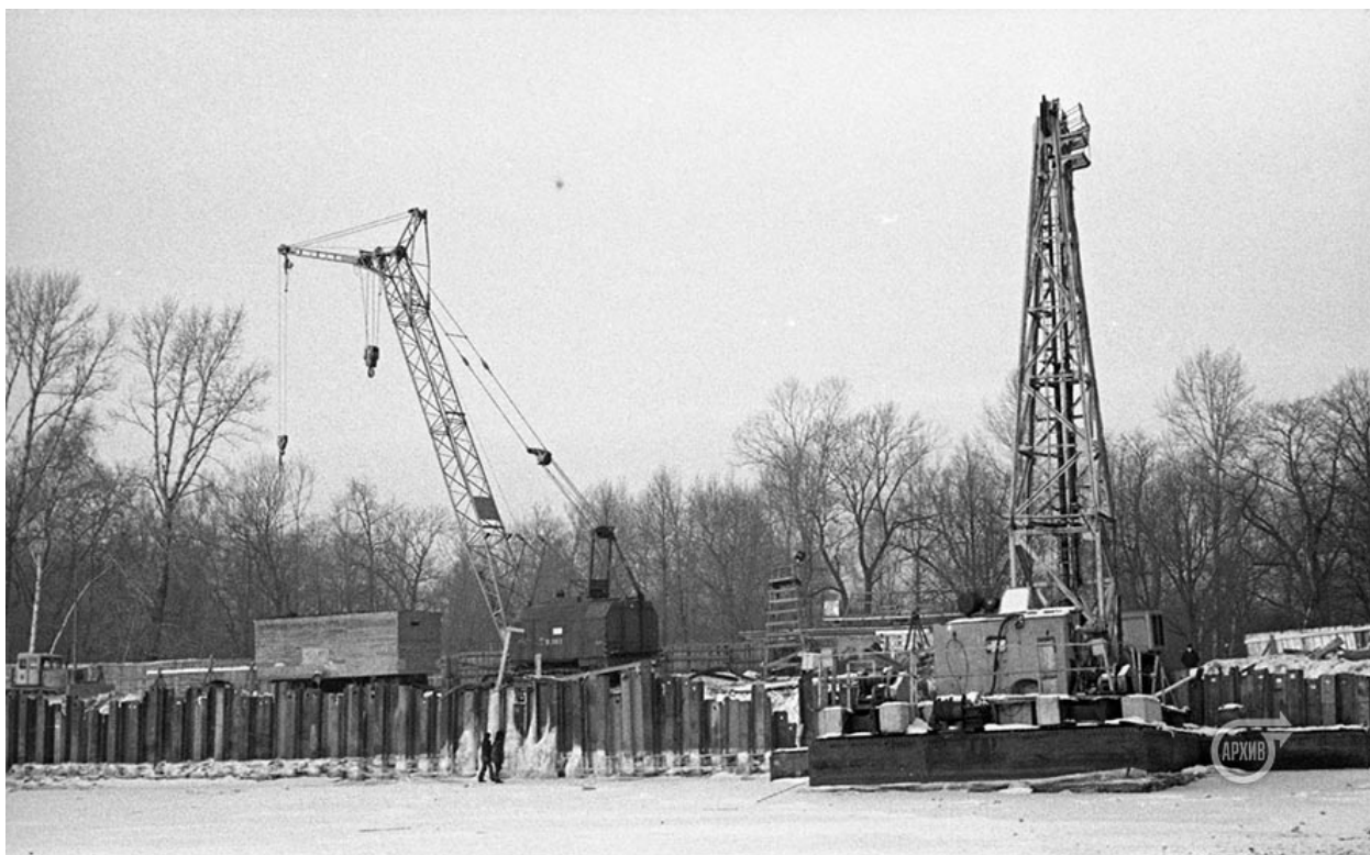
18. Строительство Кронверкской набережной, 1975-1977 гг. [Электронный ресурс] URL: https://pastvu.com/p/1869369
