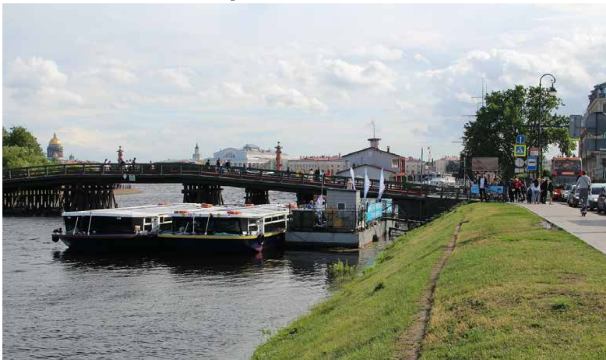
Фото 1. Вид на спуск в 15-ти метрах от Кронверкского моста (спуск № 1) объекта культурного наследия федерального значения «Набережные Кронверкского пролива» на участке набережной Кронверкского пролива «Западный Артиллерийский мост – Кронверкский мост», литера А с северо-востока.
