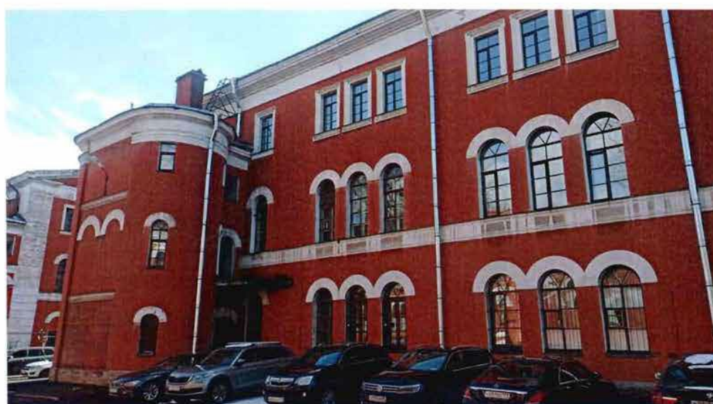
3. Вид на северный фасад объекта культурного наследия.
