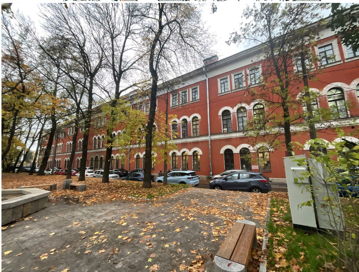
Фото 7. Фасад по ул. Комсомола. Вид с юго-запада.
