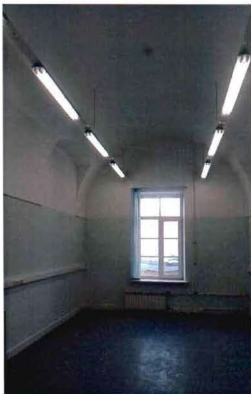
4. Помещение 3-го этажа.
