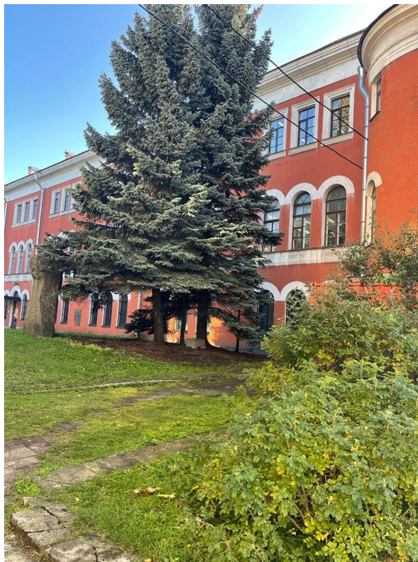
Фото 2. Дворовый и торцевой фасады. Направление съемки – юго-восток.
