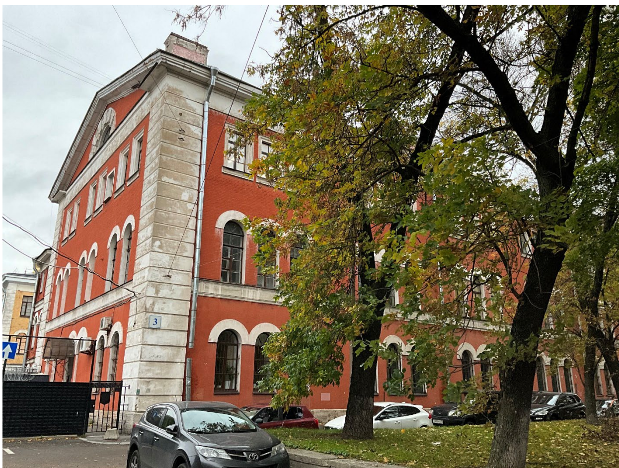
Фото 3. Лицевой и торцевой фасады. Вид с юго-запада.
