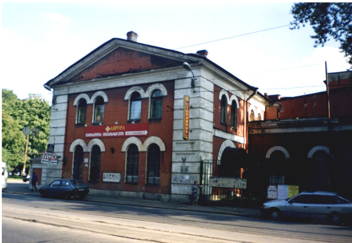
29. Арсенал. Вид с ул. Комсомола. Фото 2008 г. (28).
