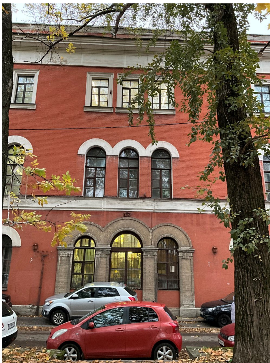
Фото 6. Фрагмент фасада по ул. Комсомола. Вид с юга.
