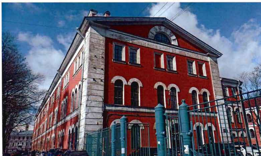
1. Вид на объект культурного наследия с юго-восточной стороны.
