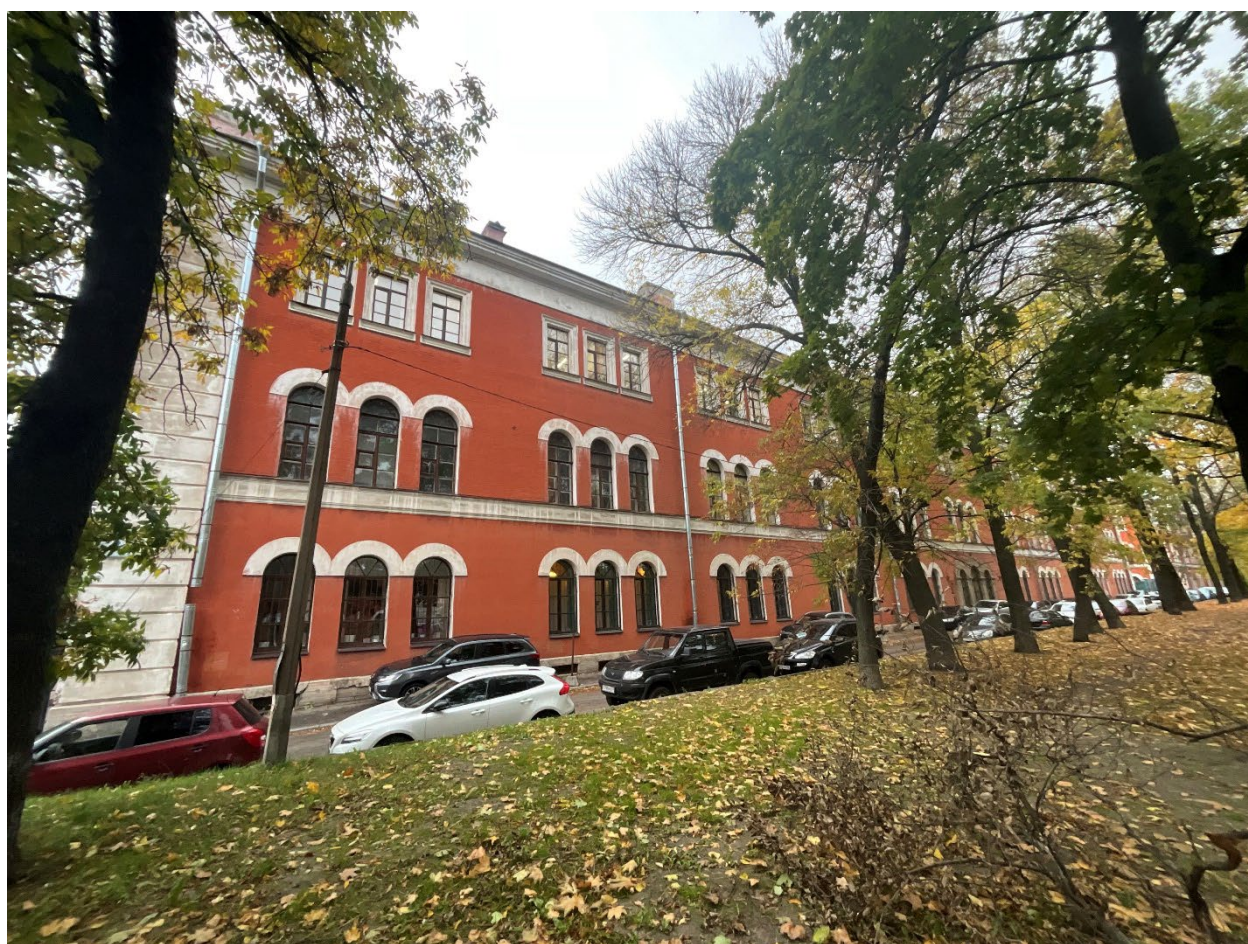
Фото 4. Фасад по ул. Комсомола. Вид с запада.
