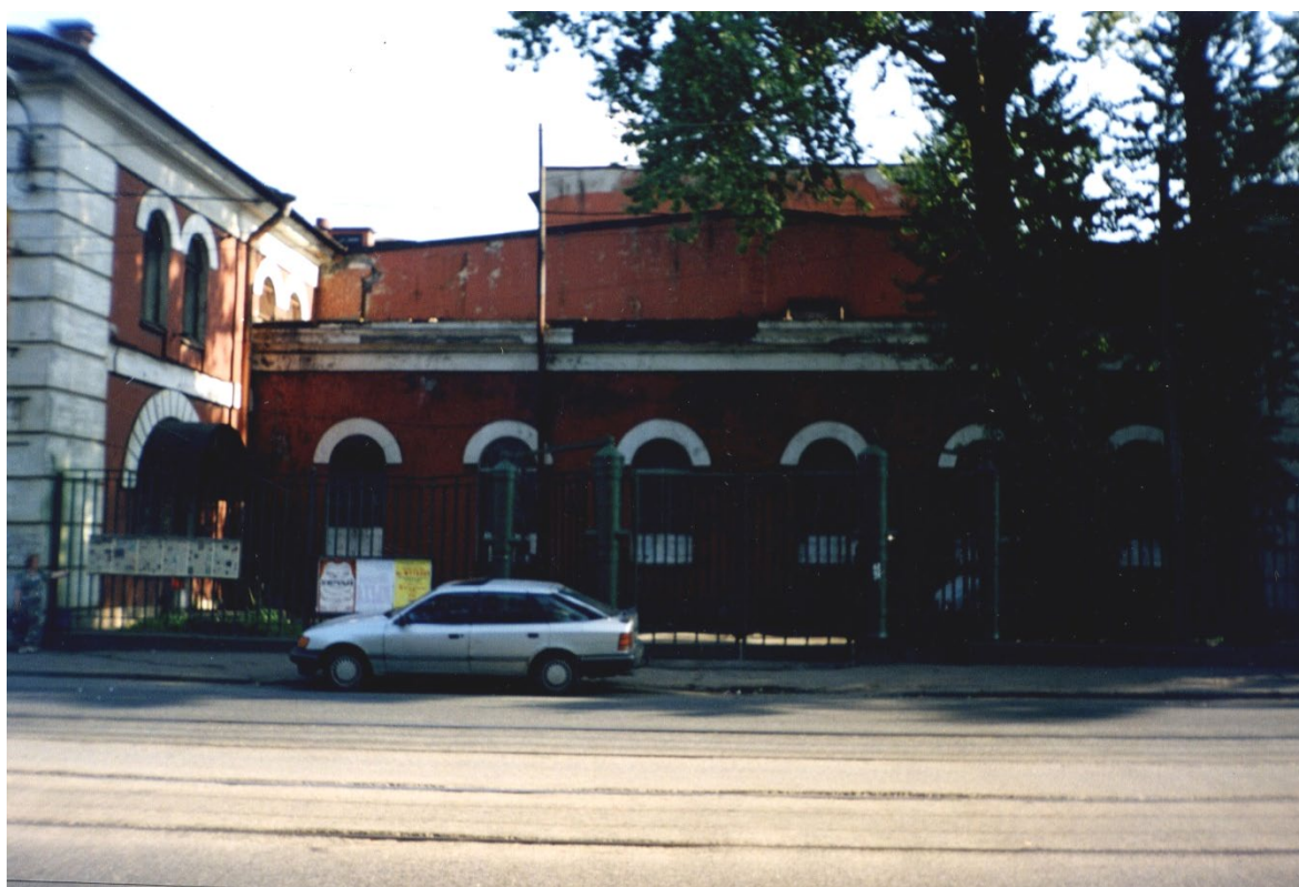
30. Арсенал. Вид с ул. Комсомола. Фото 2008 г. (28).
