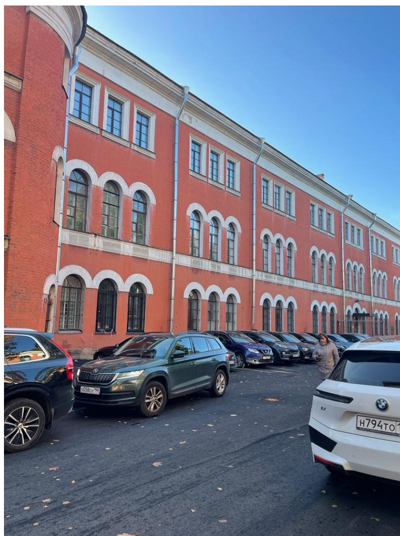
Фото 1. Дворовый фасад. Направление съемки – юго-запад.
