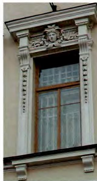
оформление оконных проемов 3-го этажа участков лицевого фасада между раскреповками - профилированные наличники с замковым камнем в виде кронштейна; подоконный выступ;
