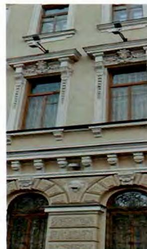
оформление воротного проезда – ниша, фланкированная прямоугольными оконными проемами с замковым камнем и люкарнами над ними, над проемом балкон, поддерживаемый кронштейнами в виде атлантов;
