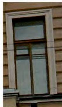
оформление оконных проемов 3-го этажа боковых ризалитов – профилированные наличники с замковым камнем в виде кронштейна, с подоконным выступом;
