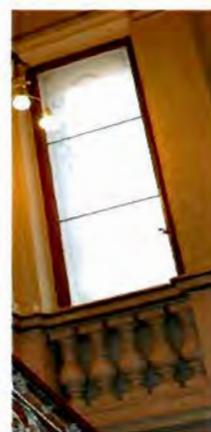
историческое заполнение оконного проема (расстекловка на 3 части), материал (дерево – дуб, стекло с матовым покрытием), рисунок (вертикально-направленная цветочно-растительная композиция с венком и вензелем в верхней части);
