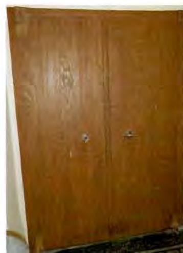
дверной проем – конфигурация (прямоугольная), местоположение (по северной стене), габариты; историческое заполнение дверного проема – бронированное, материал (сталь ?), конструкция (двухстворчатая, со второй решетчатой двухстворчатой дверью), оформление (с декоративными металлическими тягами на тыльной стороне);
