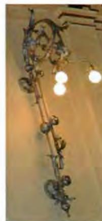
торшер на 5 светоточек (крепится на лестничное ограждение) – конфигурация, местоположение, материал (металл), техника исполнения (ковка, литье), габариты, конструкция и оформление (фигурный стержень в обрамлении четырех гладких стоек на трех-лучевом фигурном основании, с завершением стержня круглым плафоном\*, с загибающимися вниз кронштейнами с плафонами\*, с рельефной поверхностью под ним);
