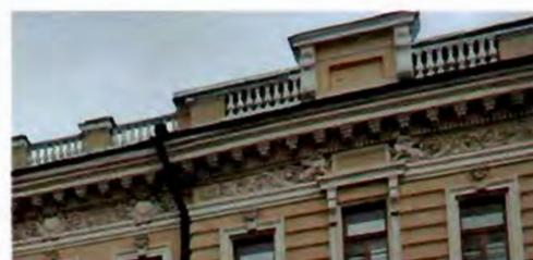
парапетное ограждение - конфигурация (парапетных тумб с балюстрадой), местоположение, габариты, материал (гипс);
