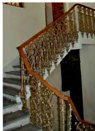
лестница пом. 1-Н (57, 86, 132, 137) – местоположение, конфигурация, конструкция (по металлическим косоурам), тип (маршевая), габариты, материал ступеней (гранит); лестничное ограждение – материал (металл), техника исполнения (литье, ковка), рисунок (вертикальные прутья с орнаментированными перехватами); поручни – конфигурация, габариты, материал (натуральное дерево), форма (профиль), цвет (коричневый).
