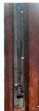
одна дверной прибор входной двери – конструкция (шпингалет с ручкой кнопкой), материал (латунь);
