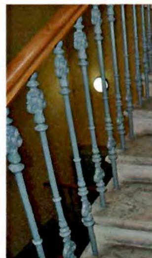
две лестницы помещения 1-Н(78) – тип (средистенная), конструкция (одномаршевая, на перекрытии, на перепаде отметок пола из 5 ступенек), местоположение (арочный проем с северной и западной стороны), материал ступеней (гранит).
