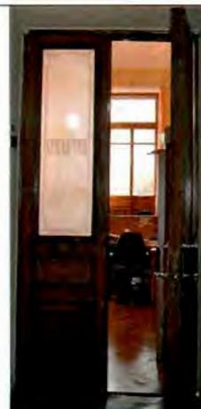
историческое заполнение дверного проема западной стены – конструкция (двухстворчатое), оформление (нижние филенки с фальцем, с декоративным карнизом между филенками), материал (дерево – дуб, матовое стекло), техника исполнения (токарная работа, резьба, тонировка), цвет (цвет тонированного дерева), рисунок (травленый рисунок: «Справки по вексельям» на каждой из створок);
