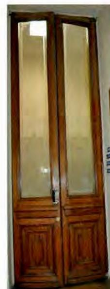
историческое заполнение дверного проема северной стены – конструкция (двухстворчатое), оформление (фигарейные филенки, с остеклением в центральной части), материал (дерево – дуб, матовое стекло), техника исполнения (токарная работа, резьба, тонировка, пескоструйная техника), цвет (цвет тонированного дерева), рисунок («Вход посторонним лицам воспрещается» на каждой из створок);
