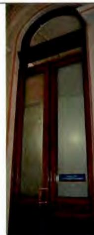
два дверных проема - конфигурация (прямоугольная), местоположение (южная часть зала (кассы), с левой стороны), габариты; историческое заполнение дверного проема - конструкция (двухстворчатая), материал (дерево - дуб), габариты, оформление (филенки с фальцем, с профилированным декоративным карнизом между филенками);
