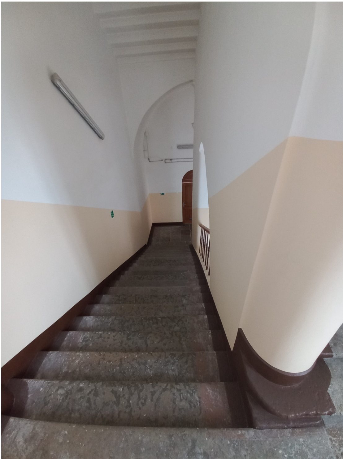
Фото 22. Вид с площадки третьего этажа.
