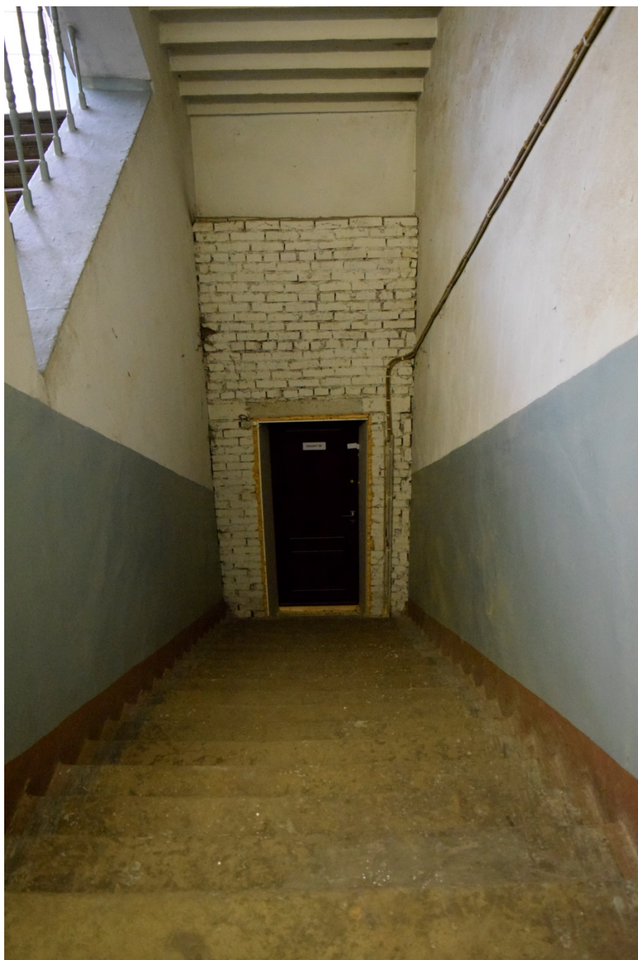
Фото 14. Вид с площадки между 1 и 2 этажами. Дверь в помещения 1 этажа.
