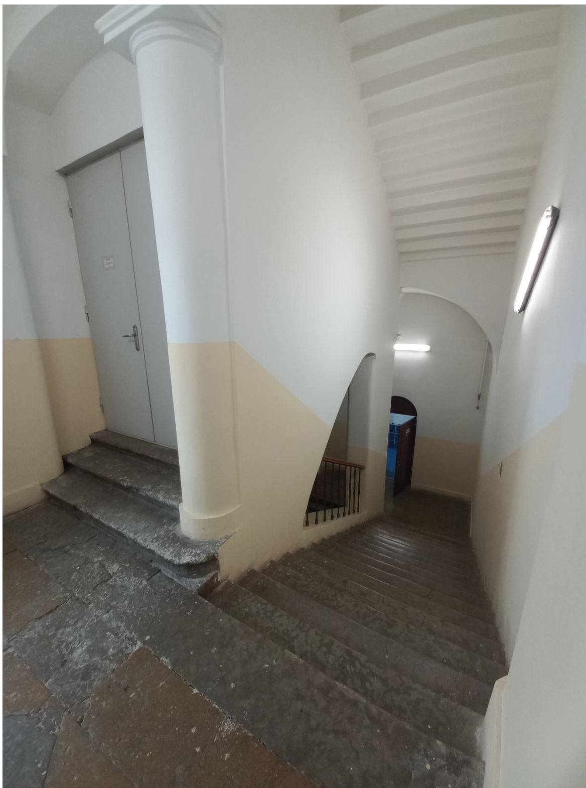
Фото 7. Вид с площадки 3 этажа.
