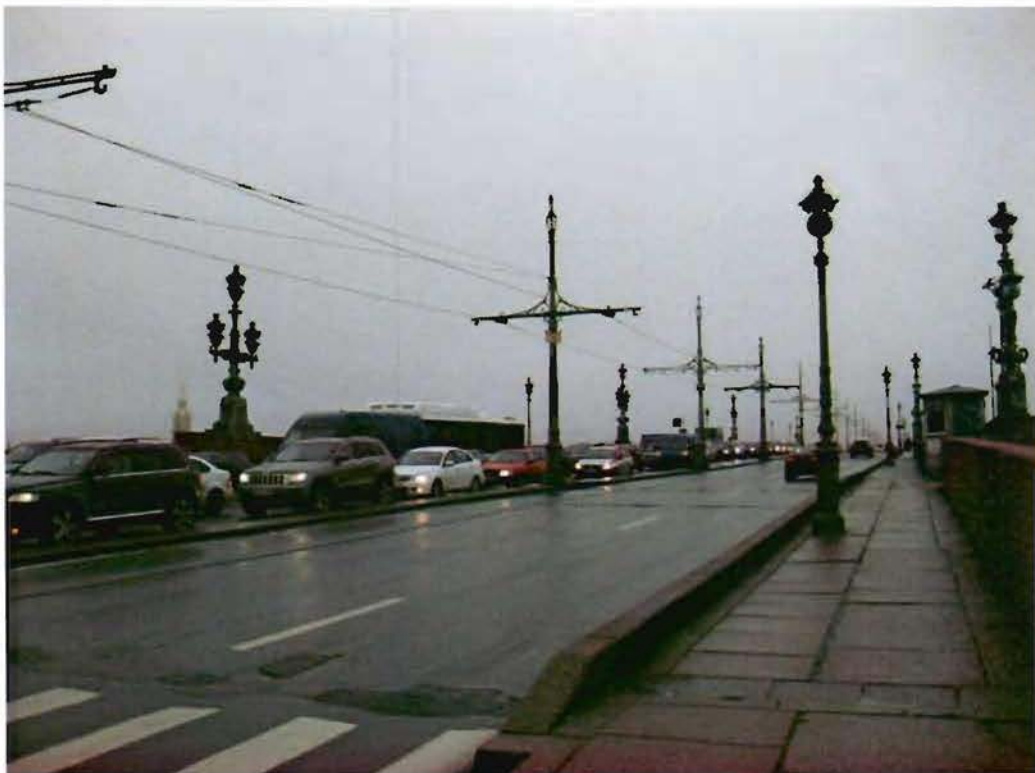
4. Вид на поверхность моста
