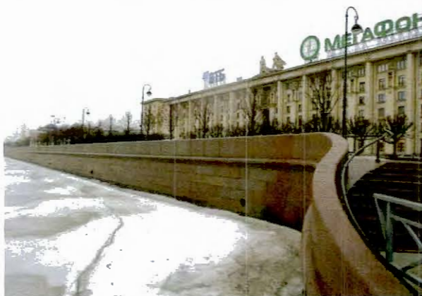
5. Вид стенки набережной
