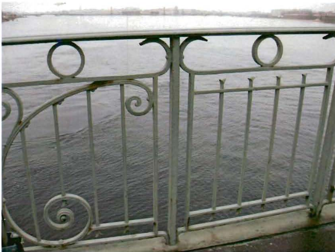
7. Решетка перильного ограждения (фрагмент)
