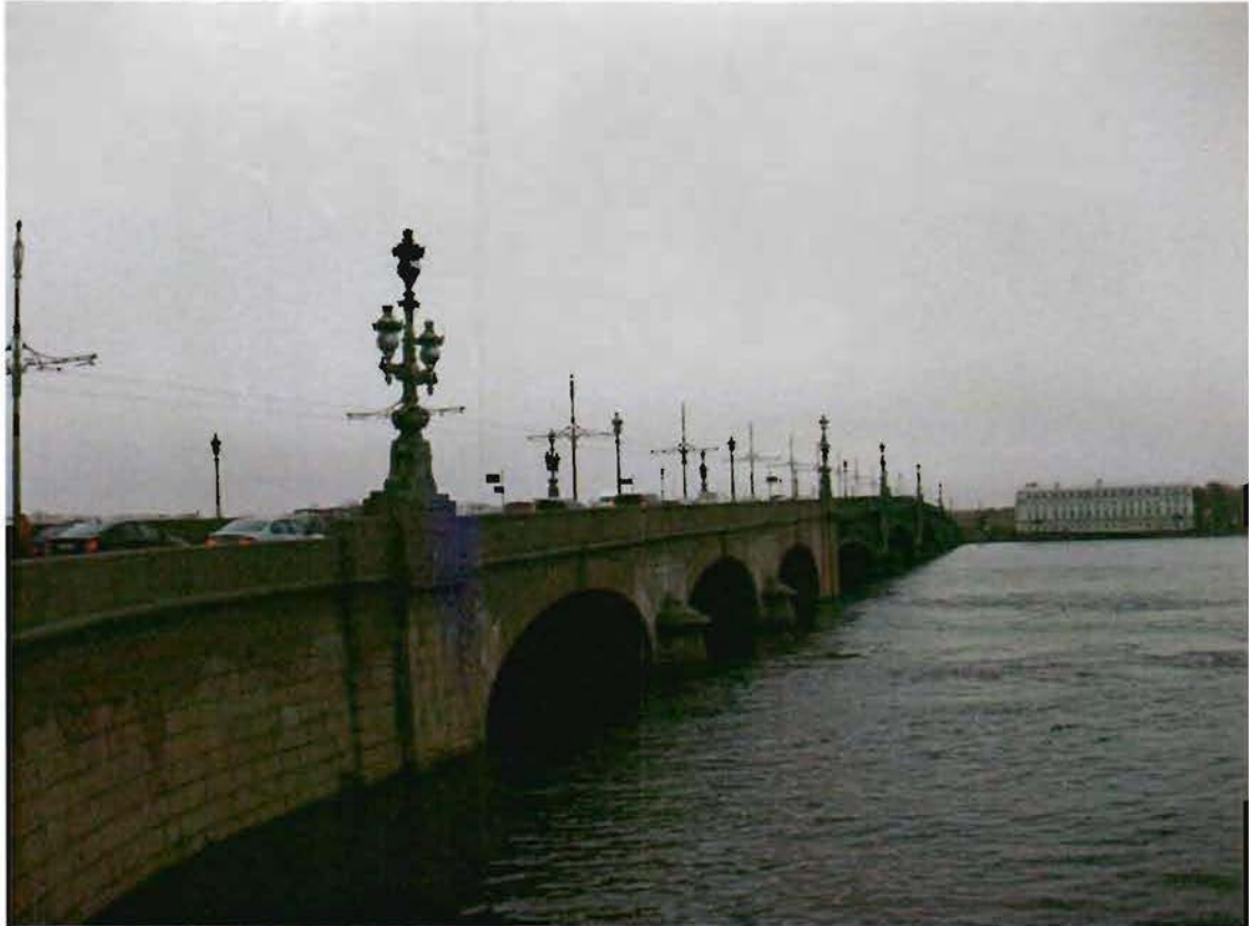
10. Каменная аркада моста. Вид со стороны низового фасада
