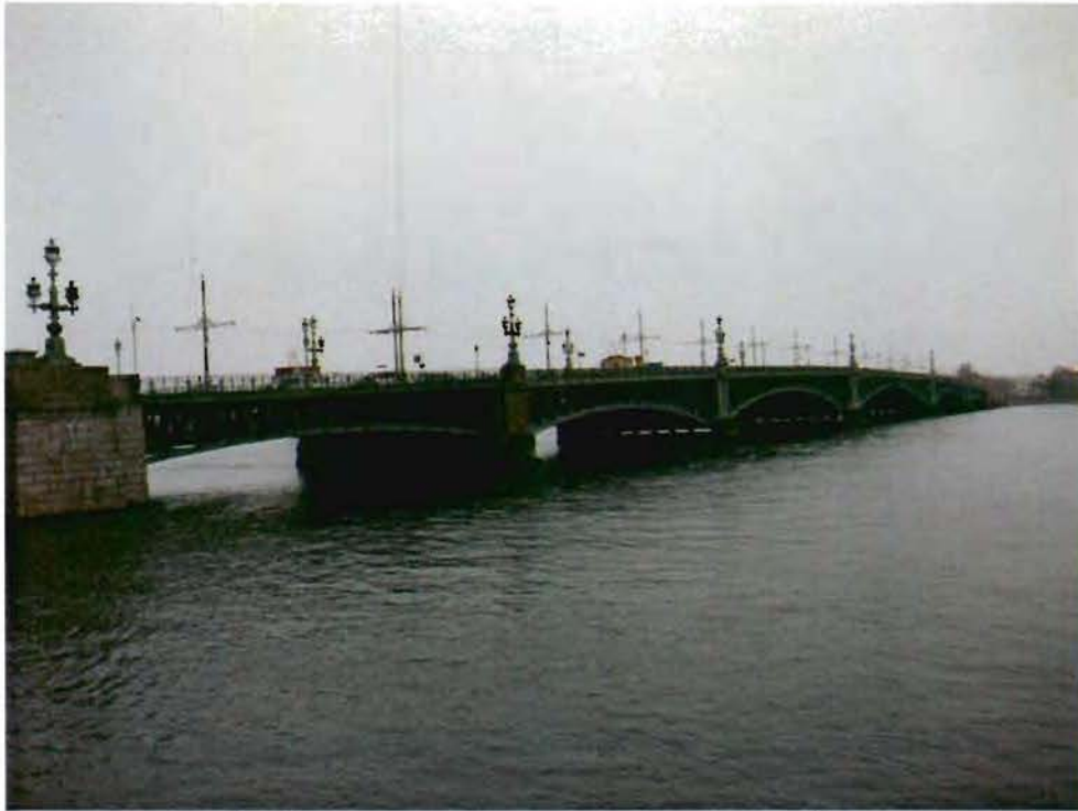
1. Вид на мост со стороны верхового фасада
