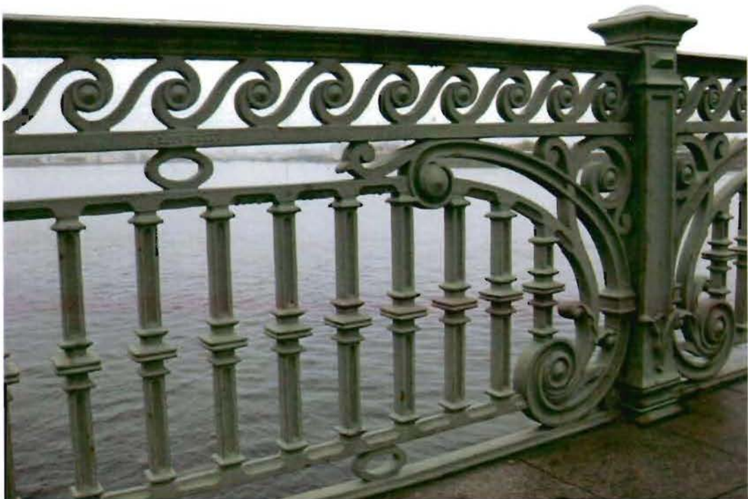
6. Решетка перильного ограждения (фрагмент)
