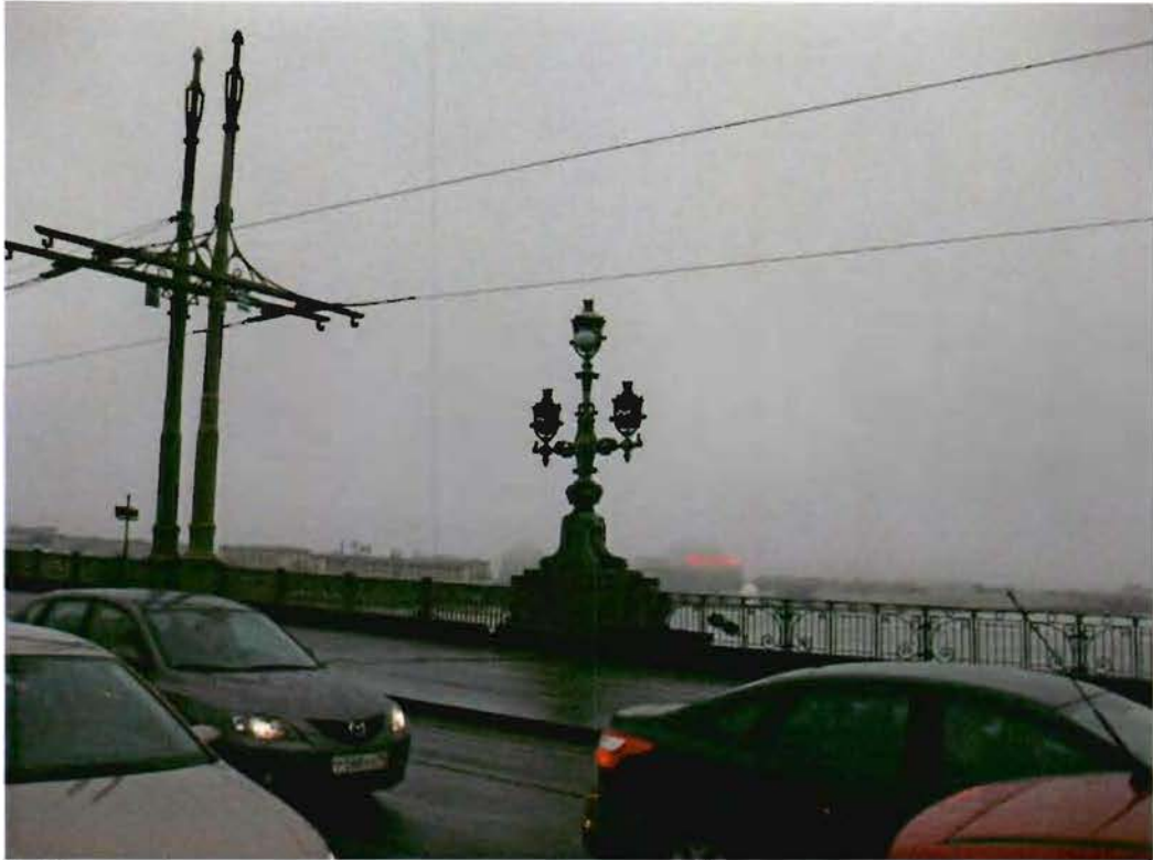
5. Вид на фонари-торшеры, опоры контактной сети, перильное ограждение
